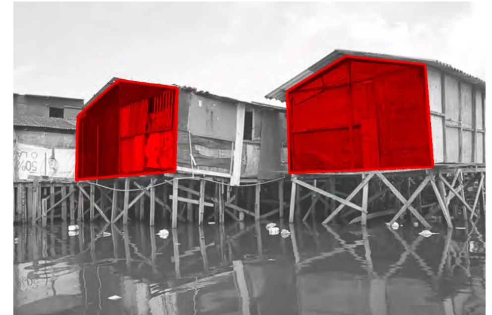
Figura 2: Detalhe das estruturas das casas em estacas com sobreposição de formas geométricas em vermelho.
