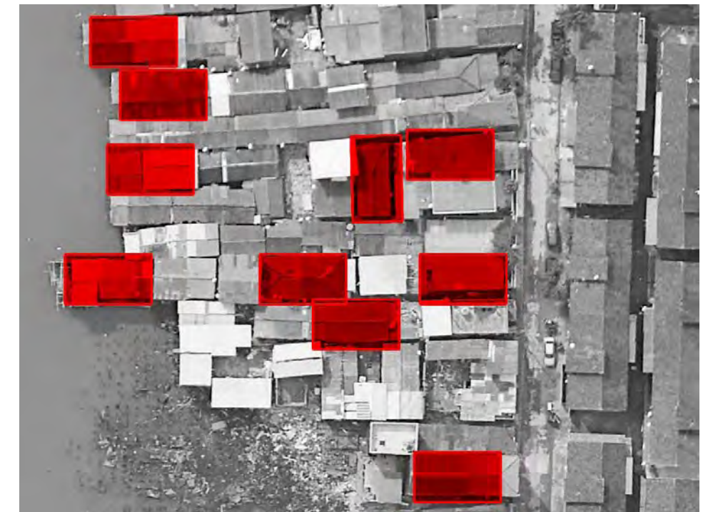
Figura 3: Vista aérea da área de estudo com sobreposição de formas retangulares em vermelho em vários pontos.
