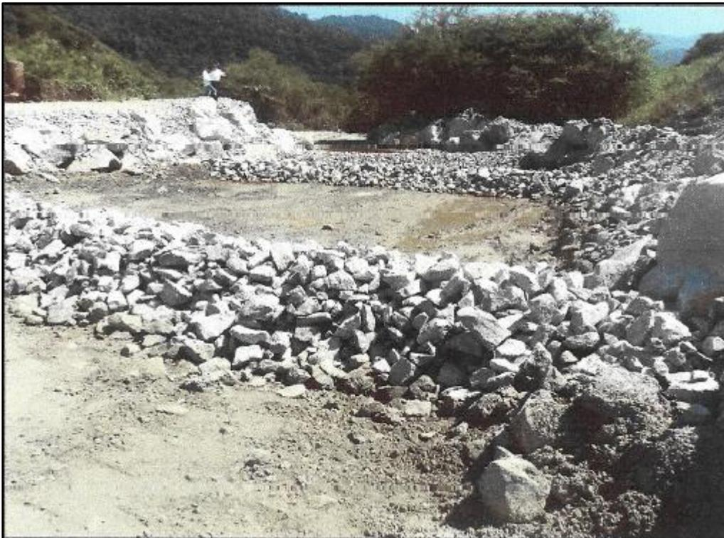
**Foto 17 - Sistema de retenção de sedimentos**
