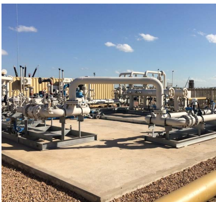
Figura 6.2.3-1: Estruturas que compõem um City Gate .
