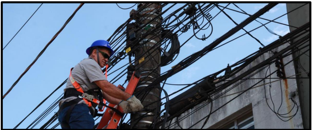
Figura 25 – Fiação de cabos em poste situado na Rua João Pessoa, Paquetá, região central de Santos.
