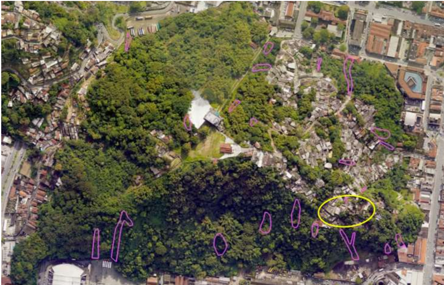
Deslizamentos causados pelas chuvas intensas de Fevereiro e Março de 2020 (Fonte: Defesa Civil de Santos, 2020).
