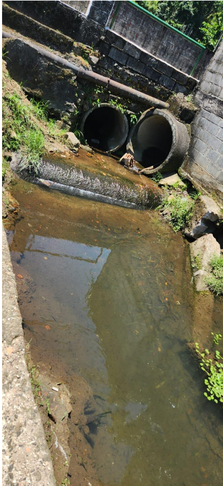
Figura 24 - Saída da drenagem oriunda da área de morros - contribuição com rio Saboó/Lenheiros
