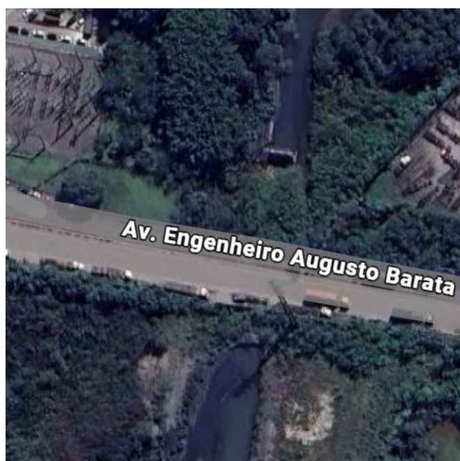
Figura 27 - Trecho do Rio Saboó/Lenheiros na passagem sob a Av. Eng o Augusto Barata (possível observar, na foto de satélite, a estrutura de comportas construída a jusante)
