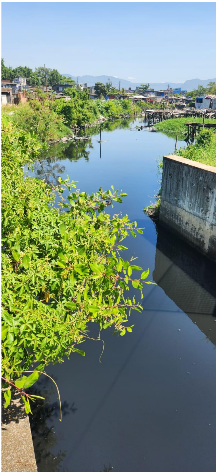
Figura 20 - Rio dos Bugres (trecho a partir da saída da elevatória com comporta)
