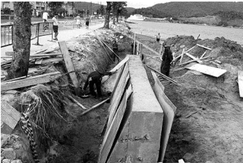
Figura 09. Construção de um muro de contenção na Av. Bartolomeu de Gusmão, como registrado na edição de 18 de maio de 2005 do Diário Oficial de Santos - Cada fôrma da muralha tem 6 m de comprimento por 2,5 m de altura. Foto: Francisco Arrais. Fonte: http://www.novomilenio.inf.br/santos/h0218d.htm acesso em 8 nov. 2016
