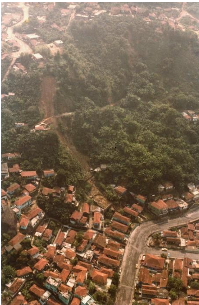
Figura 07. Parte do levantamento do IPT, durante os trabalhos de mapeamento da Carta Geotécnica – Zona de acúmulo de material escorregado no Morro do Jabaquara, em 1978 – Foto: IPT. Fonte: http://www.ipt.br/institucional/campanhas/16-voce_sabia_que_o_ipt_elaborou_a_primeira_carta_geotecnica_do_pais_.htm acesso em 09 nov. 2016.
