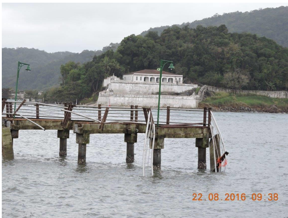
Figura 13. Deck do Pescador completamente danificado, no dia 22 de agosto de 2016. Foto: Arquivo Pessoal. Fonte: Mídias sociais acesso em 22 ago. 2016
