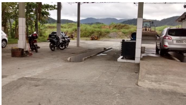
Foto IX.1.4.2-7- Vista da área de lavagem e manutenção de equipamentos
