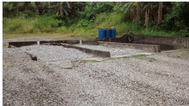
Foto IX.1.4.2-8- Vista da caixa separadora água/óleo
