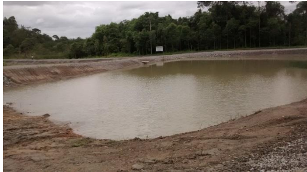
Foto IX.1.4-6- Vista da bacia ao lado da área de lavra
