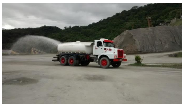
Foto IX.2.4-1- Umectação de vias não pavimentadas
