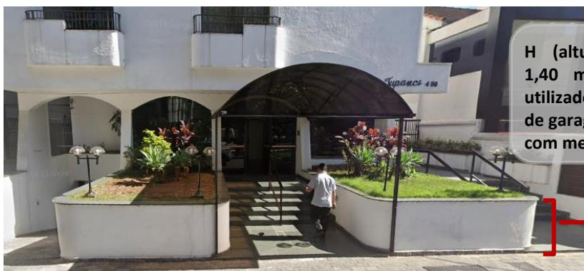
H (altura) máxima de 1,40 m – afloramento utilizado para execução de garagens subterrâneas com menos escavação
