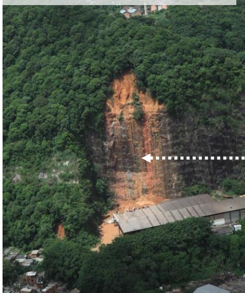
Os **laudos geológicos-geotécnicos** são estudos geológico-geotécnicos detalhados da área com identificação dos processos de instabilidade constatados ou potenciais, elaboração de modelo geomecânico e análise e produção de critérios de segurança dos taludes e estruturas rochosas e/ou de cobertura de materiais com identificação de ações emergenciais de estabilidade e indicativas de obras de contenção,
