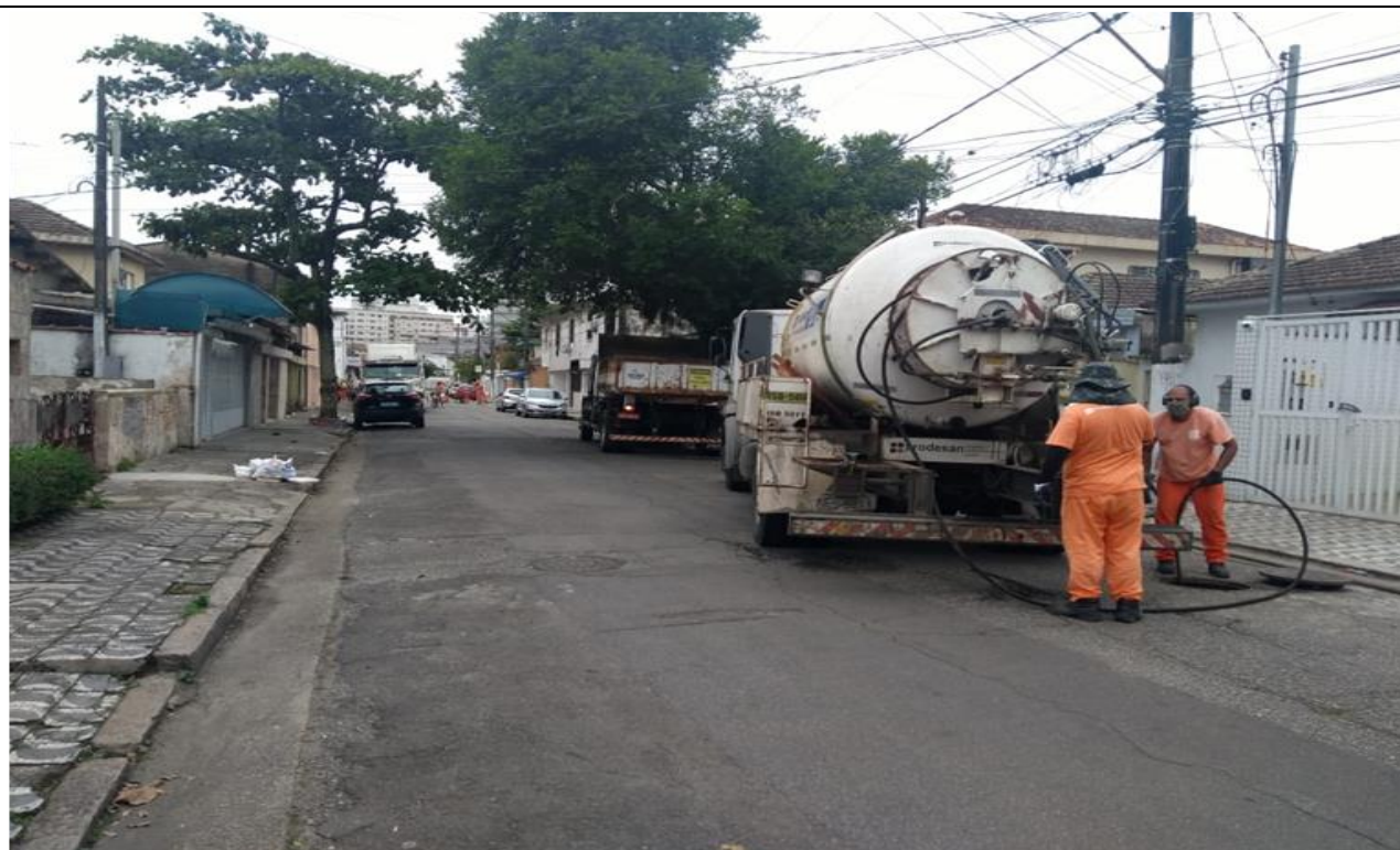
Foto 32 – Operação de Jateamento dos dutos de microdrenagem. Rua Aristίδes Cabreira C. Cunha. Bairro Estuário. Coordenadas UTM: 367471 E; 7348766 N.
