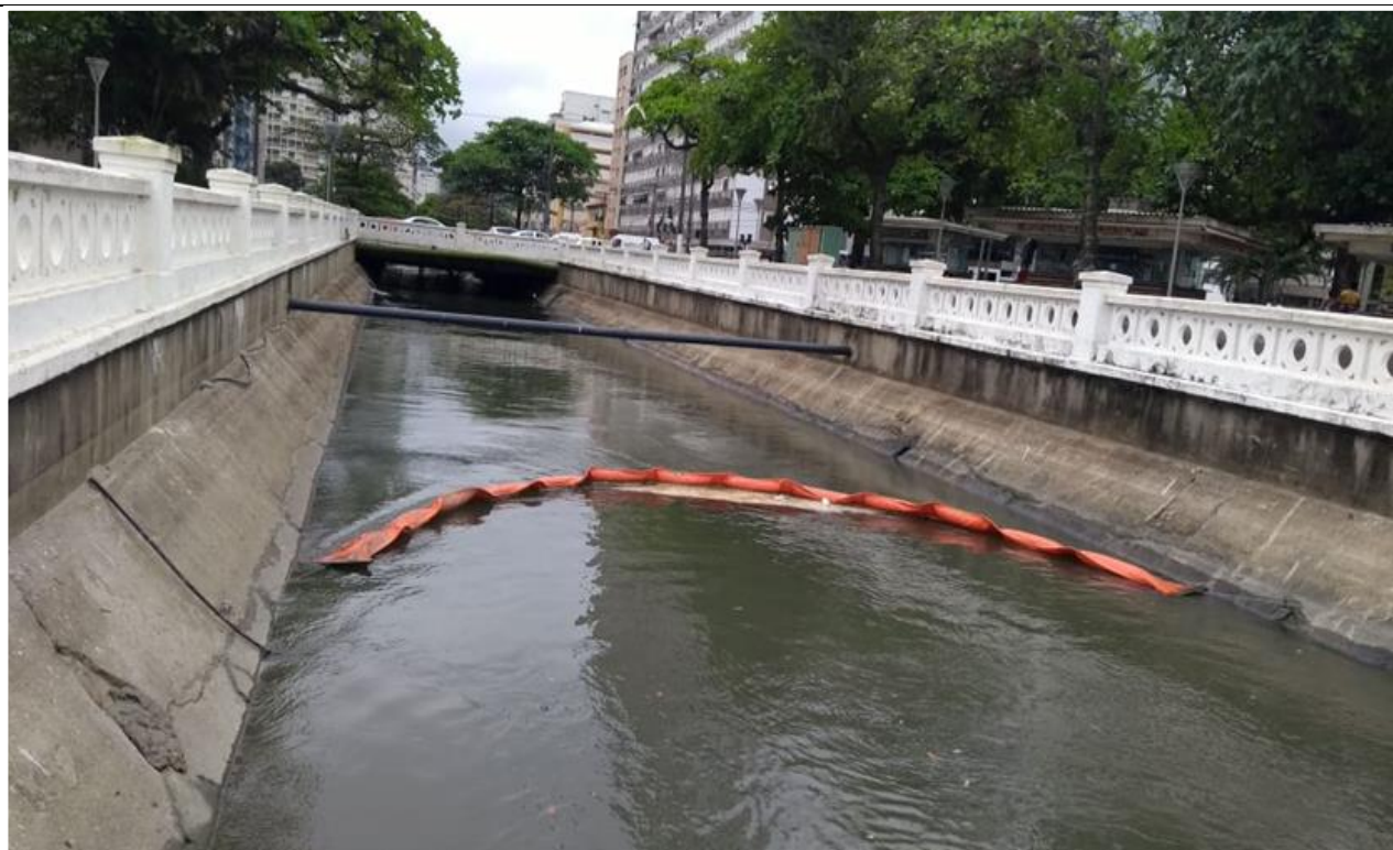
Foto 48 – Canal 1 – Bags de retenção de sólidos instalados em todos os canais. Limpeza realizada diariamente com equipamento "pulsá" - Praia do José Menino. Coordenadas UTM: 363095 E 7348598 N.
