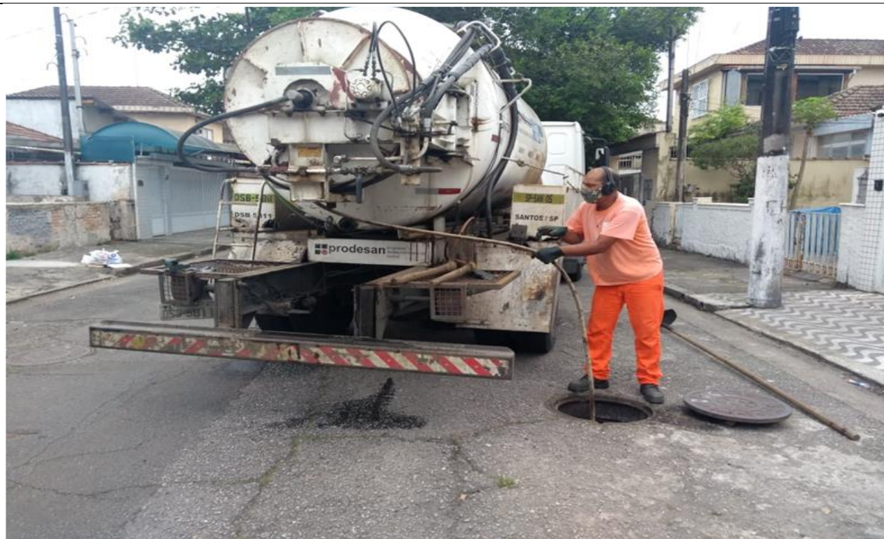
Foto 32 – Operação de Jateamento dos dutos de microdrenagem. Rua Aristίδes Cabreira C. Cunha. Bairro Estuário. Coordenadas UTM: 367471 E; 7348766 N.
