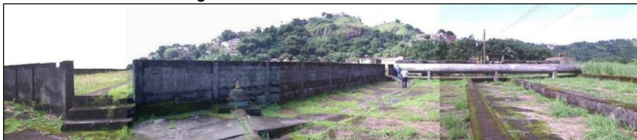
Figura 22 – Reservatório Saboó Alto.
