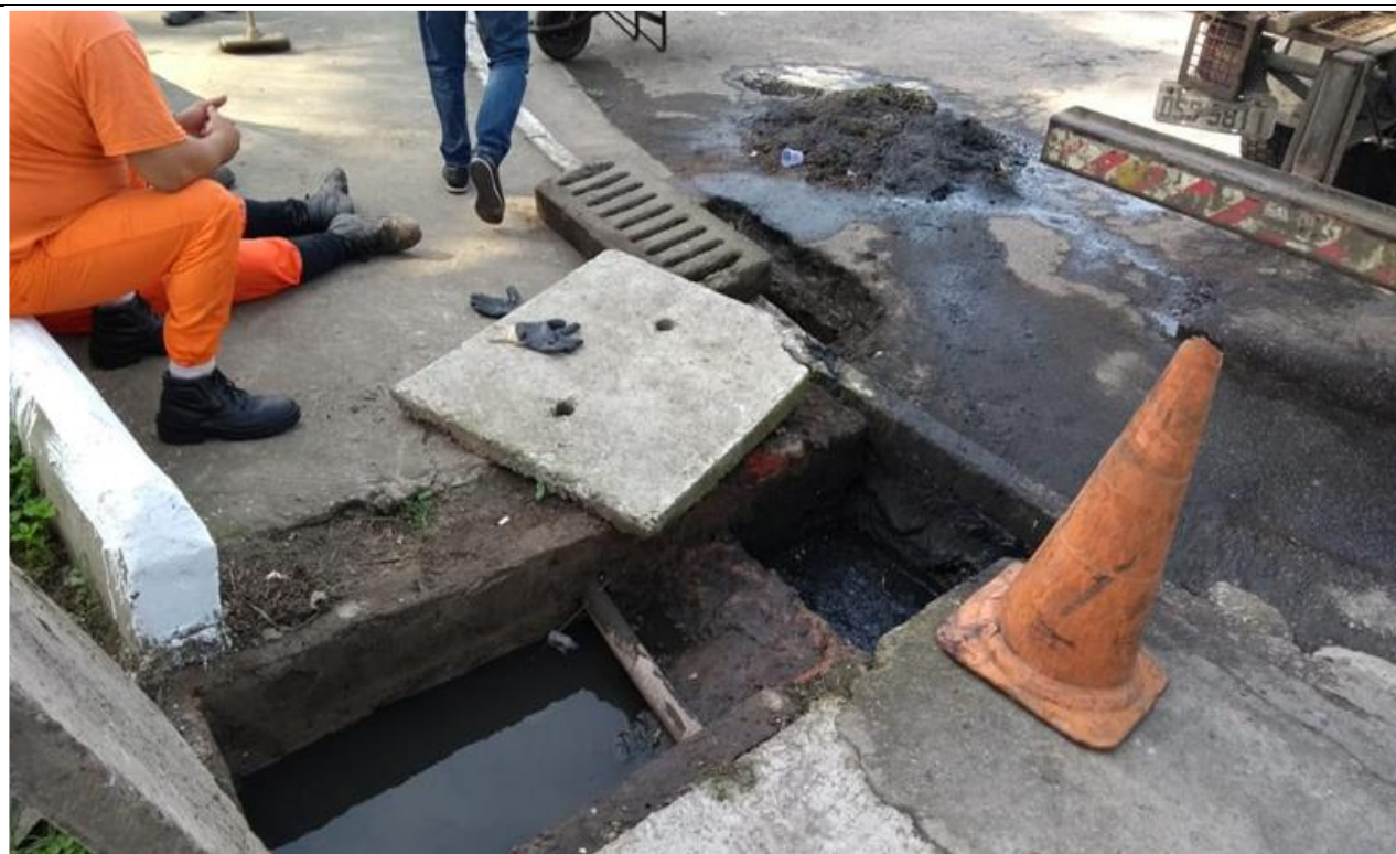
Foto 18 – Limpeza de boca de lobo - Jardim Castelo. Coordenadas UTM: 359523 E; 7350854 N.
