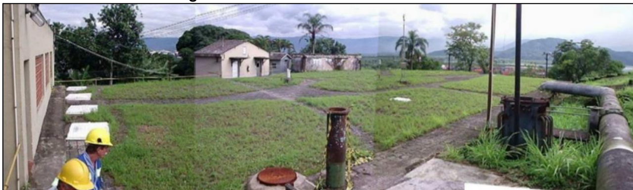
Figura 21 – Reservatório Saboó Baixo.
