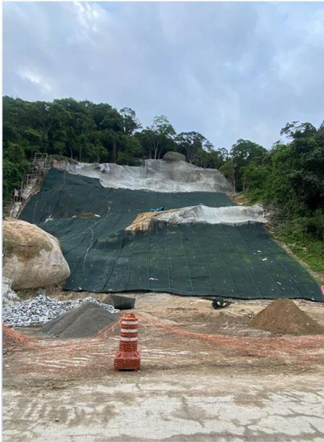
Obras de contenção e drenagem em encosta do Ilhéu Alto. Fonte: SESERP
