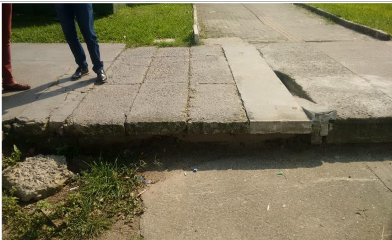
Foto 20 – Tampas de concreto para inspeção deste trecho coberto do canal. Jardim Castelo. Coordenadas UTM: 359523 E; 7350854 N.
