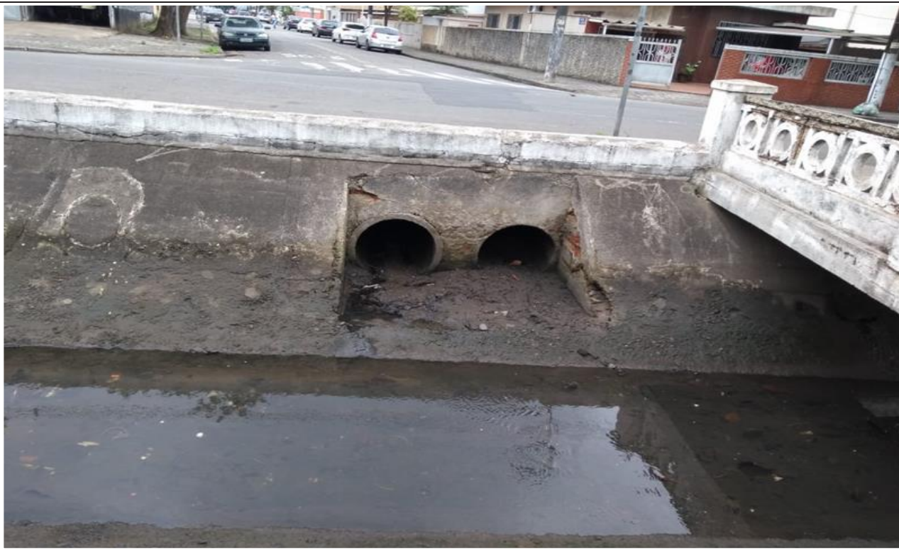
Foto 40 – Desembocadura de microdrenagem no canal 6. Av. Coronel Joaquim Monte Negro. Bairro Estuário. Coordenadas UTM: 367956 E; 7347925 N.
