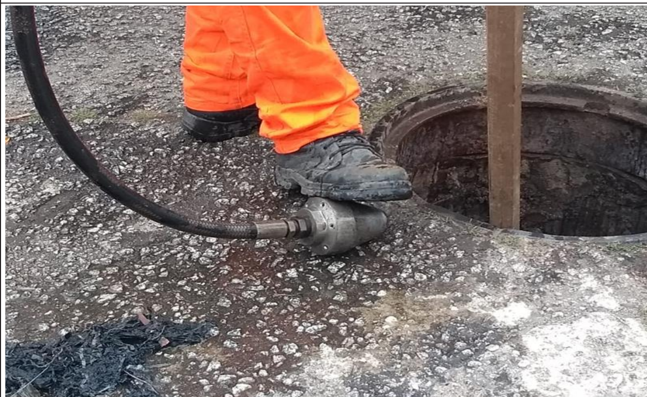
Foto 30 – Bico de Jateamento para limpeza dos dutos de microdrenagem. Rua Aristίδes Cabreira C. Cunha. Bairro Estuário. Coordenadas UTM: 367471 E; 7348766 N.
