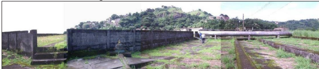
Figura 22 – Reservatório Saboó Alto.
