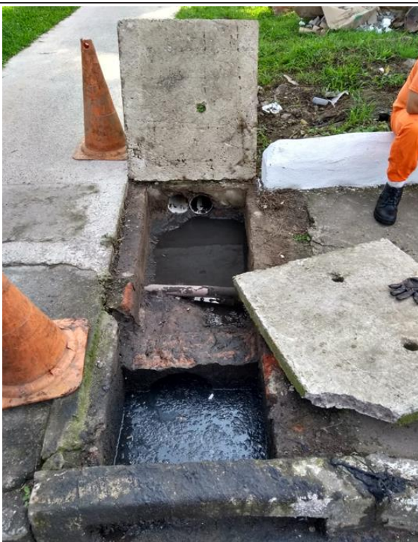
Foto 20 – Tampas de concreto para inspeção deste trecho coberto do canal. Jardim Castelo. Coordenadas UTM: 359523 E; 7350854 N.
