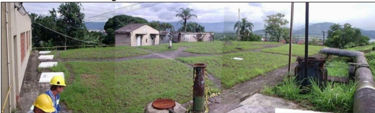
Figura 21 – Reservatório Saboó Baixo.
