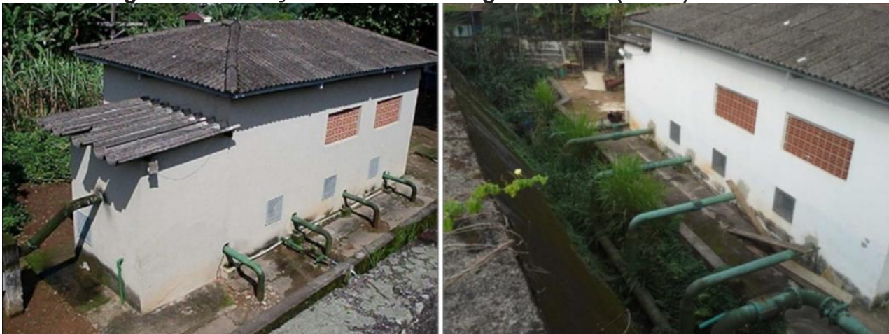
Figura 25 – Estação Elevatória de Água Tratada (EEAT) Cruzeiro.
