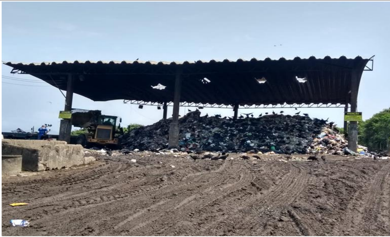
Foto 6 – Transbordo de resíduos sólidos urbanos – Entrada da carreta à direita e rampa de carga à esquerda – Bairro Alemoa. Coordenadas UTM: 357888 E; 7353597 N.
