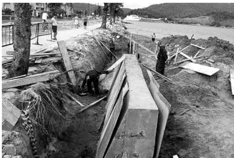
Figura 3.1.9. Construção de um muro de contenção na Av. Bartolomeu de Gusmão, como registrado na edição de 18 de maio de 2005 do Diário Oficial de Santos - Cada fôrma da muralha tem 6 m de comprimento por 2,5 m de altura. Fonte: Site Novo Milênio 31 .
