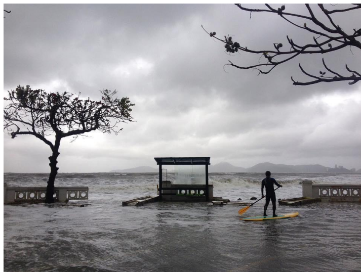
Figura 3.1.12. Ressaca na Ponta da Praia, destruindo parcialmente as muretas, no dia 21 de agosto de 2016. Fonte: Mídias sociais.
