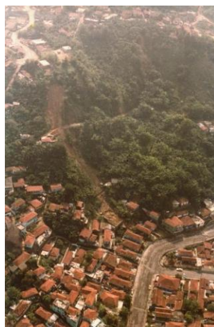
Figura 3.1.7. Parte do levantamento do IPT, durante os trabalhos de mapeamento da Carta Geotécnica - Zona de acúmulo de material escorregado no Morro do Jabaquara, em 1978. Fonte: IPT 28 .
