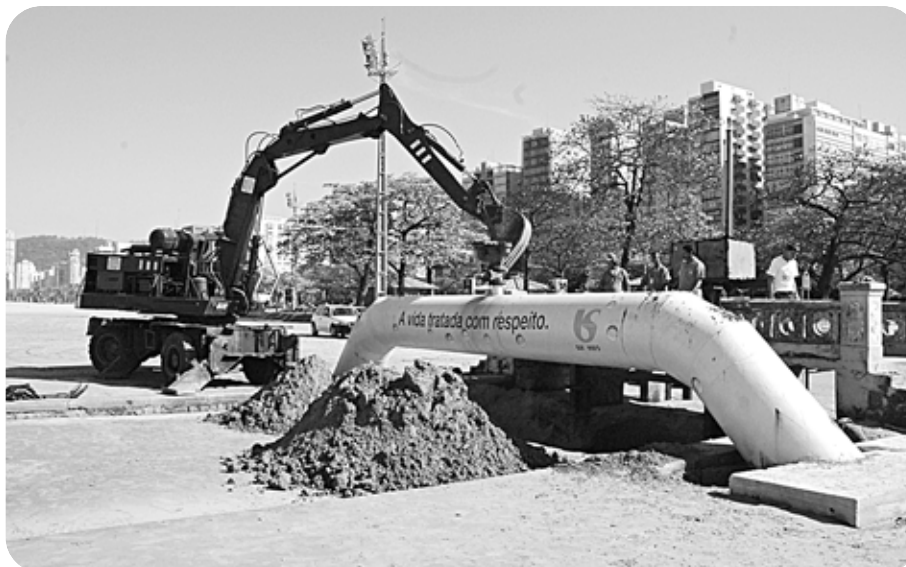
Funcionários da Prodesan trabalham no desassoreamento do Canal 2, no trecho até a avenida
