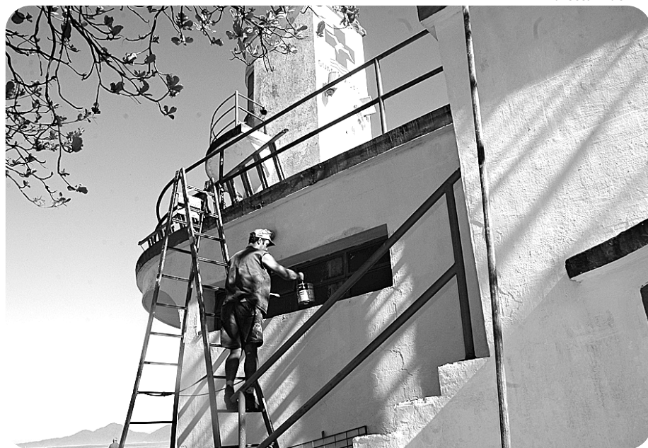
Serviços de raspagem e pintura são realizados na parte externa do Posto 6, praia da Aparecida
