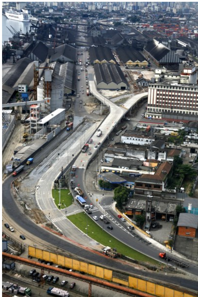
Figura 47. Vista aérea da Perimetral da Margem Direita do Porto de Santos.
