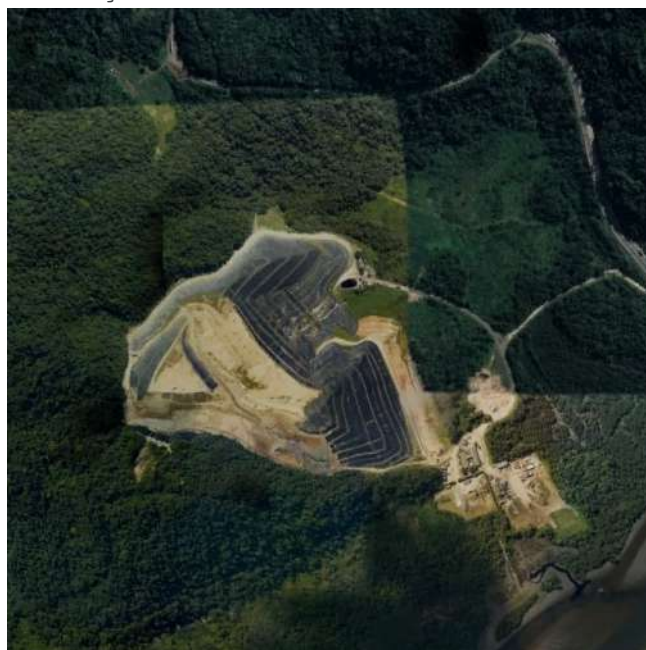
Figura 64 - Vista Satélite - Aterro Nossa Senhora das Neves
