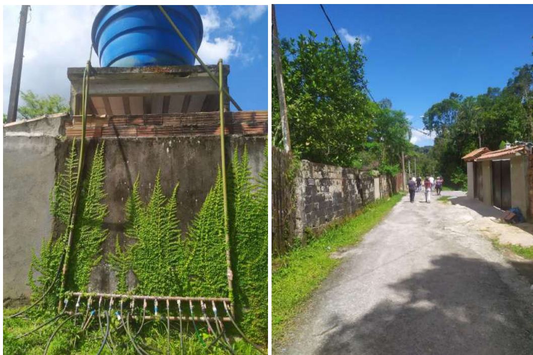
Figura 29 - Imagens da ocupação existente no ponto 1 no bairro Iriri, com destaque para o sistema de abastecimento de água existente no local (esquerda)
