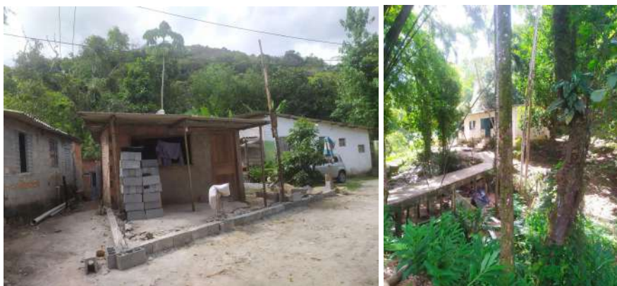
Figura 43 - Imagens da ocupação existente na porção acima da rodovia (ponto C) no bairro Monte Cabrão
