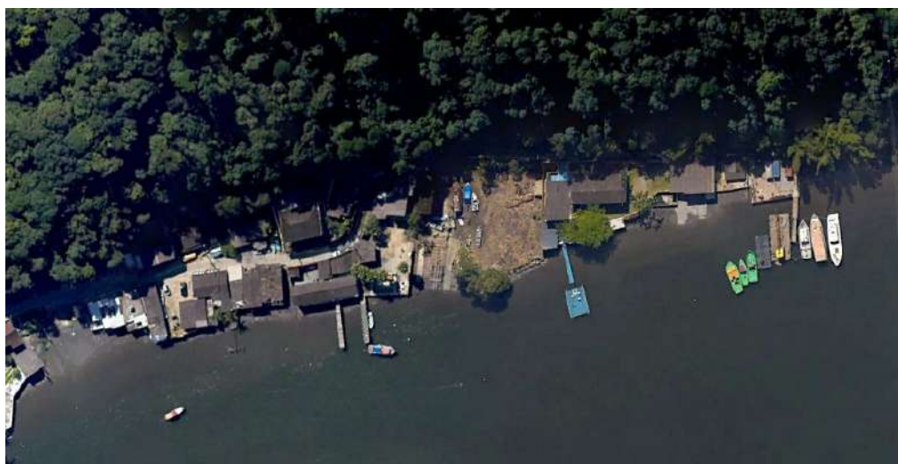
Figura 40 - Imagem aérea do tipo de ocupação existente no ponto B no bairro Monte Cabrão
