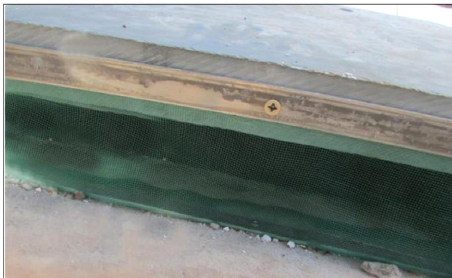
**Figura 81: Modelo de Boca de Lobo Protegida por Filtro**
