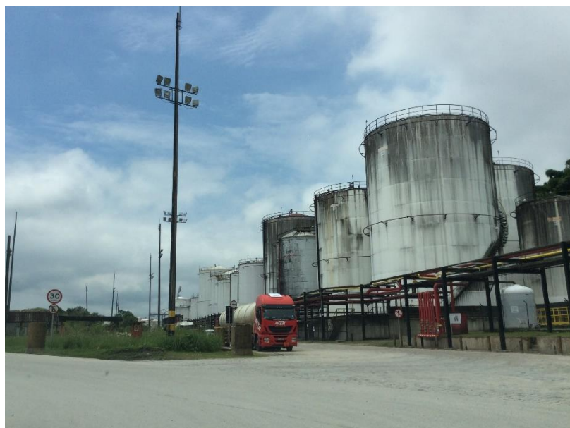
Figura 8-39: Registro fotográfico da parte interna da Ageo Norte Terminais, demonstrando os tanques de produtos químicos.
