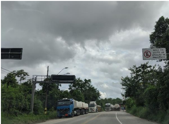
Via de acesso à Ilha Barnabé
