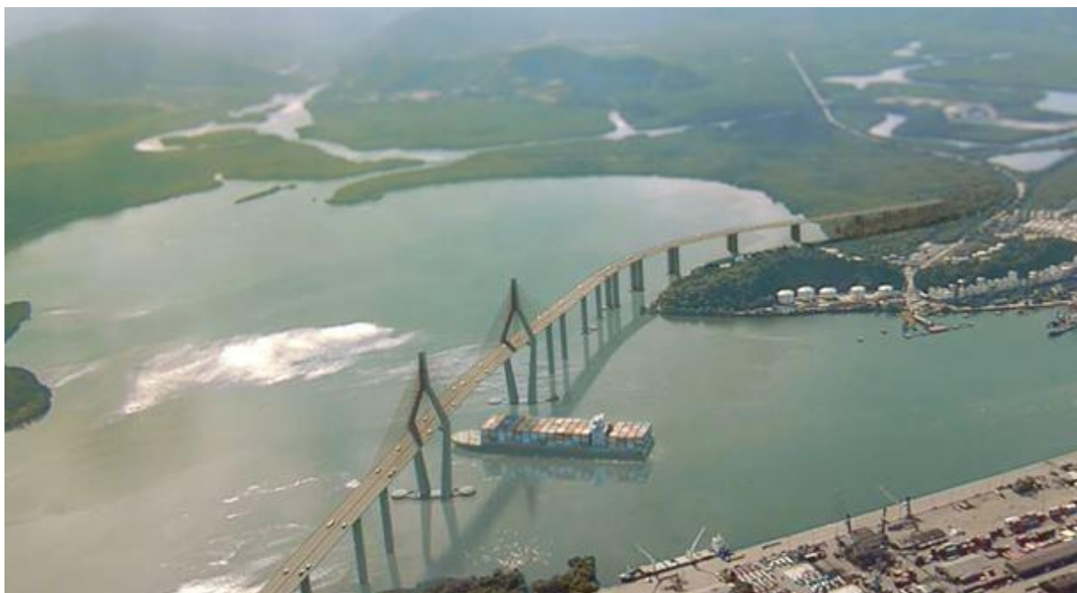
Figura 5.1-5: Vista da Travessia sobre o canal
