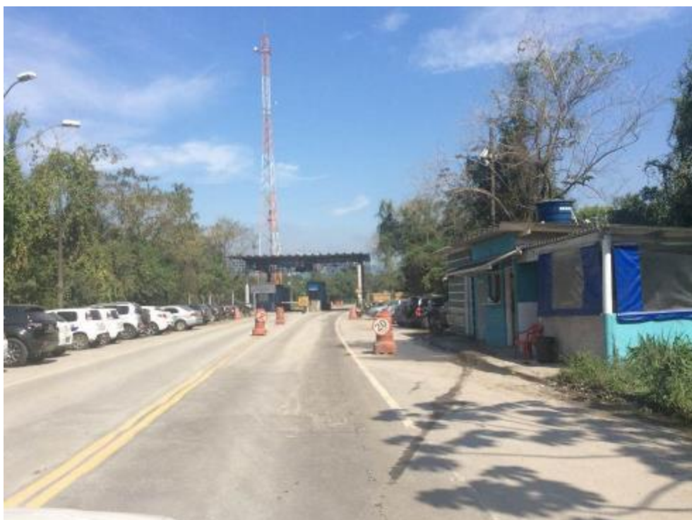
Figura 8-38: Registro fotográfico do Final do acesso público na Estrada da CODESP – Portaria para Ageo Norte Terminais, Granel Química e Adonai Química.
