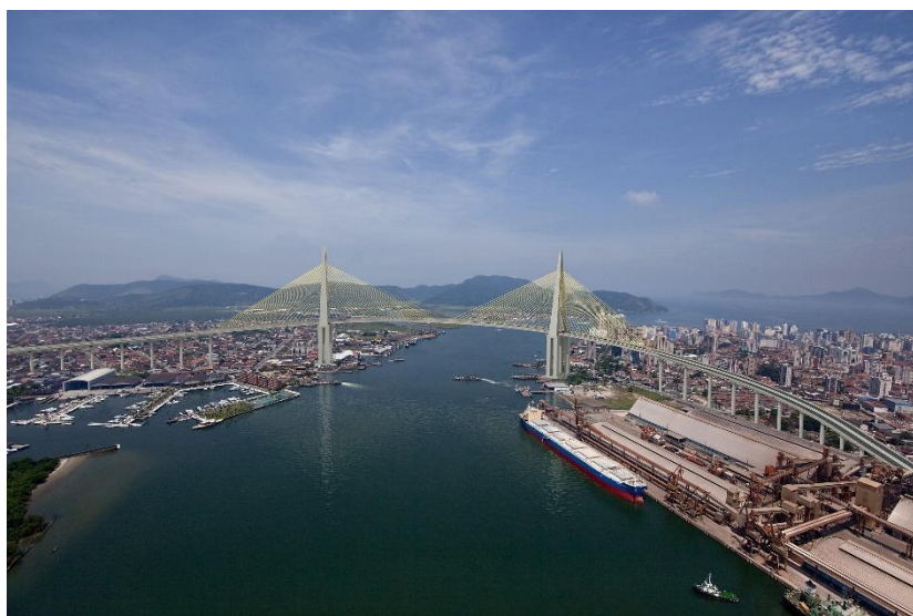
Figura 4-2: Ponte estaiada na Ponta da Praia
