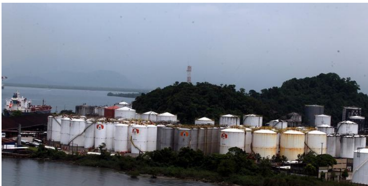
Figura 8-41: Visão da Granel Química, localizada na Ilha Barnabé, área continental do Município de Santos.
