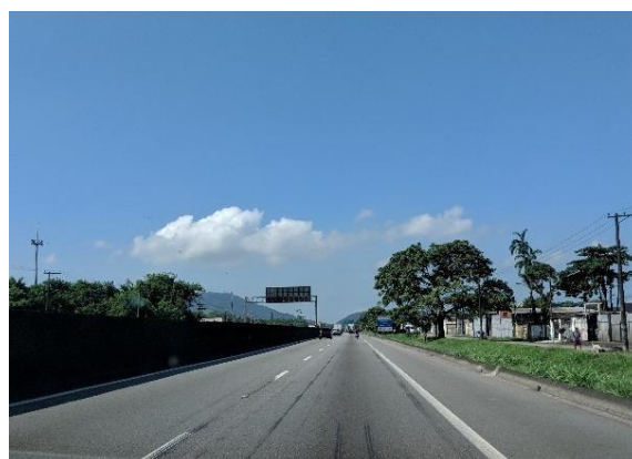
Foto 2.2-2 Rodovia Cônego Domênico Rangoni
