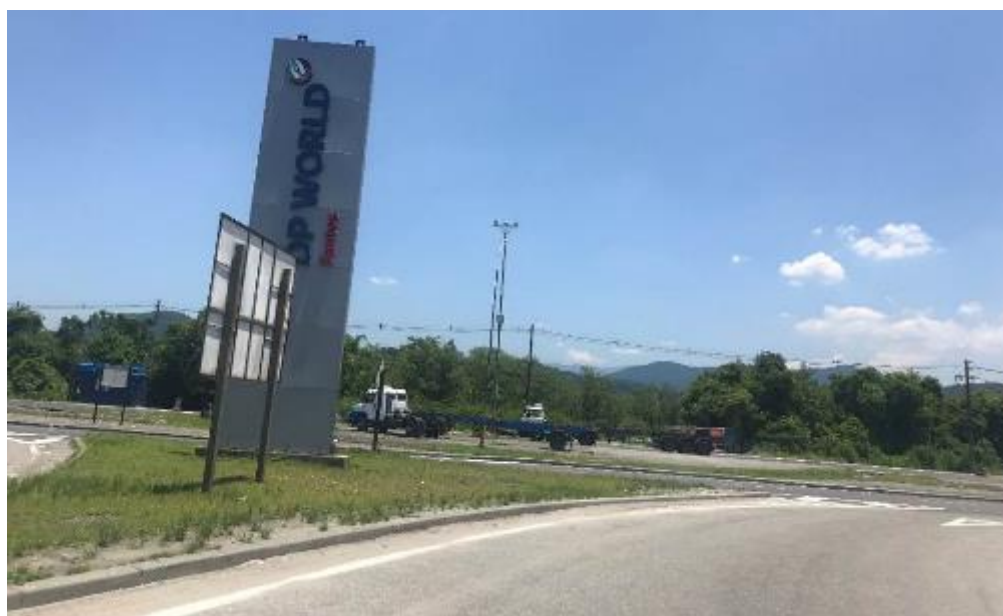
Figura 8-43: Registro fotográfico da Entrada da DP World na Estrada Particular da CODESP.
