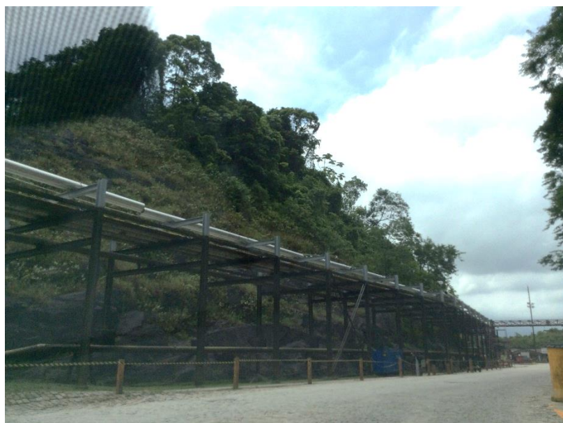
Figura 8-40: Registro fotográfico dos dutos de distribuição de produtos químicos na área interina da Ageo Norte Terminais.
