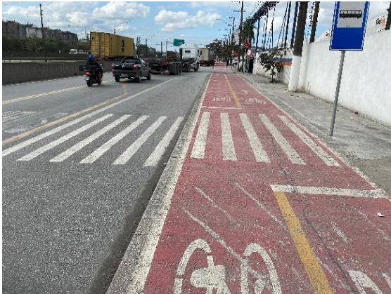
Foto 2.5-3: Sinalização horizontal e vertical.
