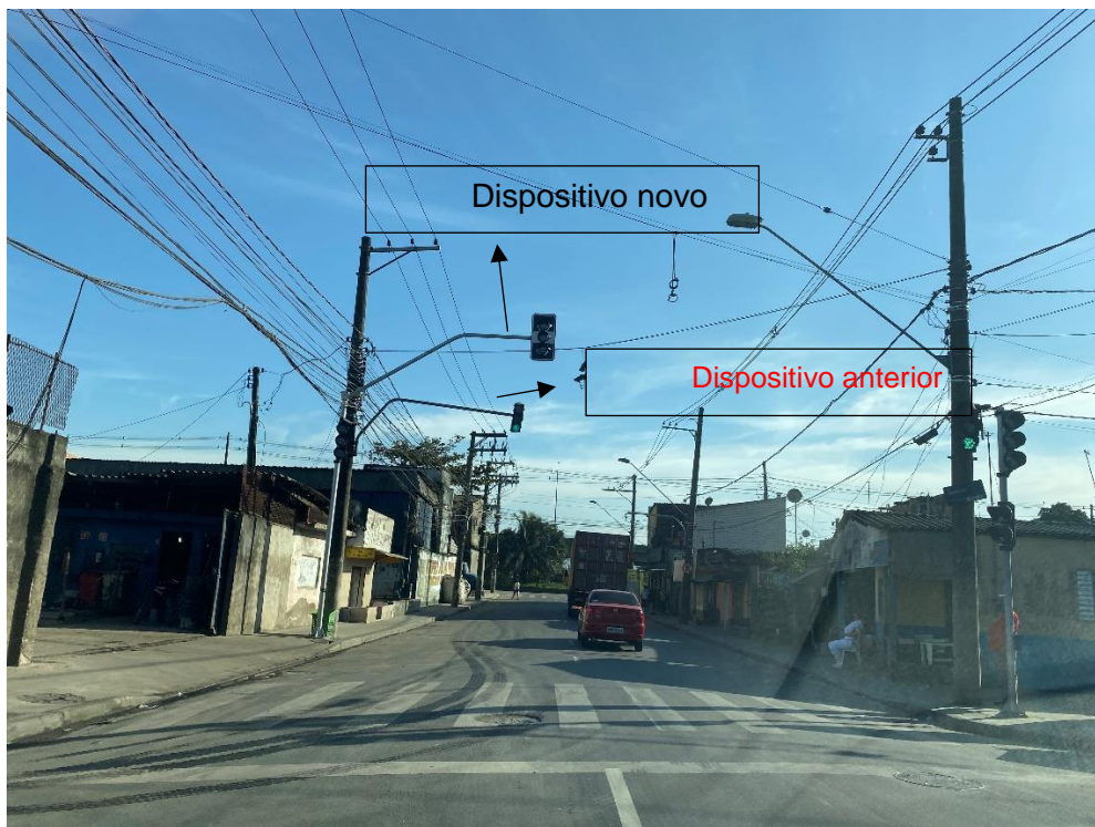
Foto 2.5-4: Sinalização horizontal ao longo da Av. Marginal da Via Anchieta.
