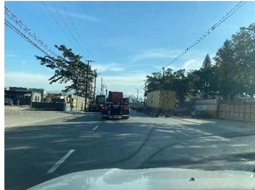
Foto 3.5-2: Rua Bóris Kauffmann – faixa de rolamento em pavimento asfáltico com sinalização horizontal.
