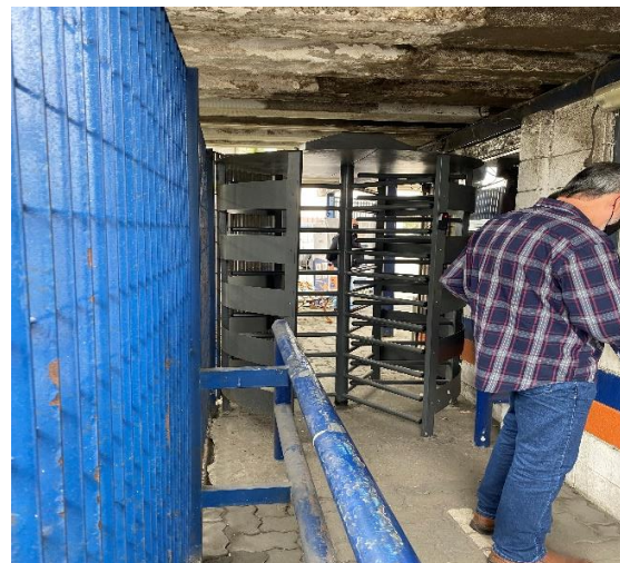
Foto 2.2.1-4: O controle de acesso interno de pedestres é realizado de forma híbrida – com o uso de cancelas eletrônicas e porteiro.
