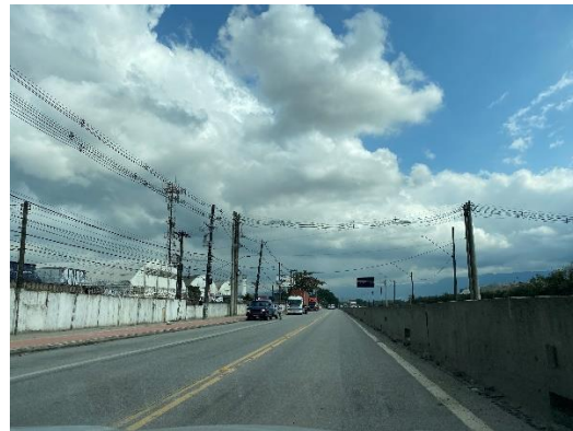
Foto 3.5-4: Av. Marginal da Via Anchieta – faixa de rolamento em pavimento asfáltico com sinalização horizontal e dispositivo de drenagem na lateral direita (Sentido São Manoel).
