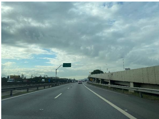
Foto 3.5-3: Rodovia SP 150 – faixa de rolamento em pavimento asfáltico com sinalização horizontal.
