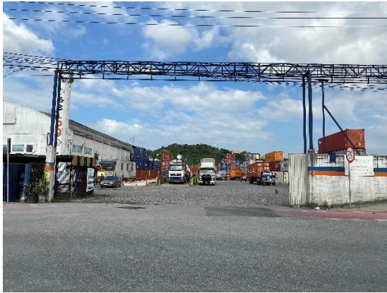
Foto 2.2.1-1: Acesso de veículos.
