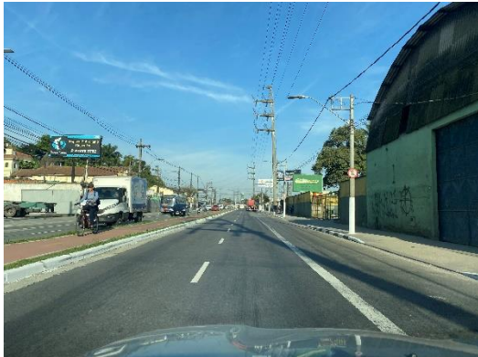
Foto 3.5-1: Av. Nossa Sra. De Fátima – faixa de rolamento em pavimento asfáltico com sinalização horizontal.
