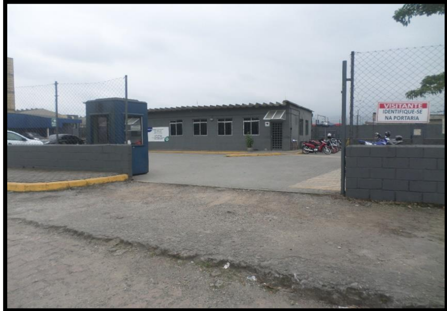
Foto 4 - Entrada e Saída principal MEDLOG Fonte: Engea, 2019.
