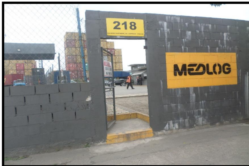
Foto 5 – Vista frontal. Fonte: Engea, 2019.
