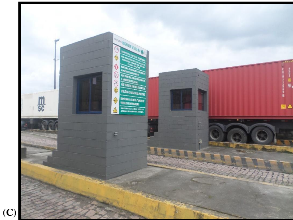
Foto 7 – (A) Visão frontal (B) Visão lateral e (C) Entrada Rua de Servidão MEDLOG. Fonte: Engea, 2019.
