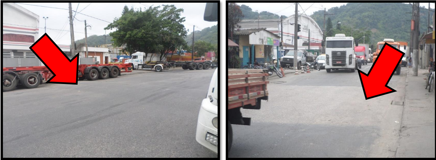
Foto 12 - Lombadas após a MEDLOG. Fonte: Engea, 2019.
