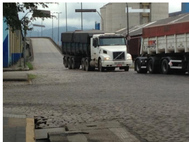
Foto 5.4-2: Aspecto geral da principal via que dá acesso à Zona Portuária (Avenida Eduardo Pereira Guinle), onde localiza-se a Elevações Portuárias. Ressalta-se que a mesma é interligada à av Perimetral, que margeia a área portuária e conduz à Rodovia Anchieta
