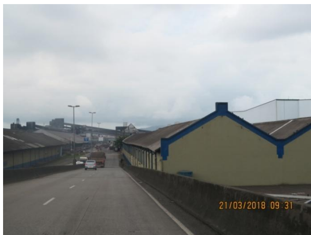
Foto 5.4-1: Aspecto geral da principal via que dá acesso à Zona Portuária (Avenida Eduardo Pereira Guinle), onde localiza-se a Elevações Portuárias
