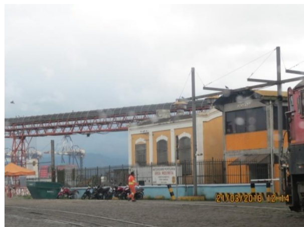
Foto 5.4-8: Aspecto geral das vias da Zona Portuária, com destaque para o Portão 6, da companhia Docas, que dá acesso a área alfandegada
