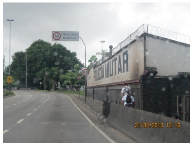
Foto 5.4-10: Avenida Perimetral e Muro do 6º Batalhão da Polícia Militar, vizinho ao Cemitério Paquetá, o mais antigo da cidade, com entrada pela Rua Dr. Cochrane
