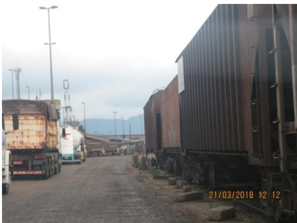
Foto 5.4-7: Aspecto geral das vias da Zona Portuária, onde localiza-se a Elevações Portuárias Destaque para a via Férrea
