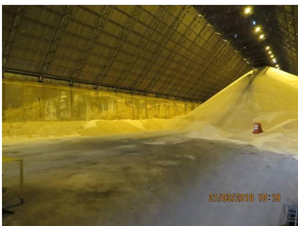
Foto 2.3.2-1: Visão interna do armazém
