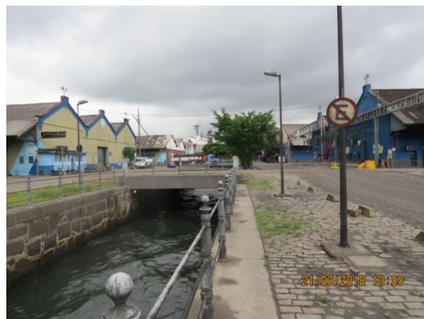
Foto 5.4-6: Aspecto geral das vias da Zona Portuária, com destaque ao Rio Soldado, por onde navegam as catraias. (Avenida Ulrico Mursa)
