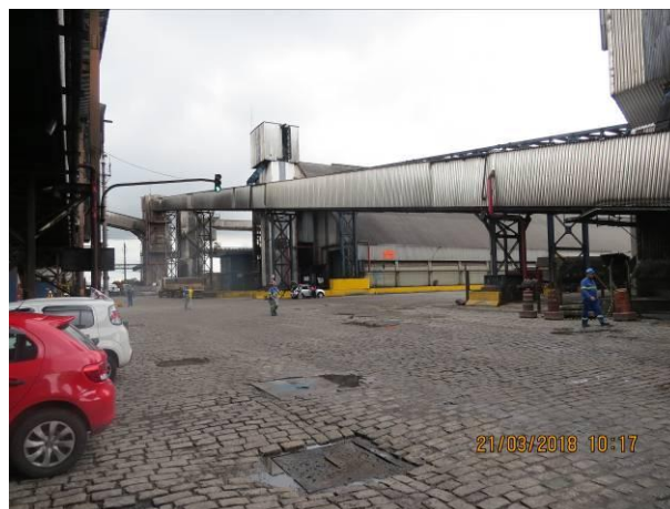
Foto 2.3.3-2: Sistema de esteiras transportadoras que conecta aos ship-loaders
