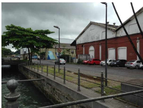
Foto 5.4-3: Antiga Casa do Café, Vizinha ao canal do rio Soldado e dos armazéns da Rodrimar e Elevações Portuárias, na esquina da Avenida Eduardo Pereira Guinle e Avenida Ulrico Mursa
