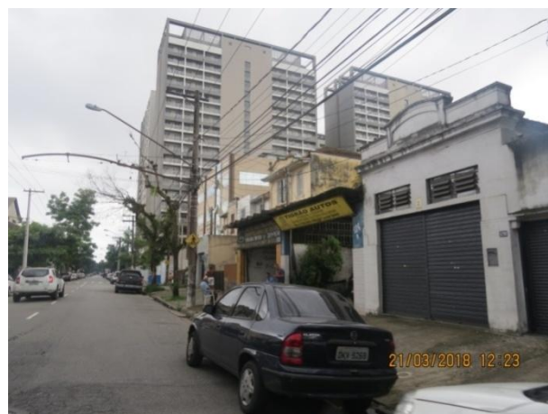
Foto 5.4-16: Um dos poucos edifícios existentes na área de Influência, situados na Rua Dr Emilio Ribas
