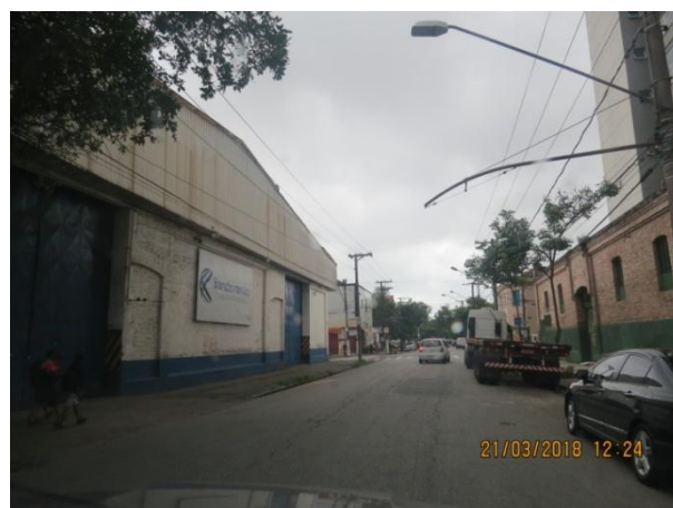
Foto 5.4-20: Galpão de Logística na Rua Dr. Emílio Ribas
