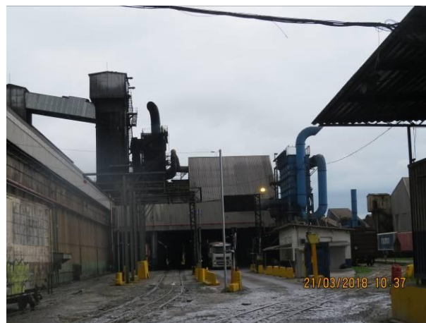
Foto 2.3.1-2: Área da moega de descarregamento
