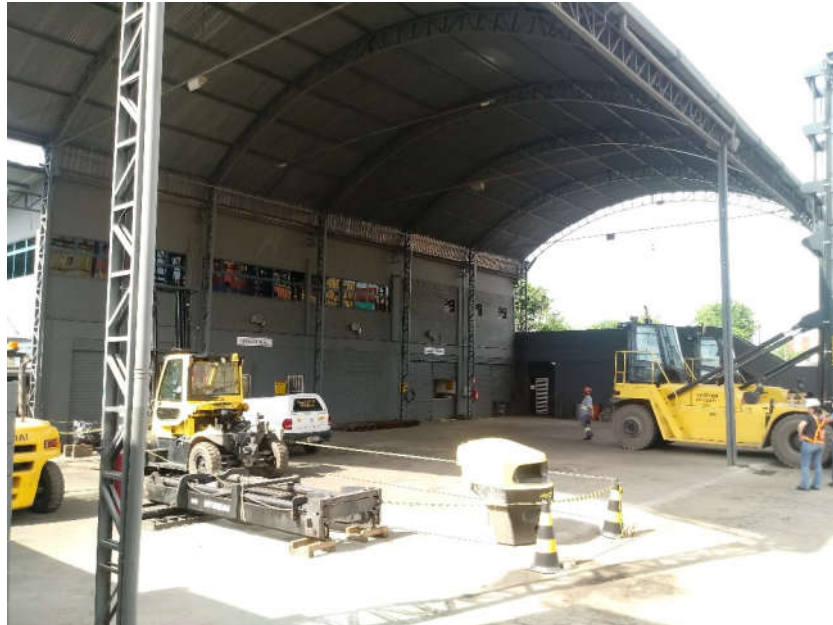
Figura 3.7 – Área de Manutenção de Empilhadeiras
