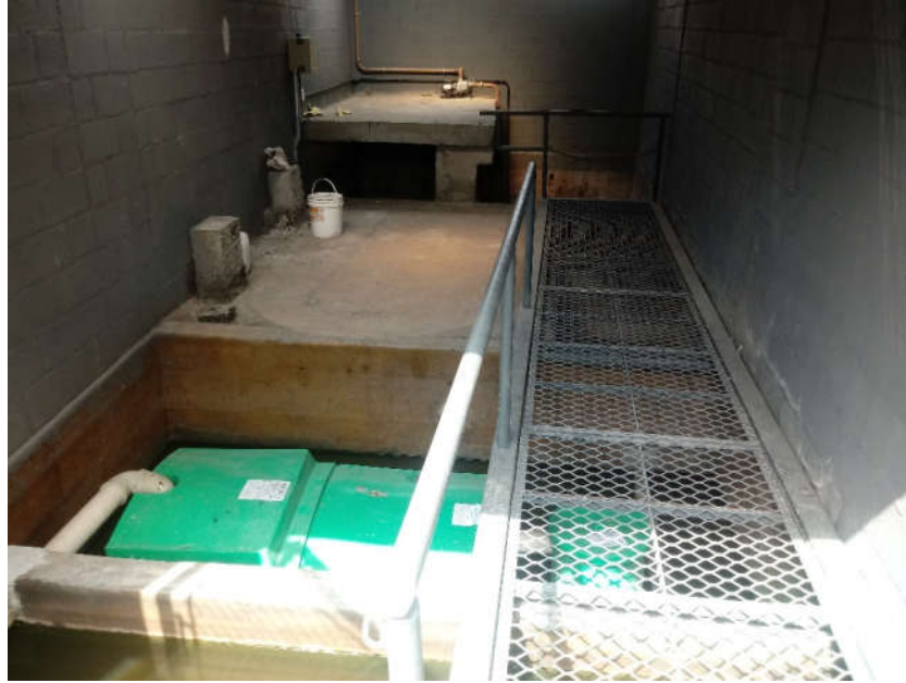
Figura 3.8 – Estação de Tratamento de Efluentes
