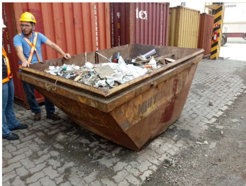
Foto 6.1 – Contêiner metálico com resíduos perigosos disposto em área não impermeabilizada
