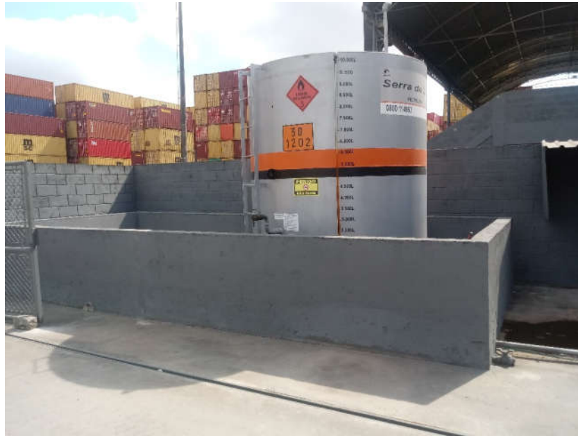
Figura 3.5 – Tanque de armazenamento de combustível (diesel)
