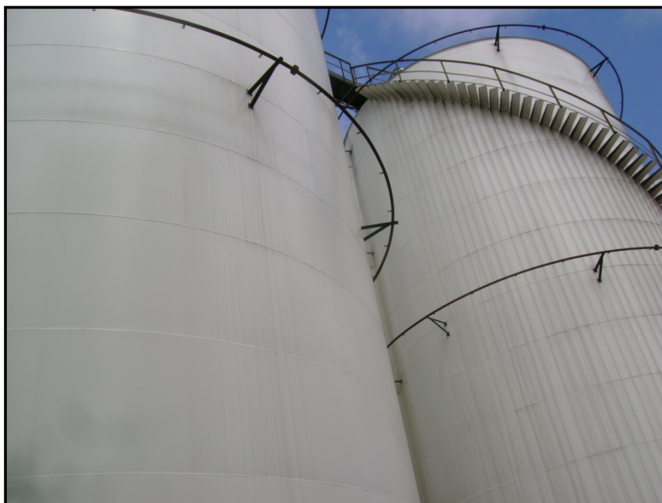
Figura 2.3 – Tanques de armazenamento com anéis aspersores
