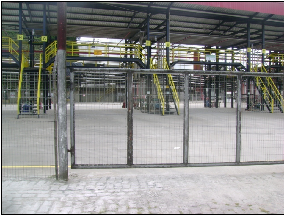
Figura 2.1 – Plataforma de carregamento rodoviário
