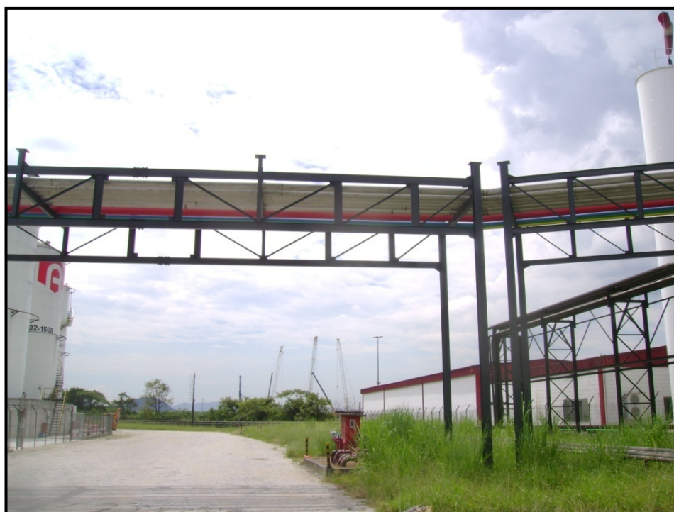
Figura 2.2 – Foto do pipe-rack
