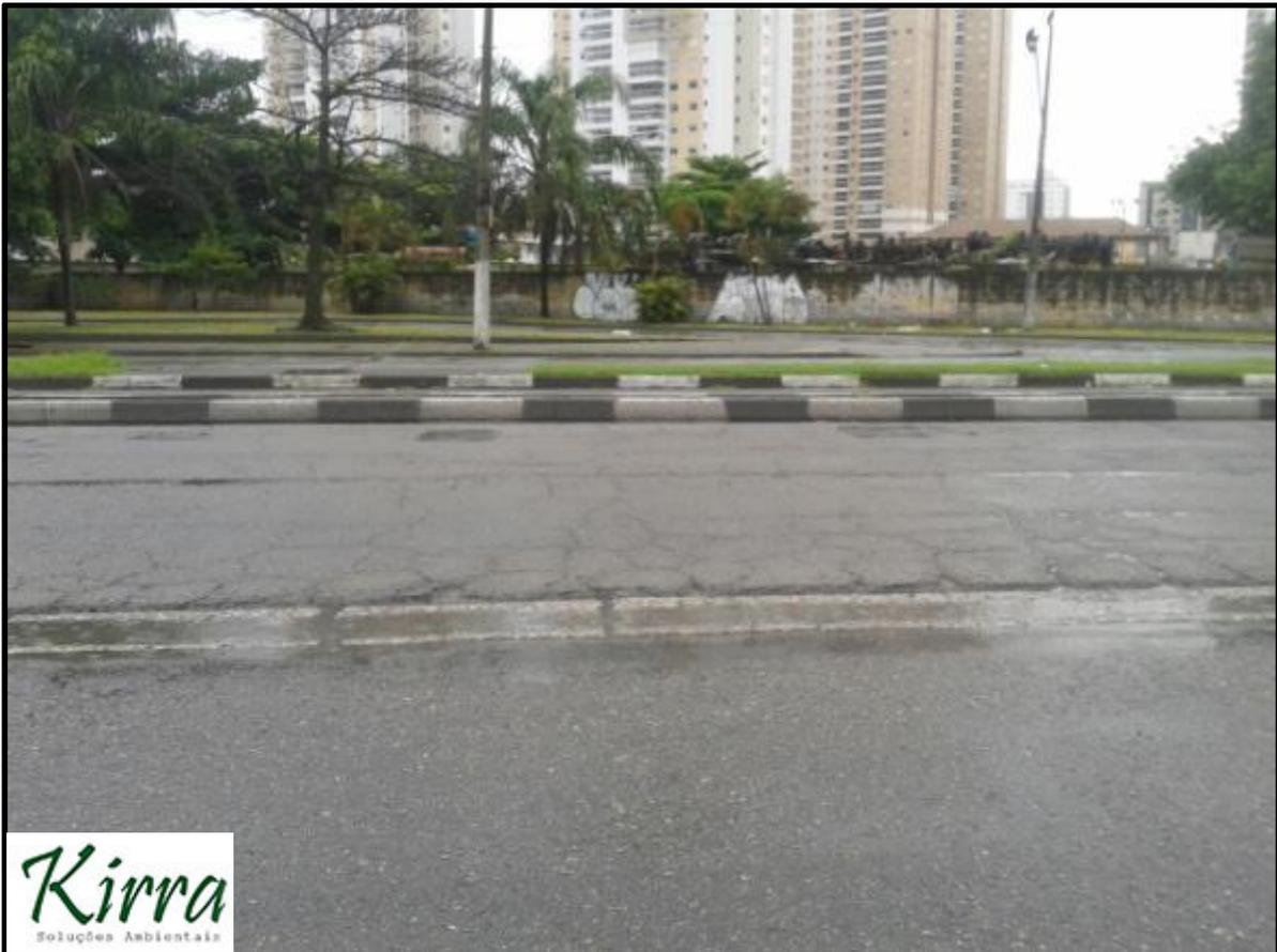
**Figura 06. Pavimento asfáltico com início de deterioração na Avenida Mário Covas sentido Balsa/Centro. Fonte: Kirra, Janeiro/2017.**
