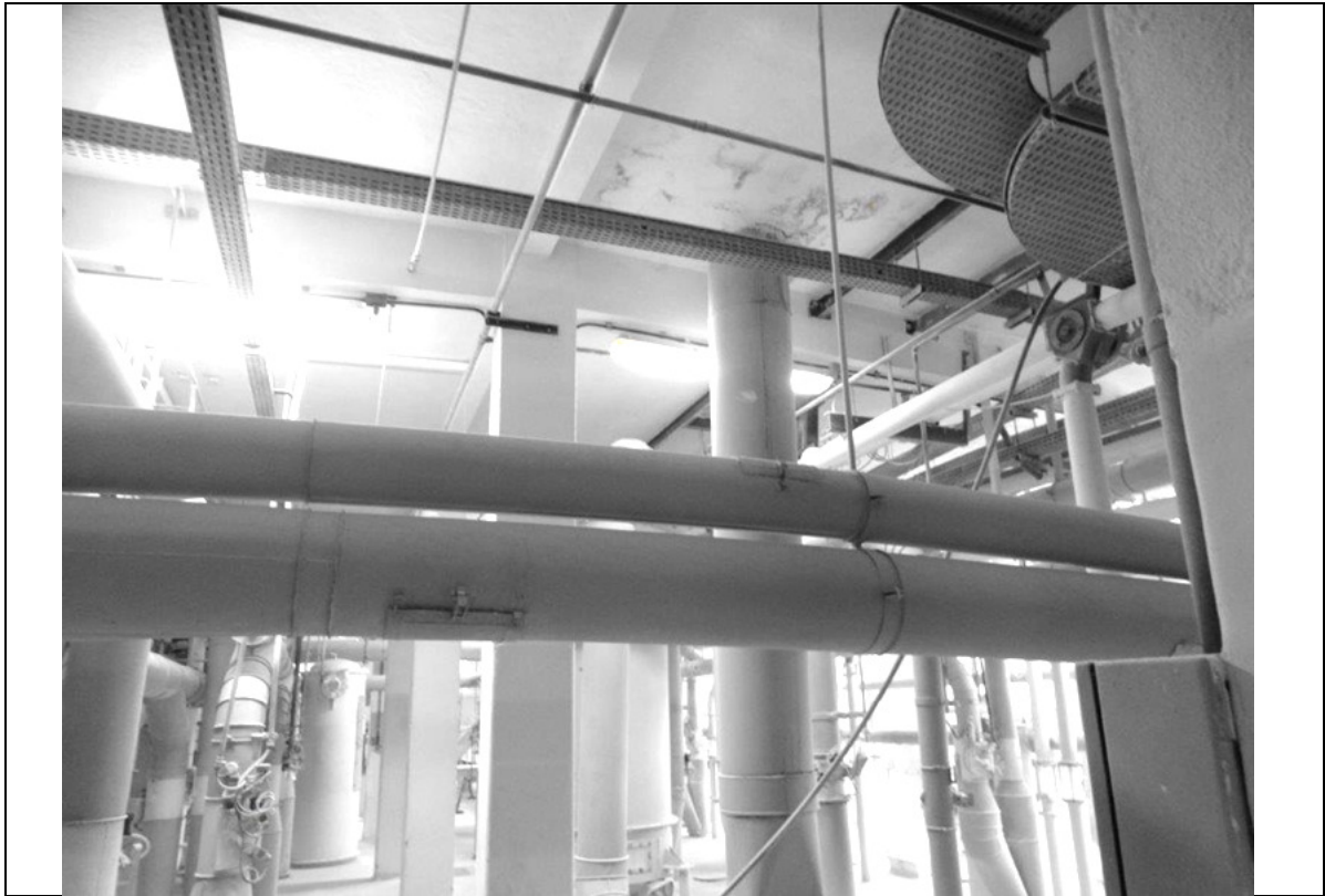
FOTO 130 – PRÉDIO H0 - 4º ANDAR.
