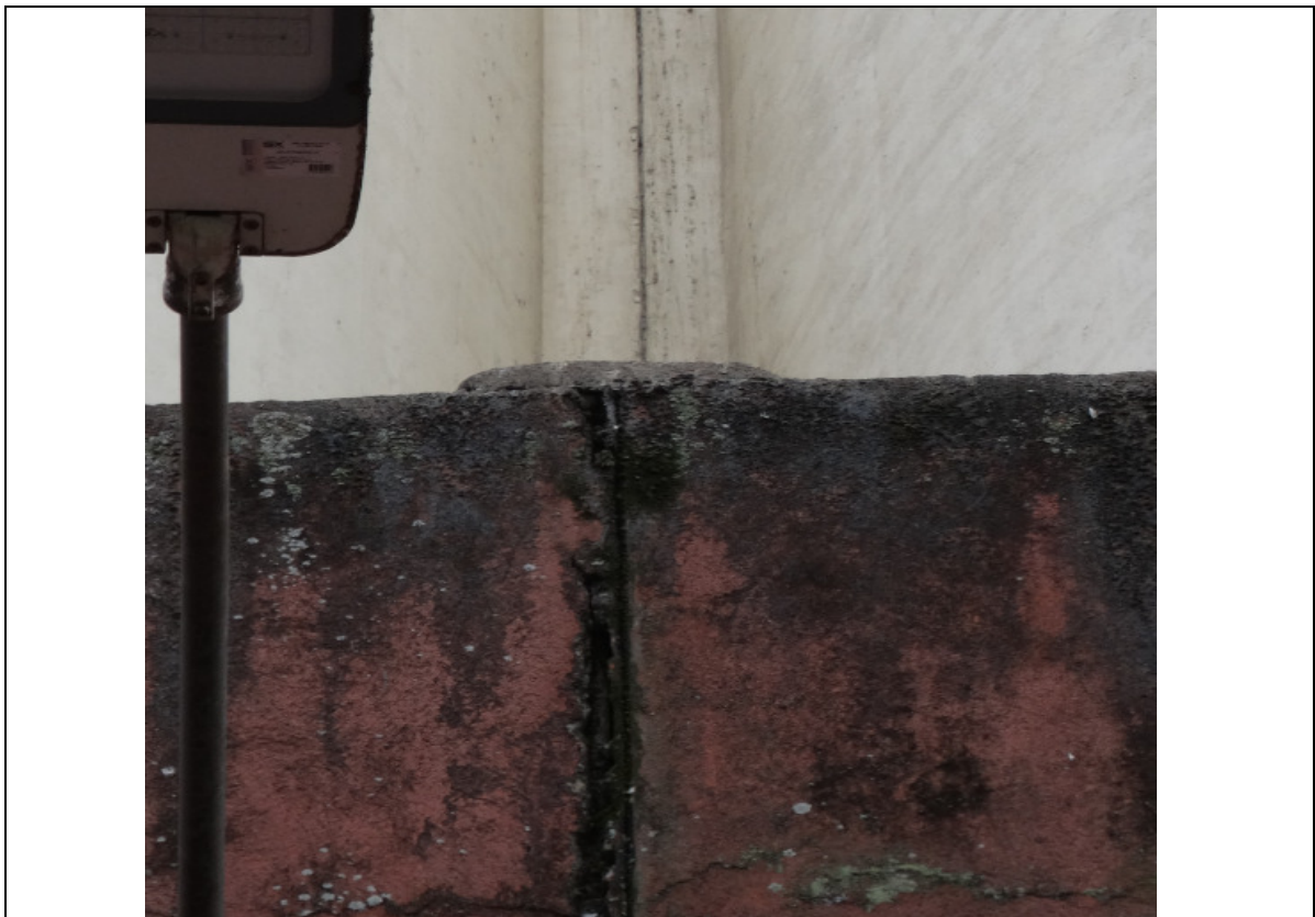
FOTO 225 – DETALHE DA FOTO ANTERIOR: OBSERVA-SE TRECHO SUPERIOR DA ALVENARIA COM A JUNTA ESTRUTURAL PREENCHIDA COM MATERIAL RÍGIDO.
