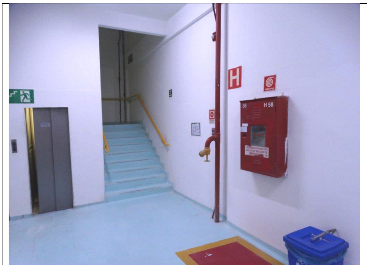
FOTO 153 – PRÉDIO H0 - 2º ANDAR.
