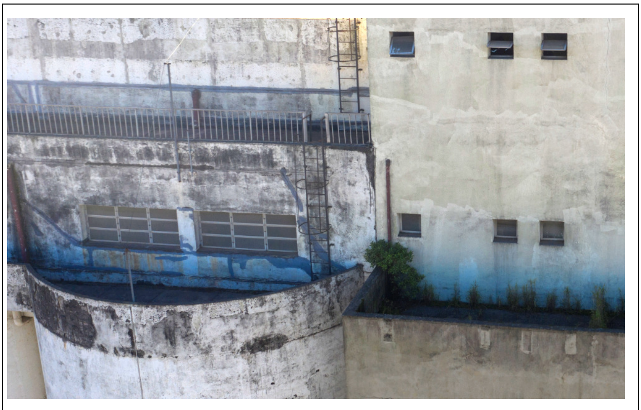
FOTO 277 – DETALHE DE FOTO DA PARTE SUPERIOR DO MEGASILO: ESCORRIMENTO DE SUJIDADES PELAS PARTES SUPERIORES OU PLATIBANDAS PELA AUSÊNCIA DE RUFOS. CRESCIMENTO DE PLANTAS SOBRE TRECHO DE LAJE.
