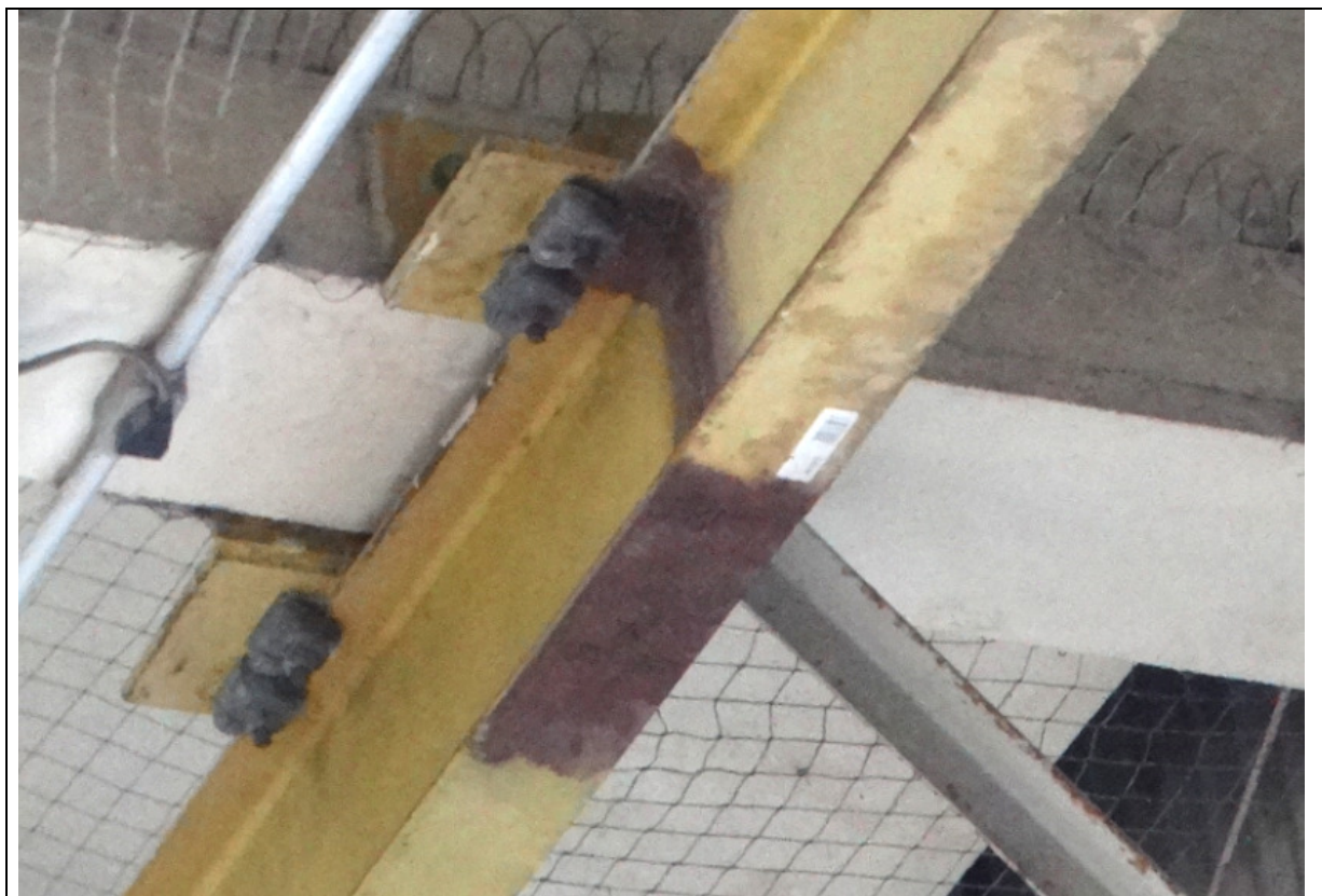
FOTO 78 - DETALHE DA FOTO ANTERIOR: CORROSÃO LOCALIZADA.
