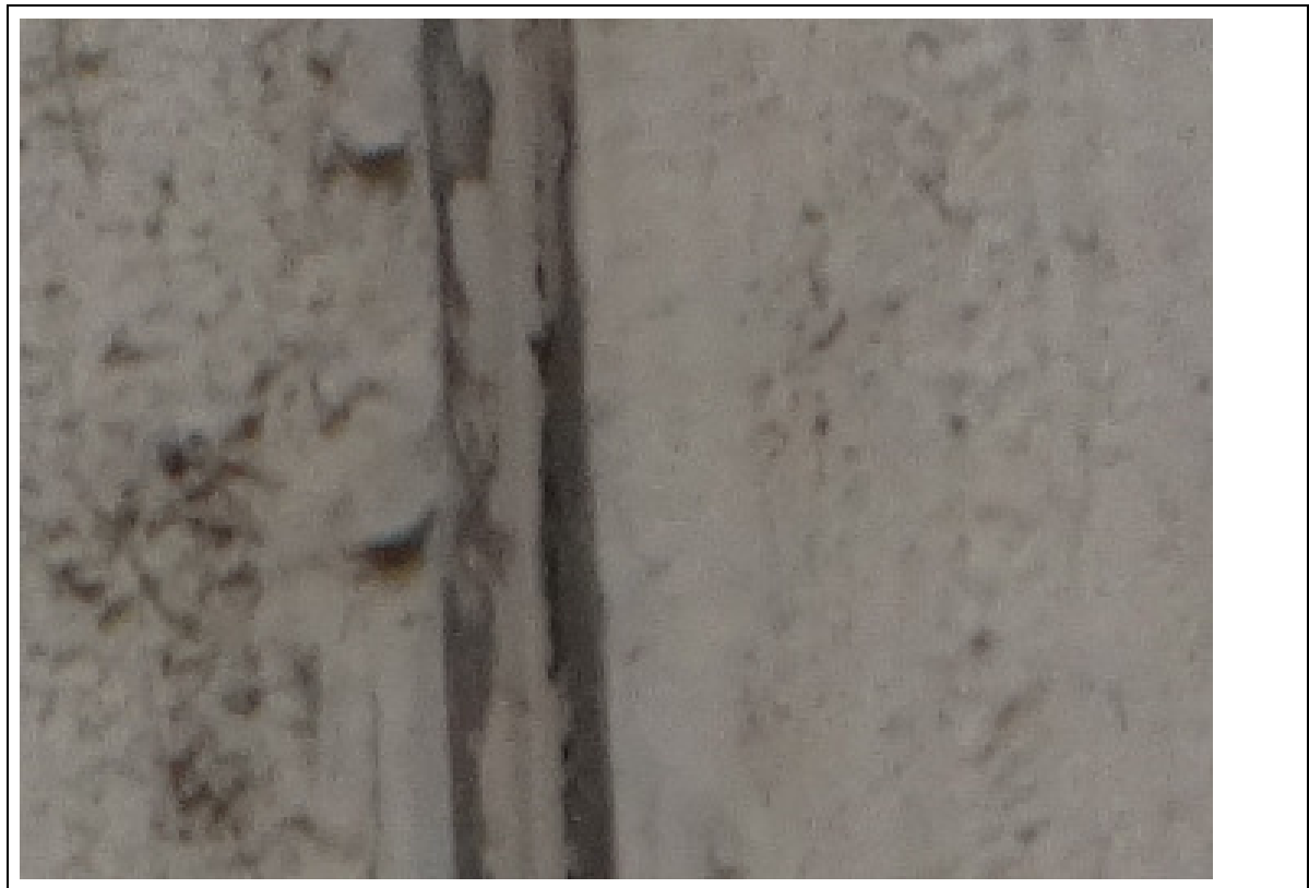
FOTO 223 – DETALHE DA FOTO ANTERIOR: TRECHO PREENCHIDO COM SELANTE, APRESENTANDO RUPTURA DE ADESÃO DO SELANTE COM O LÁBIO LATERAL DA JUNTA.
