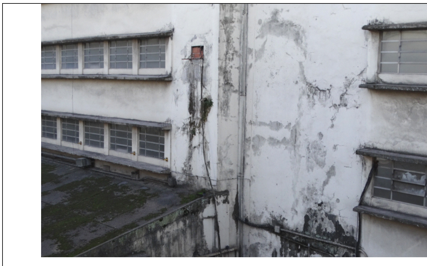
FOTO 87 – VISTA DE UMA DAS FACES DO PRÉDIO DA MOAGEM A.
