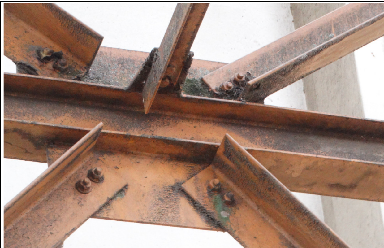
FOTO 214 – DETALHE DA FOTO 211: DIVERSOS TRECHOS DA ESTRUTURA METÁLICA COM CORROSÃO SUPERFICIAL.
