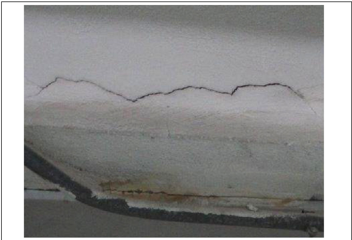
FOTO 108 – DETALHE DA FOTO ANTERIOR: NECESSÁRIO INSPECIONAR DE FORMA INVASIVA, PARA VERIFICAR SE A ARMADURA ESTÁ CORROÍDA, TRATANDO ADEQUADAMENTE.
