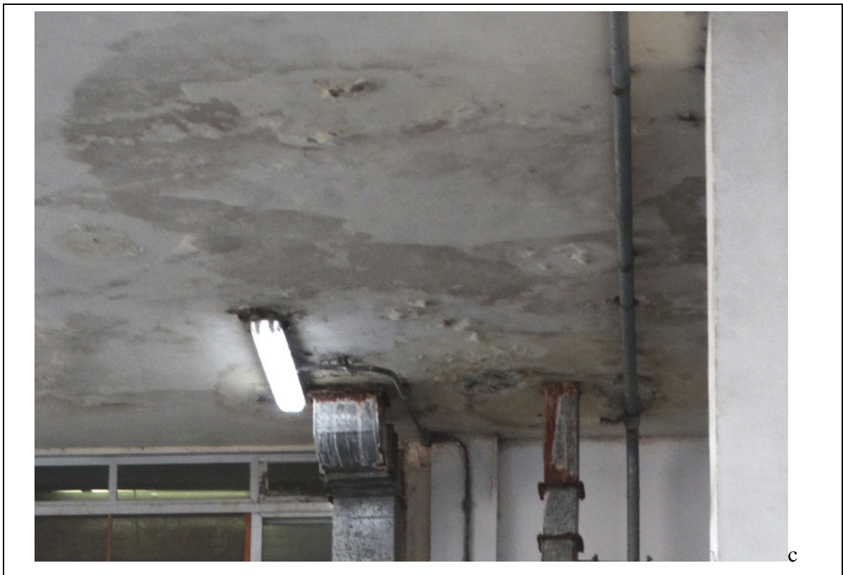
FOTO 32 – DETALHE DA FOTO ANTERIOR: EXTENSAS MANCHAS DE UMIDADE.
