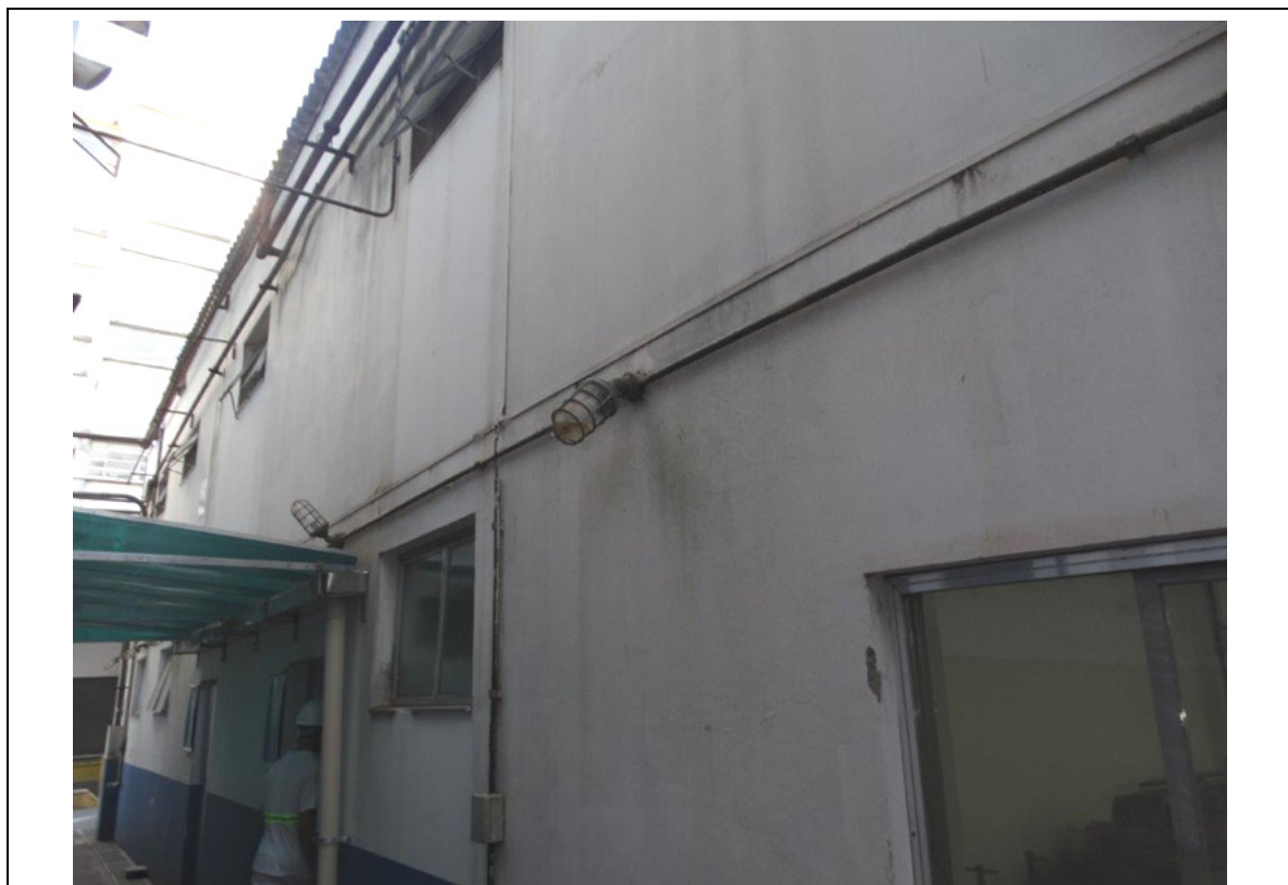
FOTO 26 – LATERAL PRÉDIO VESTIÁRIOS.
