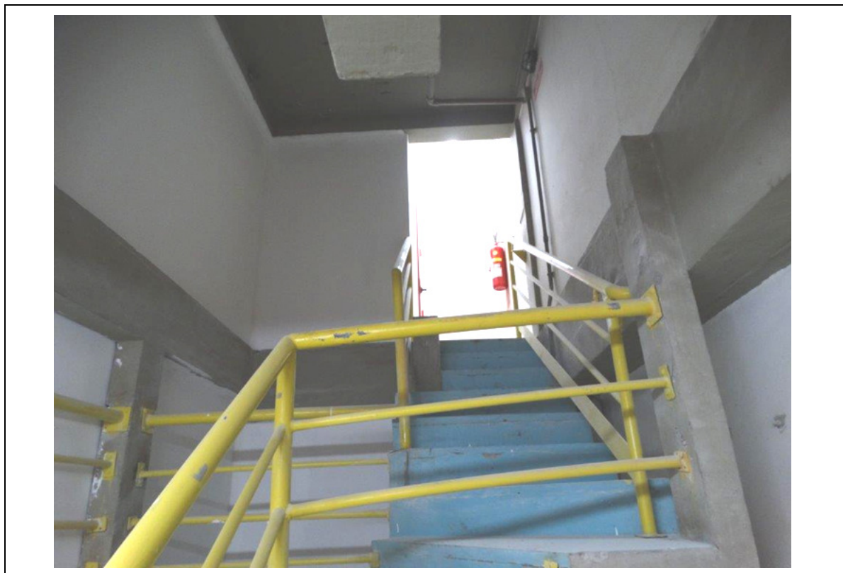
FOTO 164 – PRÉDIO H1: CASA DE MÁQUINAS / BARRILETE.
