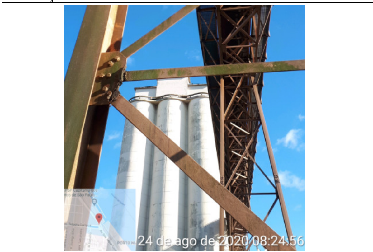
FOTO 303 - VISTA DA PARTE INTERMEDIÁRIA DA ESTRUTURA.
