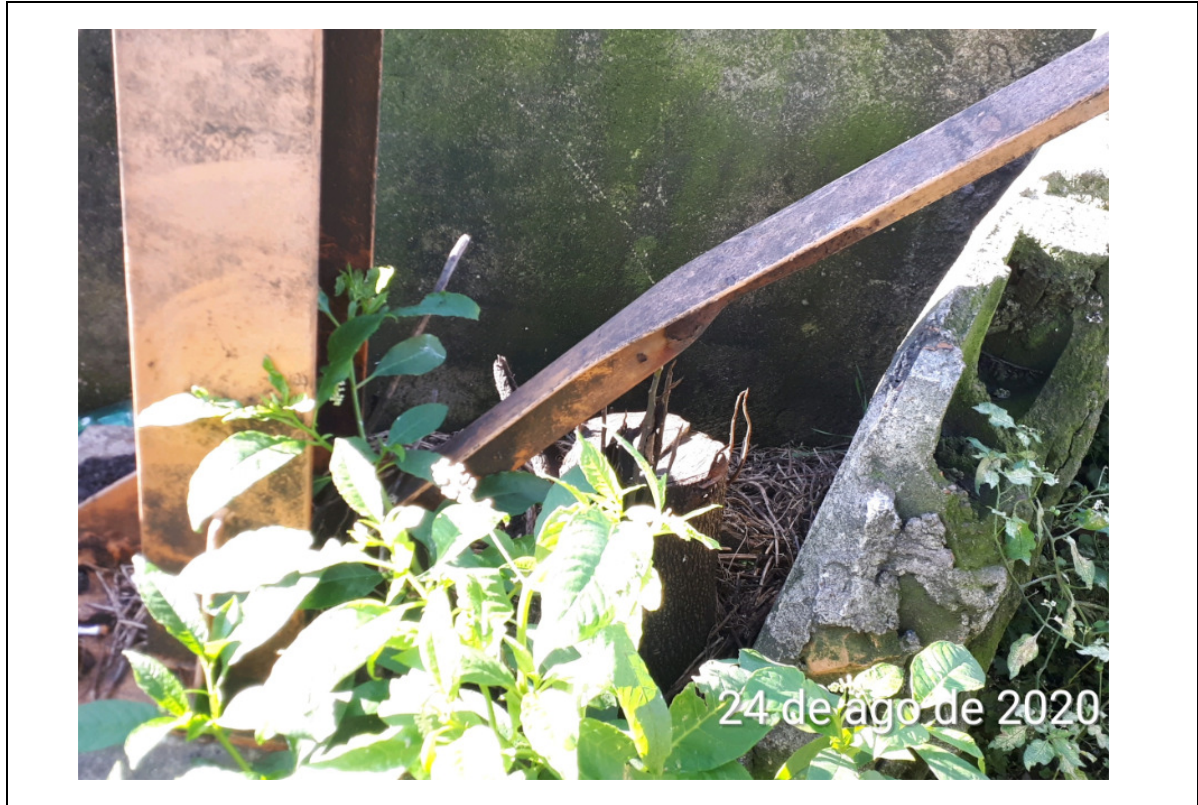
FOTO 302 - DETALHE DE UMA BARRA DESTA BASE, COM DEFORMAÇÃO.
