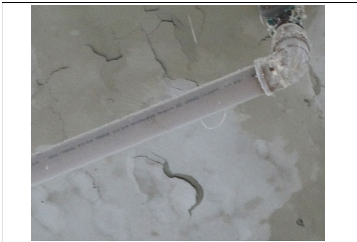
FOTO 166 – DETALHE DA FOTO ANTERIOR: CORROSÃO NO FUNDO DA LAJE DO RESERVATÓRIO, COM DESTACAMENTO DE PLACAS DE CONCRETO.
