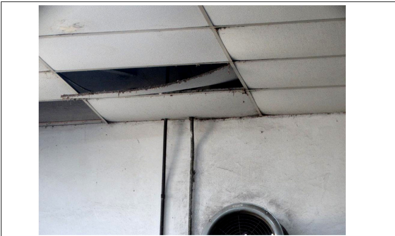
FOTO 09 – DETALHE DO FORRO DA FOTO ANTERIOR: PLACA NA IMINÊNCIA DE SOLTAR DO FORRO.
