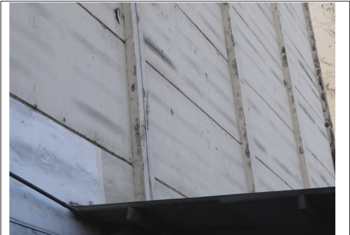
FOTO 189 – DETALHE DA MESMA FACHADA ANTERIOR, ACIMA DA OFICINA DE EMPILHADEIRA.
