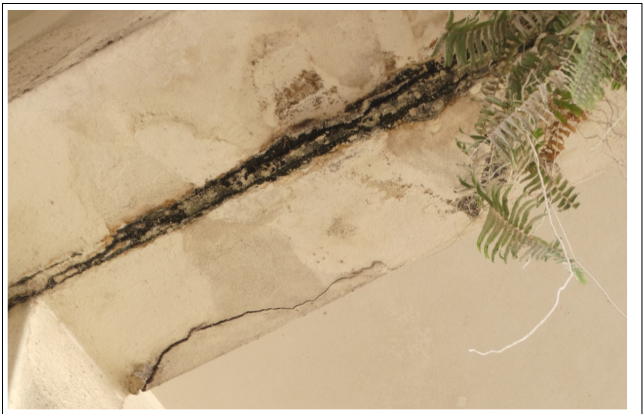
FOTO 149 – DETALHE DA FOTO ANTERIOR: INDÍCIO DE CORROSÃO DA ARMADURA DA VIGA. NECESSÁRIO REALIZAR UMA INSPEÇÃO INVASIVA, CASO EXISTA CORROSÃO TRATAR ADEQUADAMENTE.
