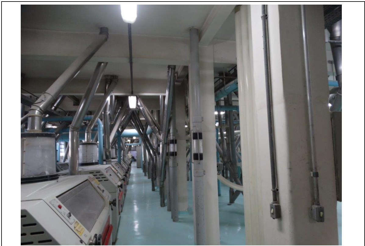
FOTO 63 – MOAGEM A - 5º ANDAR.
