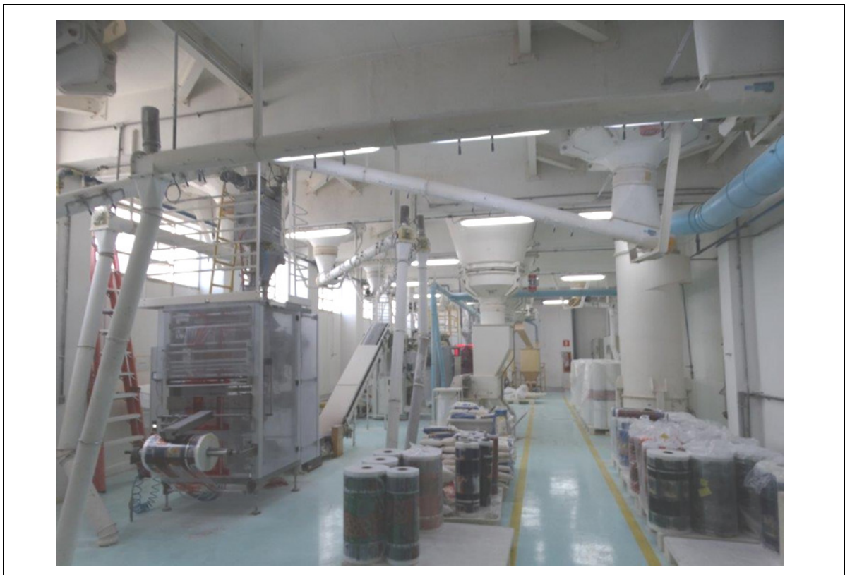
FOTO 169 – PRÉDIO H1: 3º ANDAR.
