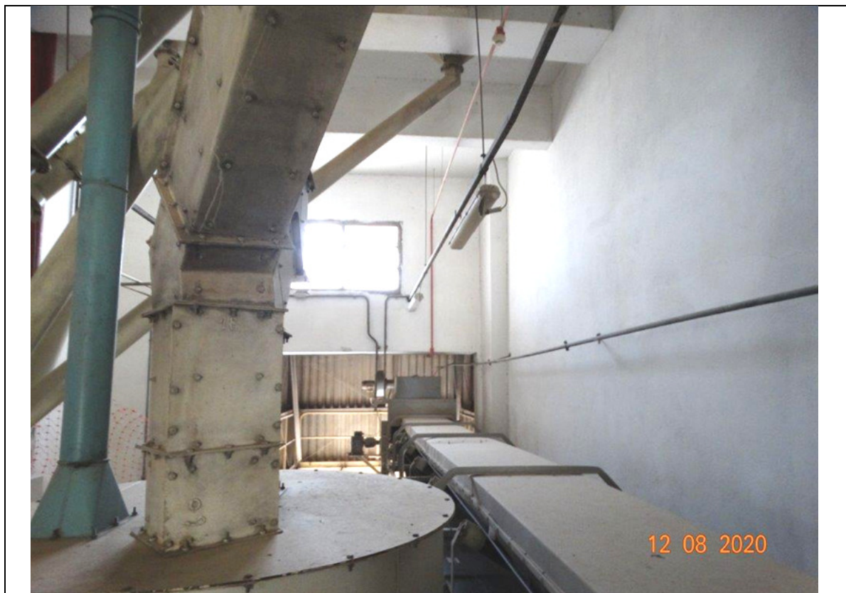
FOTO 253 – MEGASILO: 5º ANDAR.
