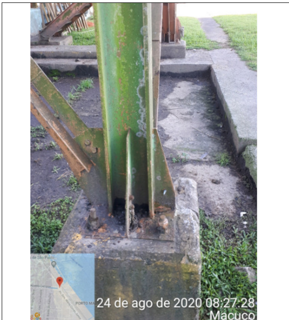
FOTO 309 - UMA DAS BASES DA TORRE, COM ACÚMULO DE SUJIDADES, COLÔNIA DE FUNGOS E BACTÉRIAS COM COR ESVERDEADA. CORROSÃO LOCALIZADA.
