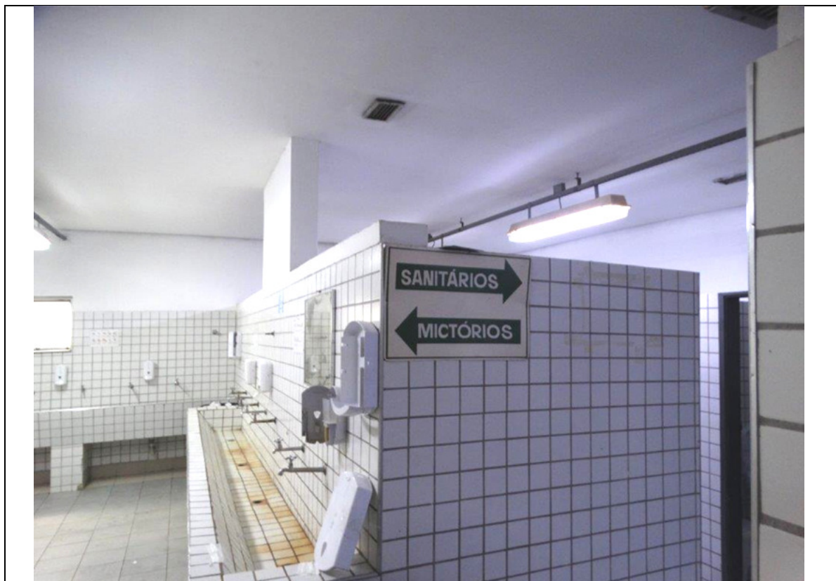
FOTO 29 – 1º ANDAR – VESTIÁRIO.
