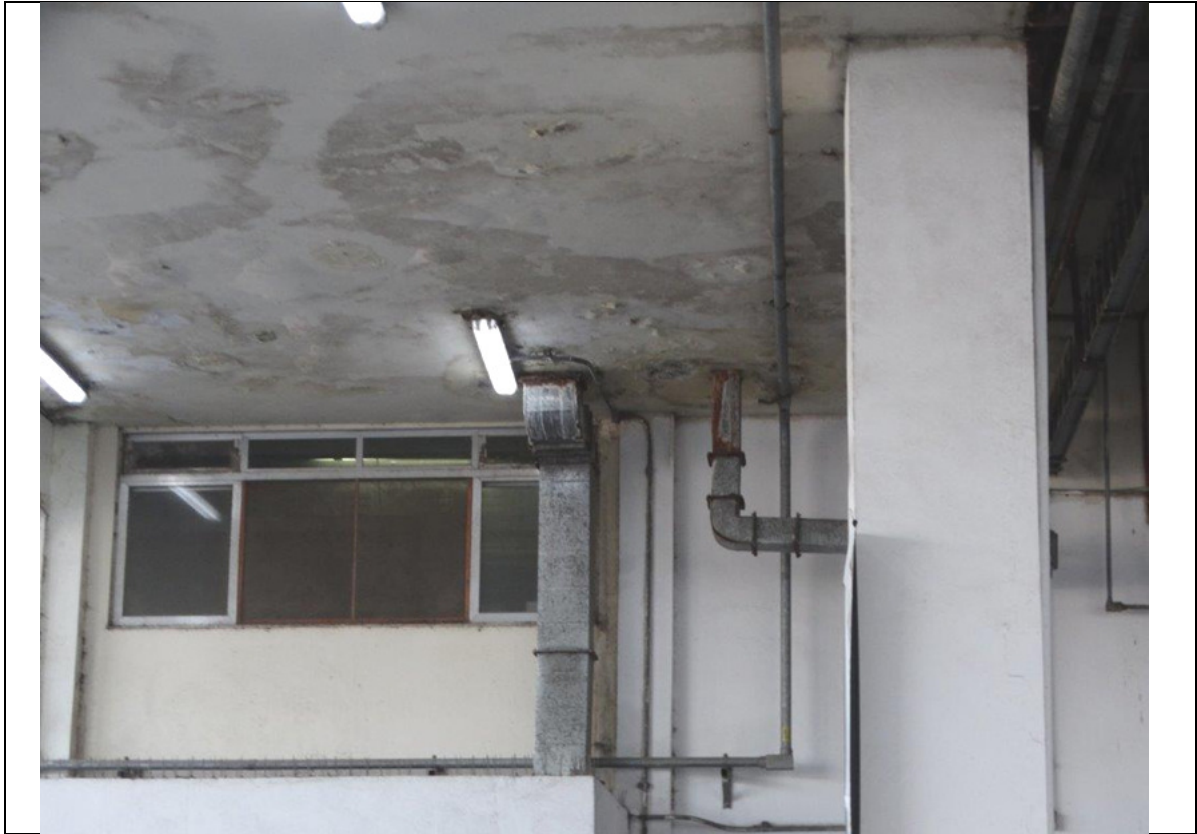
FOTO 31 – DETALHE DA FOTO ANTERIOR: EXTENSAS MANCHAS DE UMIDADE.
