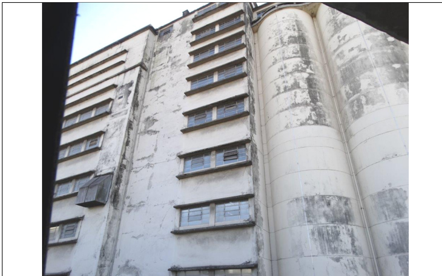
FOTO 86 – VISTA DE UMA DAS FACES DO PRÉDIO DA MOAGEM A.
