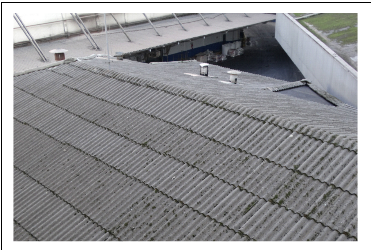
FOTO 17 – TELHADO DA CARPINTARIA E OFICINAS.
