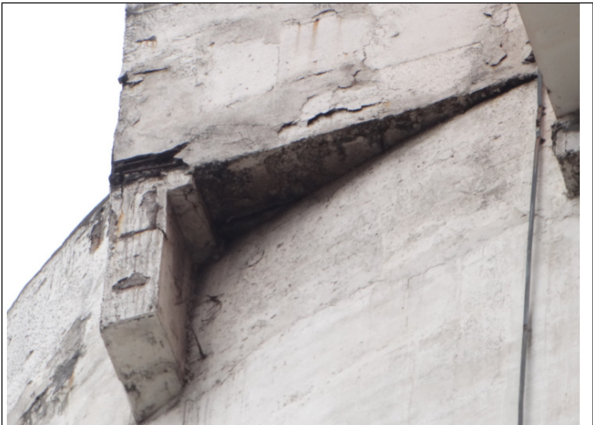
FOTO 234 – DETALHE DA FOTO ANTERIOR: ALGUNS TRECHOS DA ESTRUTURA DE CONCRETO ARMADO APRESENTAM CORROSÃO COM DESTACAMENTO DA CAMADA DE COBRIMENTO DO CONCRETO.
