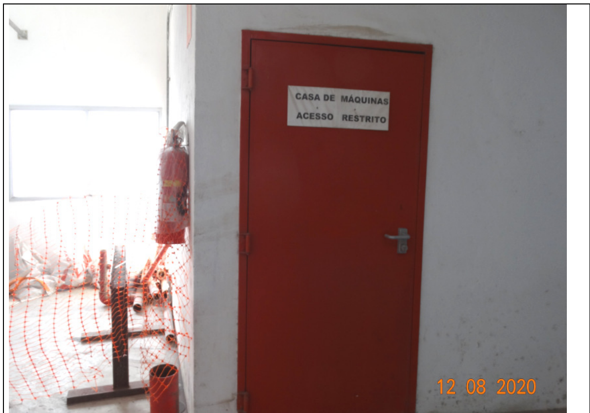
FOTO 244 – MEGASILO: CASA DE MÁQUINAS.
