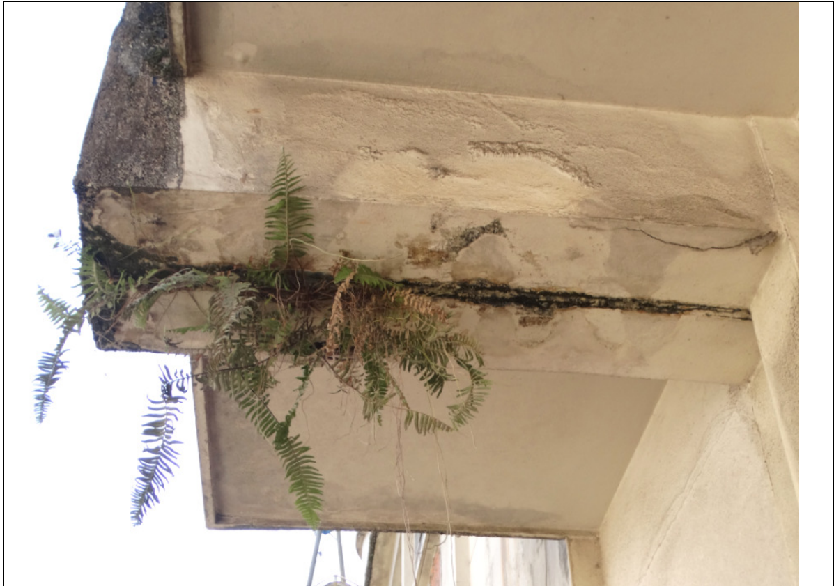
FOTO 148 – DETALHE DA FOTO ANTERIOR: CRESCIMENTO DE PLANTAS NO INTERIOR DE JUNTA DE DILATAÇÃO. NECESSÁRIO LIMPAR E SELAR COM SELANTE DE POLIURETANO.
