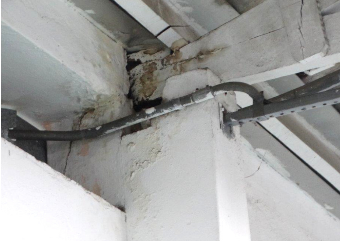
FOTO 11 – DETALHE DE PILAR COM TRELIÇA DA FOTO ANTERIOR: MANCHA DE UMIDADE. NECESSÁRIO EXAMINAR SE A CALHA DO TELHADO APRESENTA ALGUM PONTO DE VAZAMENTO OU SE JÁ FOI SANADO.
