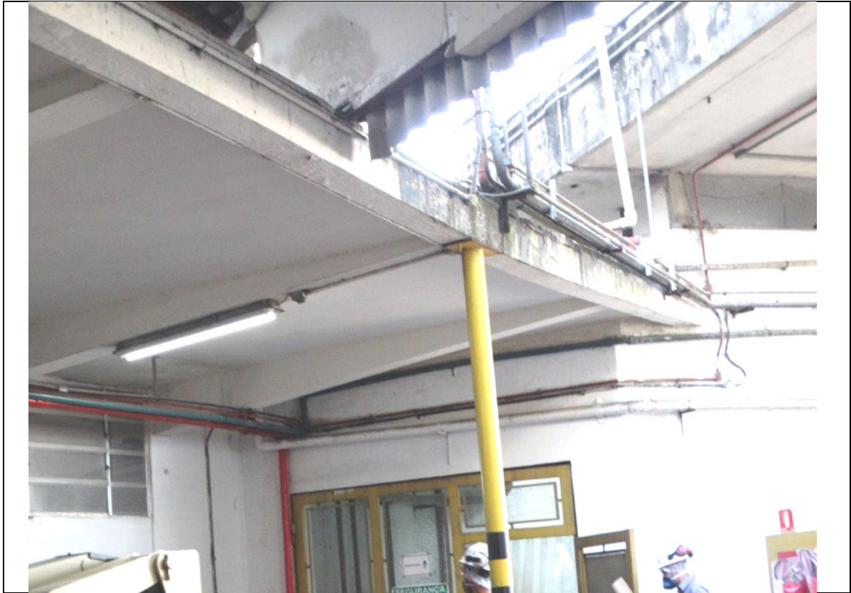
FOTO 43 – MARQUISE: NECESSÁRIO INVESTIGAR MOTIVO DO ESCORAMENTO NA PONTA DO BALANÇO.
