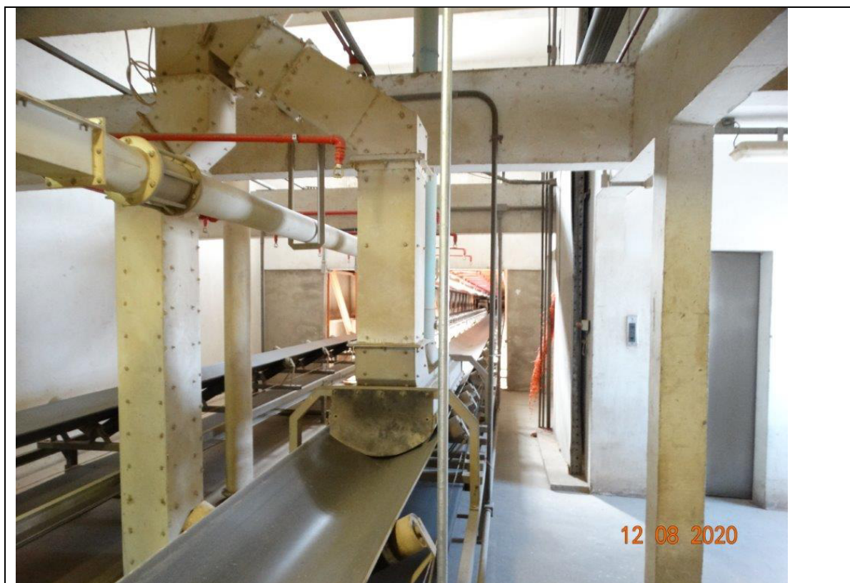
FOTO 258 – MEGASILO: 3º ANDAR.
