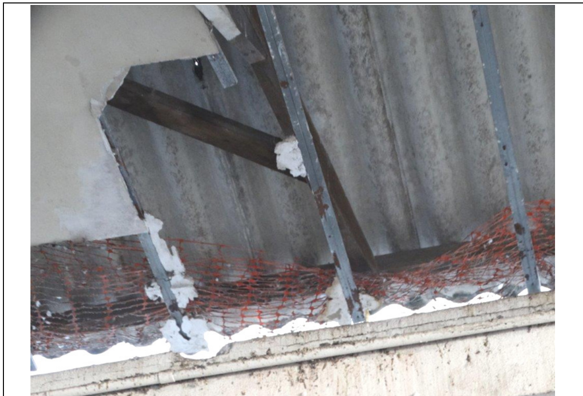
FOTO 45 – TRECHO DA COBERTURA.
