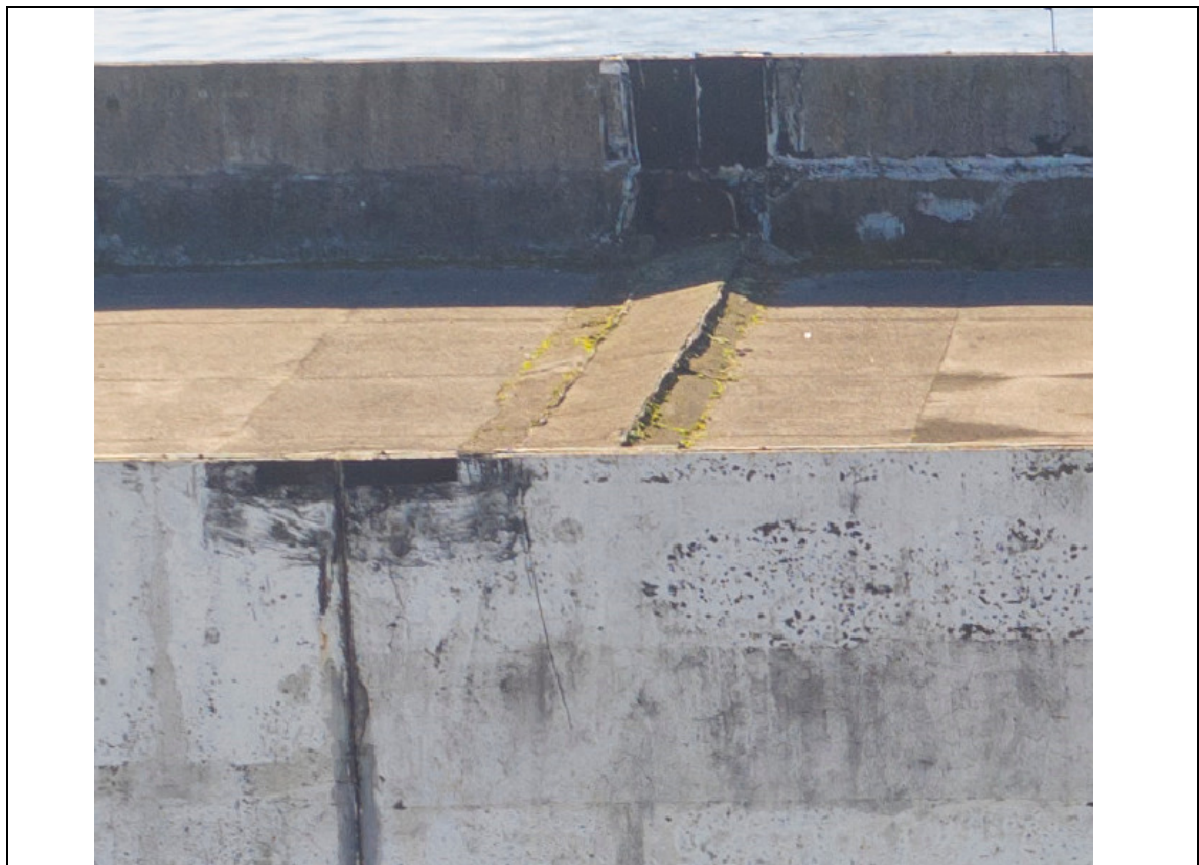
FOTO 279 – DETALHE DA FOTO ANTERIOR: NECESSÁRIO INSPECIONAR "IN LOCO" SE A JUNTA DE DILATAÇÃO TEM CONTINUIDADE E ALINHAMENTO; PROTEÇÃO MECÂNICA COM SUJIDADES E COM SALIÊNCIA.
