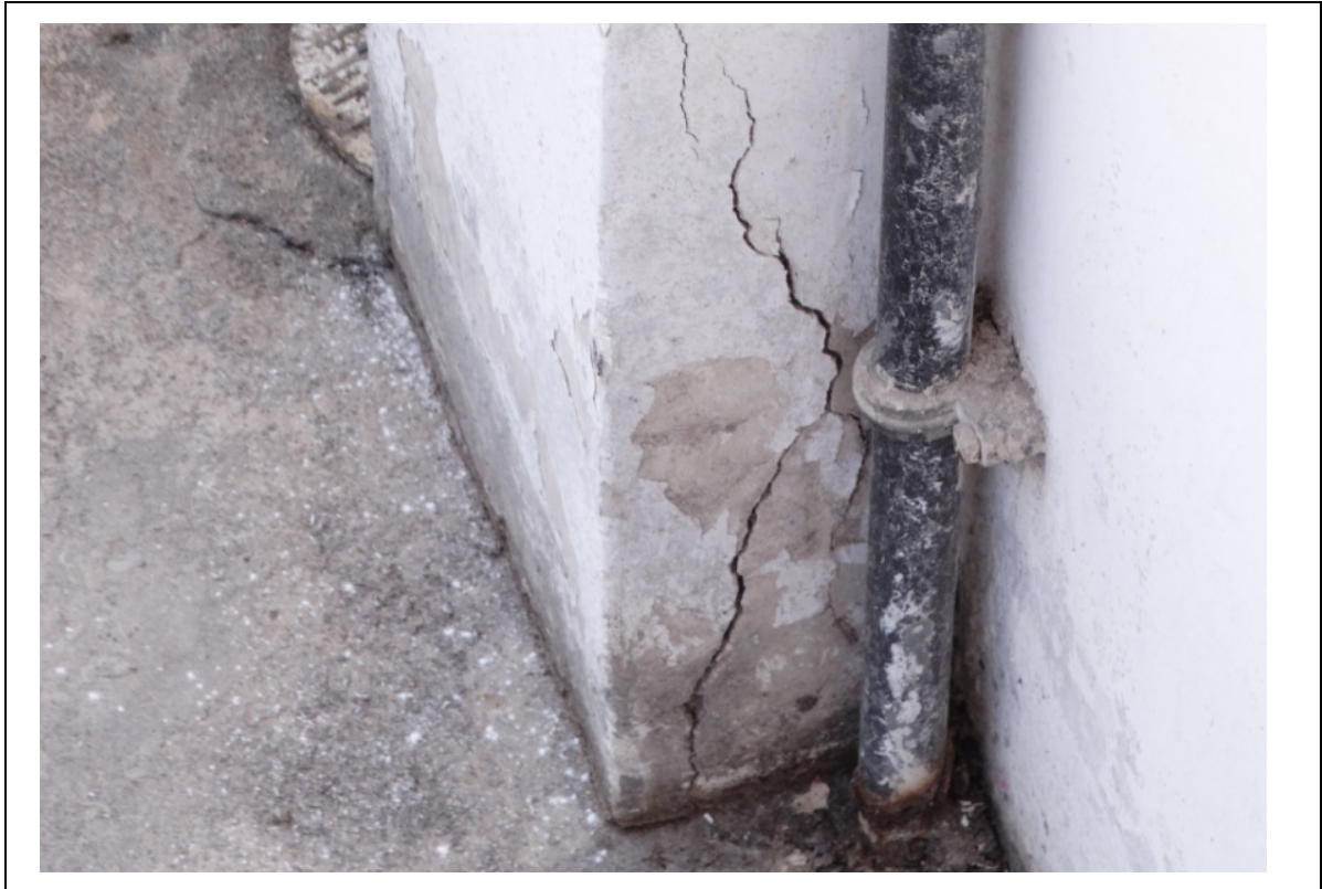
FOTO 142 – DETALHE DA FOTO ANTERIOR: INDÍCIO DE CORROSÃO DA ARMADURA DO PILAR. NECESSÁRIO REALIZAR UMA INSPEÇÃO INVASIVA, CASO EXISTA CORROSÃO TRATAR ADEQUADAMENTE.
