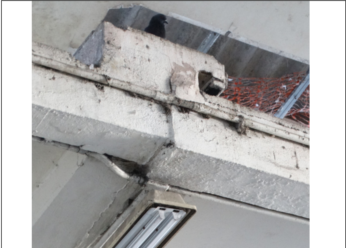
FOTO 41 – DETALHE DA FOTO ANTERIOR: TRECHO COM JUNTA DE DILATAÇÃO SEM O SELANTE.
