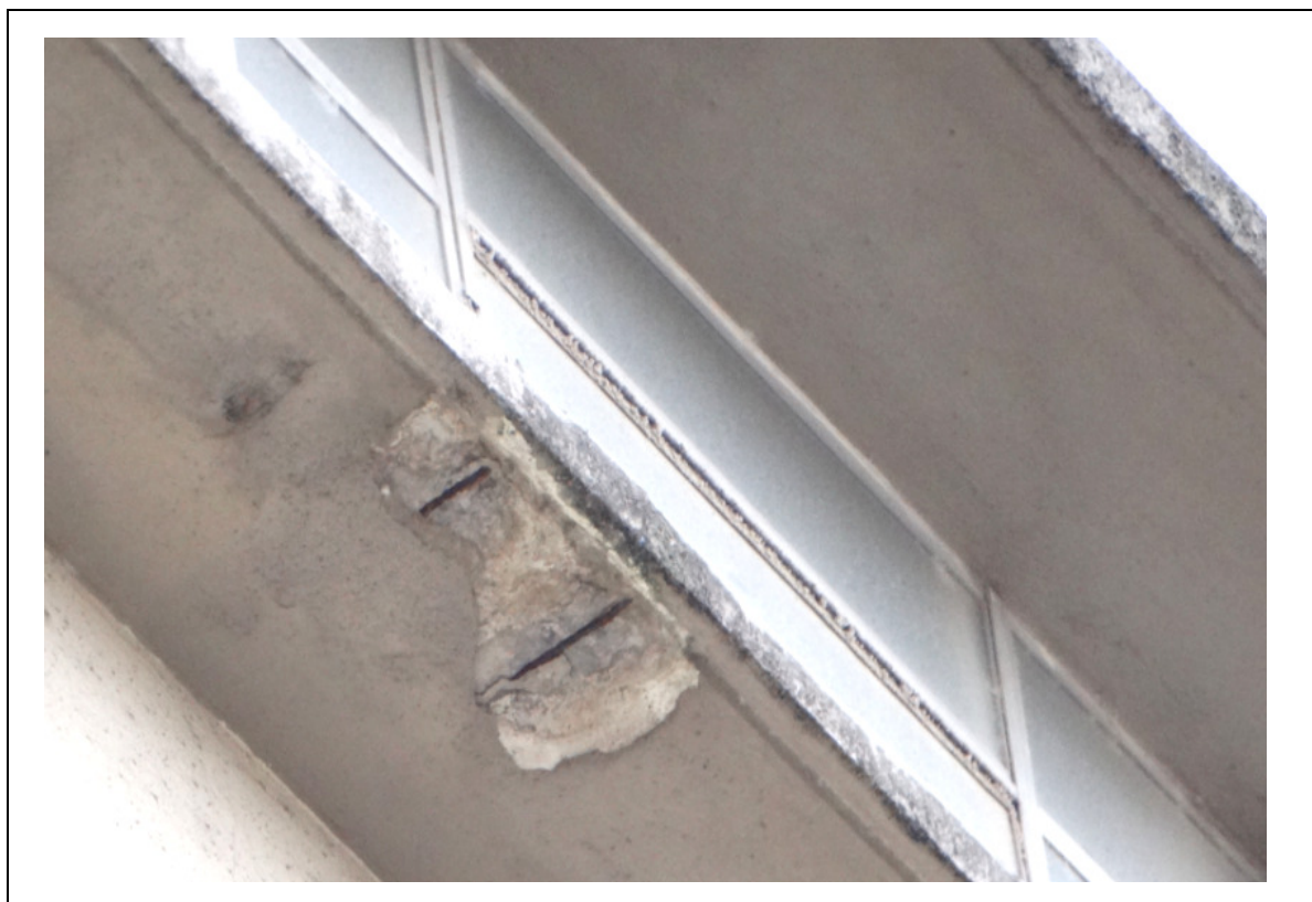
FOTO 126 – DETALHE DA FOTO ANTERIOR: CORROSÃO NO ELEMENTO DE CONCRETO EM BALANÇO DA FACHADA, COM DESTACAMENTO DA CAMADA DE COBRIMENTO.
