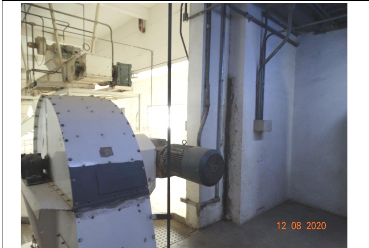
FOTO 247 – MEGASILO: 8º ANDAR.
