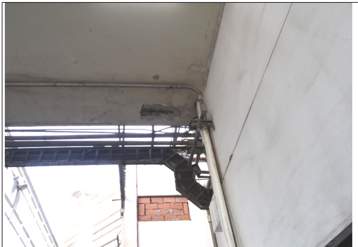
FOTO 33 – COBERTURA DA ENTRADA.
