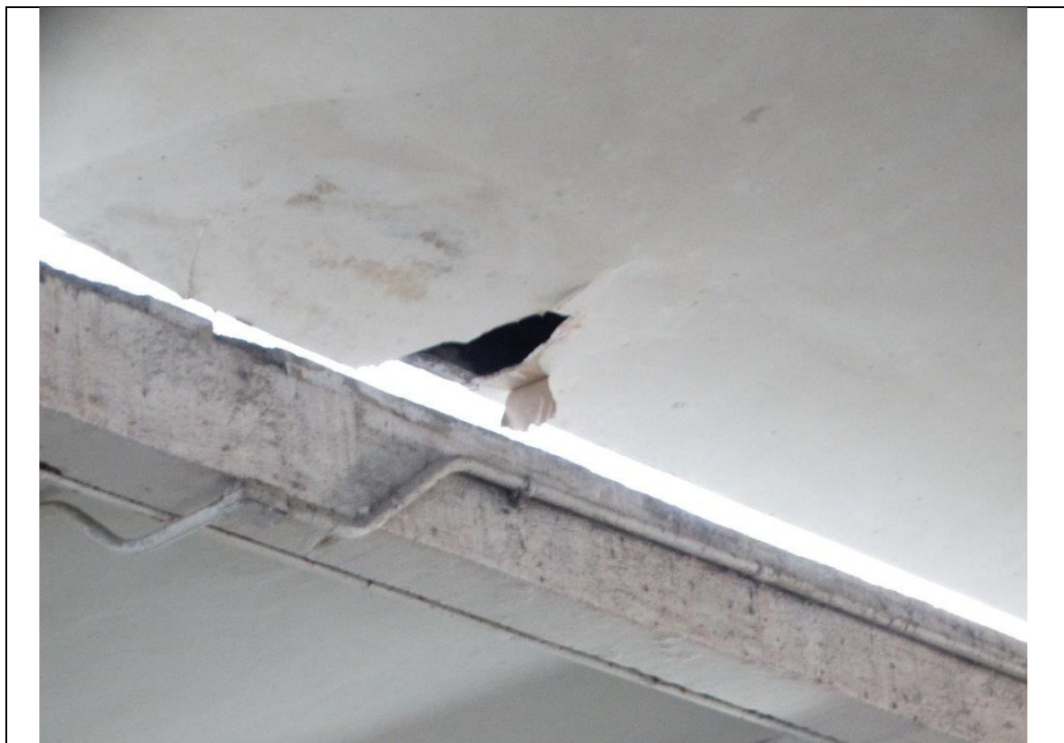
FOTO 39 - DETALHE DA FOTO ANTERIOR: FORRO COM DESTACAMENTO.
