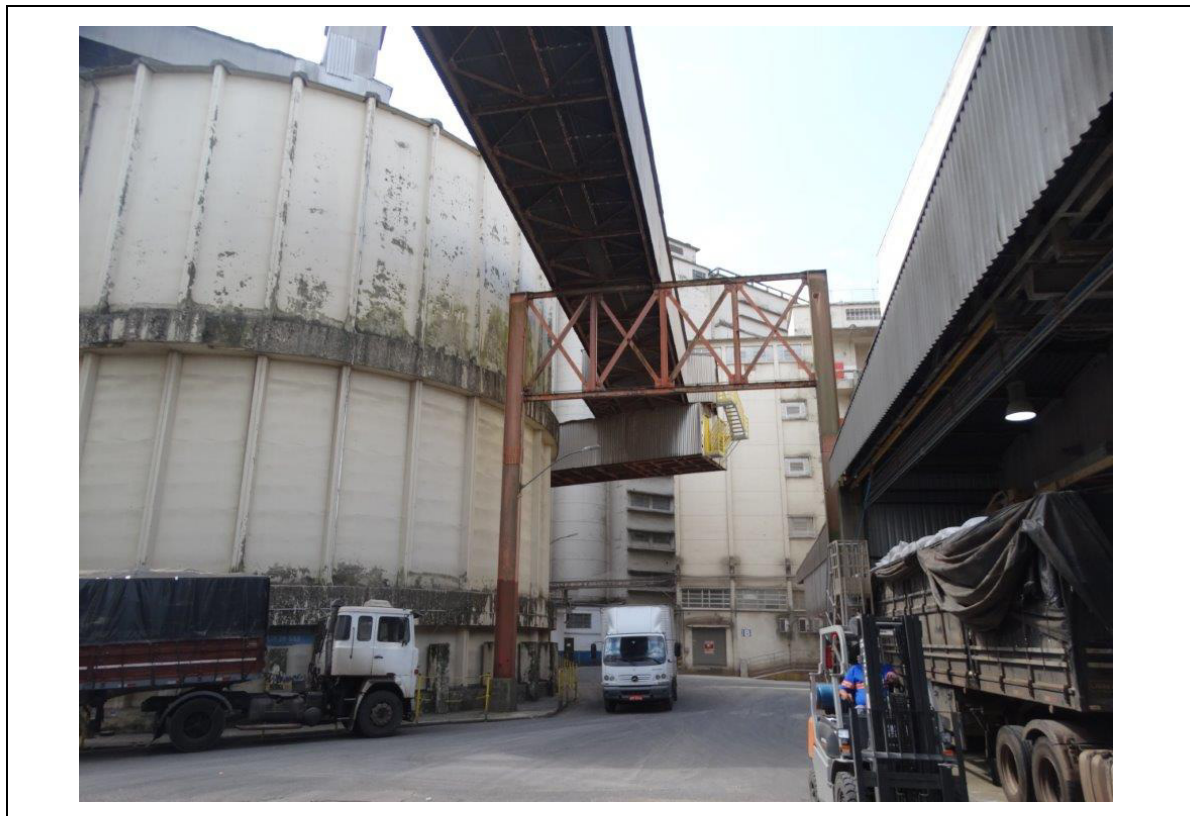
FOTO 202 – CORREIA TRANSPORTADORA ENTRE MAGASILO E SILOS ZORTEA.
