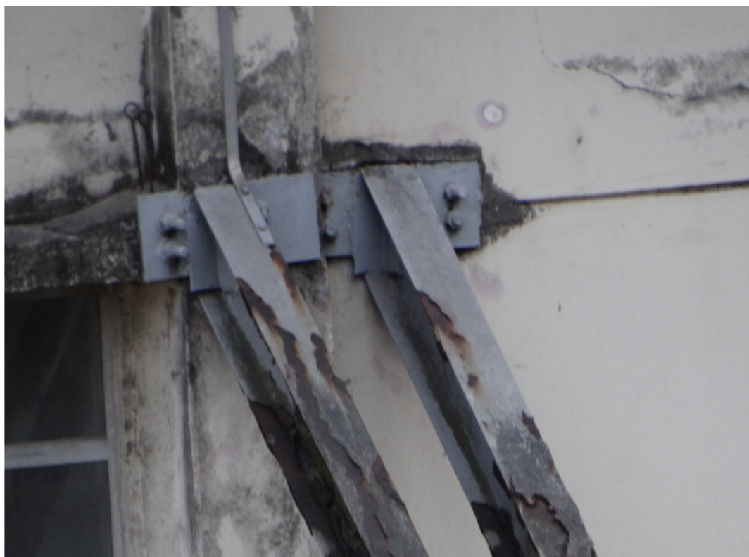
FOTO 163 – DETALHE DA FOTO ANTERIOR: CORROSÃO NA ESTRUTURA METÁLICA DA MÃO FRANCESA DE SUPORTE DA COBERTURA.
