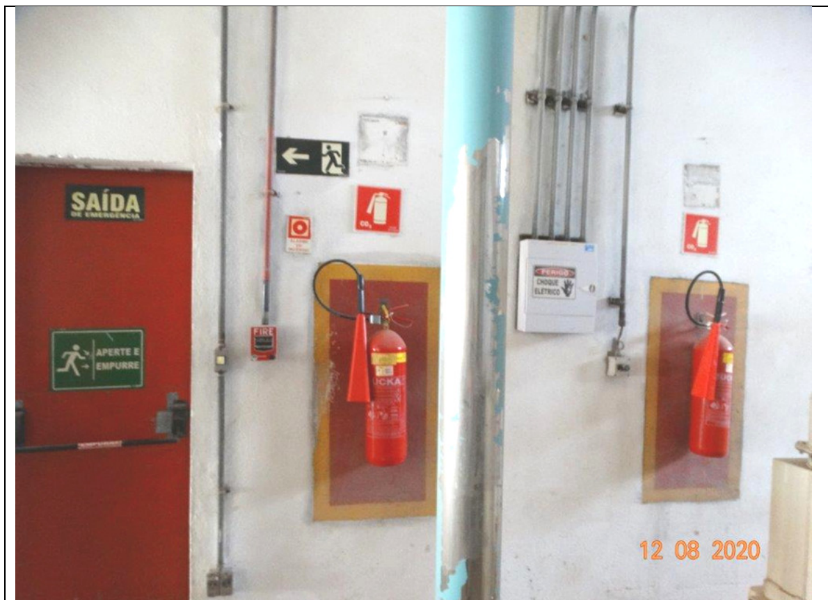
FOTO 254 – MEGASILO: 5º ANDAR.
