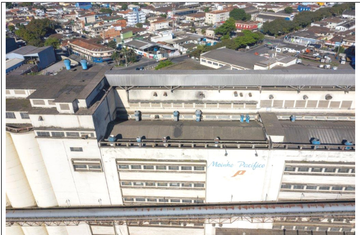
FOTO 293 – PRÉDIO DA MOAGEM.
