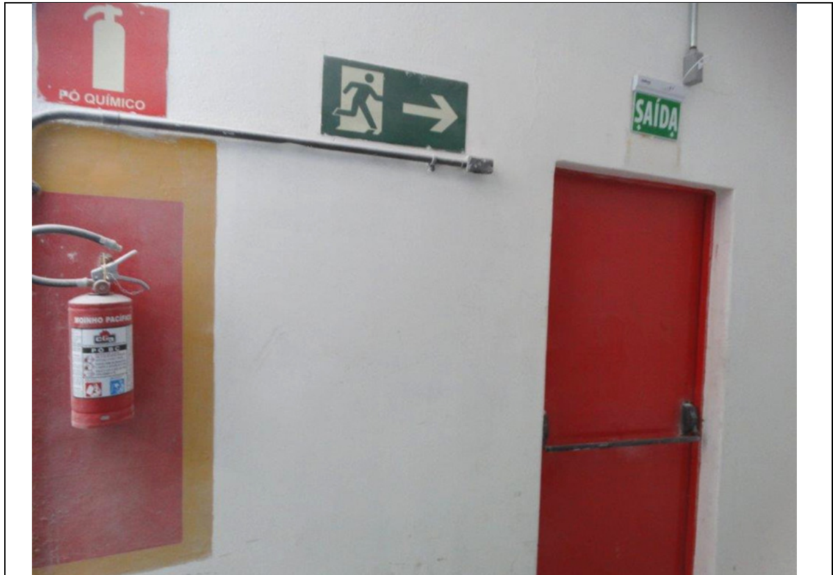
FOTO 132 – PRÉDIO H0 - 4º ANDAR - SAÍDA DE EMERGÊNCIA PELO LADO EXTERNO.
