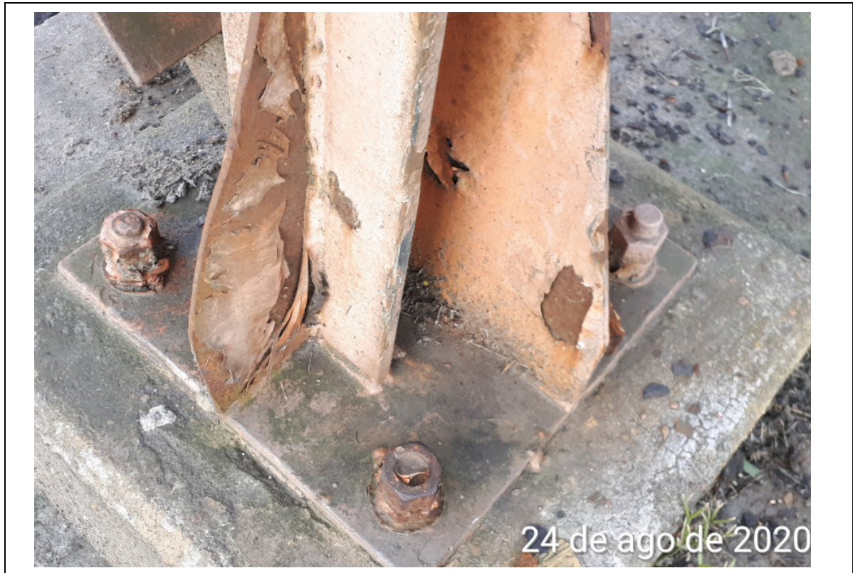
FOTO 306 - DETALHE DE UMA DAS BASES DA TORRE DA FOTO ANTERIOR : OXIDAÇÃO COM DESGASTE DA PINTURA PROTETORA.
