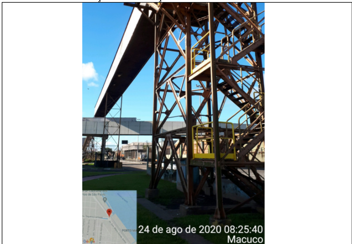
FOTO 305 - VISTA PARCIAL DAS TORRES SOBRE A AVENIDA PORTUÁRIA.
