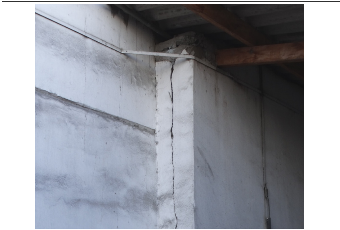
FOTO 185 – DETALHE DA FOTO ANTERIOR: TRINCA JUNTO A ALVENARIA.
