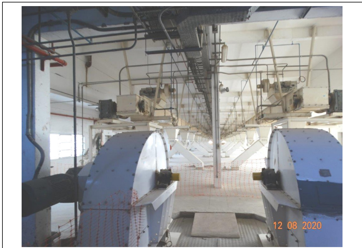
FOTO 246 - MEGASILO: 8º ANDAR.
