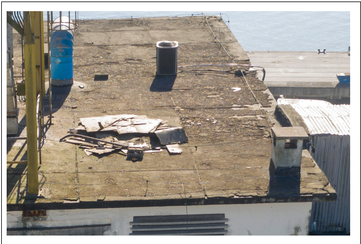
FOTO 288 – DETALHE DA FOTO ANTERIOR: CONSTATADA PRESENÇA DE RESÍDUOS DE MATERIAIS SOBRE A LAJE DE COBERTURA E DESGASTE DA ARGAMASSA DE PROTEÇÃO MECÂNICA EM ALGUNS TRECHOS.
