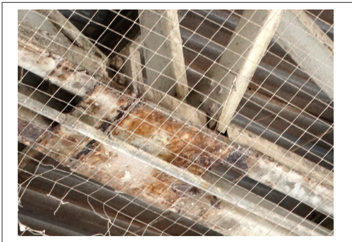
FOTO 192 – DETALHE DA FOTO ANTERIOR: CORROSÃO EM PEÇAS METÁLICAS DA COBERTURA.
