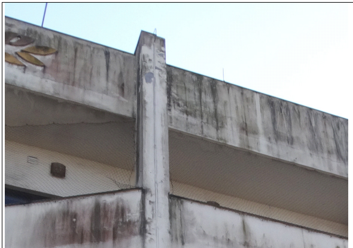
FOTO 25 – DETALHE DA FOTO ANTERIOR: ESCORRIMENTO DE SUJIDADES E UMIDADE PELA PARTE SUPERIOR DA PLATIBANDA PELA AUSÊNCIA DE RUFOS.
