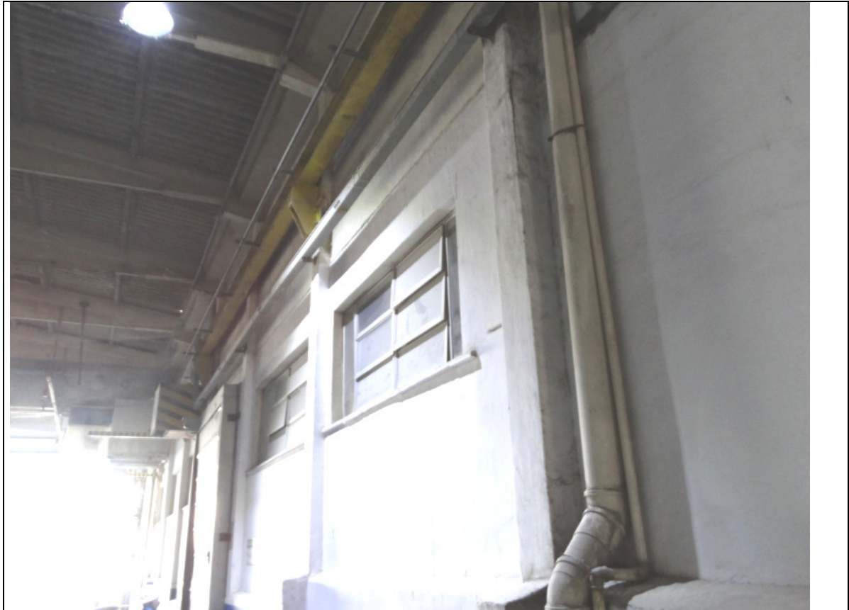
FOTO 179 – TRECHO DE ALVENARIA E ESTRUTURA DO PRÉDIO H1.
