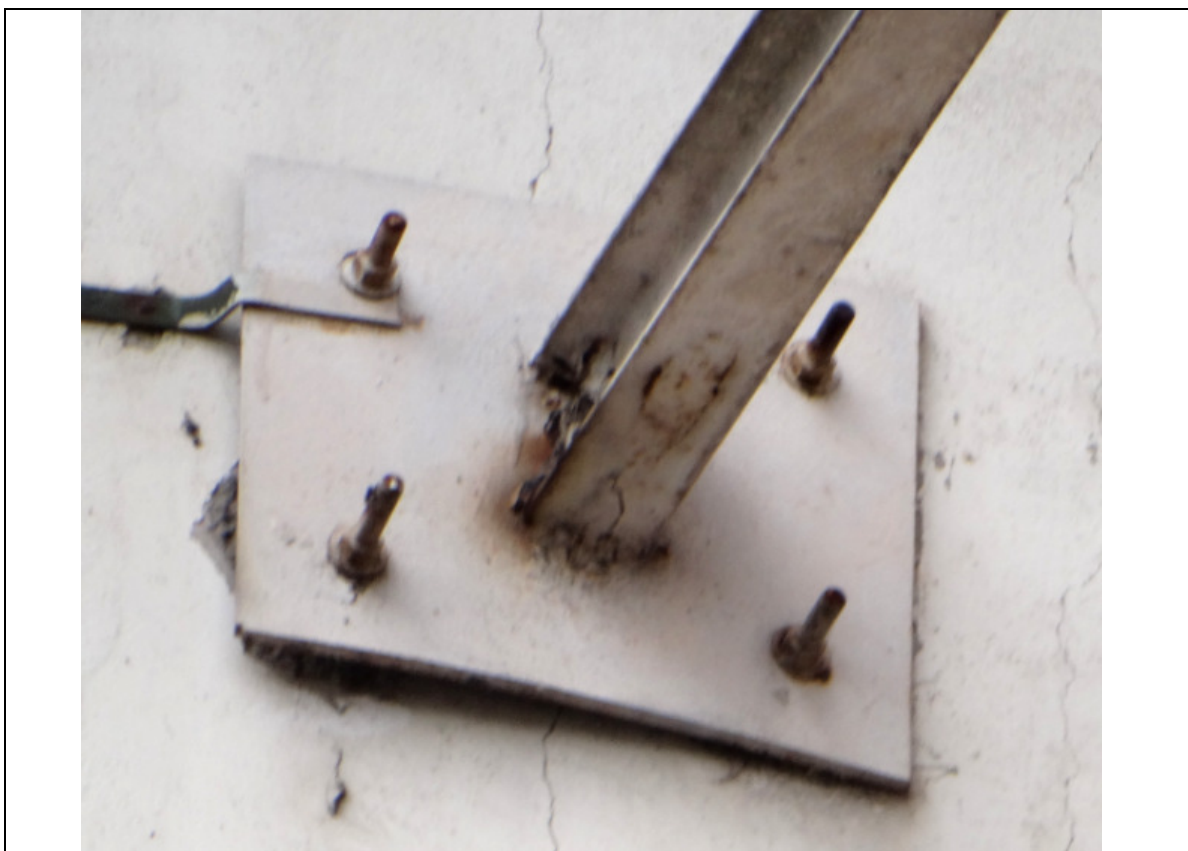
FOTO 236 – DETALHE DA FOTO 232: SUPORTE METÁLICO DA ESTRUTURA APRESENTA CORROSÃO NA EMENDA.
