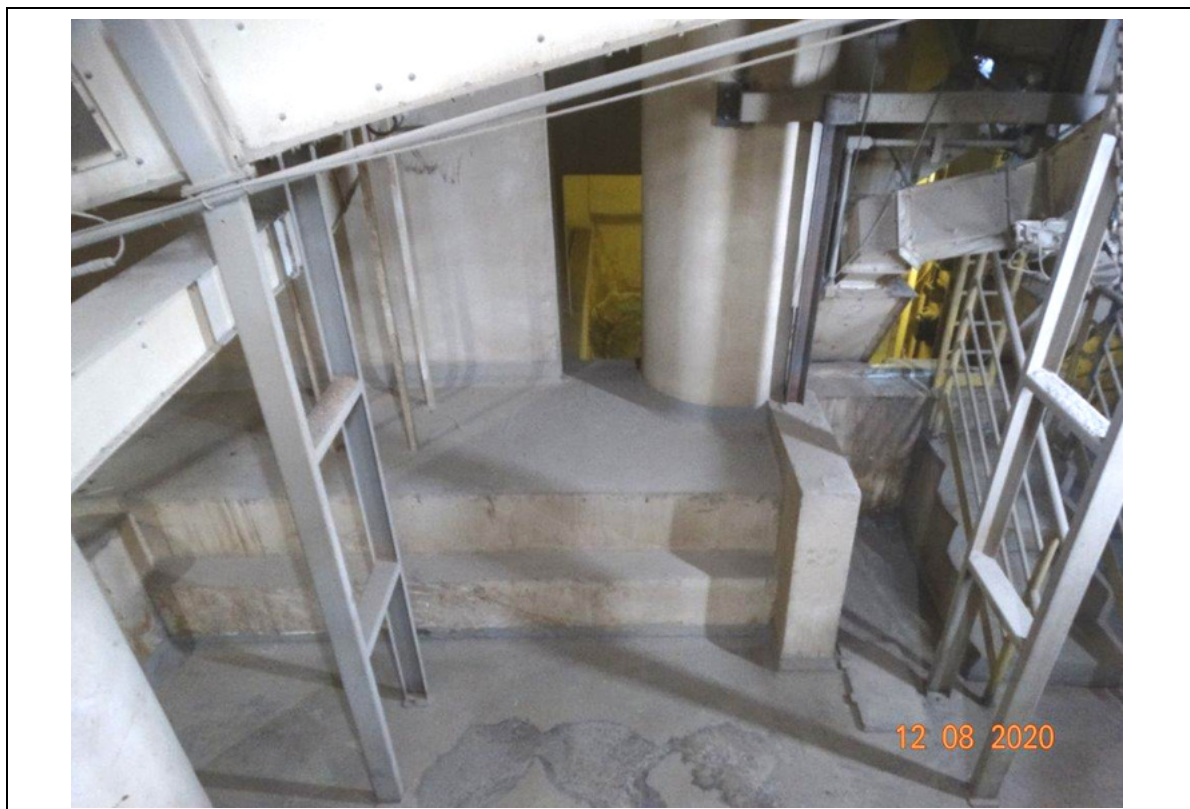
FOTO 121 – PORÃO MOAGEM B.
