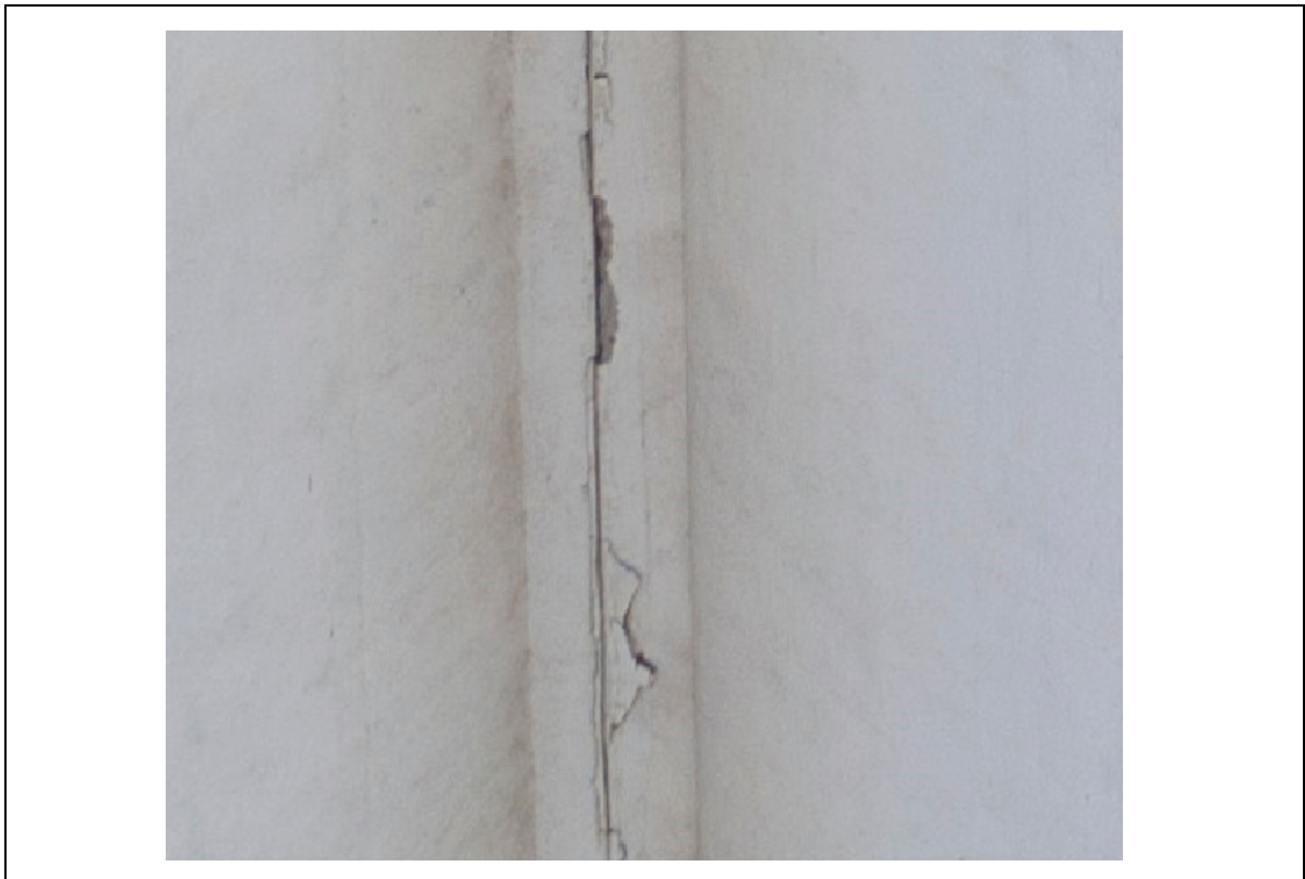
FOTO 282 – TRECHO DA JUNTA DE DILATAÇÃO, PROJETADA EM TODO SENTIDO VERTICAL DO MEGASILO. OBSERVA-SE ROMPIMENTO DO CONCRETO JUNTO DAS BORDAS. NECESSÁRIO REVISAR A JUNTA PARA EVITAR TENSÕES NO CONCRETO E INFILTRAÇÕES.
