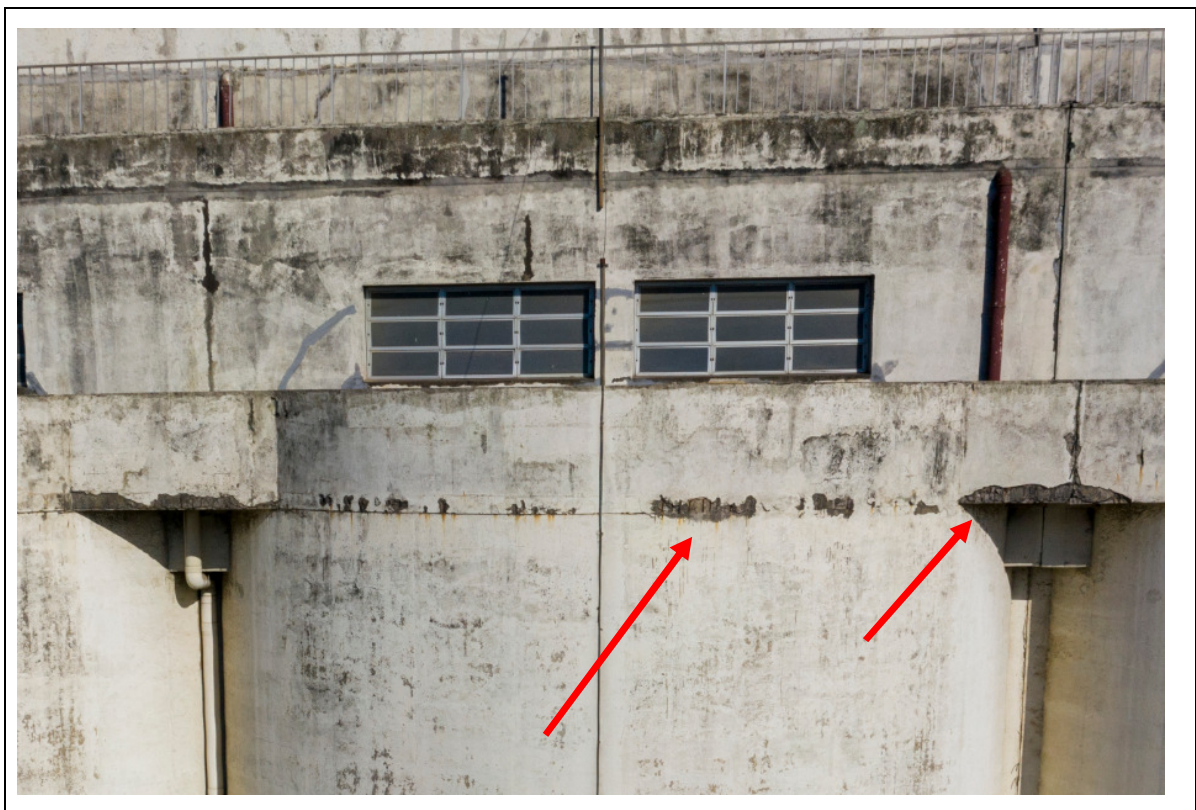
FOTO 275 – DETALHE DA FOTO ANTERIOR: TRRCHOS COM CORROSÃO DAS ARMADURAS DA PAREDE DE CONCRETO.
