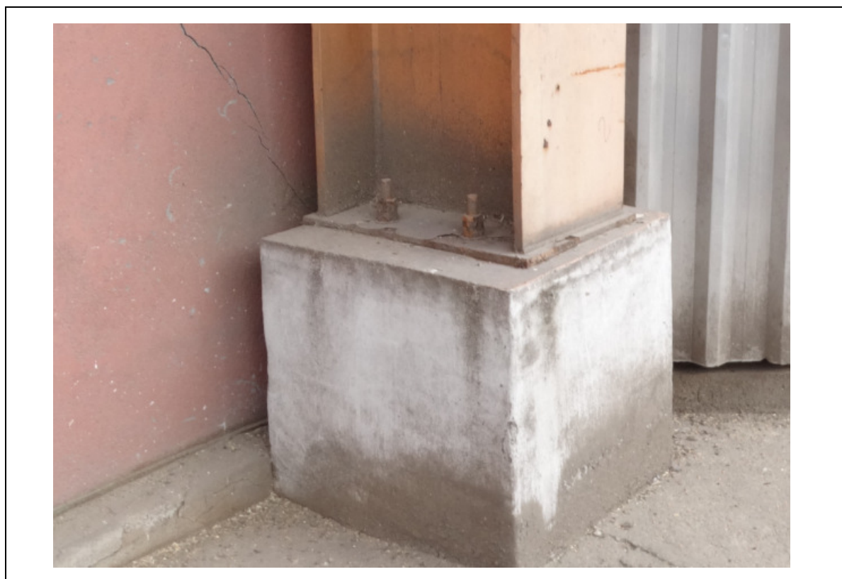
FOTO 231 – DETALHE DA BASE DA ESTRUTURA DA FOTO ANTERIOR.
