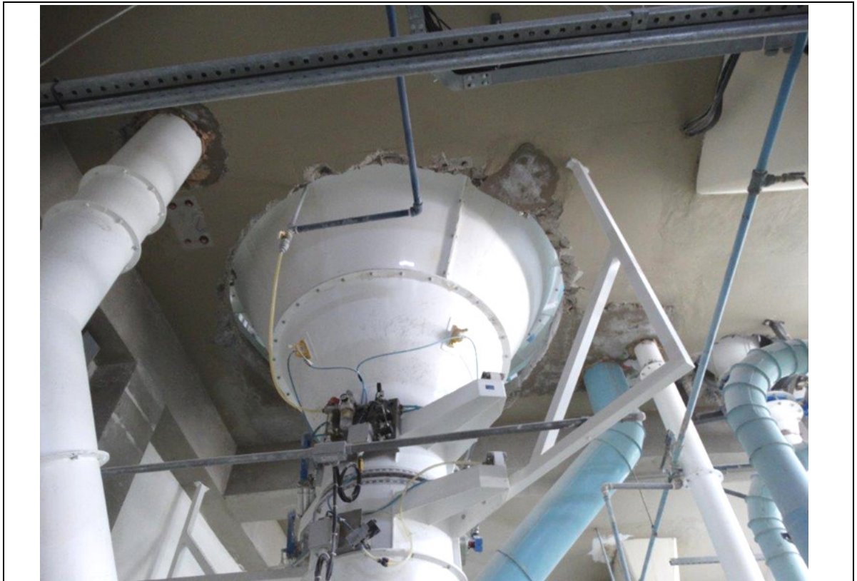
FOTO 171 – PRÉDIO H1: 1º ANDAR.
