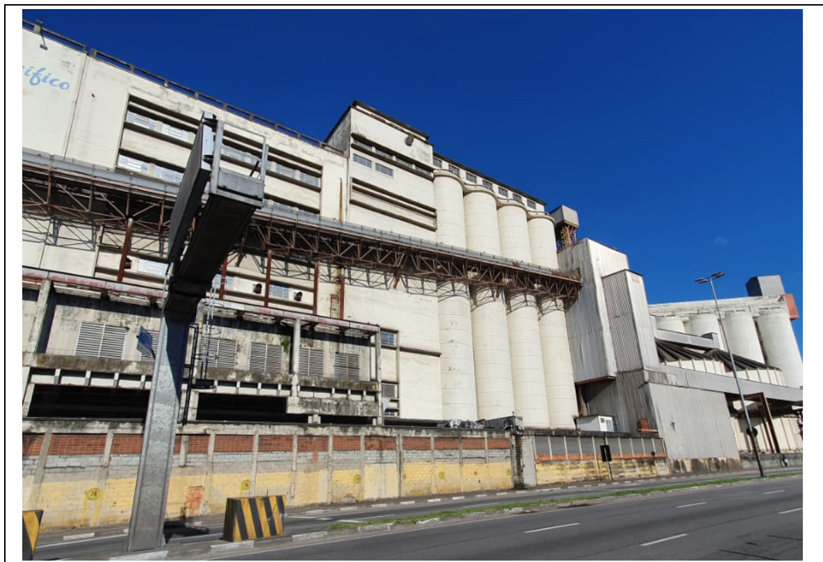
FOTO 311 - VISTA GERAL DA ESTEIRA, FIXADA JUNTO AO PRÉDIO.
