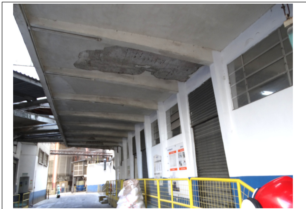
FOTO 79 - COBERTURA MOAGEM B.
