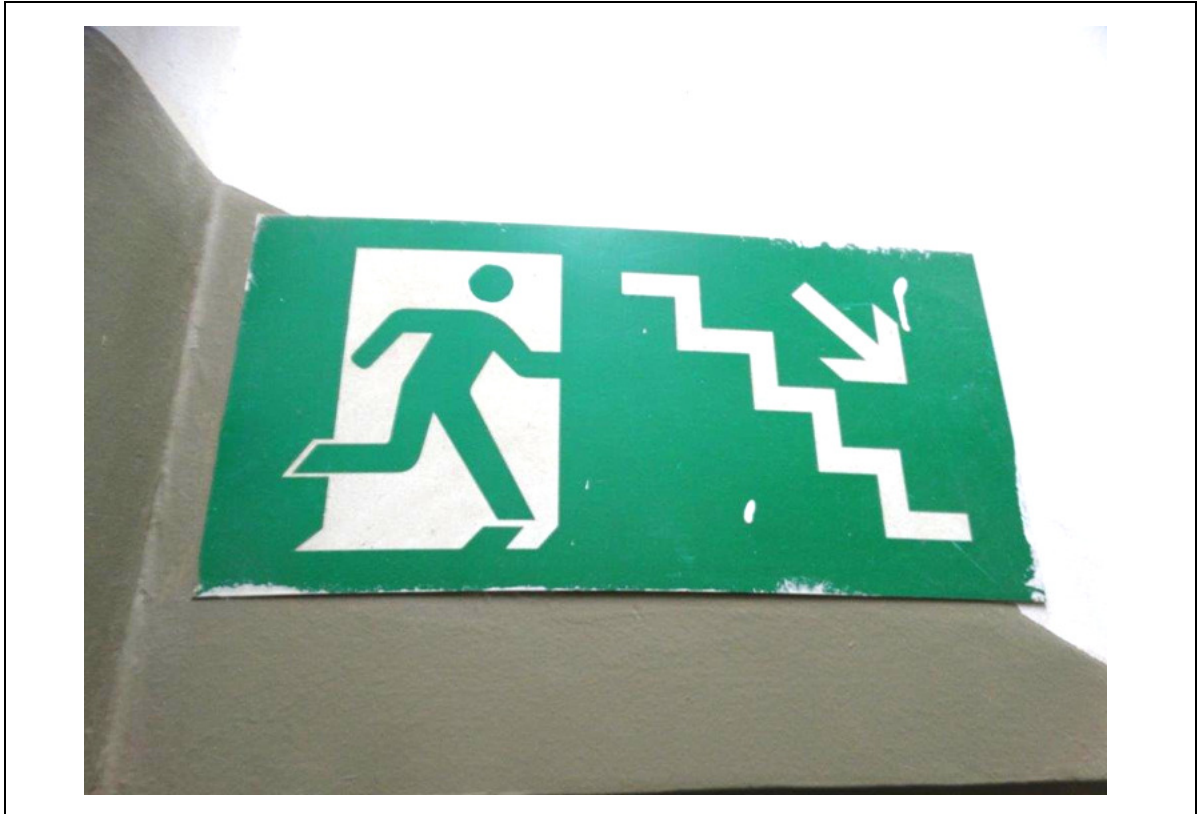
FOTO 60 – MOAGEM A - 6º ANDAR: PLACA NÃO ESTÁ NO PADRÃO ATUAL EXIGIDO PELO CORPO DE BOMBEIROS. (NECESSITA TER INSCRITO CNPJ DO FABRICANTE E SER FOTOLUMINESCENTE).
