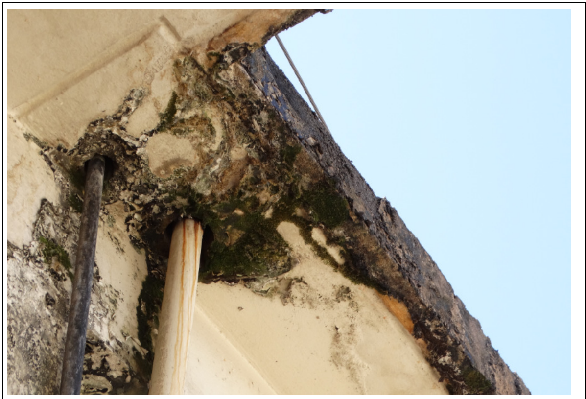
FOTO 139 – DETALHE DA FOTO ANTERIOR: FALHA NA VEDAÇÃO DO CONDUTOR EM PVC, COM ESCORRIMENTO DE ÁGUA. ACÚMULO DE SUJIDADES NA PLATIBANDA.
