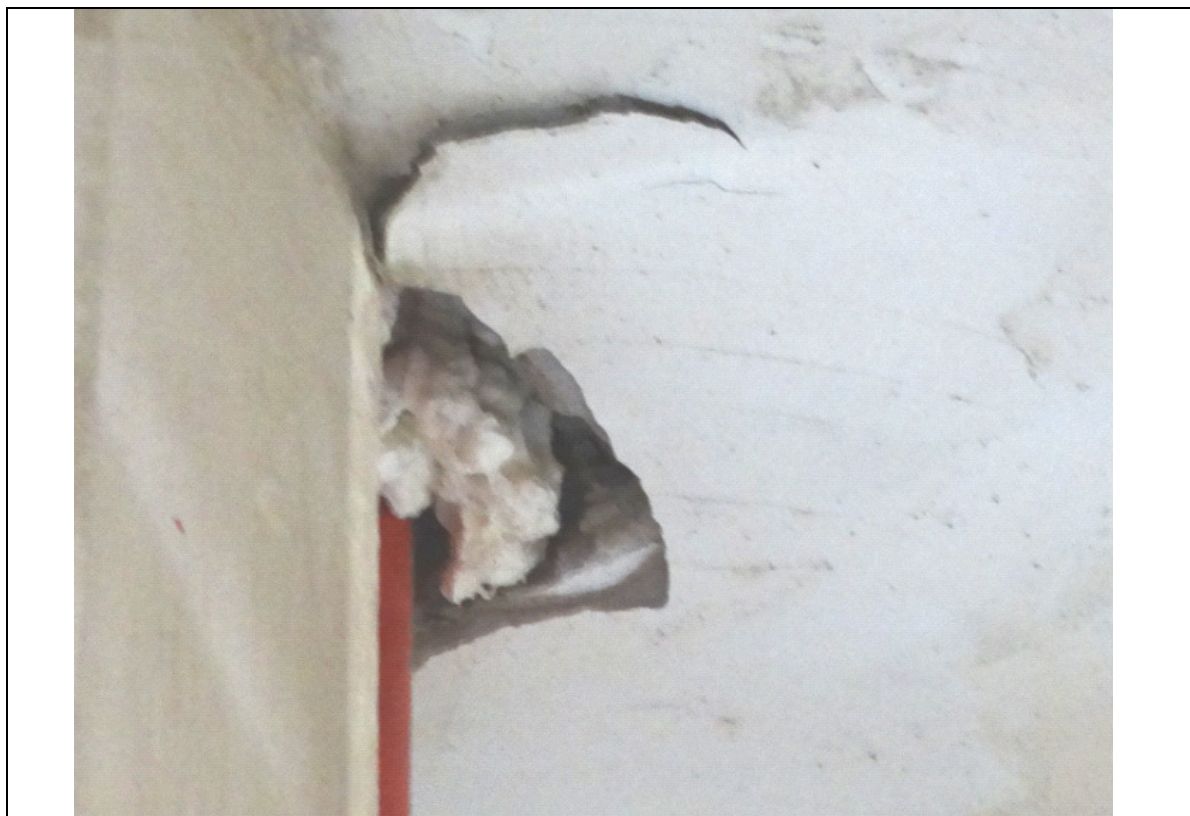
FOTO 54 – DETALHE DA FOTO ANTERIOR: ARREMATE EM LAJE INCOMPLETO.
