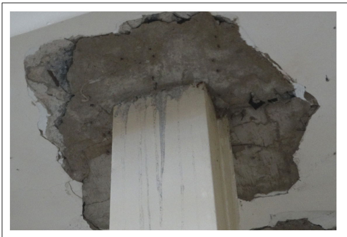
FOTO 65 – DETALHE DA FOTO ANTERIOR: CHUMBAMENTO DE PEÇA METÁLICA SEM ACABAMENTO.
