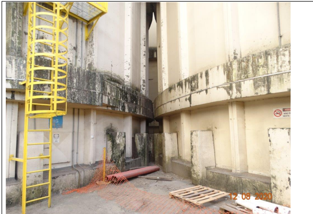
FOTO 196– SILOS ZORTEA N° 04 (DIR.) e N° 05 (ESQ.).
