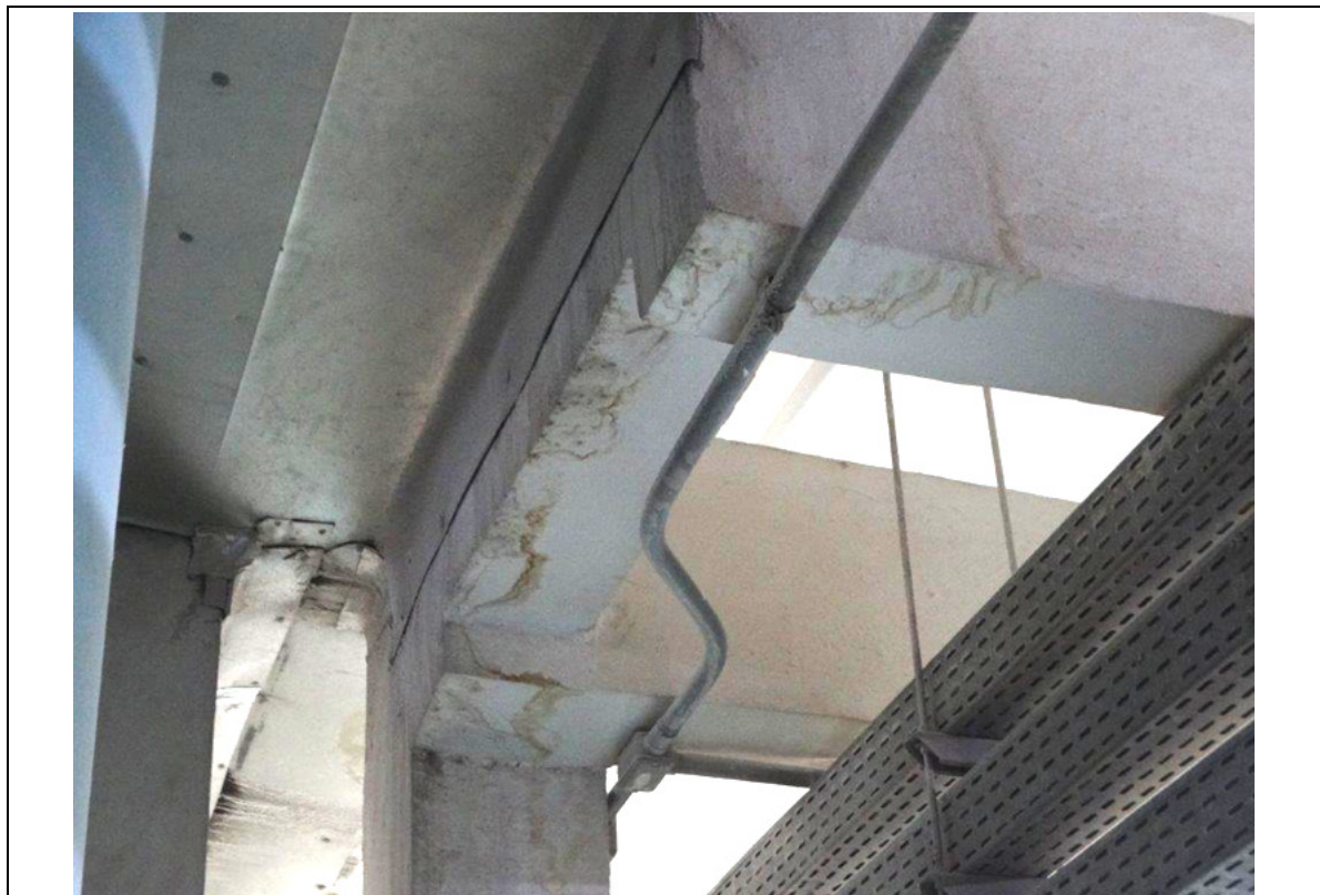
FOTO 105 – DETALHE DA FOTO ANTERIOR: MANCHA DE UMIDADE, MAS SEM GOTEJAMENTO ATIVO.
