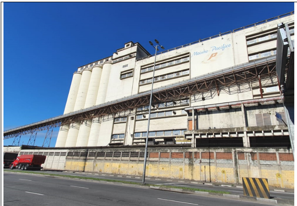
FOTO 310 - VISTA GERAL DA ESTEIRA, FIXADA JUNTO AO PRÉDIO.
