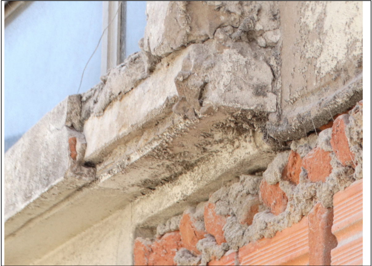
FOTO 144 – DETALHE DA FOTO ANTERIOR: DESTACAMENTO DE ARGAMASSA DA PINGADEIRA DE JANELA.
