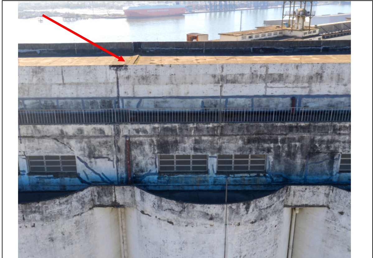
FOTO 278 – DETALHE DE FOTO DA PARTE SUPERIOR DO MEGASILO.
