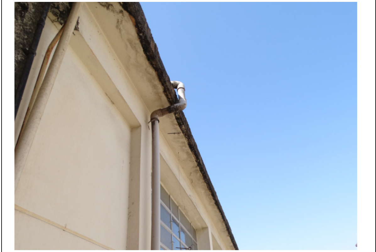
FOTO 138 – BEIRAL DO TELHADO.
