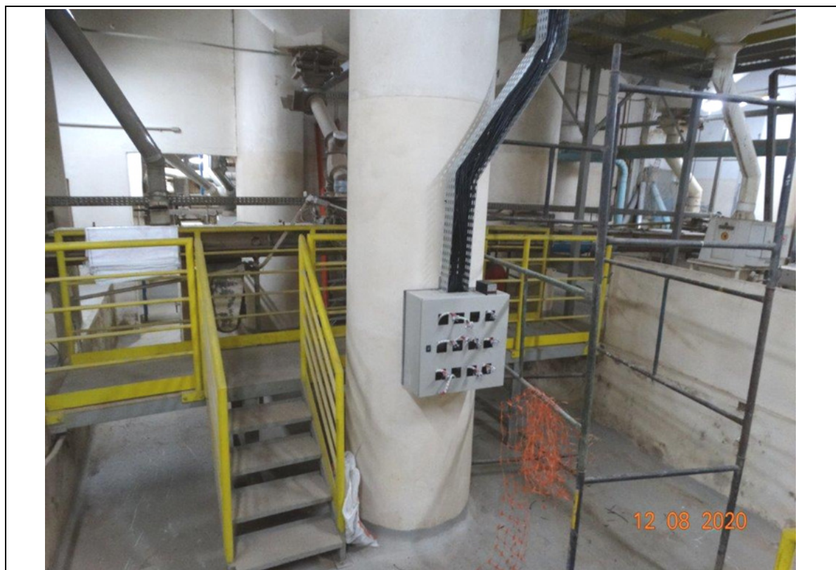
FOTO 93 – PORÃO - MOAGEM A.
