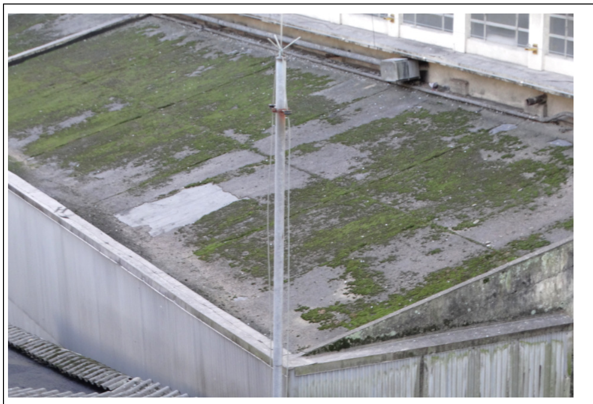
FOTO 88- LAJE DE COBERTURA DA FOTO ANTERIOR, COM FUNGOS E LIMO.
