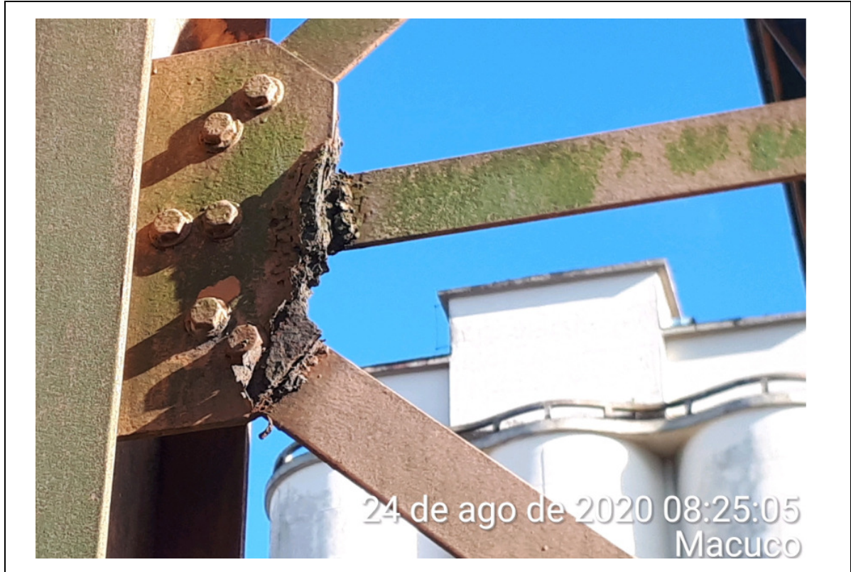
FOTO 304 - DETALHE DE TRECHO COM AVANÇADO ESTADO E CORROSÃO NAS LIGAÇÕES DAS PEÇAS.
