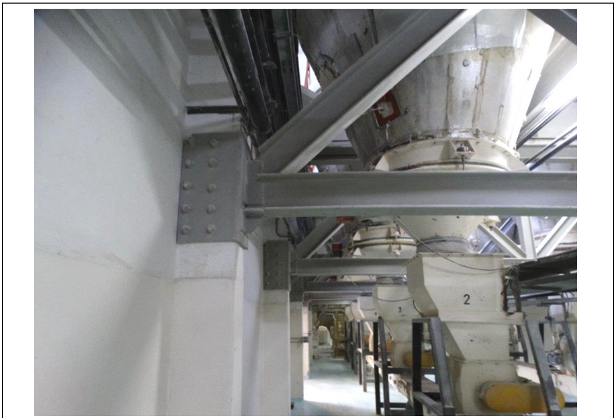
FOTO 161 – PRÉDIO H0 - 1º ANDAR.
