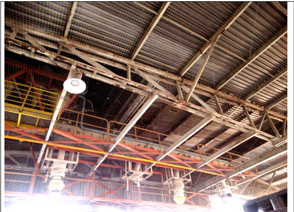
FOTO 191 - COBERTURA PÁTIO CD.
