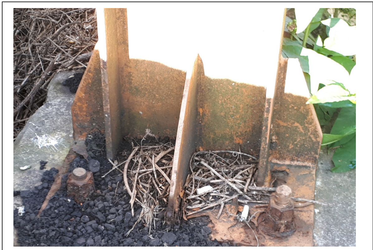
FOTO 301 - DETALHE DA BASE DA TORRE DA FOTO ANTERIOR : OXIDAÇÃO DA BASE E PARAFUSOS. SUJIDADES SOBRE A BASE, CAUSANDO UMIDADE.
