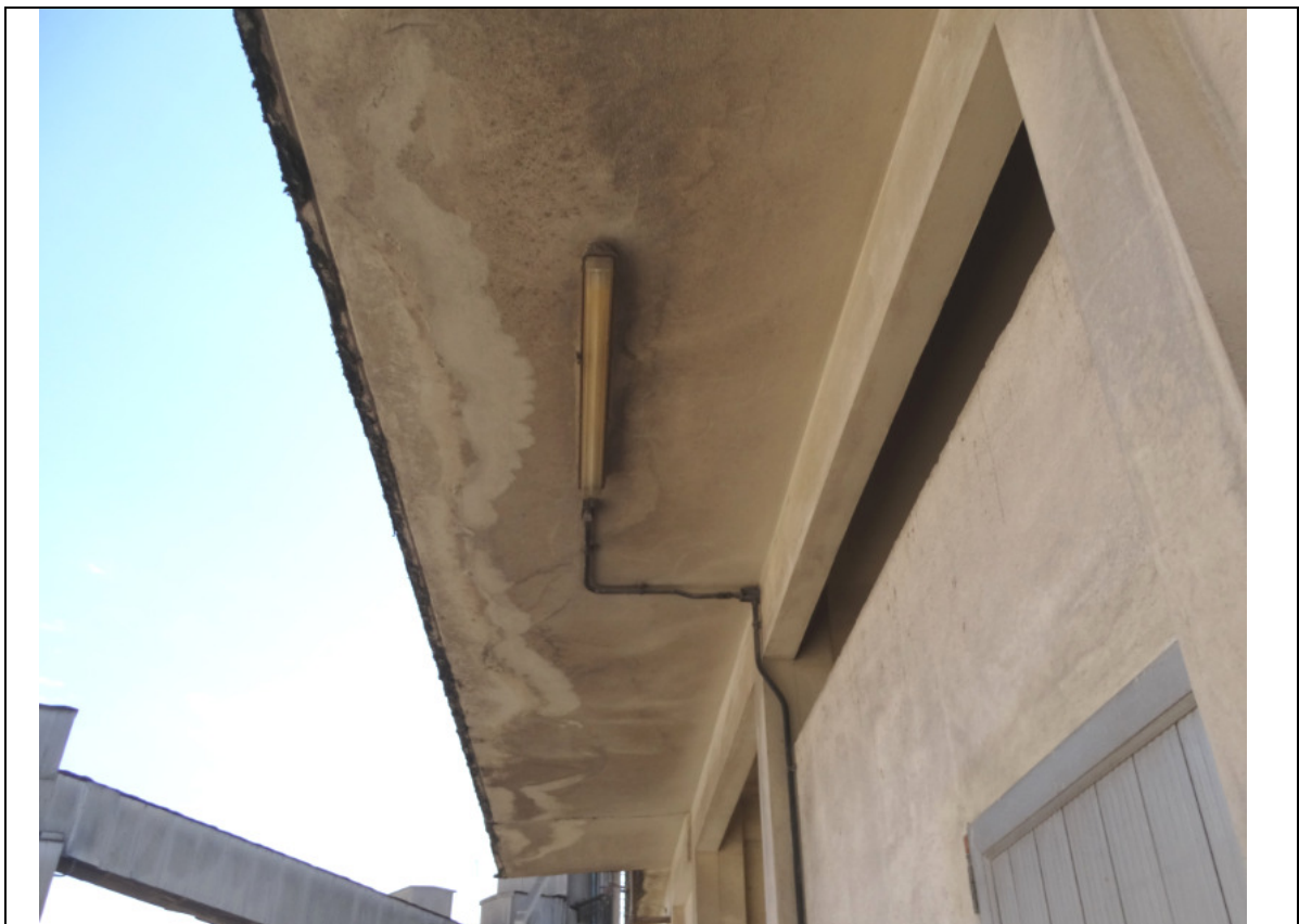
FOTO 135 – DETALHE DA FOTO ANTERIOR: TETO COM EXTENSAS MANCHAS DE UMIDADE PELA DEFICIÊNCIA DE PINGADEIRA JUNTO A BORDA DA LAJE.
