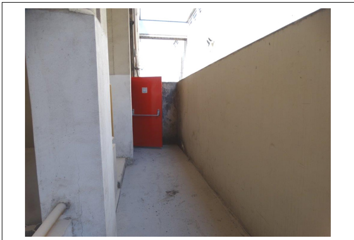
FOTO 158 – PRÉDIO H0 - SAÍDA DE EMERGÊNCIA 1º ANDAR.
