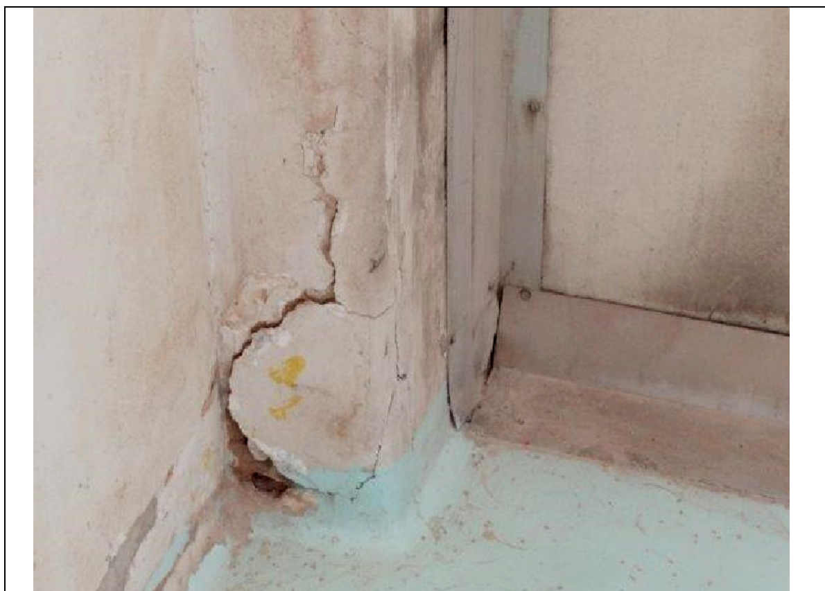
FOTO 114 – DETALHE DA FOTO ANTERIOR: INDÍCIO DE CORROSÃO NA PARTE INFERIOR DO PILAR.
