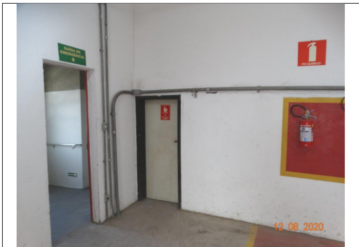
FOTO 245- MEGASILO: ÁREA INTERNA DA COBERTURA.
