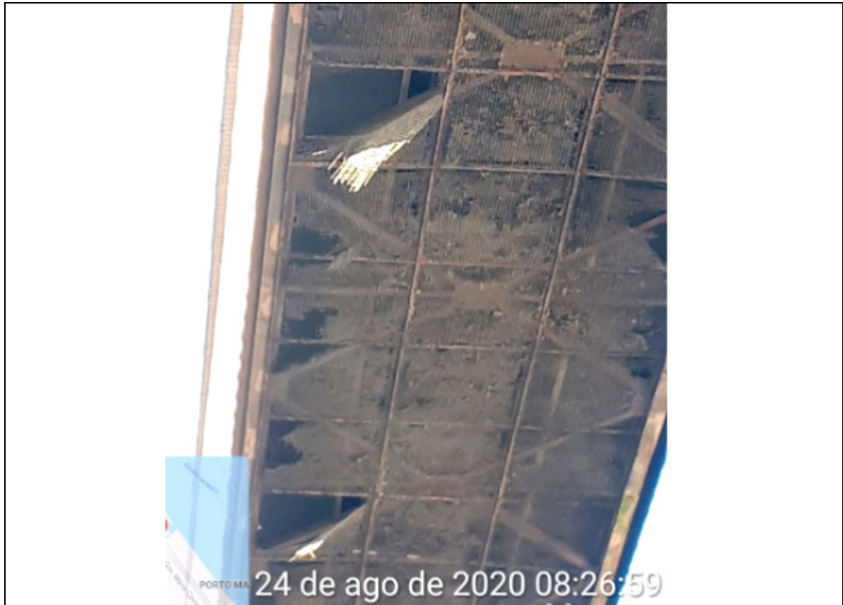
FOTO 308 - PARTE INFERIOR DA ESTEIRA NUM TRECHO ENTRE TORRES, MOSTRANDO DIVERSOS TERCHOS DE TELA DETERIORADAS E UMA COM IMINÊNCIA DE QUEDA, DEVENDO SER REPARADAS OU SUBSTITUÍDAS.
