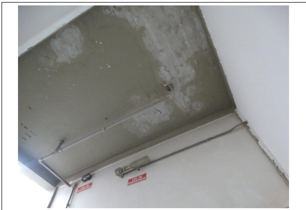
FOTO 165 – PRÉDIO H1: BARRILETE.
