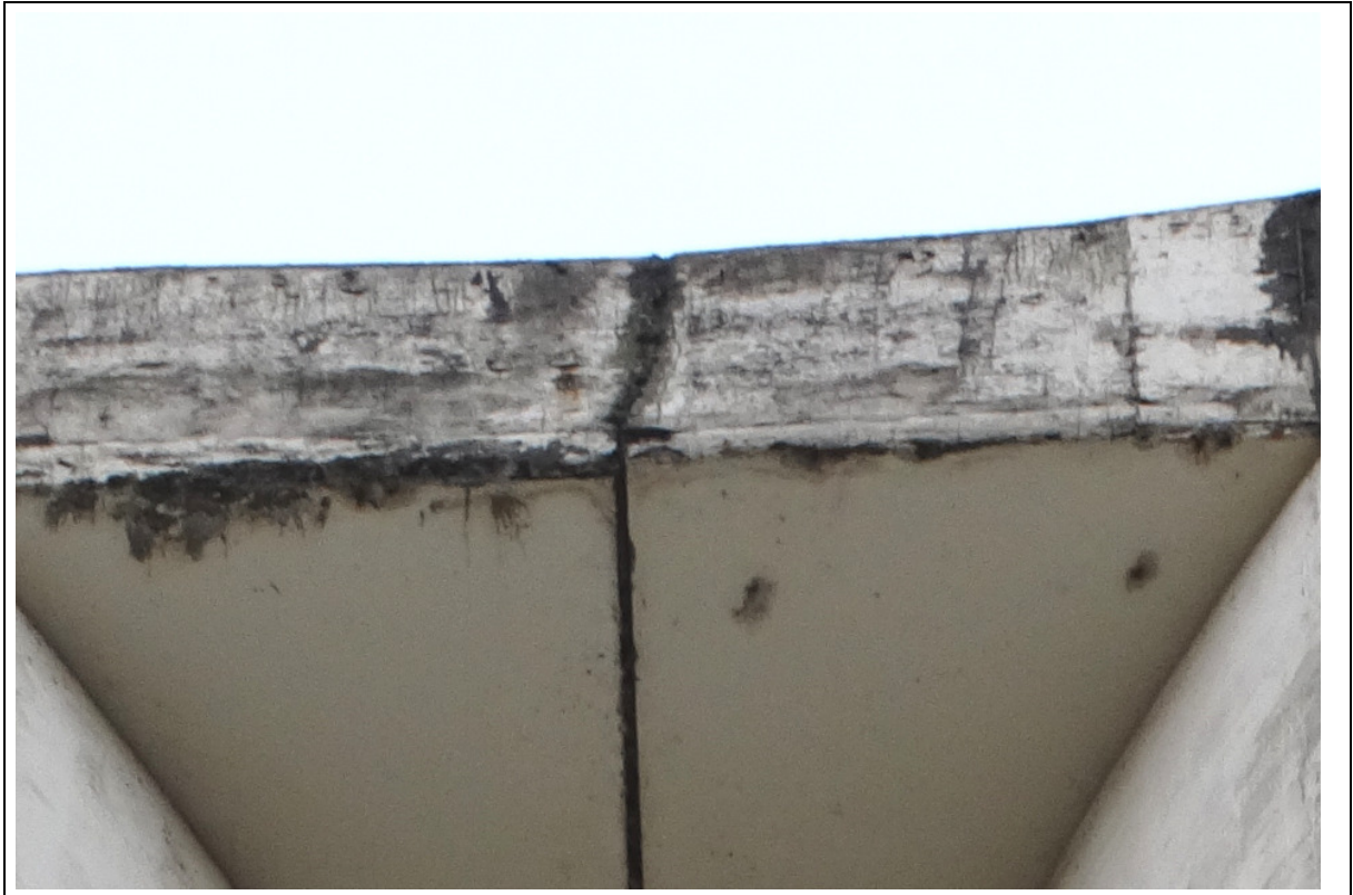
FOTO 220 – DETALHE DA FOTO ANTERIOR: NOTA-SE DESALINHAMENTO DA JUNTA ESTRUTURAL. NECESSÁRIO CONSULTAR O PROJETO ESTRUTURAL PARA VERIFICAR LARGURA PROJETADA E RECOMPOR NO ALINHAMENTO COM SELANTE.
