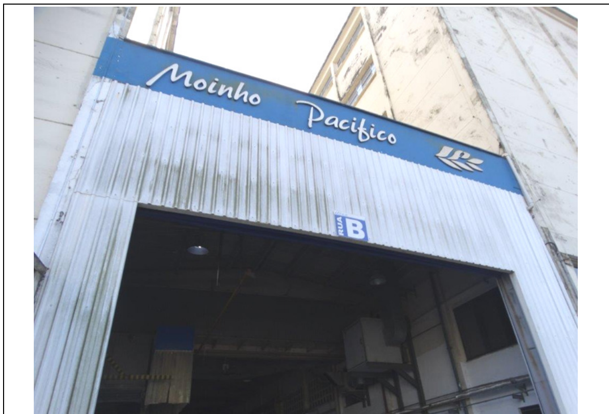
FOTO 183 – TÉRREO - ACESSO A CAMINHÕES.
