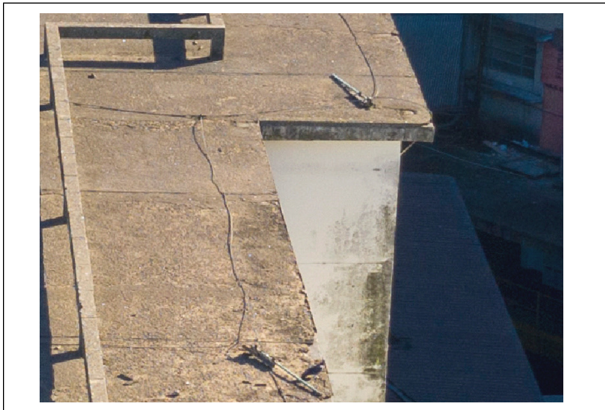
FOTO 268 – DETALHE DA FOTO ANTERIOR: ALGUMAS HASTES DO SPDA ESTÃO SEM FIXAÇÃO NA POSIÇÃO VERTICAL.
