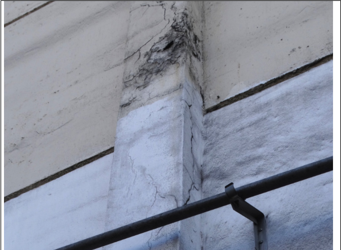
FOTO 188 – DETALHE DA FOTO ANTERIOR: INDÍCIO DE CORROSÃO DE ARMADURA DO PILAR. NECESSÁRIO UMA INSPEÇÃO INVASIVA, CASO EXISTA CORROSÃO TRATAR ADEQUADAMENTE.
