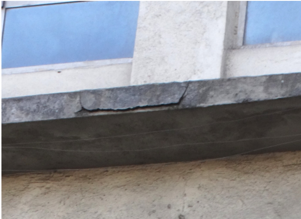
FOTO 91 – DETALHE DA FOTO ANTERIOR: ALGUNS TRECHOS DOS BEIRAIS APRESENTAM TRINCAS E IMINÊNCIA DE DESTACAMENTO DE CONCRETO.
