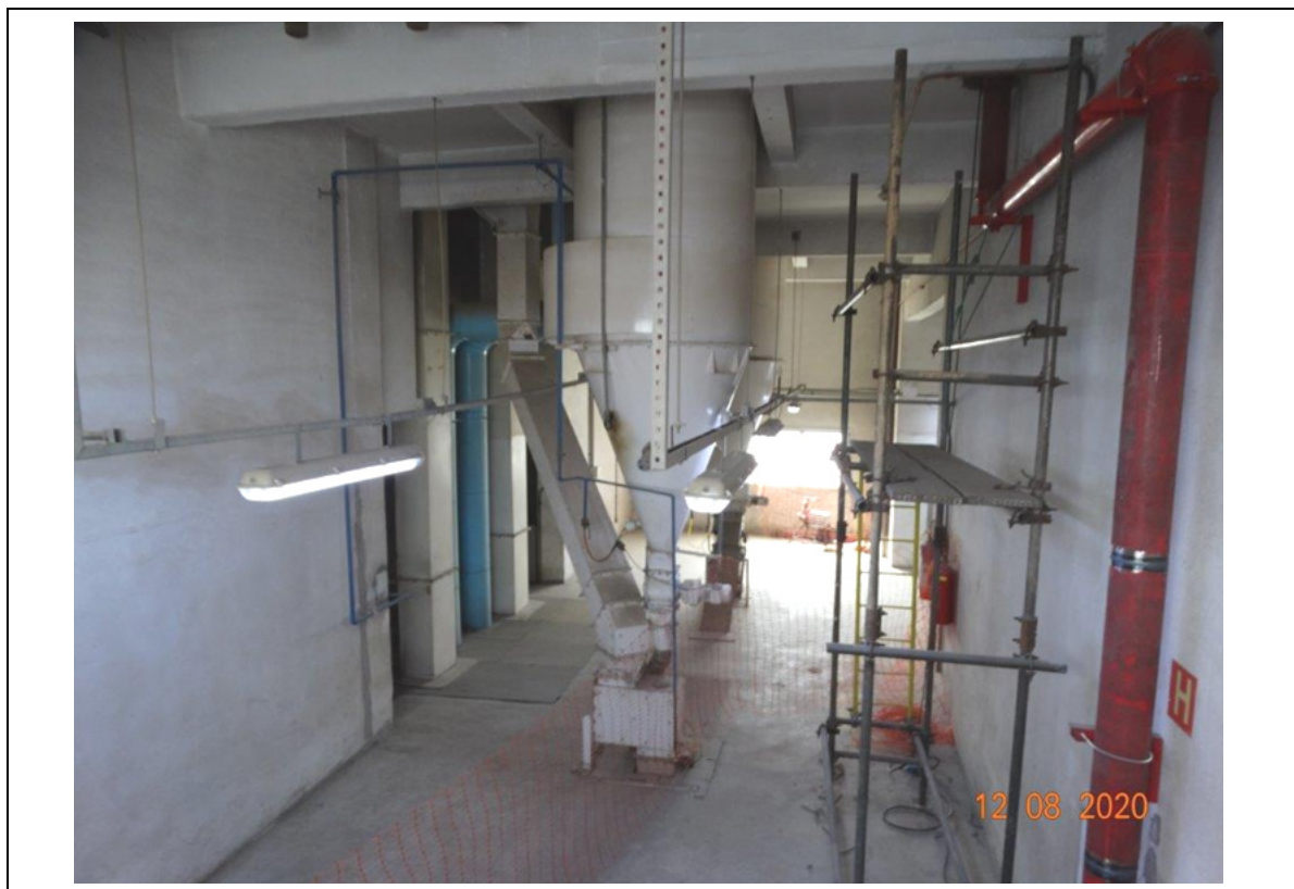
FOTO 251 – MEGASILO: 7º ANDAR.
