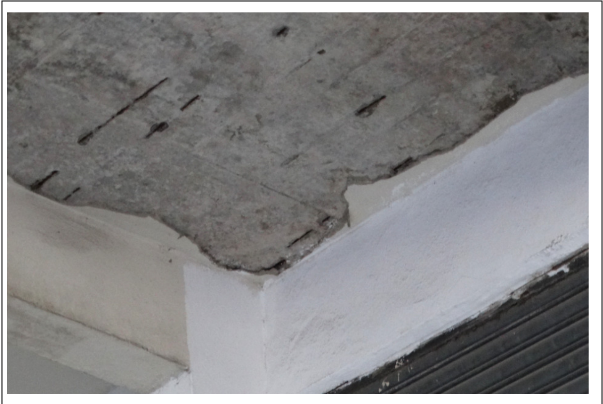
FOTO 80 – DETALHE DA FOTO ANTERIOR: CORROSÃO NO FUNDO DA LAJE, DEFICIÊNCIA NO COBRIMENTO DO CONCRETO. DESTACAMENTO DA ARGAMASSA, COM RISCO DE DESCOLAR EM PLACAS.
