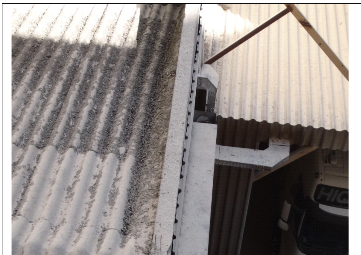
FOTO 155 – DETALHE DA FOTO ANTERIOR: SUJIDADES SOBRE AS TELHAS PODEM PROVOCAR ENTUPIMENTO DAS CALHAS E CONDUTORES.
