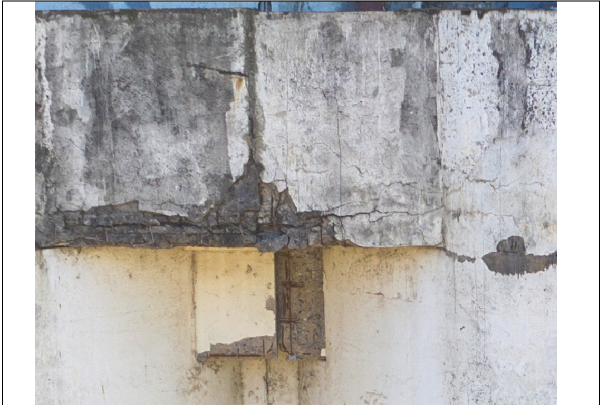
FOTO 281 – DETALHE DA FOTO ANTERIOR: TRECHO DA JUNTA NO TOPO DO MEGASILO COM CORROSÃO DE ARMADURAS E DESAGREGAÇÃO DO CONCRETO. NECESSÁRIO RECUPERAR ESTE TRECHO.
