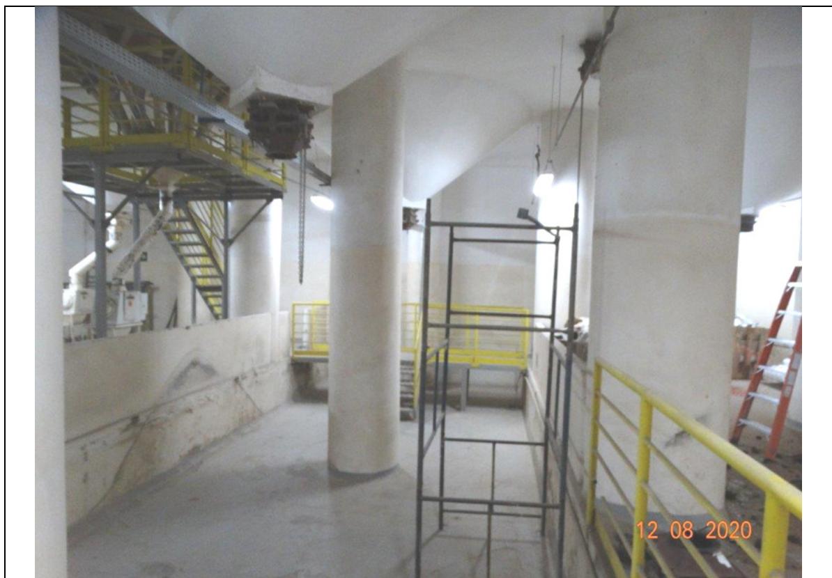
FOTO 92 – PORÃO - MOAGEM A.
