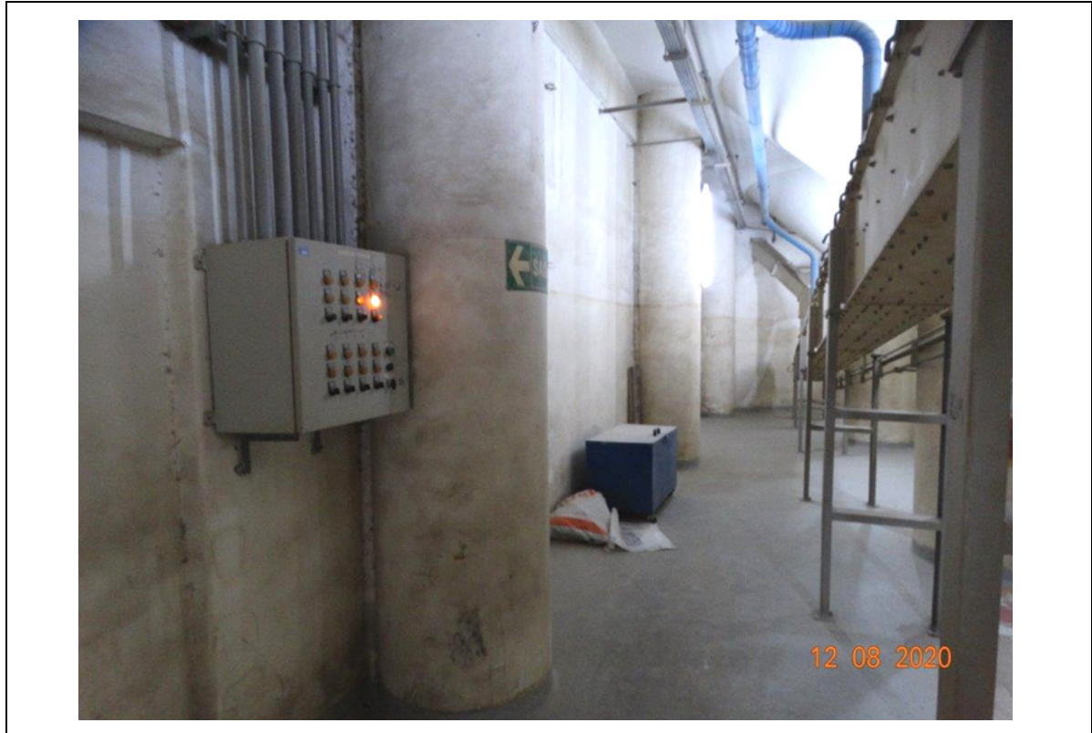
FOTO 123 – PORÃO MOAGEM B.
