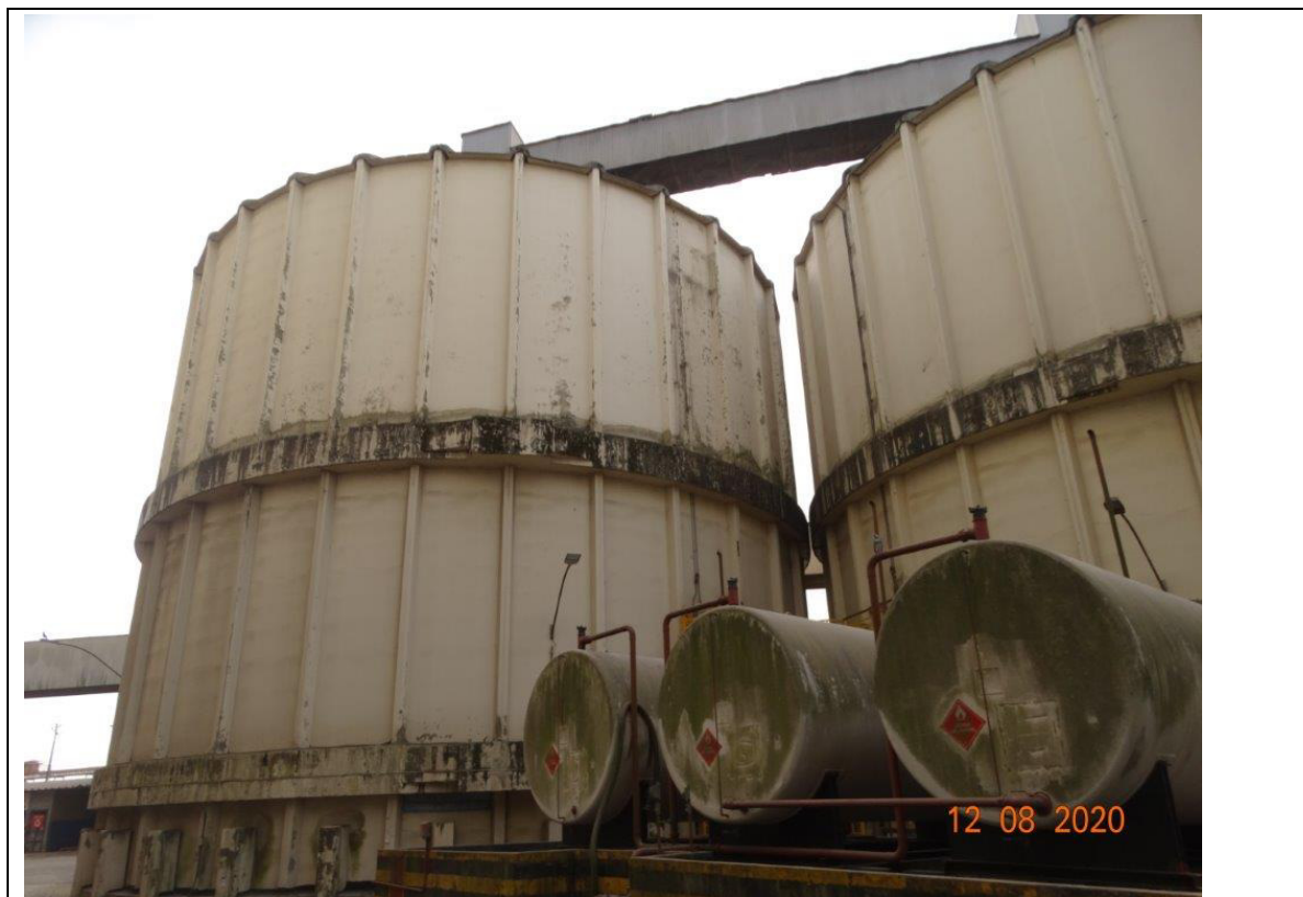
FOTO 198 – SILOS ZORTEA N° 02 (DIR.) e N° 03 (ESQ.).
