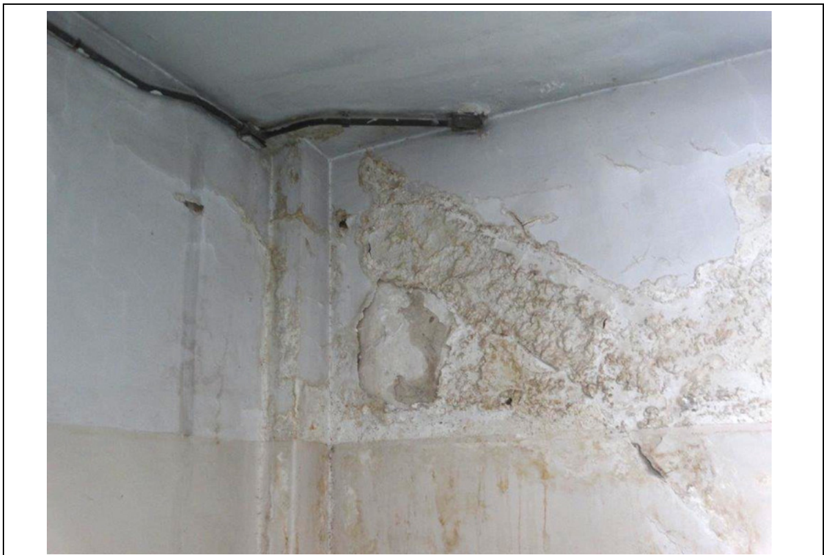
FOTO 71- DETALHE DA FOTO ANTERIOR: MANCHAS ANTIGAS DE UMIDADE COM DESAGREGAÇÃO DA PINTURA, NÃO HÁ UMIDADE NEM GOTEJAMENTO.
