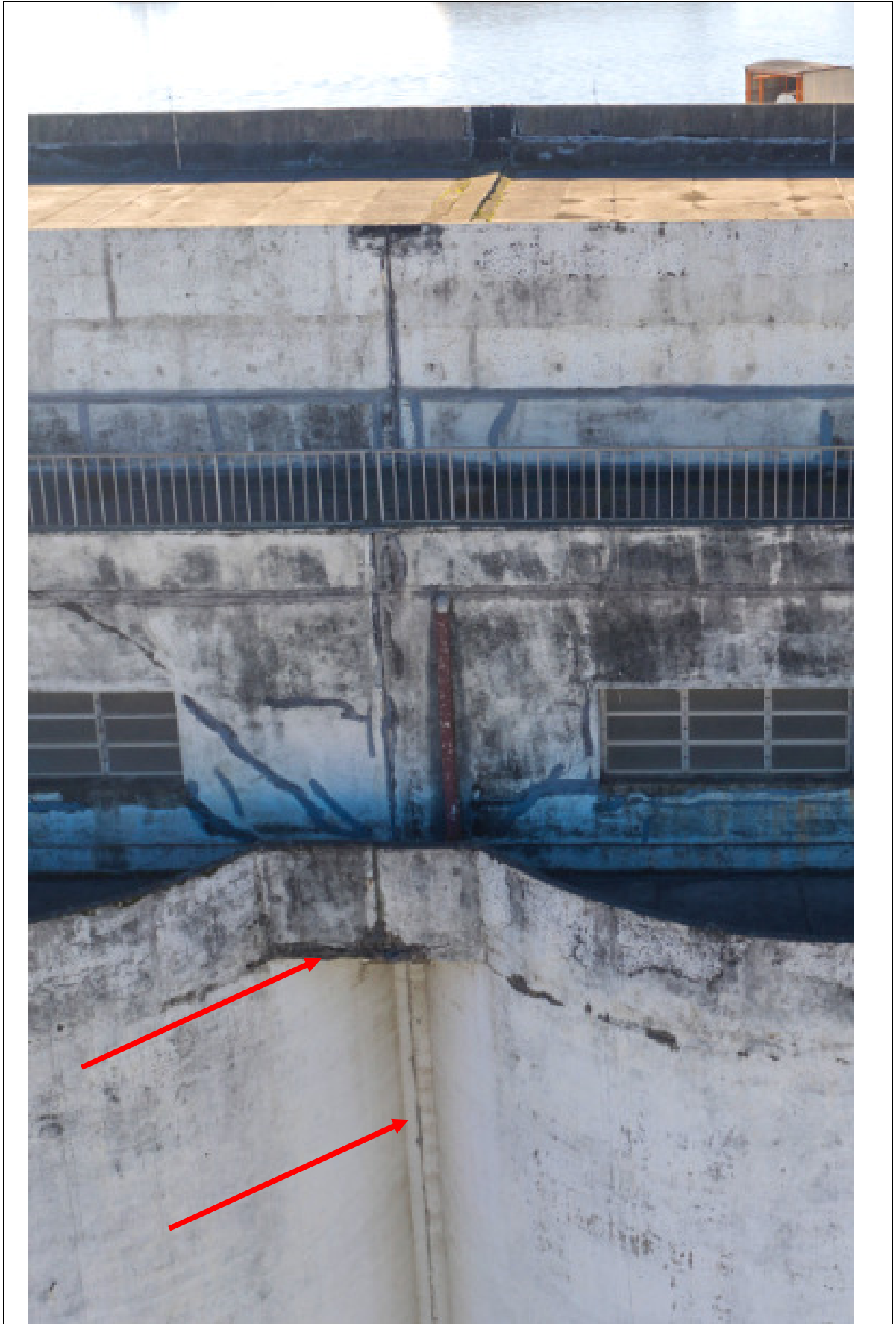
FOTO 280 – TRECHO DO MEGASILO COM JUNTA DE DILATAÇÃO.
