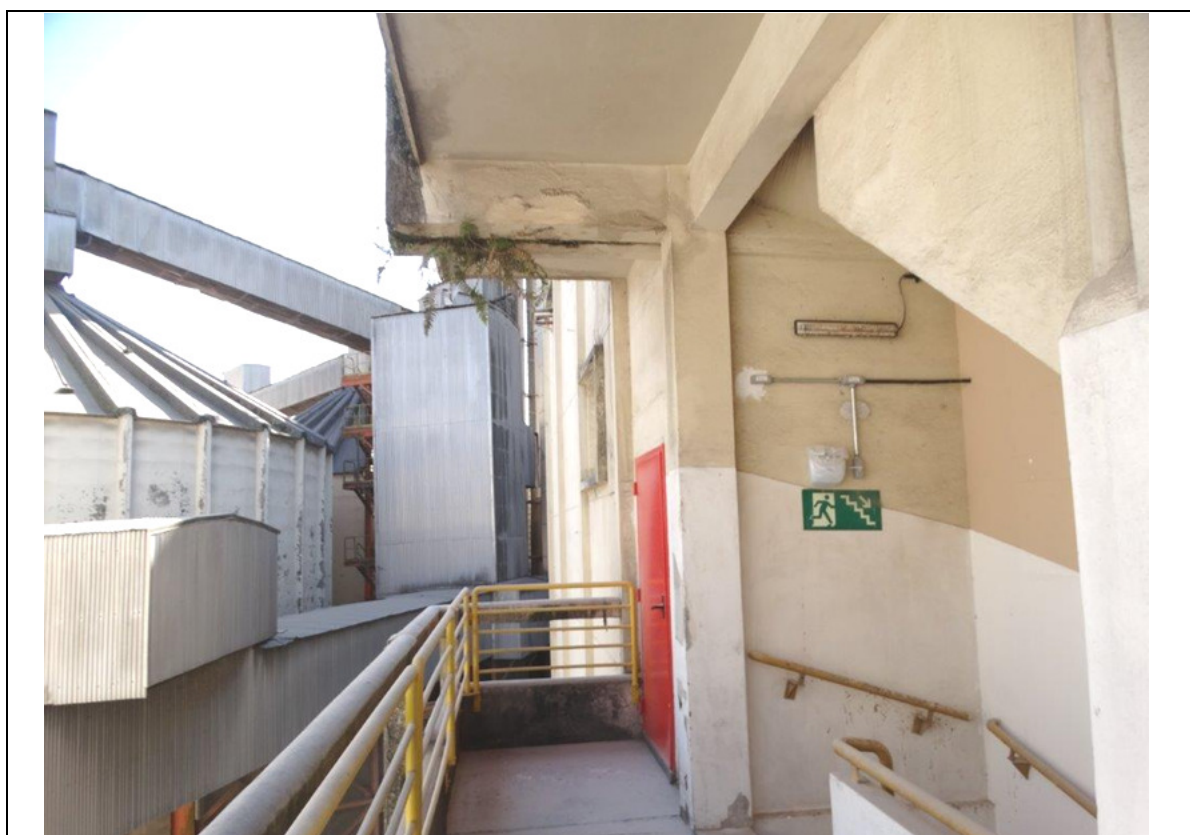
FOTO 147 – PRÉDIO H0 - SAÍDA DE EMERGÊNCIA 3º ANDAR.
