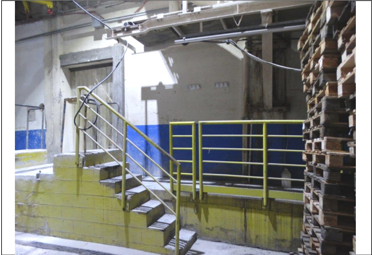
FOTO 181 – TRECHO DE ALVENARIA E ESTRUTURA DO PRÉDIO H0.
