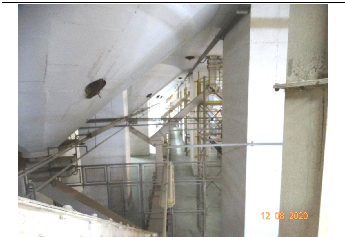
FOTO 261 – MEGASILO: 1º ANDAR.
