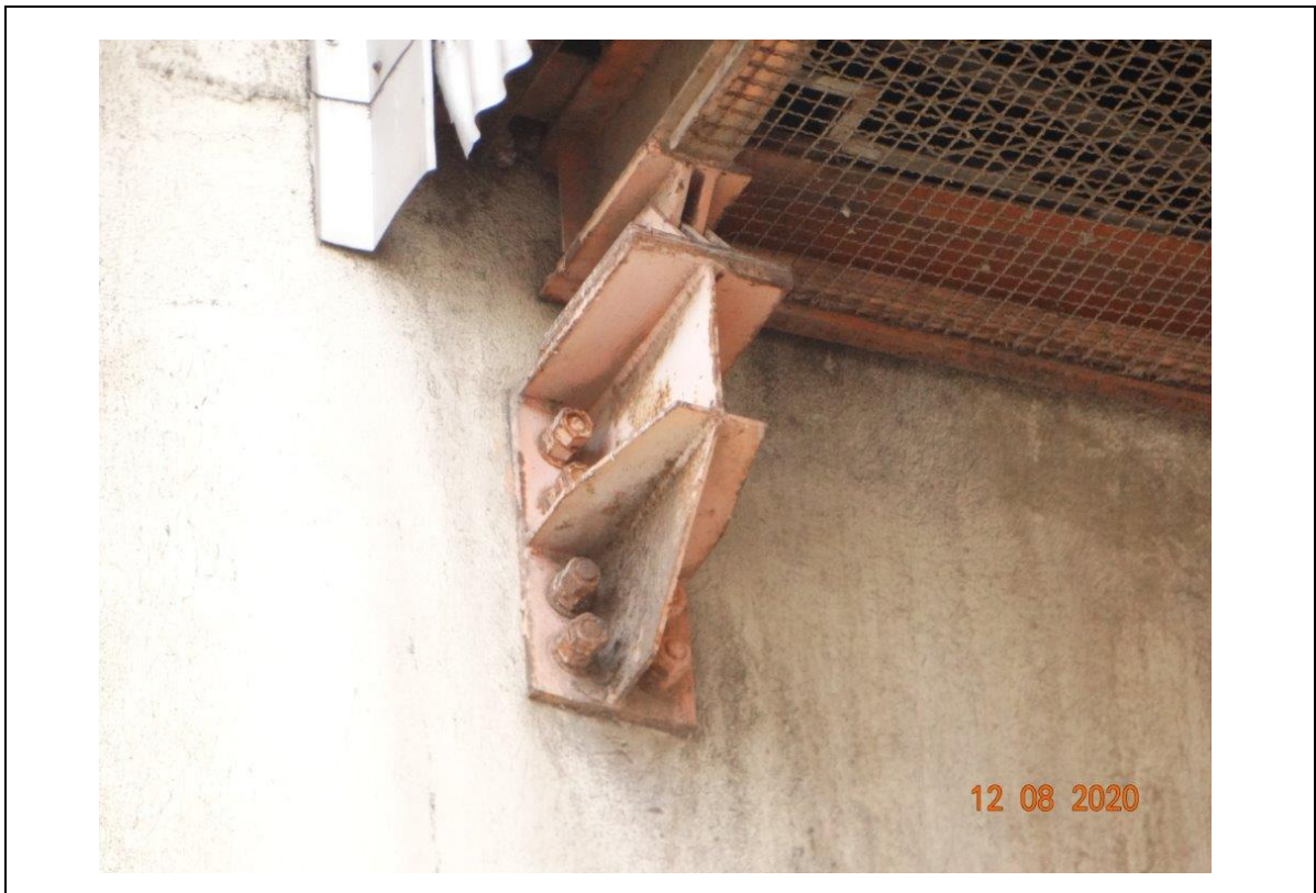
FOTO 209– DETALHE DA FOTO ANTERIOR: CALÇO DE APOIO DA CORREIA TRANSPORTADORA, IMPORTANTE PEÇA DE SUSTENTAÇÃO.
