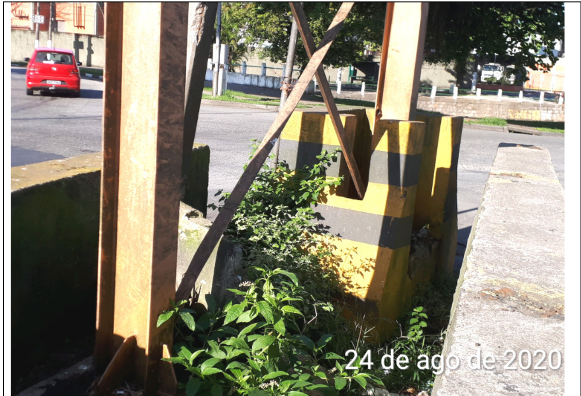
FOTO 300 - BASE DA TORRE DA FOTO ANTERIOR.
