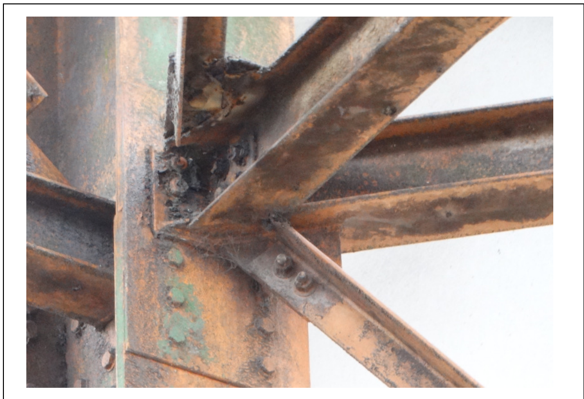
FOTO 213 – DETALHE DA FOTO 211: DIVERSOS TRECHOS DA ESTRUTURA METÁLICA COM CORROSÃO SUPERFICIAL.
