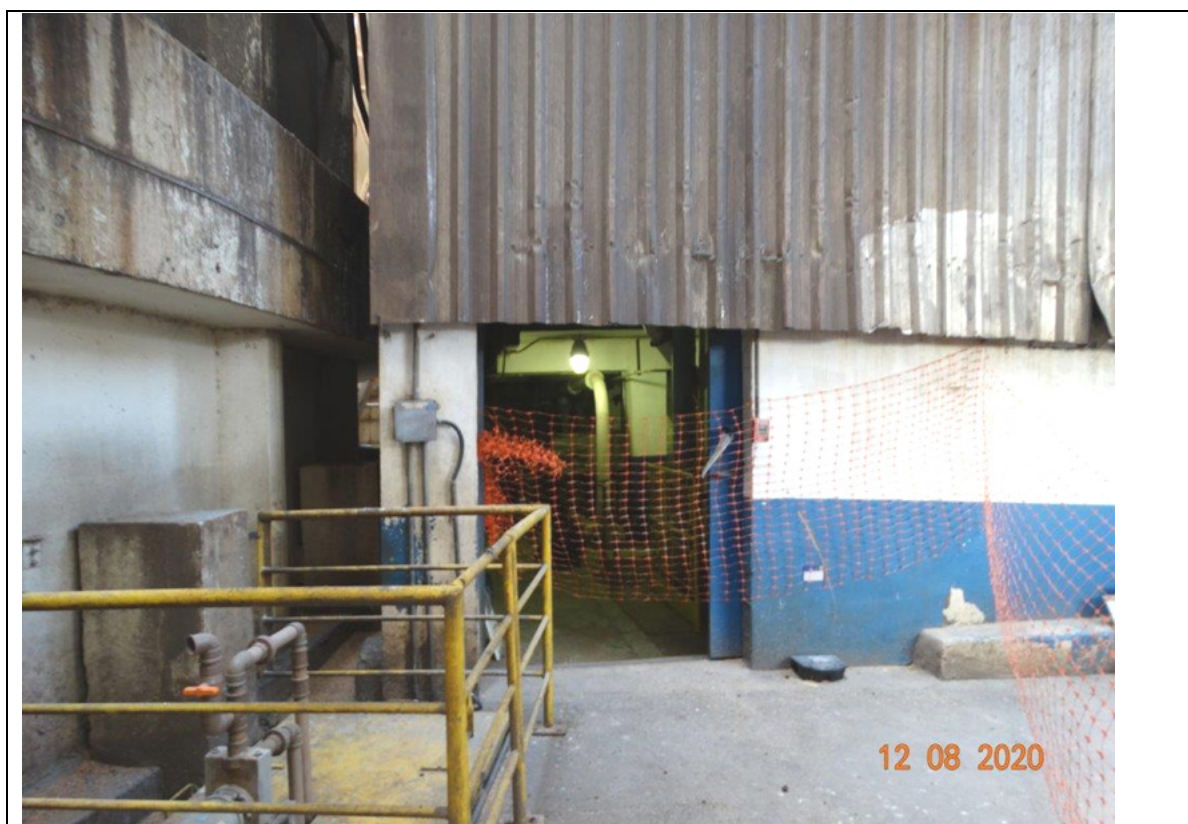
FOTO 217 – PRÉ-LIMPEZA DO SILO ZORTEA.
