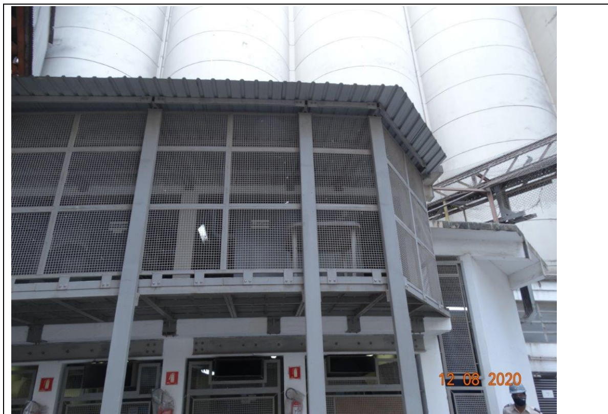
FOTO 216 – SALA DE COMPRESSOR.
