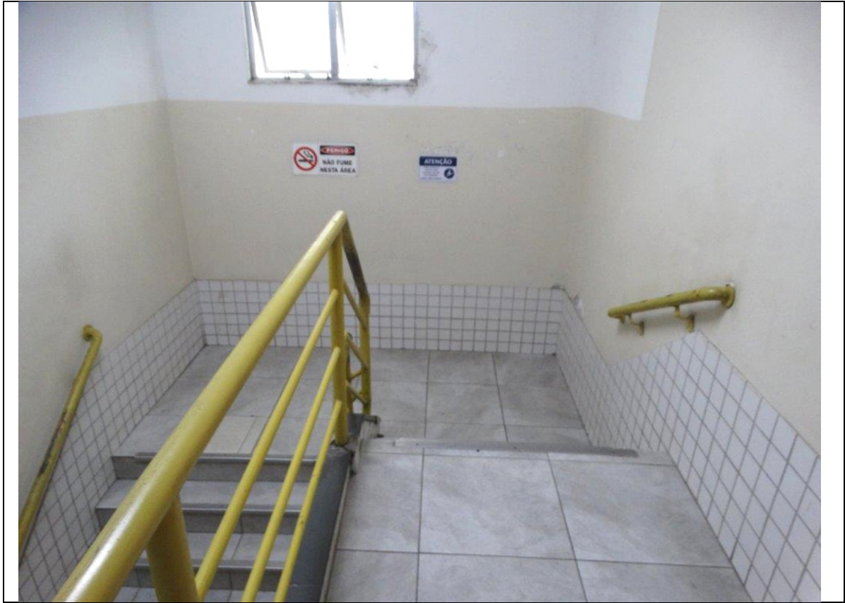
FOTO 27 – ACESSO AO VESTIÁRIO MASCULINO. NECESSÁRIO ADAPTAR O CORRIMÃO DA ESCADARIA (DEVE SER CONTÍNUO INCLUSIVE NOS PATAMARES).
