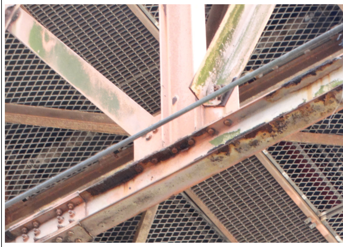
FOTO 204 – DETALHE DA FOTO ANTERIOR: PEÇAS DA ESTRUTURA METÁLICA COM CORROSÃO.
