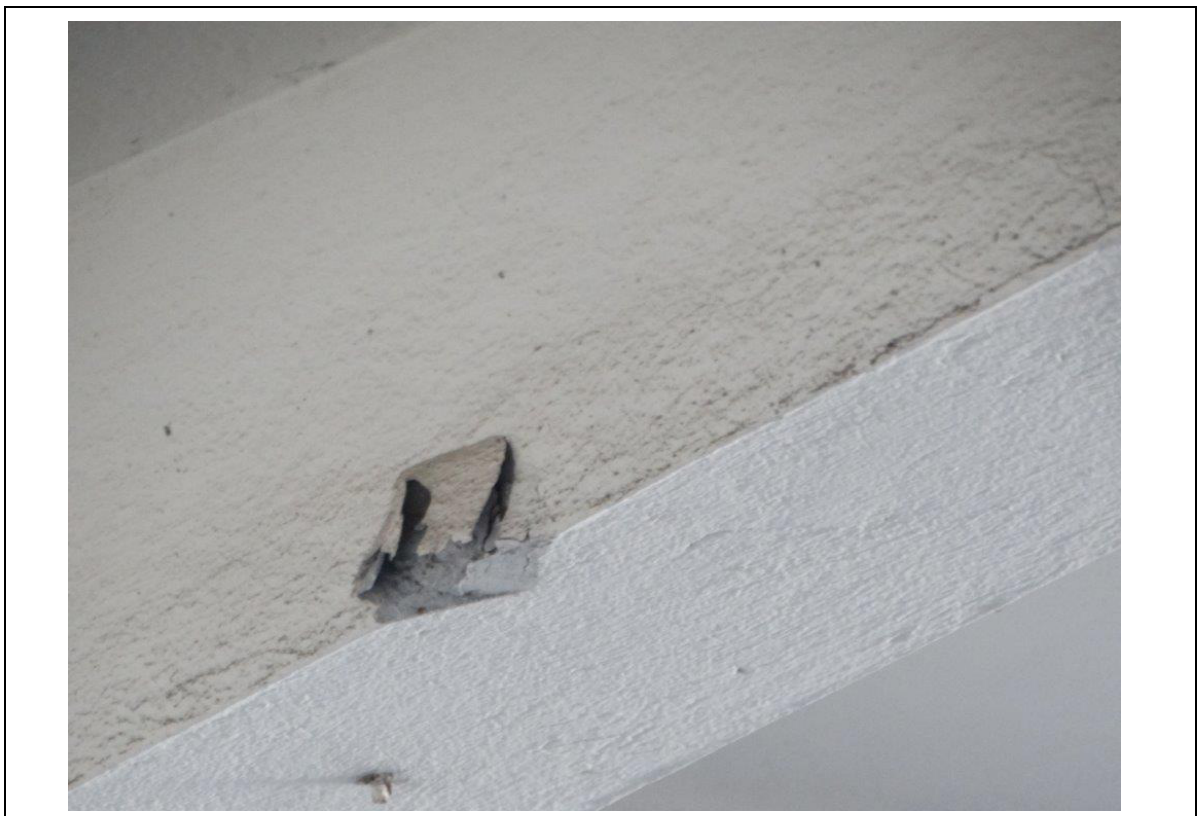
FOTO 42 – DETALHE DA FOTO ANTERIOR: CORROSÃO EM PEQUENO TRECHO DA VIGA EM BALANÇO.
