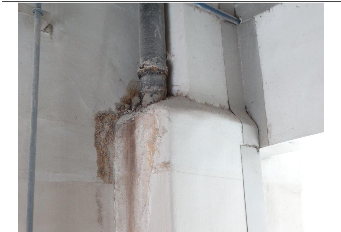
FOTO 73 – DETALHE DA FOTO ANTERIOR: MANCHA DE UMIDADE MAS SEM APRESENTAR GOTEJAMENTO ATIVO.
