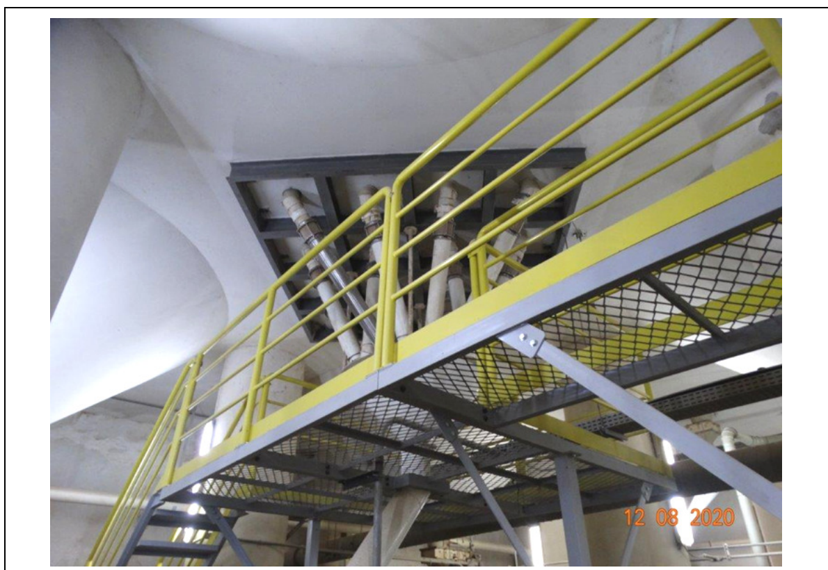
FOTO 122 – PORÃO MOAGEM B.
