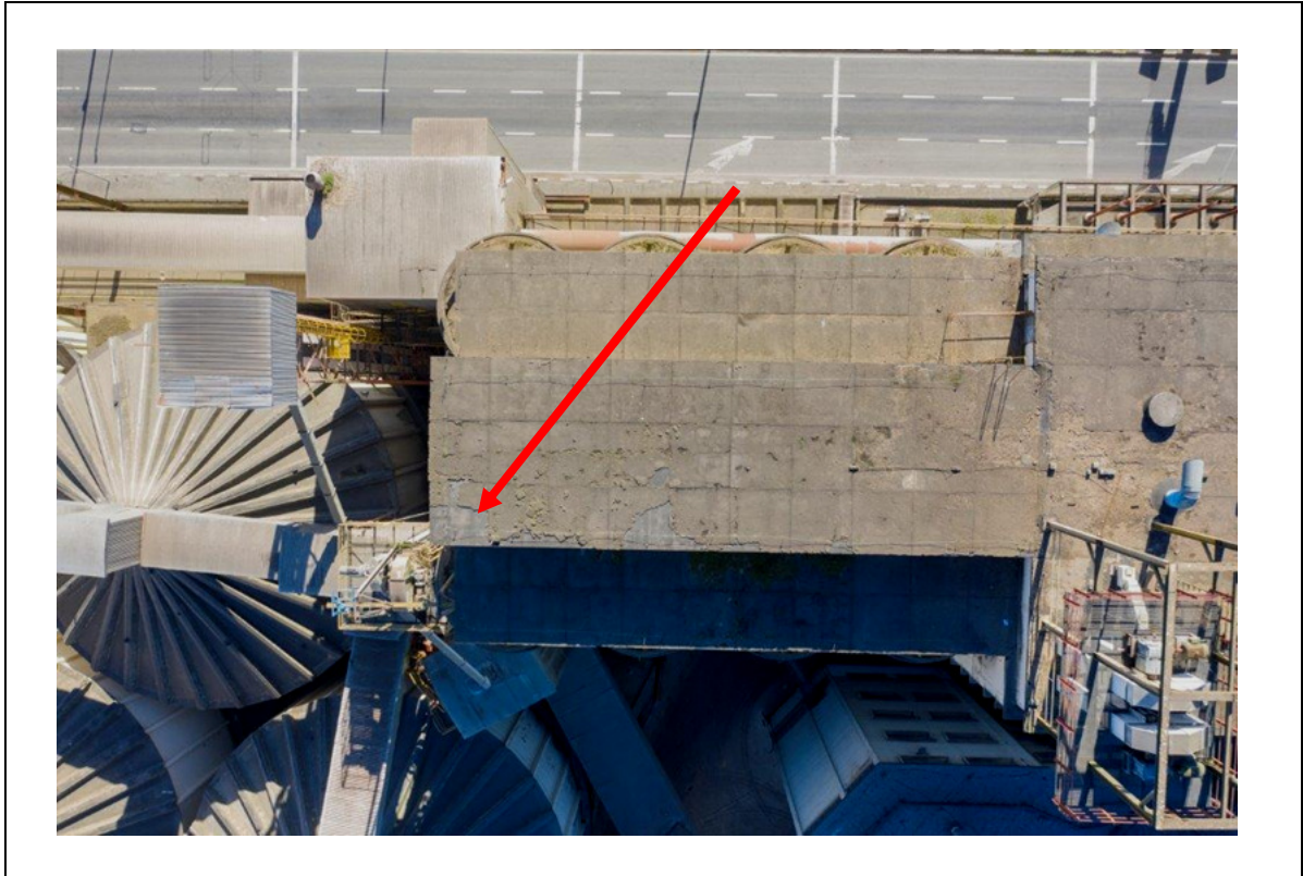
FOTO 289 – PARTE DA COBERTURA DA MOAGEM B.
