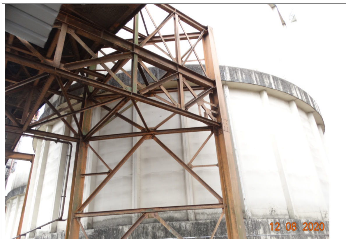
FOTO 211 – ESTRUTURA METÁLICA DA FOTO ANTERIOR. (DA ESTRUTURA VISTA NA FOTO 207).
