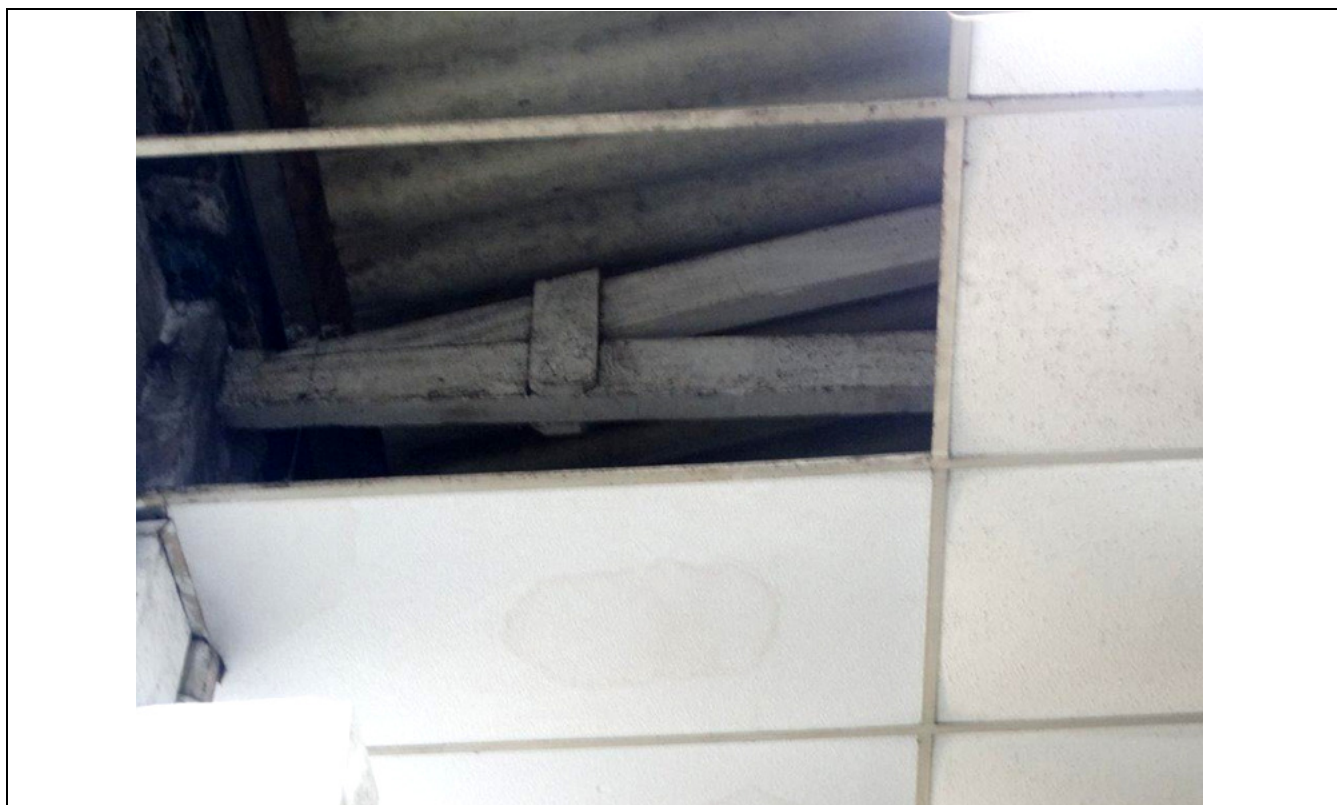
FOTO 08 – TETO DO LOCAL DA FOTO ANTERIOR, COM ALGUMAS PLACAS FALTANTES. OBSERVA-SE TRELIÇA DE MADEIRA DA COBERTURA.
