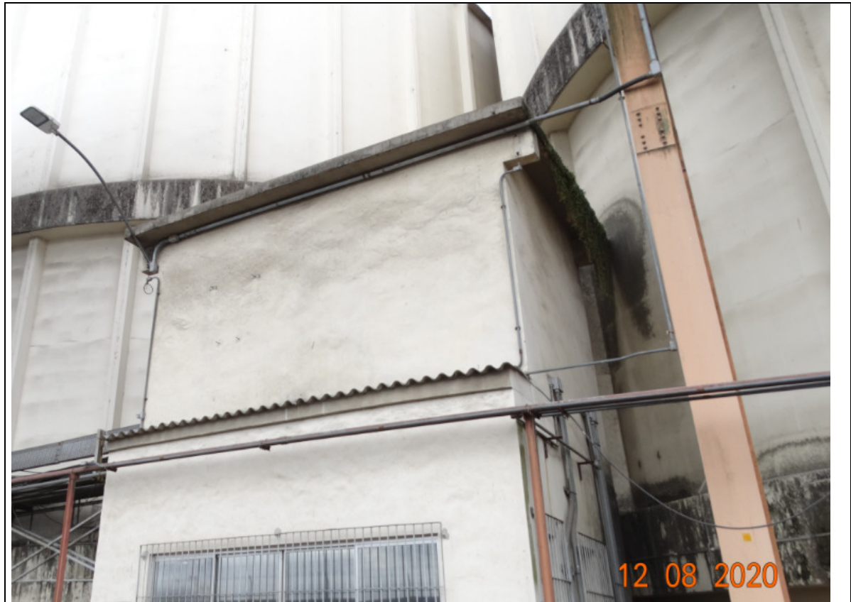
FOTO 237 – CABINE JUNTO AO SILO ZORTEA Nº 01.
