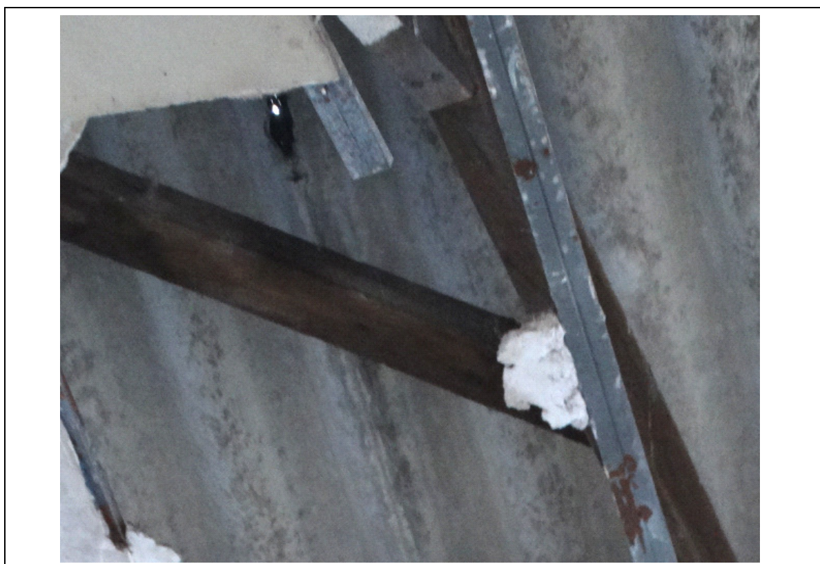
FOTO 46 – DETALHE DA FOTO ANTERIOR: NECESSÁRIO REVISAR: ELIMINAR PONTO DE INFILTRAÇÃO, UMIDADE E CORROSÃO.
