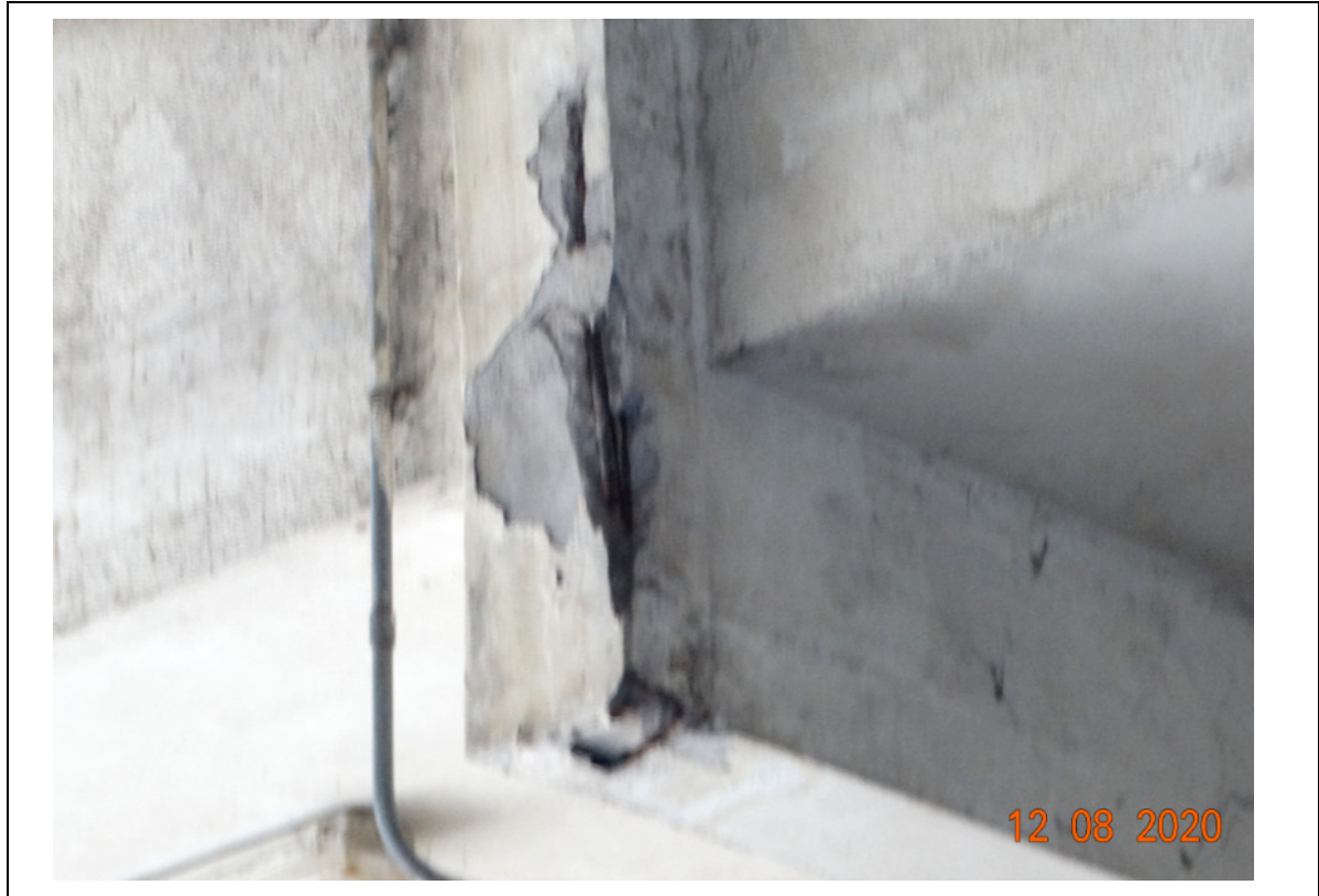
FOTO 176 – DETALHE DA FOTO ANTERIOR: CORROSÃO DE ARMADURA NA EXTREMIDADE DA VIGA.
