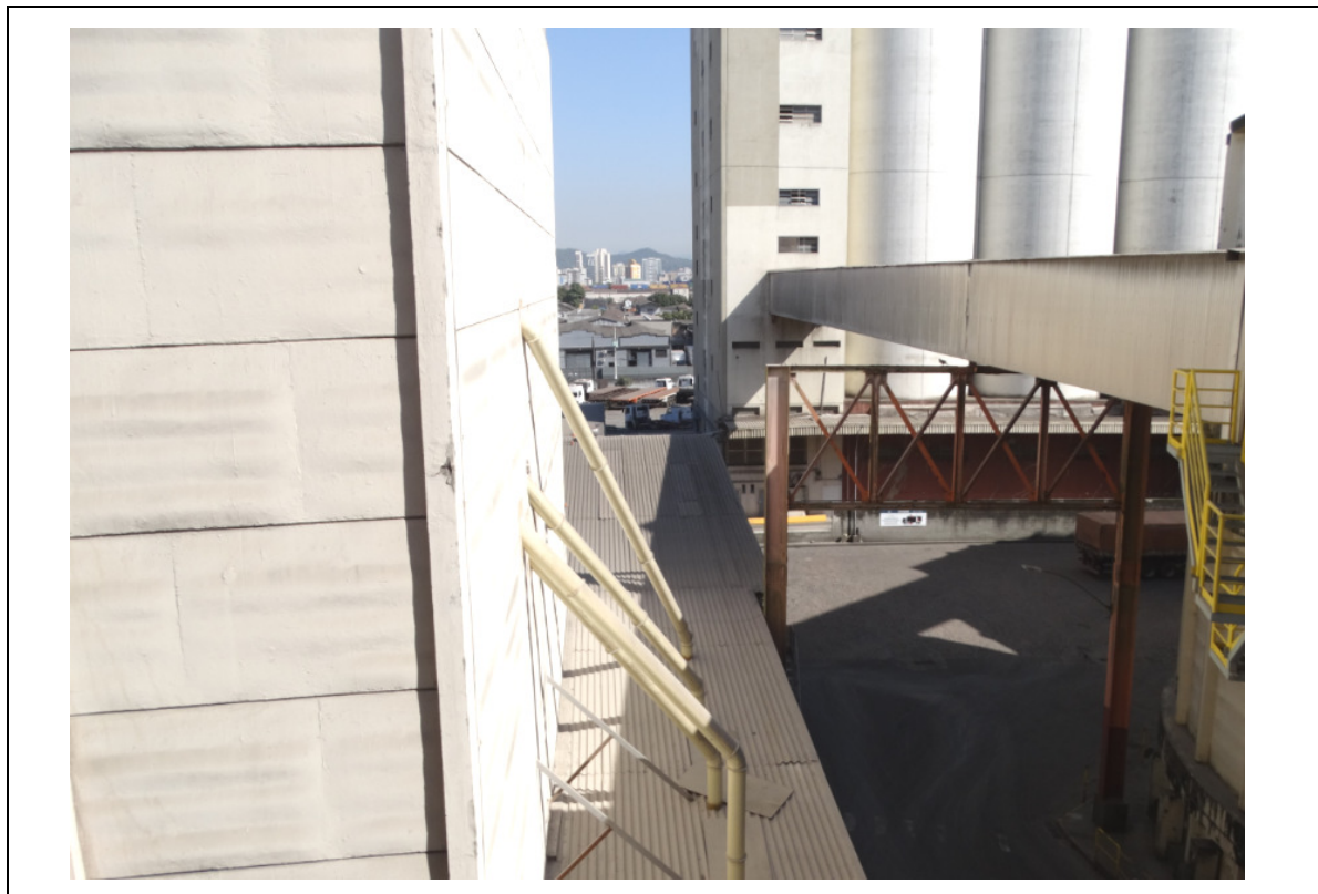
FOTO 150 – TRECHO DA FACHADA DO PRÉDIO H1/H2.
