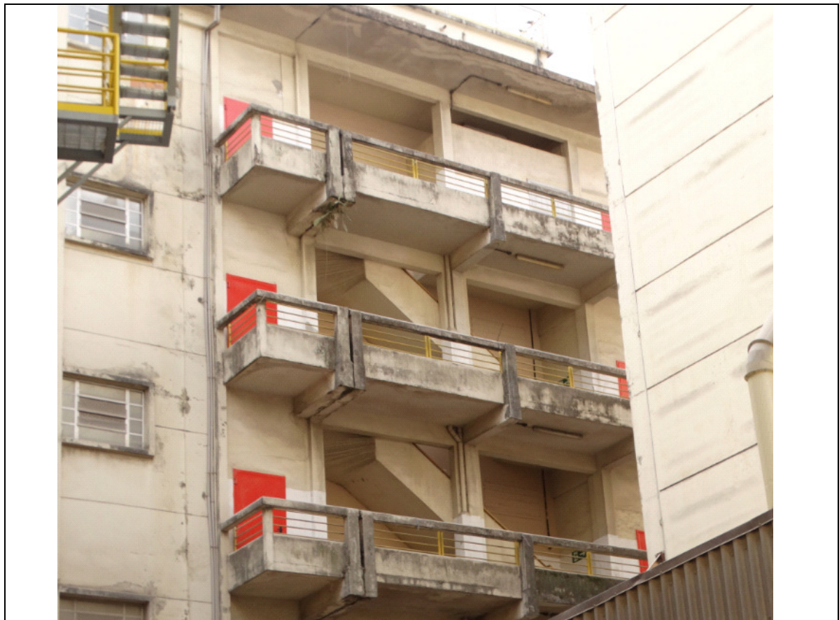
FOTO 133– PRÉDIO H0 - SAÍDA DE EMERGÊNCIA PELO LADO EXTERNO.
