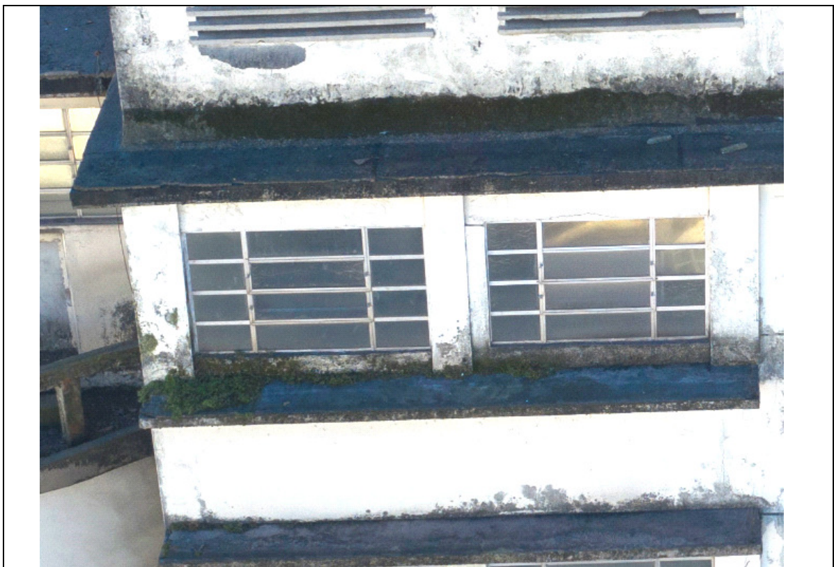
FOTO 292 – DETALHE DA FOTO ANTERIOR: DETALHES DA FACHADA COM ELEMENTOS QUE PROPICIAM ACÚMULO DE UMIDADE, FULIGEM, LIMO, CRESCIMENTO DE MICROORGANISMOS E PLANTAS, CONDIÇÃO PREJUDICIAL A DURABILIDADE DO CONCRETO.
