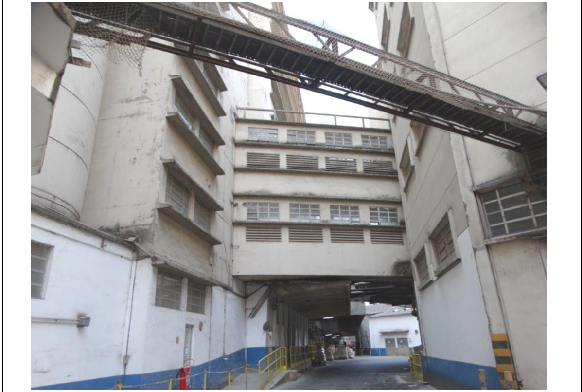
FOTO 117 – A ESQUERDA, PRÉDIO DA MOAGEM B. OS ELEMENTOS DE CONCRETO DA FACHADA SITUAM-SE SOBRE ÁREA DE PASSAGEM DE FUNCIONÁRIOS.
