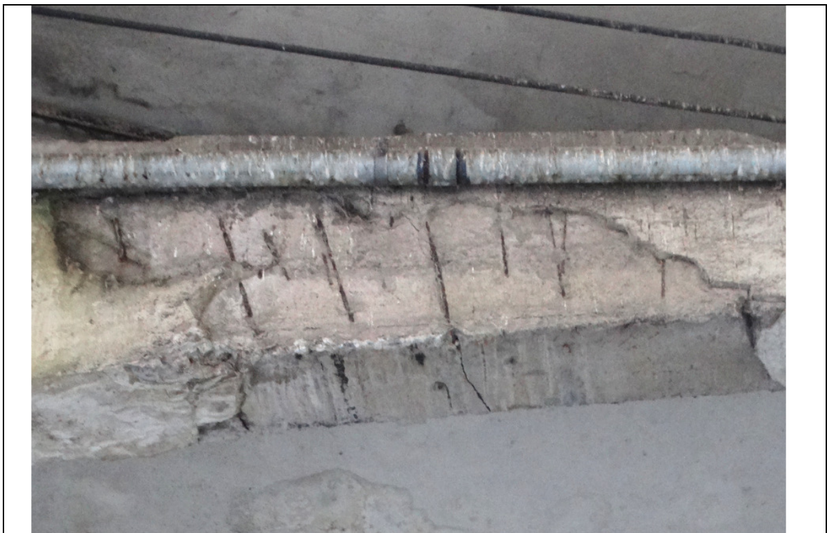
FOTO 85 – DETALHE DO LADO OPOSTO DA VIGA DA FOTO ANTERIOR: CORROSÃO NOS ESTRIBOS, DEFICIÊNCIA DE COBRIMENTO DE CONCRETO.
