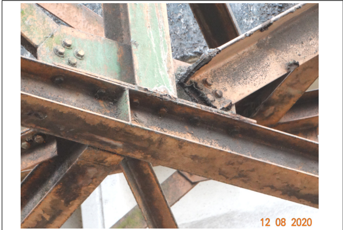
FOTO 212 – DETALHE DA FOTO ANTERIOR: DIVERSOS TRECHOS DA ESTRUTURA METÁLICA COM CORROSÃO SUPERFICIAL.
