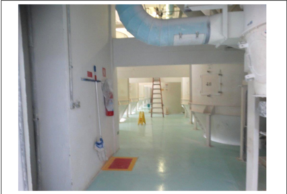
FOTO 168 – PRÉDIO H1: 4º ANDAR.
