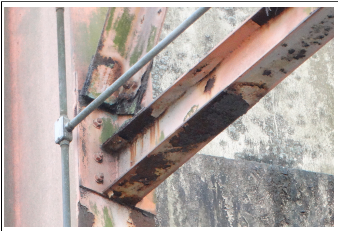
FOTO 205 – DETALHE DA FOTO ANTERIOR: PEÇAS DA ESTRUTURA METÁLICA COM CORROSÃO.
