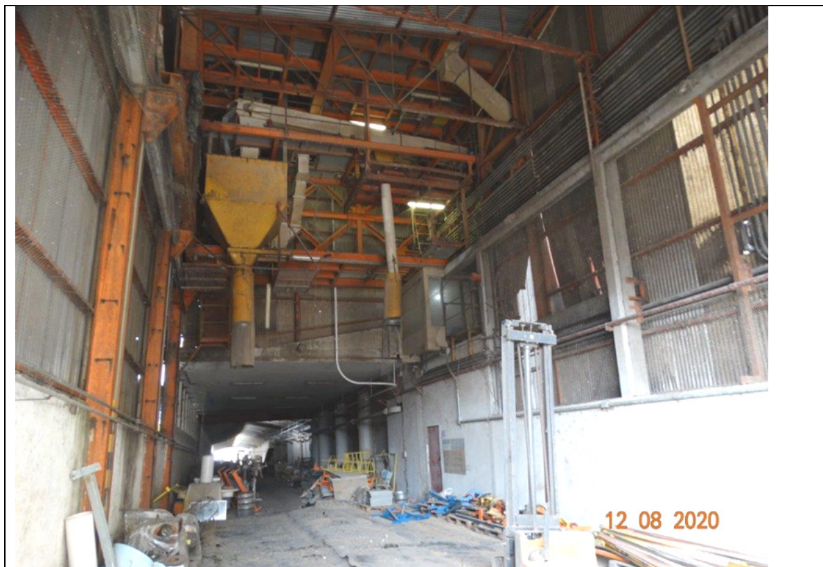
FOTO 239 – TRECHO DE PASSAGEM COBERTO DA LINHA FÉRREA, ATUALMENTE DESATIVADA E USADA COMO CANTEIRO DE OBRAS.
