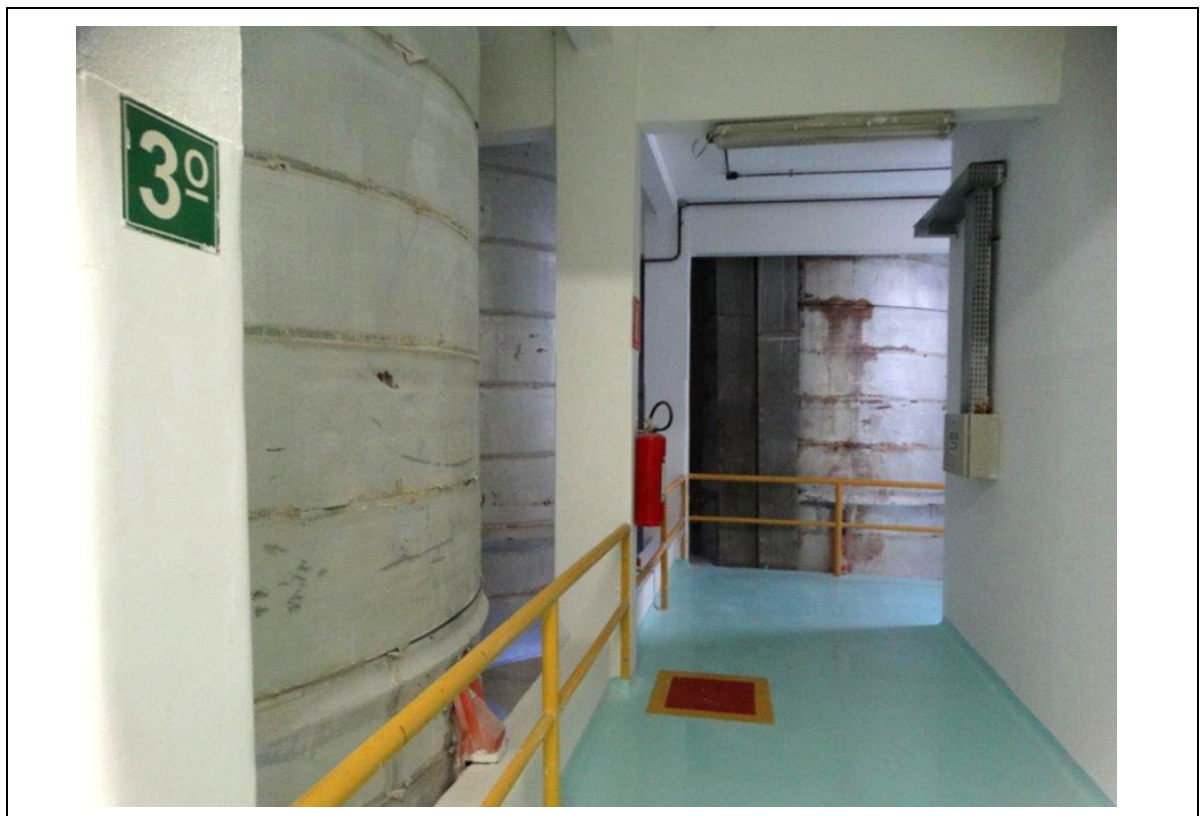
FOTO 145 – PRÉDIO H0 - 3º ANDAR.
