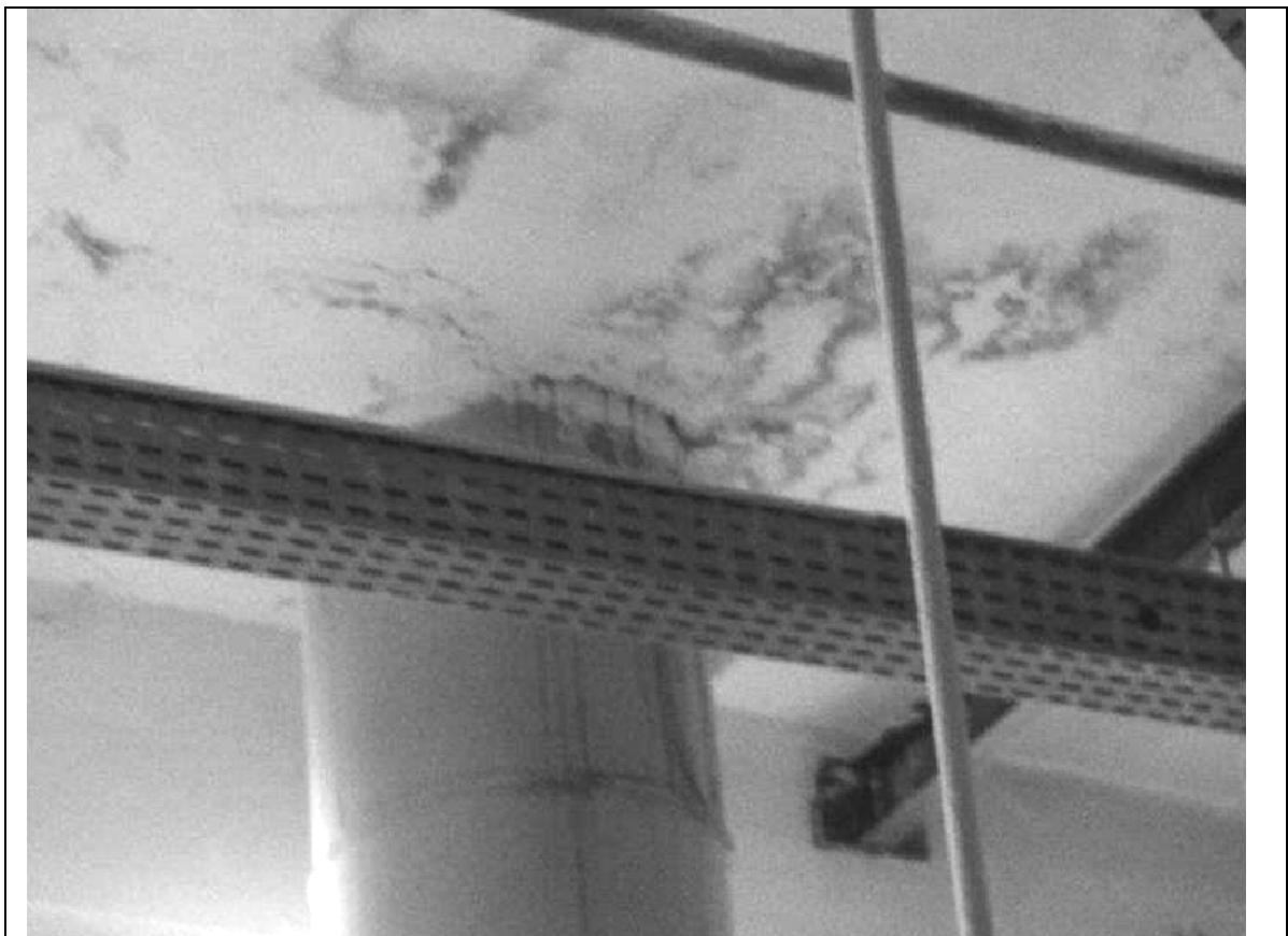
FOTO 131 – DETALHE DA FOTO ANTERIOR: MANCHA DE UMIDADE NO TETO MAS SEM GOTEJAMENTO ATIVO.
