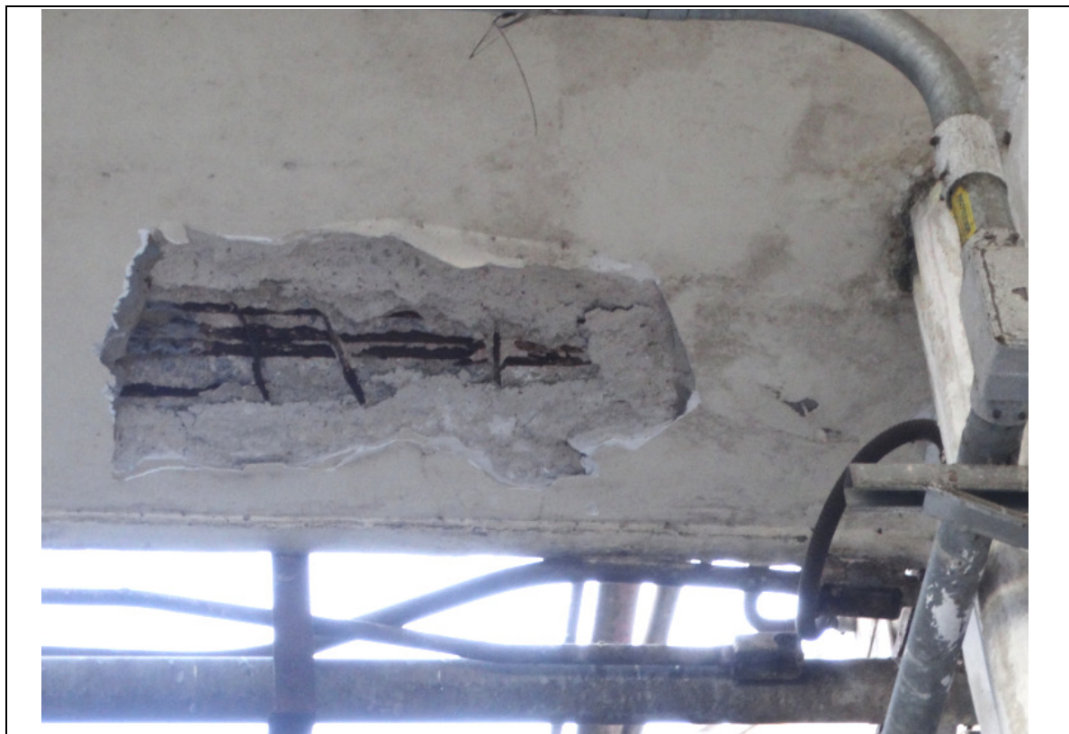
FOTO 34 – DETALHE DA FOTO ANTERIOR: CORROSÃO NAS ARMADURAS DA LAJE.
