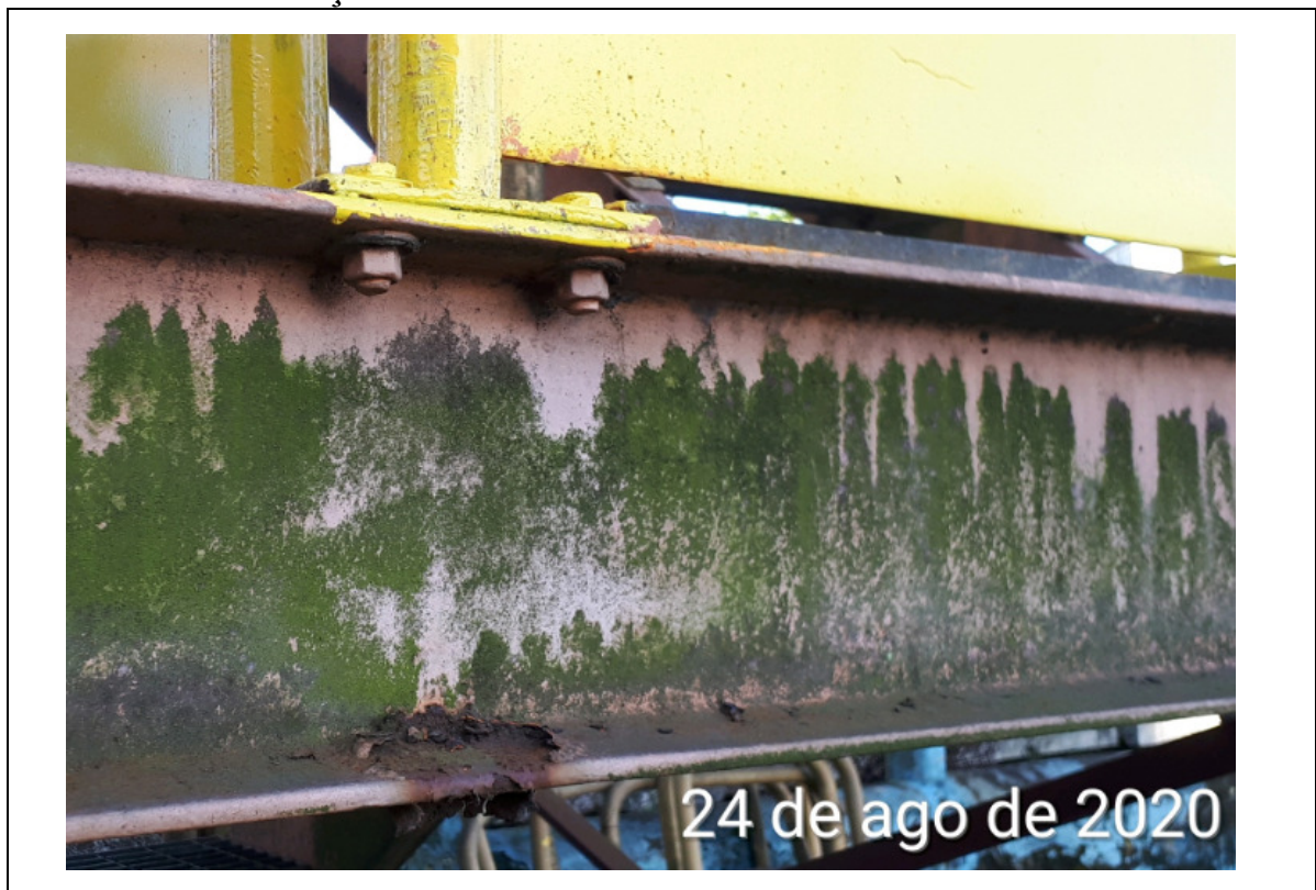
FOTO 307 - UMA DAS VIGAS DA TORRE, COM ACÚMULO DE SUJIDADES, COLÔNIA DE FUNGOS E BACTÉRIAS COM COR ESVERDEADA. CORROSÃO LOCALIZADA.
