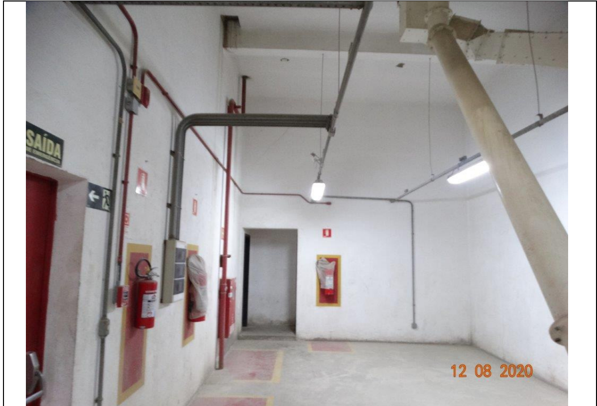
FOTO 259 – MEGASILO: 2º ANDAR.
