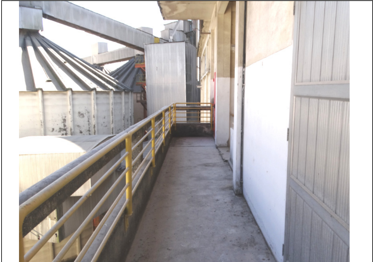
FOTO 134 – PRÉDIO H0 - SAÍDA DE EMERGÊNCIA 4º ANDAR.
