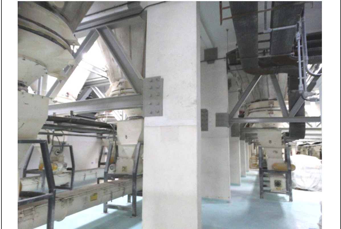
FOTO 160 – PRÉDIO H0 - 1º ANDAR.
