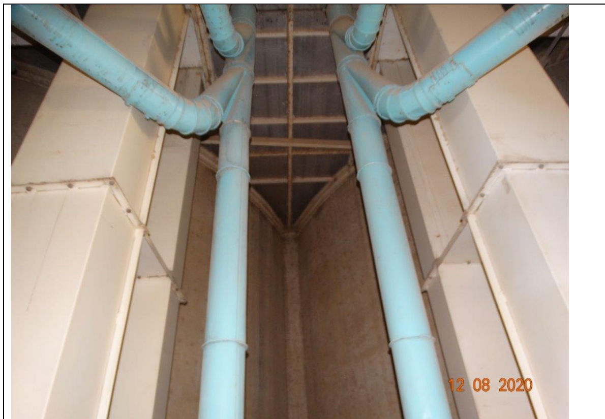
FOTO 257 – MEGASILO: 4º ANDAR.
