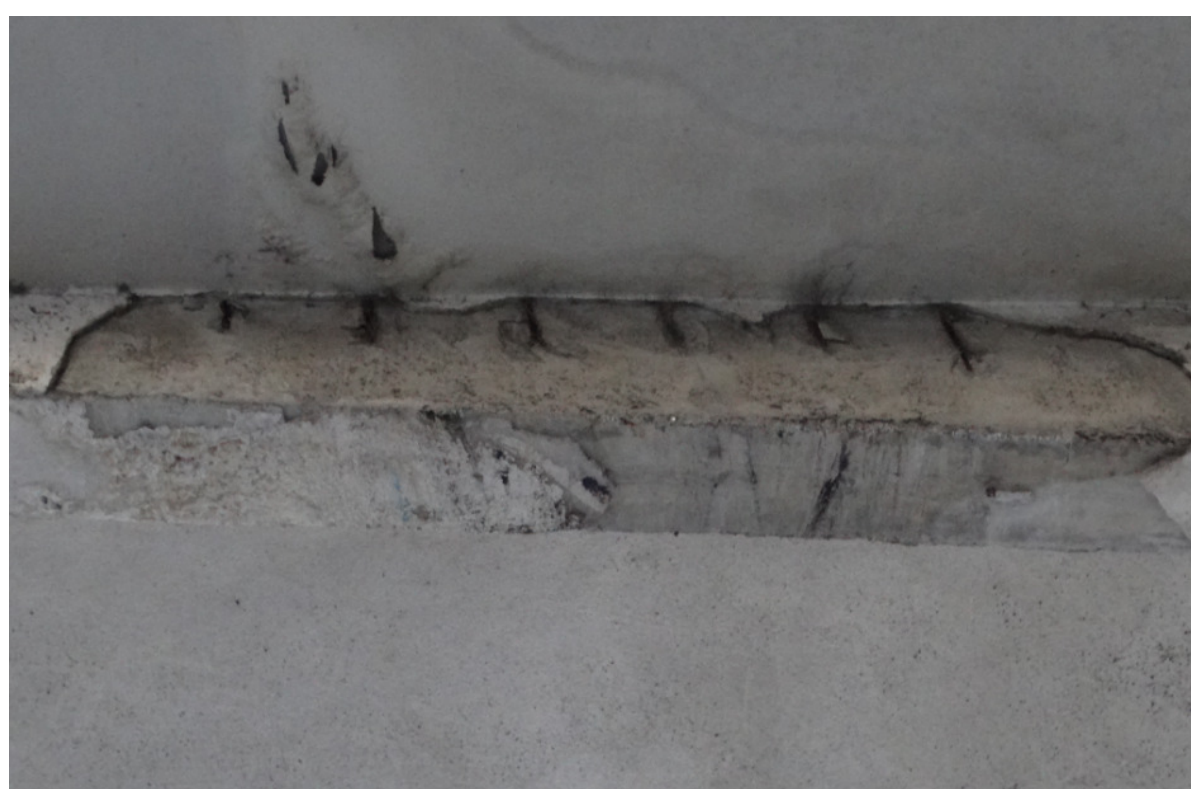
FOTO 82- DETALHE DA FOTO ANTERIOR: CORROSÃO EM VIGA, DEFICIÊNCIA NO COBRIMENTO DO CONCRETO. DESTACAMENTO DA ARGAMASSA.
