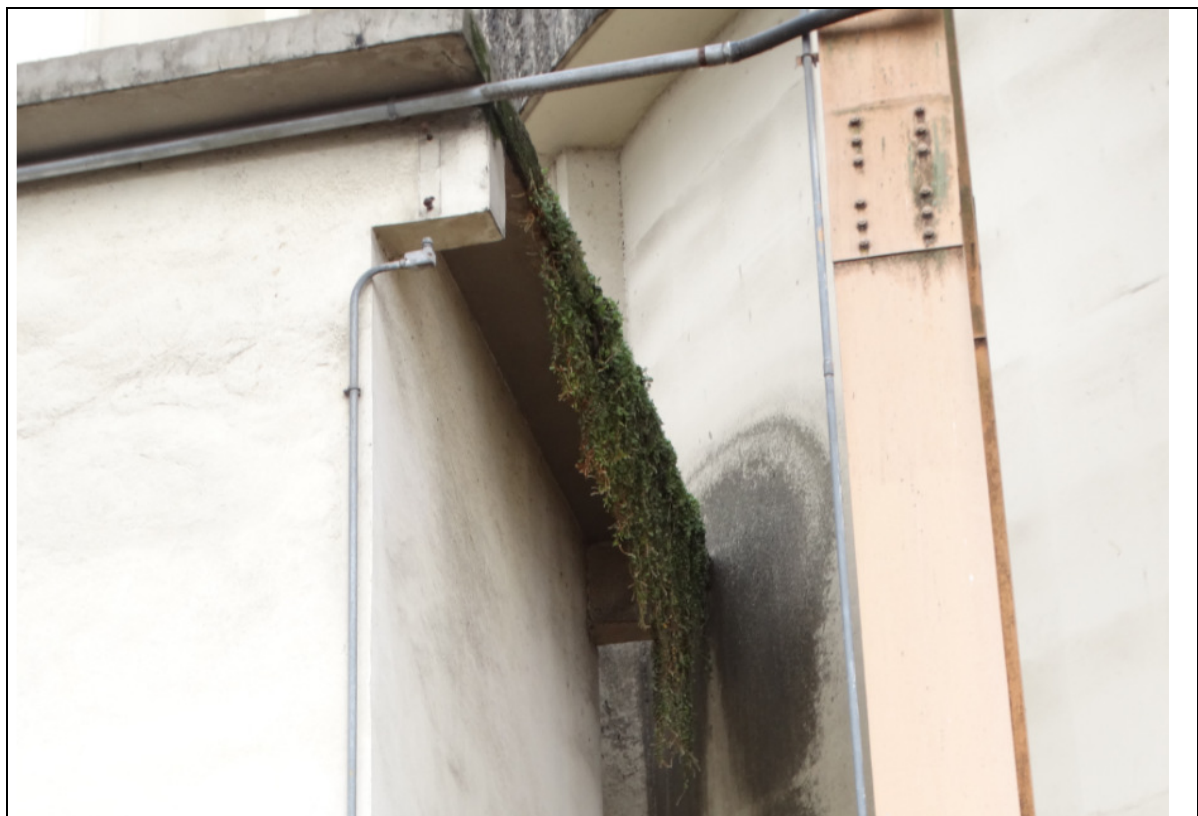
FOTO 238 – DETALHE DA FOTO ANTERIOR: CRESCIMENTO DE PLANTAS, FUNGOS E LIMO SOBRE A LAJE DE COBERTURA DA CABINE.
