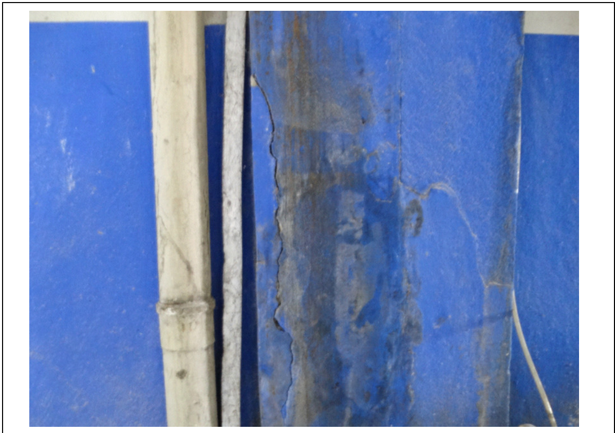
FOTO 182 – DETALHE DA FOTO ANTERIOR: INDÍCIO DE CORROSÃO DA ARMADURA DO PILAR. NECESSÁRIO UMA INSPEÇÃO INVASIVA, CASO EXISTA CORROSÃO TRATAR ADEQUADAMENTE.
