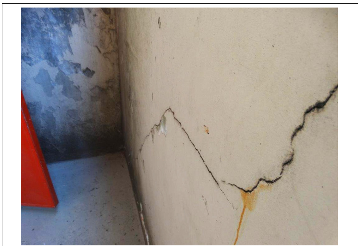
FOTO 159 – DETALHE DA FOTO ANTERIOR: EXTENSA RACHADURA NA ALVENARIA. NECESSÁRIO REFORÇAR.
