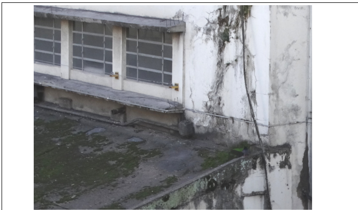
FOTO 89- DETALHE DA FOTO ANTERIOR: LAJE DE COBERTURA COM FUNGOS E LIMO.
