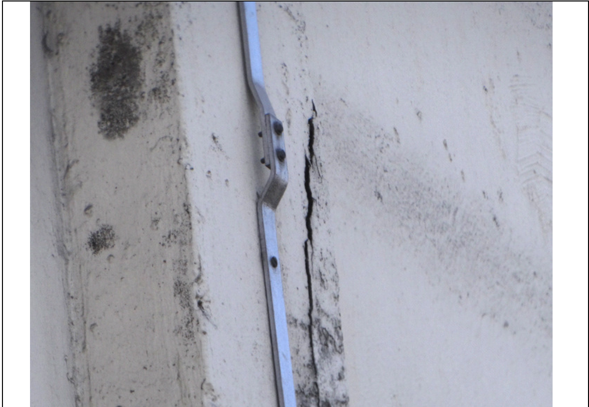
FOTO 190 - DETALHE DA FOTO ANTERIOR: INDÍCIO DE CORROSÃO DE ARMADURA DO PILAR. NECESSÁRIO UMA INSPEÇÃO INVASIVA, CASO EXISTA CORROSÃO TRATAR ADEQUADAMENTE.
