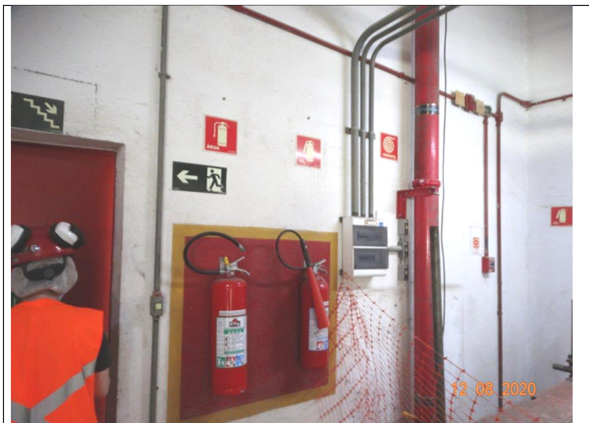
FOTO 250 – MEGASILO: 8º ANDAR.
