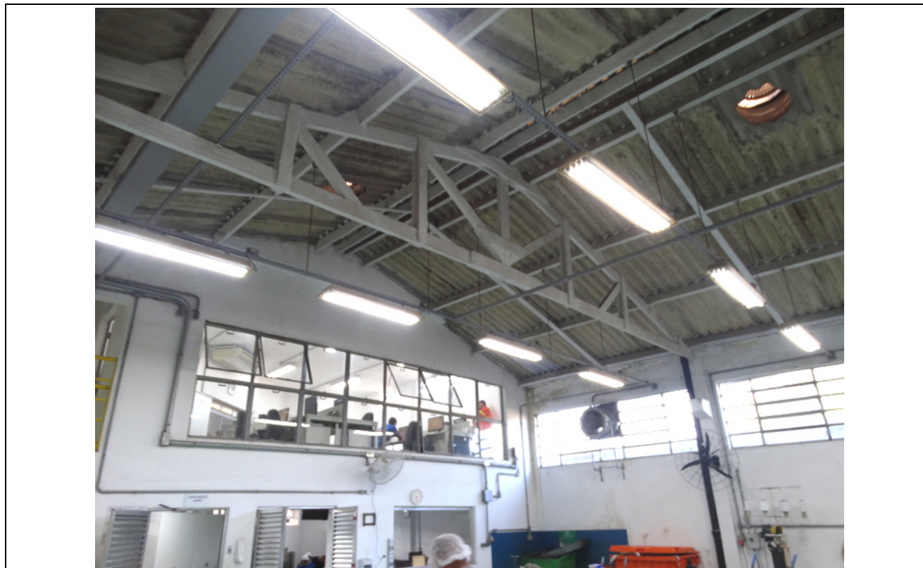
FOTO 03 – SETOR DE OFICINA /MANUTENÇÃO.
