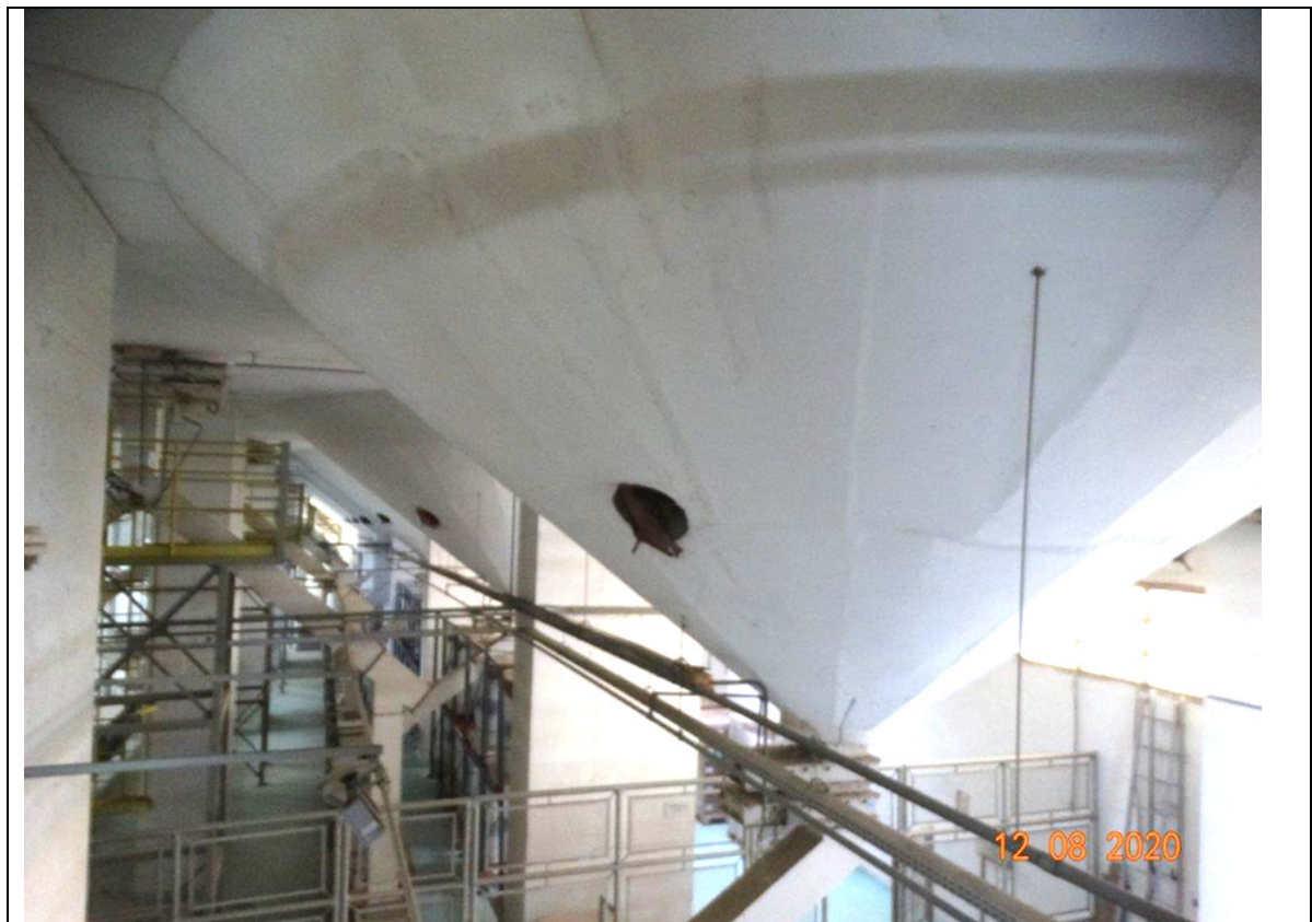
FOTO 260 – MEGASILO: 1º ANDAR.
