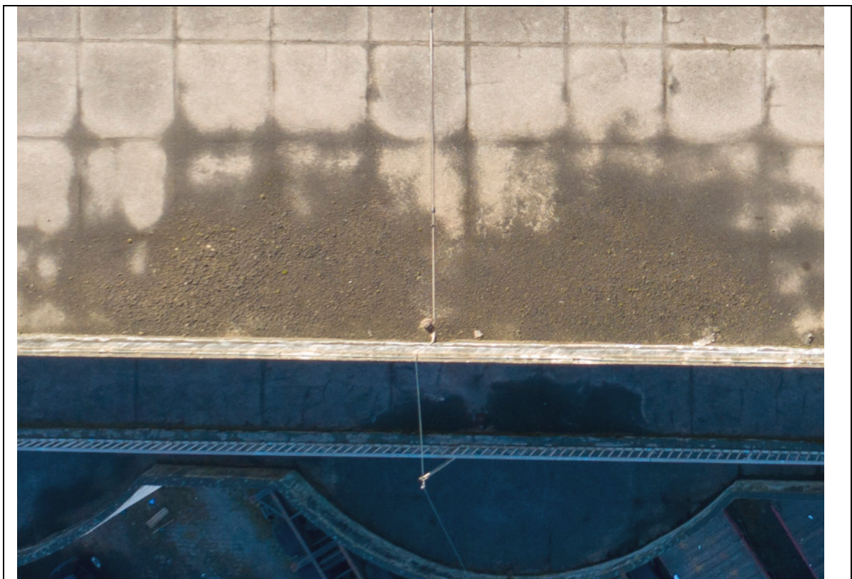
FOTO 273 – DETALHE DE TRECHO DA LAJE DE COBERURA DO MEGASILO, COM SUJIDADES JUNTO AOS PONTOS DE DRENAGEM DE ÁGUA PLUVIAL.
