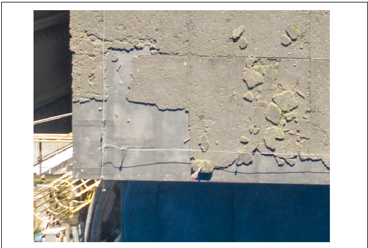
FOTO 290 – DETALHE DA FOTO ANTERIOR: DESGASTE DA ARGAMASSA DE PROTEÇÃO MECÂNICA EM ALGUNS TRECHOS; NECESSÁRIO REFAZER PARA EVITAR DANOS A MANTA ASFÁLTICA PELA AÇÃO DIRETA DOS RAIOS ULTRAVIOLETA.
