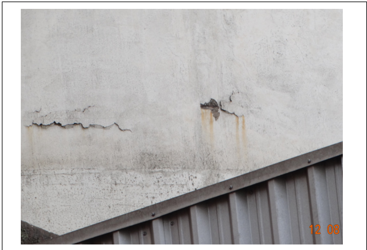
FOTO 227 – DETALHE DA FOTO ANTERIOR: TRECHO DA PAREDE COM ARMADURAS CORROÍDAS, DESTACANDO O CONCRETO DE COBRIMENTO.
