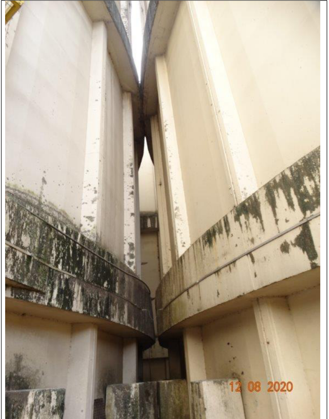
FOTO 197– SILOS ZORTEA N° 04 (DIR.) e N° 05 (ESQ.).
