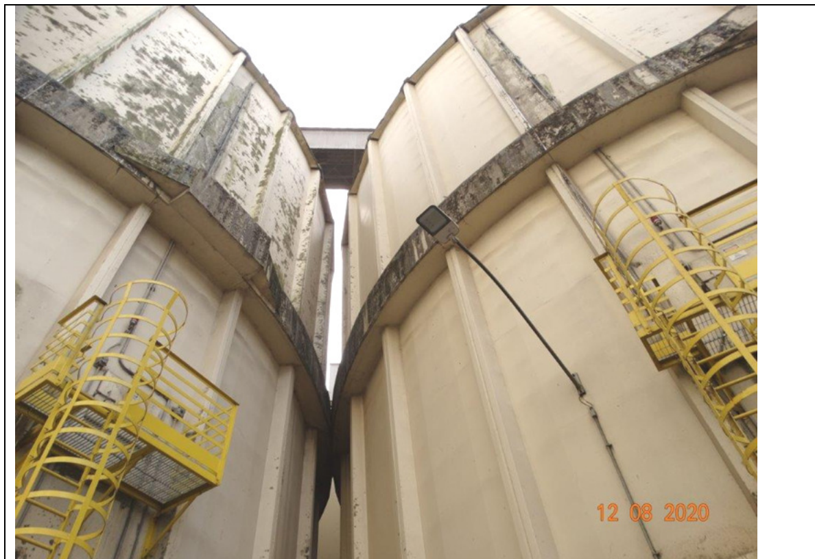
FOTO 195 – SILOS ZORTEA N° 04 (DIR.) e N° 05 (ESQ.) - OCORREU UM RECALQUE GERANDO A APROXIMAÇÃO DESSES SILOS. HÁ ARQUIVOS SOBRE ESTUDOS E PROCEDIMENTOS ADOTADOS, EM ANEXO A ESTE LAUDO.
