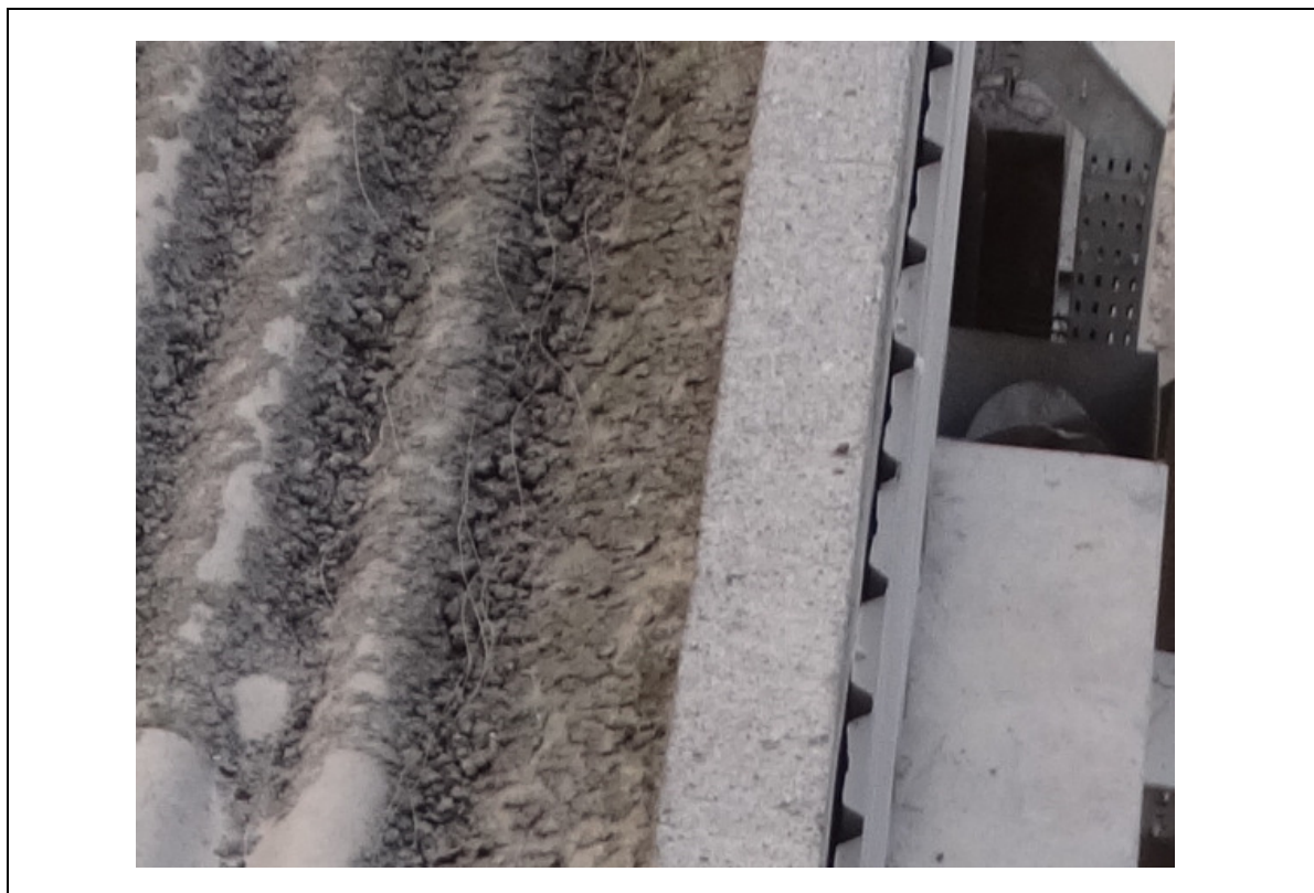
FOTO 156 – DETALHE DA FOTO ANTERIOR: SUJIDADES SOBRE AS TELHAS.
