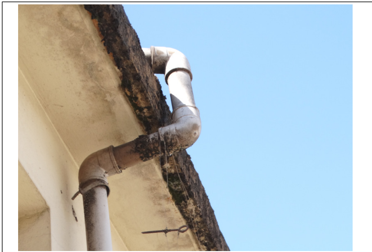
FOTO 140 – TUBULAÇÃO DE PVC SEM SUPORTE JUNTO A FACHADA.
