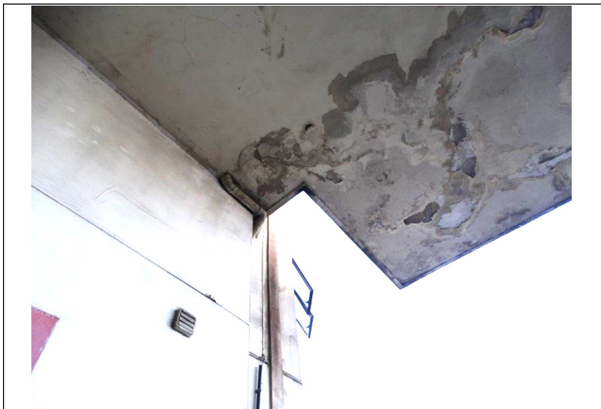
FOTO 35 – COBERTURA DA ENTRADA - EXTENSAS MANCHAS DE UMIDADE.
