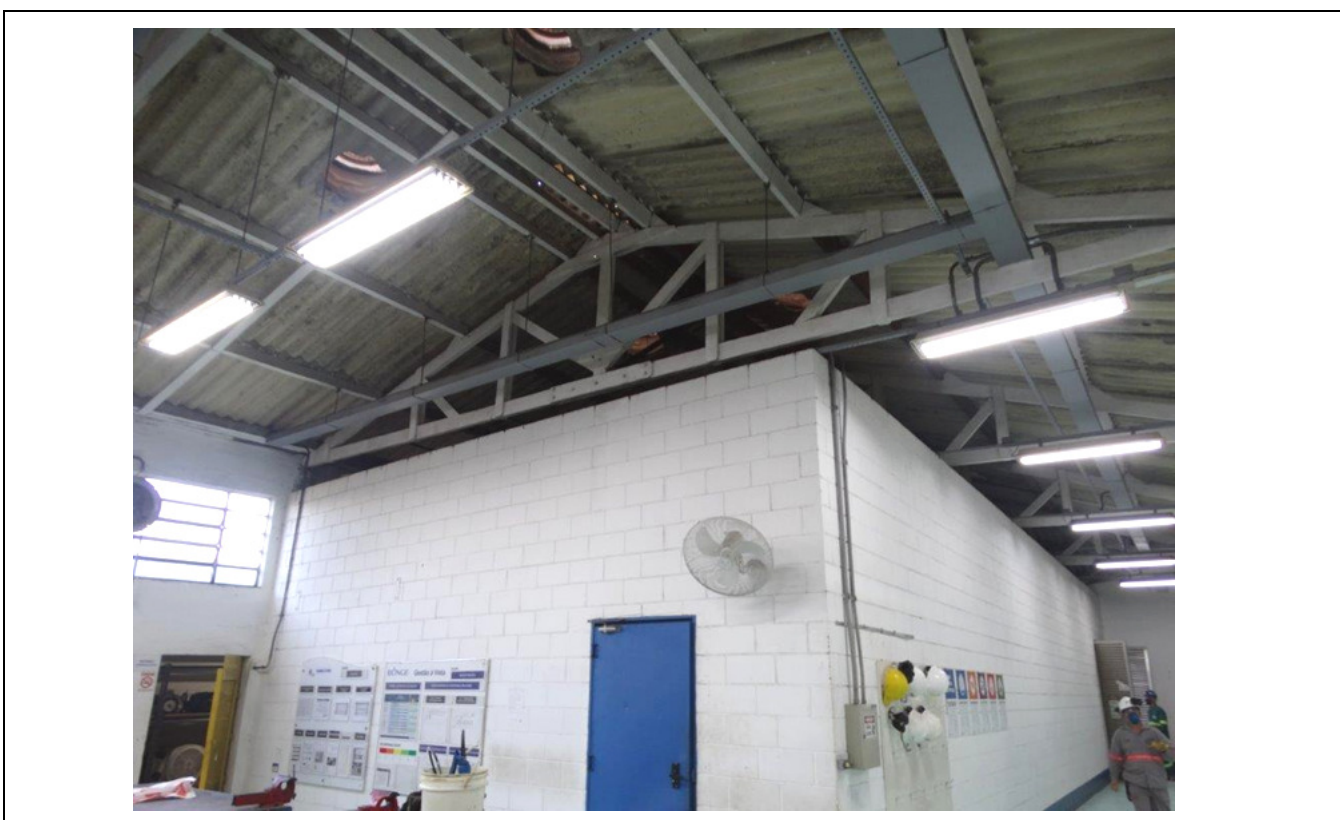
FOTO 04 – SETOR DE OFICINA /MANUTENÇÃO.
