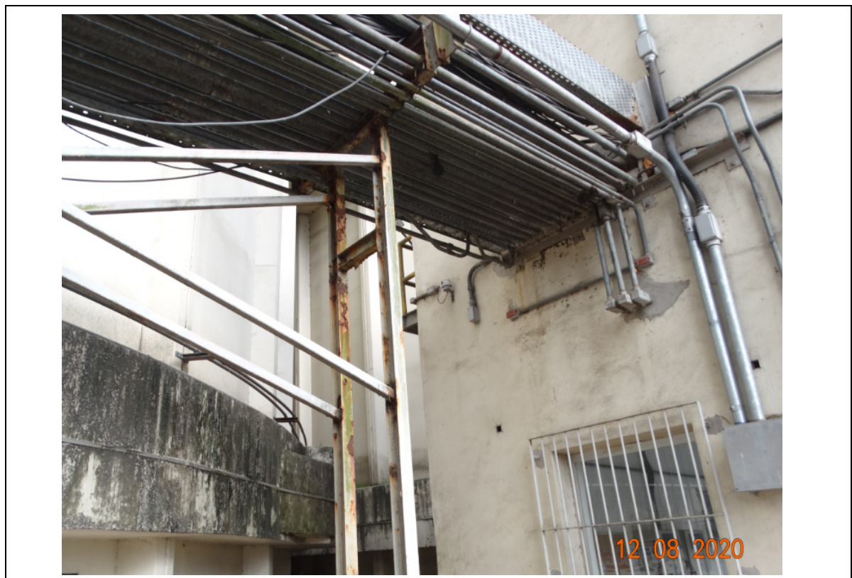
FOTO 242 – DETALHE DA FOTO ANTERIOR: SUPORTE PARA ELETRODUTOS.
