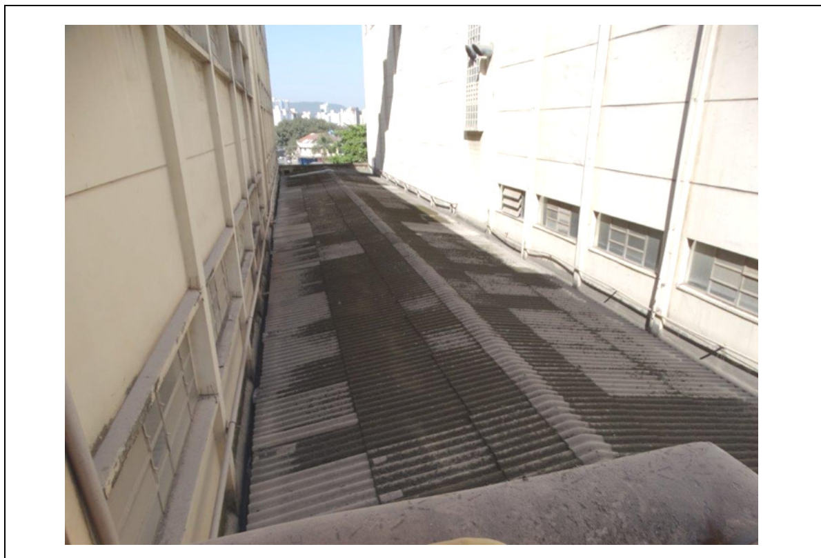
FOTO 154 – TELHADO ENTRE H0 e H1/H2.
