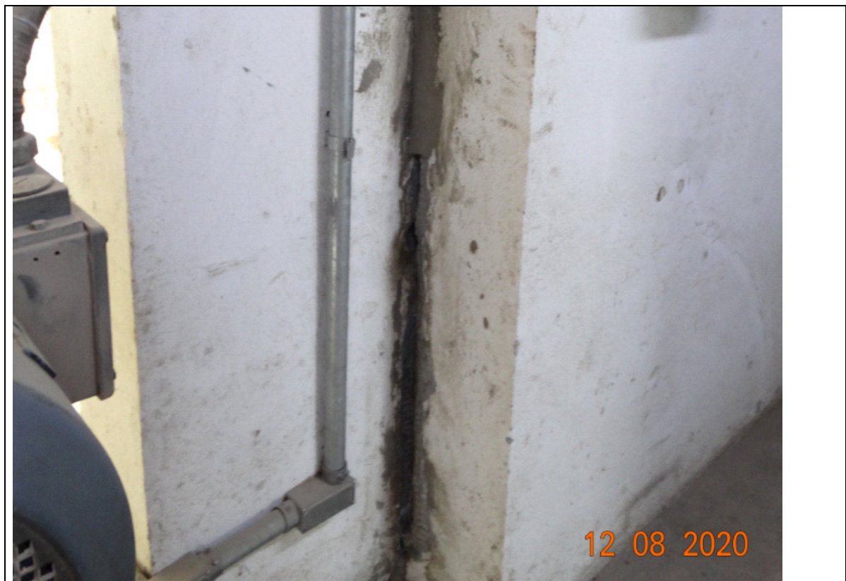
FOTO 248 – MEGASILO: DETALHE DA FOTO ANTERIOR: PREENCHIMENTO DE JUNTA DE DILATAÇÃO DE FORMA INCORRETA, COM MATERIAL RÍGIDO (ARGAMASSA CIMENTÍCIA). É NECESSÁRIO REMOVER ESSE MATERIAL E PREENCHER COM MATERIAL FLEXÍVEL, INDICADO EM PROJETO.
