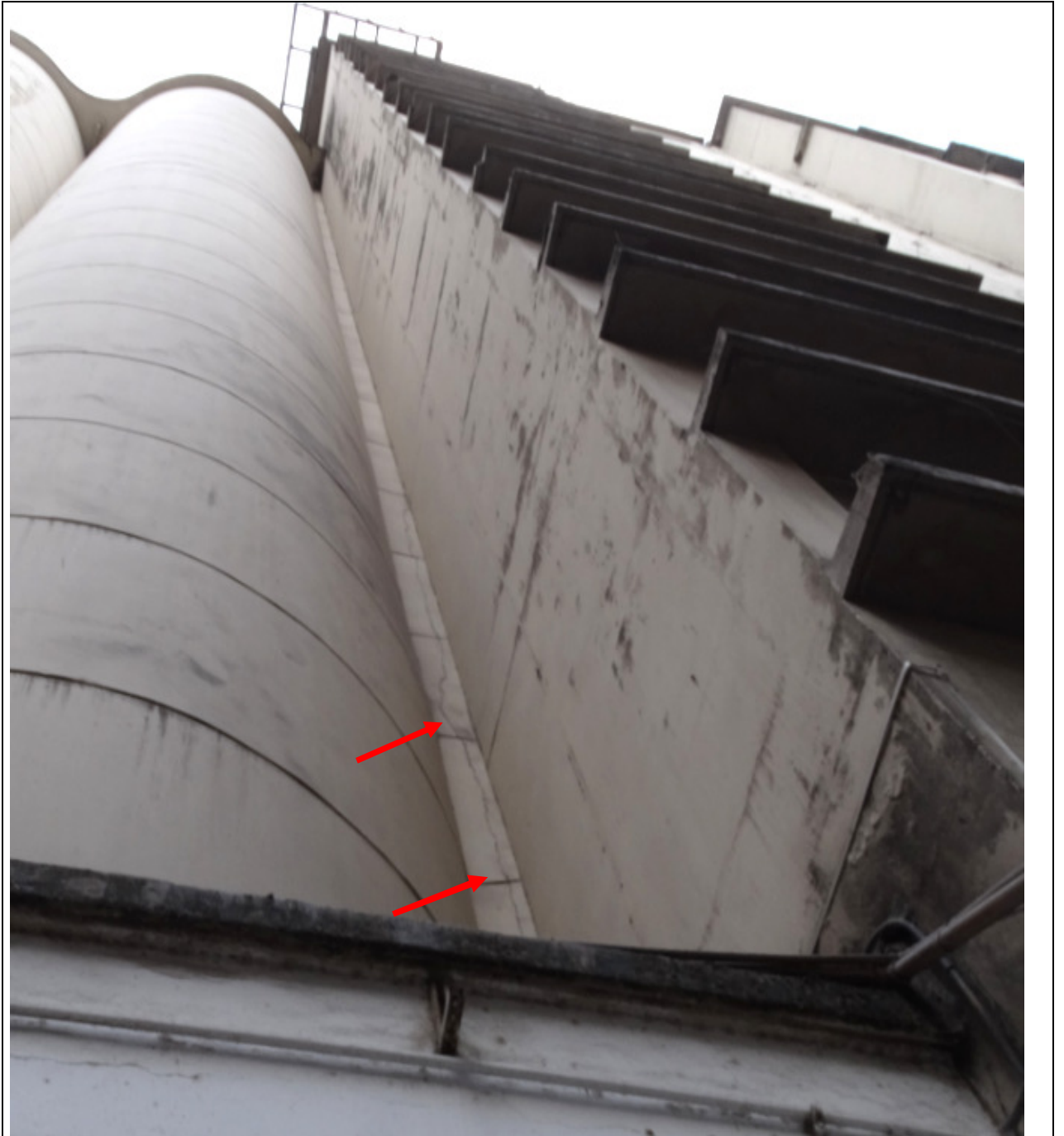
FOTO 127 – FACHADA DA MOAGEM B.
