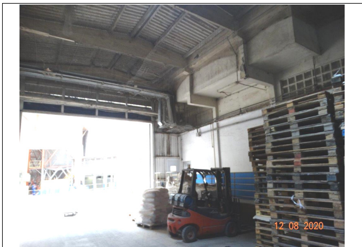
FOTO 175– COBERTURA ENTRE H1/H0.
