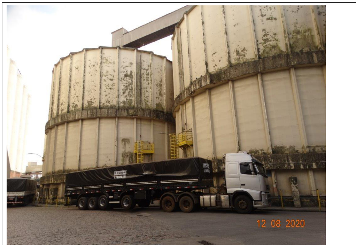
FOTO 201 – SILOS ZORTEA N° 04 (DIR.) e N° 05 (ESQ.).
