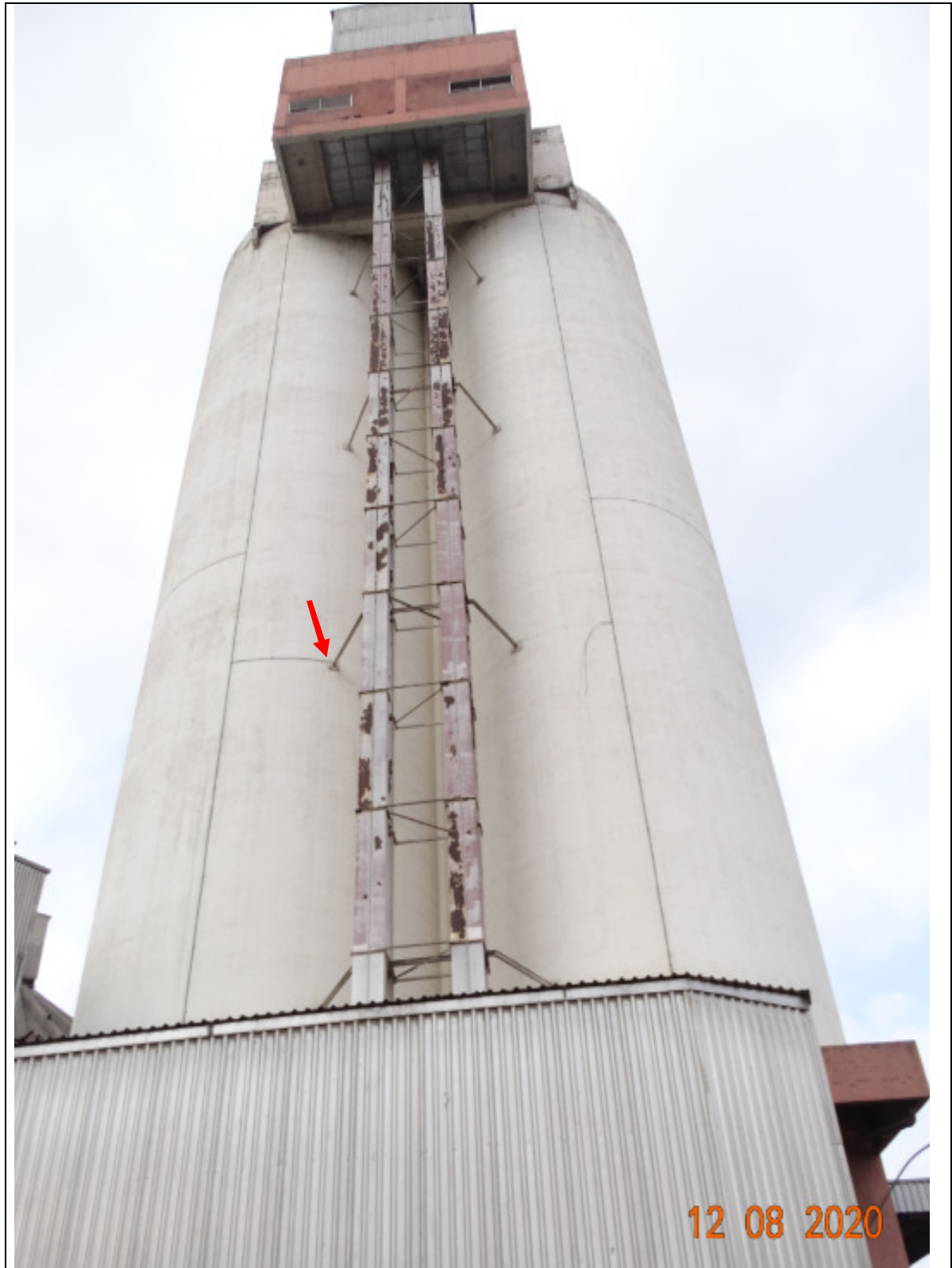
FOTO 232 - MEGASILO VISTA LATERAL PELA AVENIDA PORTUÁRIA.
