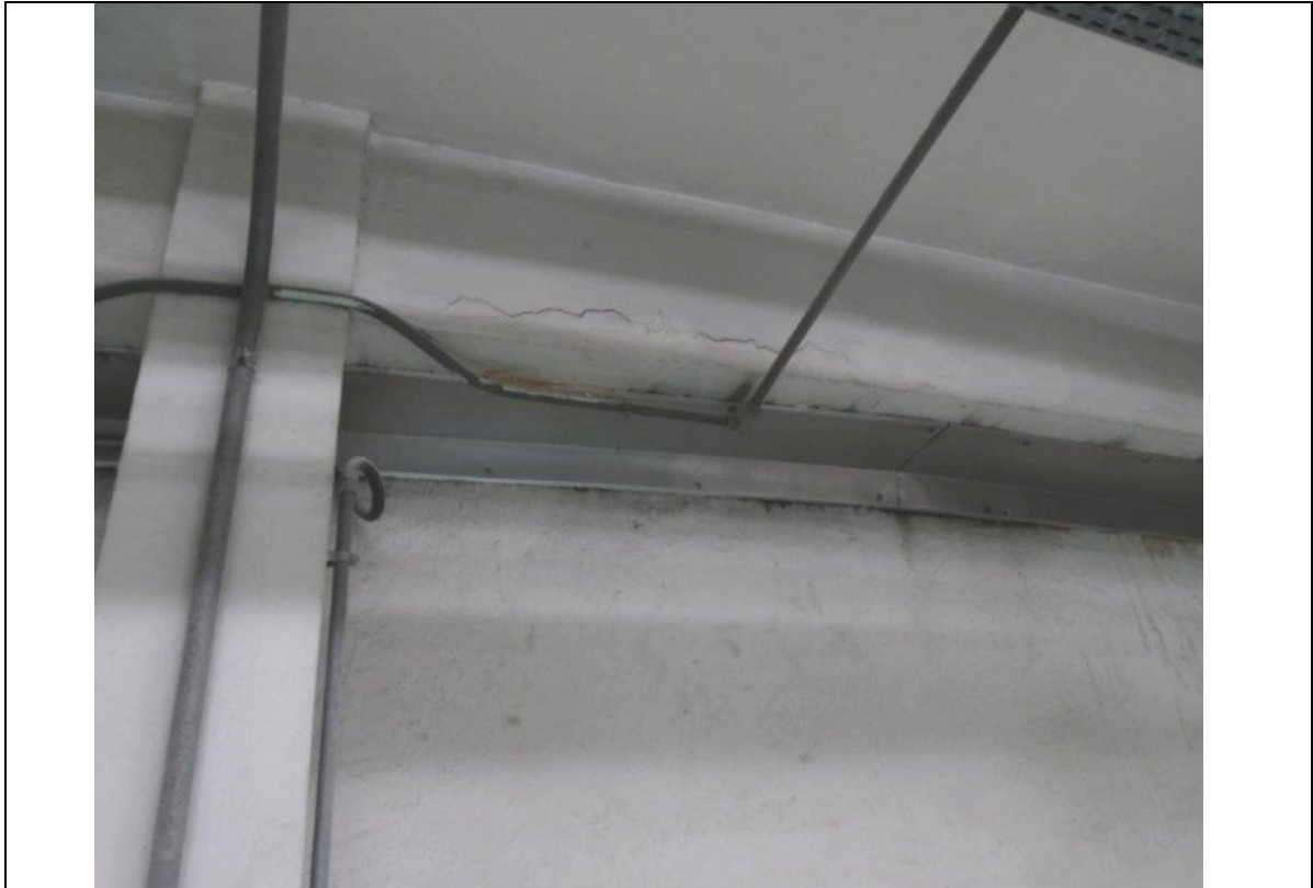
FOTO 107 – DETALHE DA FOTO ANTERIOR: TRINCA EXTENSA NO FUNDO DA VIGA.
