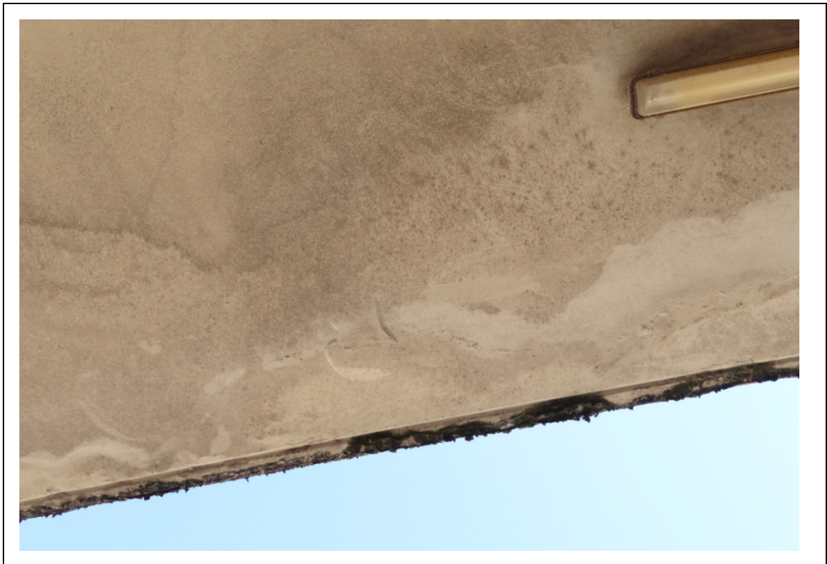
FOTO 137 – DETALHE DA FOTO ANTERIOR: TETO COM UM TRECHO COM ESTUFAMENTO DA ARGAMASSA.
