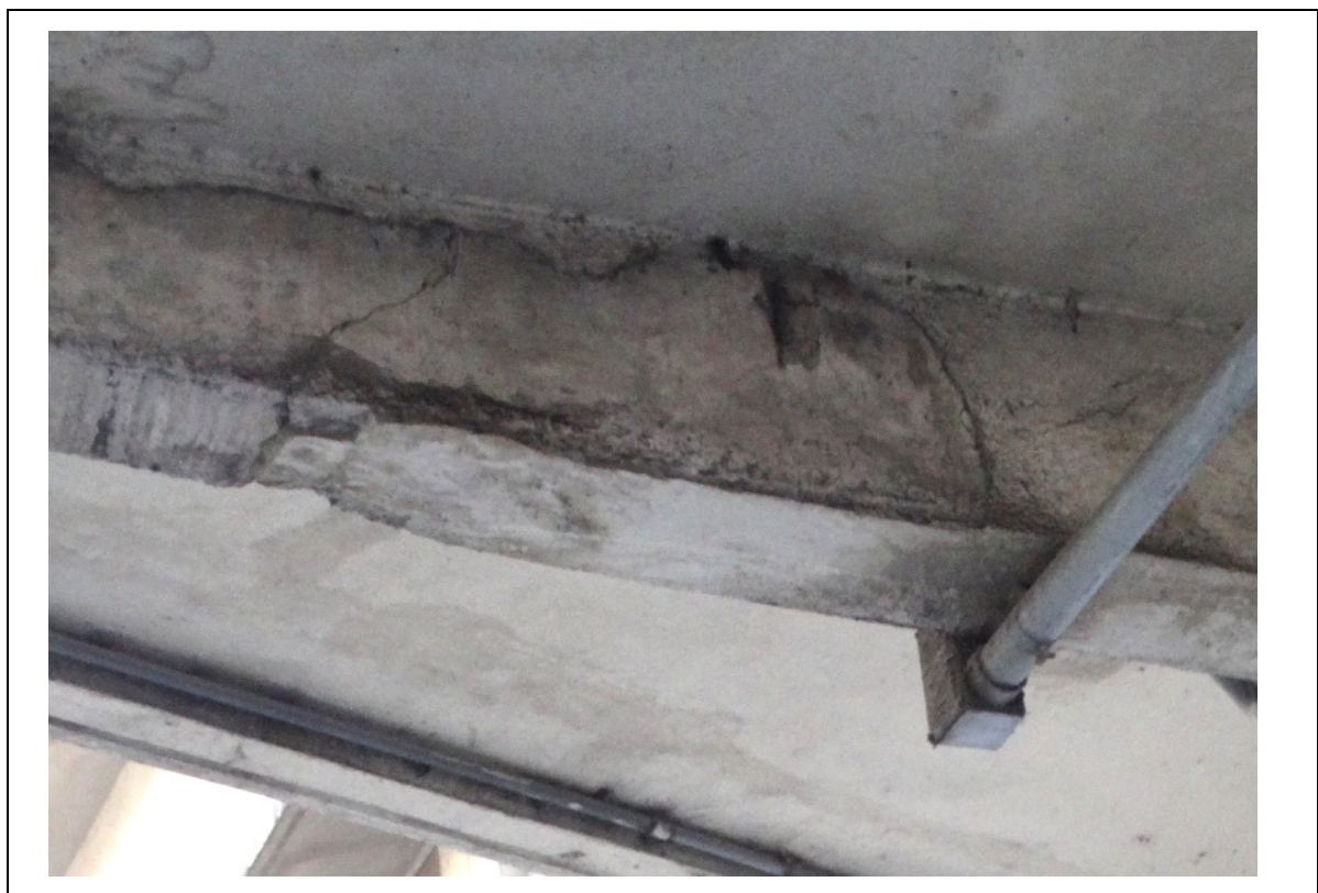
FOTO 83 - DETALHE DA FOTO ANTERIOR: VIGA DA EXTREMIDADE DA MESMA COBERTURA.
