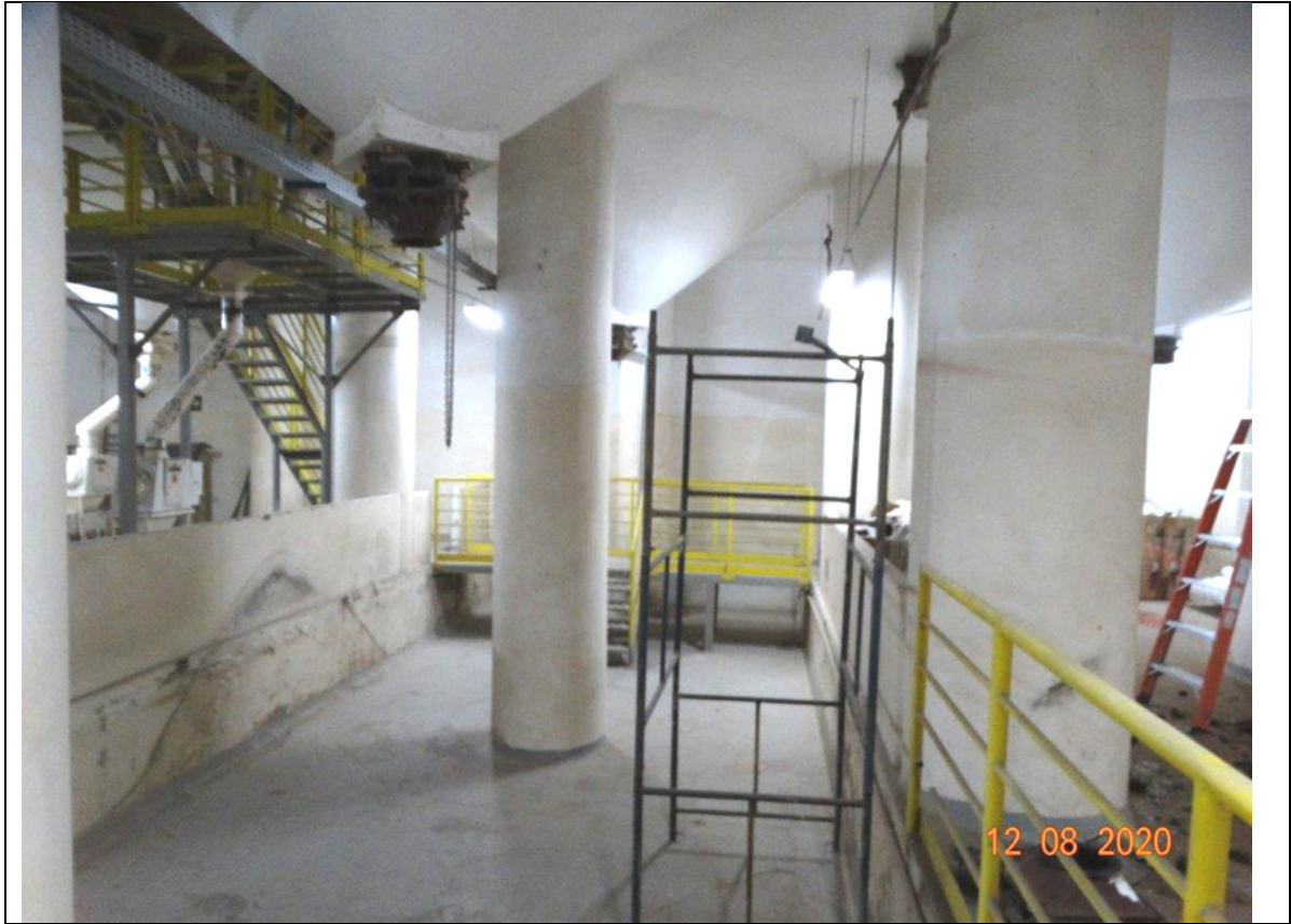
FOTO 94 – PORÃO - MOAGEM A.
