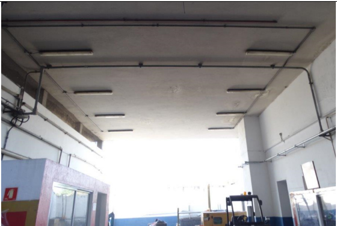
FOTO 12 – COBERTURA ENTRADA PRÉDIO DA ADMINISTRAÇÃO.
