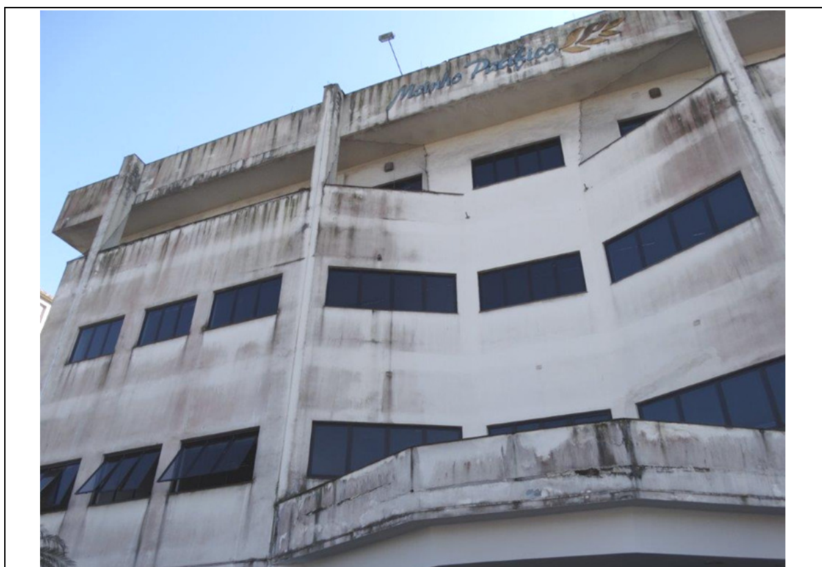
FOTO 24 – FACHADA PRÉDIO DA ADM.
