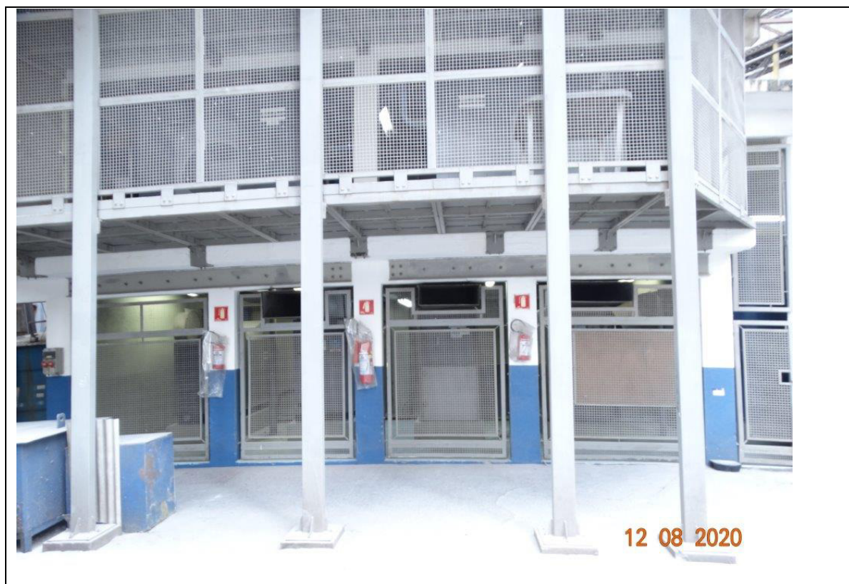
FOTO 215 – SALA DE COMPRESSOR.
