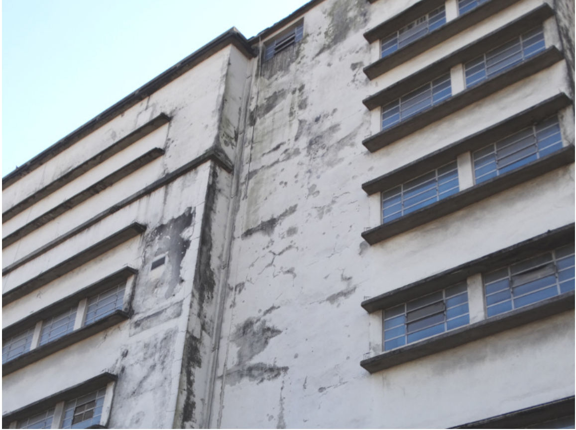
FOTO 90 – VISTA DE UMA DAS FACES DO PRÉDIO DA MOAGEM A.
