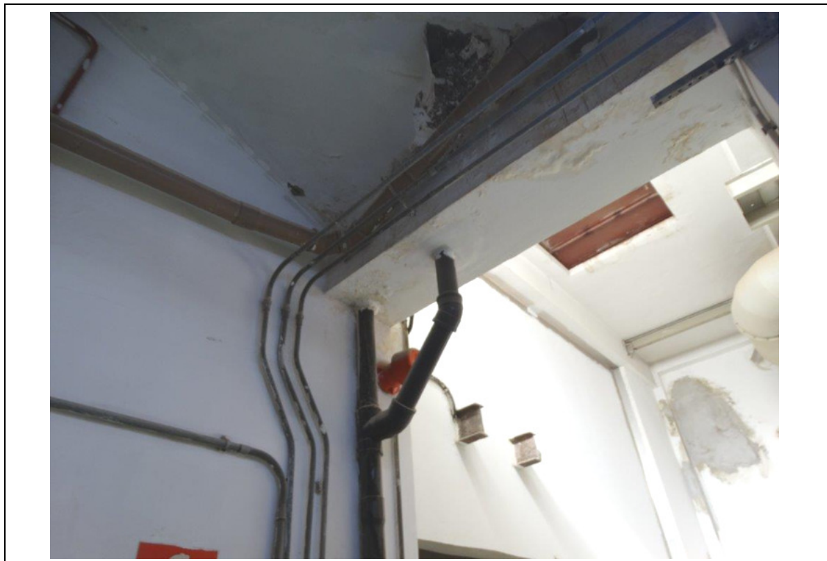
FOTO 58 – MOAGEM A - 7º ANDAR: CORROSÃO EM ARMADURA DA LAJE. LAJE.
