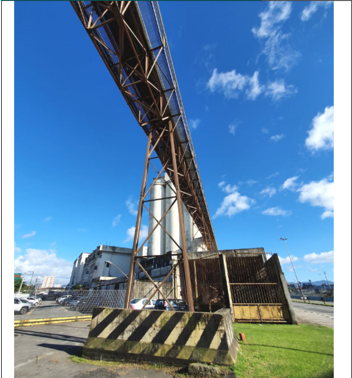
FOTO 299 - TORRE METÁLICA, PARTE DO CONJUNTO DE TORRES PARA AS ESTEIRAS TRANSPORTADORAS DE CORREIA ENTRE O MOINHO PACÍFICO E A ÁREA PORTUÁRIA. ESTAS TORRES ELEVAM-SE SOBRE OS LOGRADOUROS PÚBLICOS, EM ÁREA DE INTENSA MOVIMENTAÇÃO DE VEÍCULOS E CAMINHÕES.
