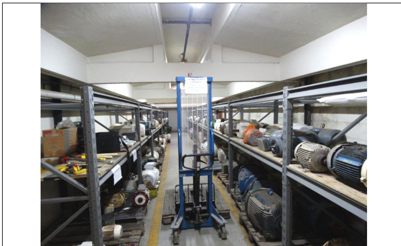
FOTO 06 – SALA DE BOMBAS.
