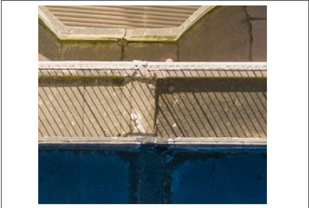
FOTO 272 – DETALHE DA FOTO ANTERIOR: NECESSÁRIO CHECAR "IN LOCO" A CONTINUIDADE E ALINHAMENTO DA JUNTA DE DILATAÇÃO PREVISTA EM PROJETO.
