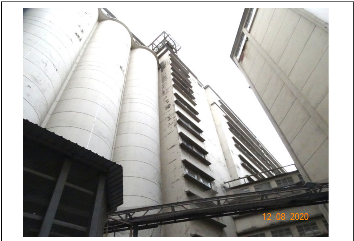
FOTO 118 – DETALHE DA PARTE SUPERIOR DA FOTO ANTERIOR: HÁ UM TRECHO DESTA PRÉDIO COM ELEMENTOS DE CONCRETO PARA FORA DA FACHADA, EM BALANÇO. É NECESSÁRIO INSPECIONAR SE HÁ ALGUM PONTO COM CORROSÃO, SOM CAVO OU PEÇA COM DESTACAMENTO DO CONCRETO, TRATANDO ADEQUADAMENTE.
