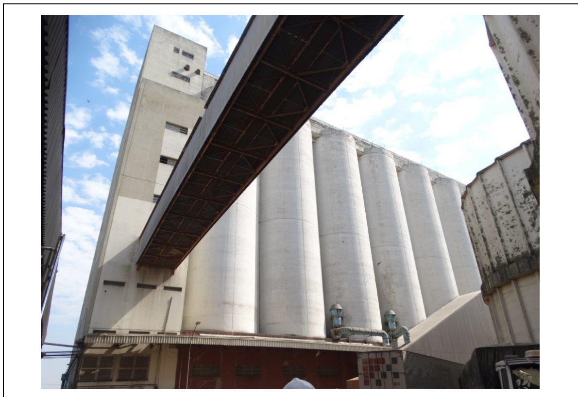
FOTO 206 – CORREIA TRANSPORTADORA ENTRE MEGASILO E SILOS ZORTEA.
