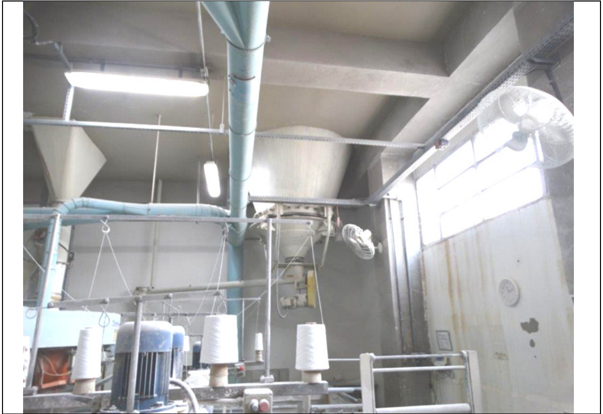
FOTO 170 – PRÉDIO H1: 2º ANDAR.
