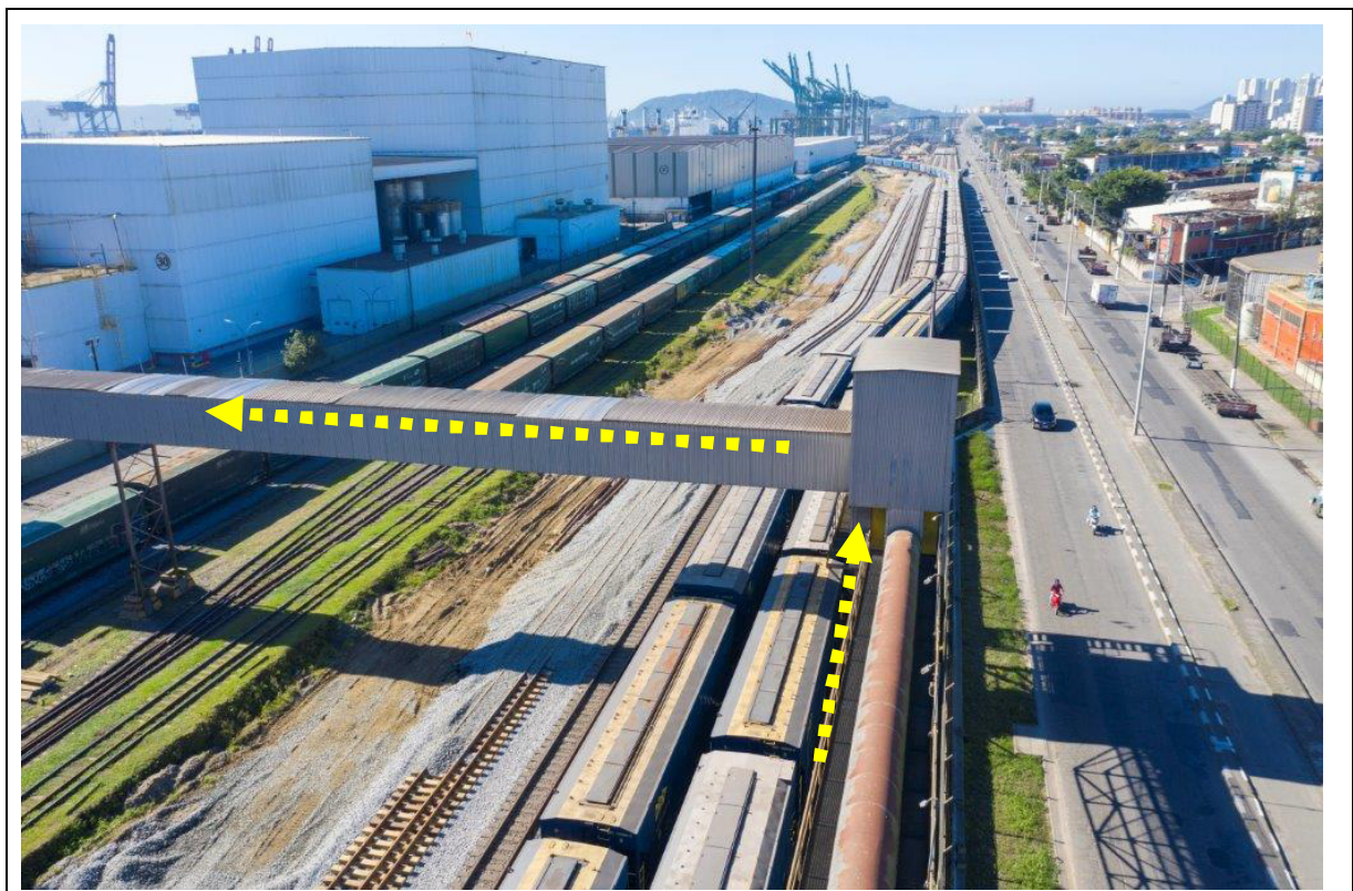
FOTO 298 – TRECHO DE CORREIA TRANSPORTADORA SOBRE O LOGRADOURO PÚBLICO ATRAVESSANDO A ALINHA FÉRREA ATÉ A ÁREA PORTUÁRIA .
