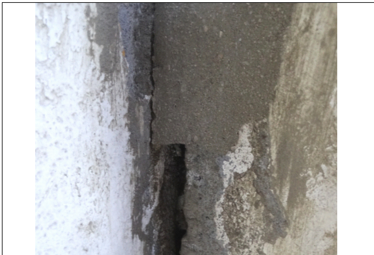
FOTO 249 – DETALHE DA FOTO ANTERIOR: PREENCHIMENTO DE JUNTA DE DILATAÇÃO COM MATERIAL RÍGIDO.
