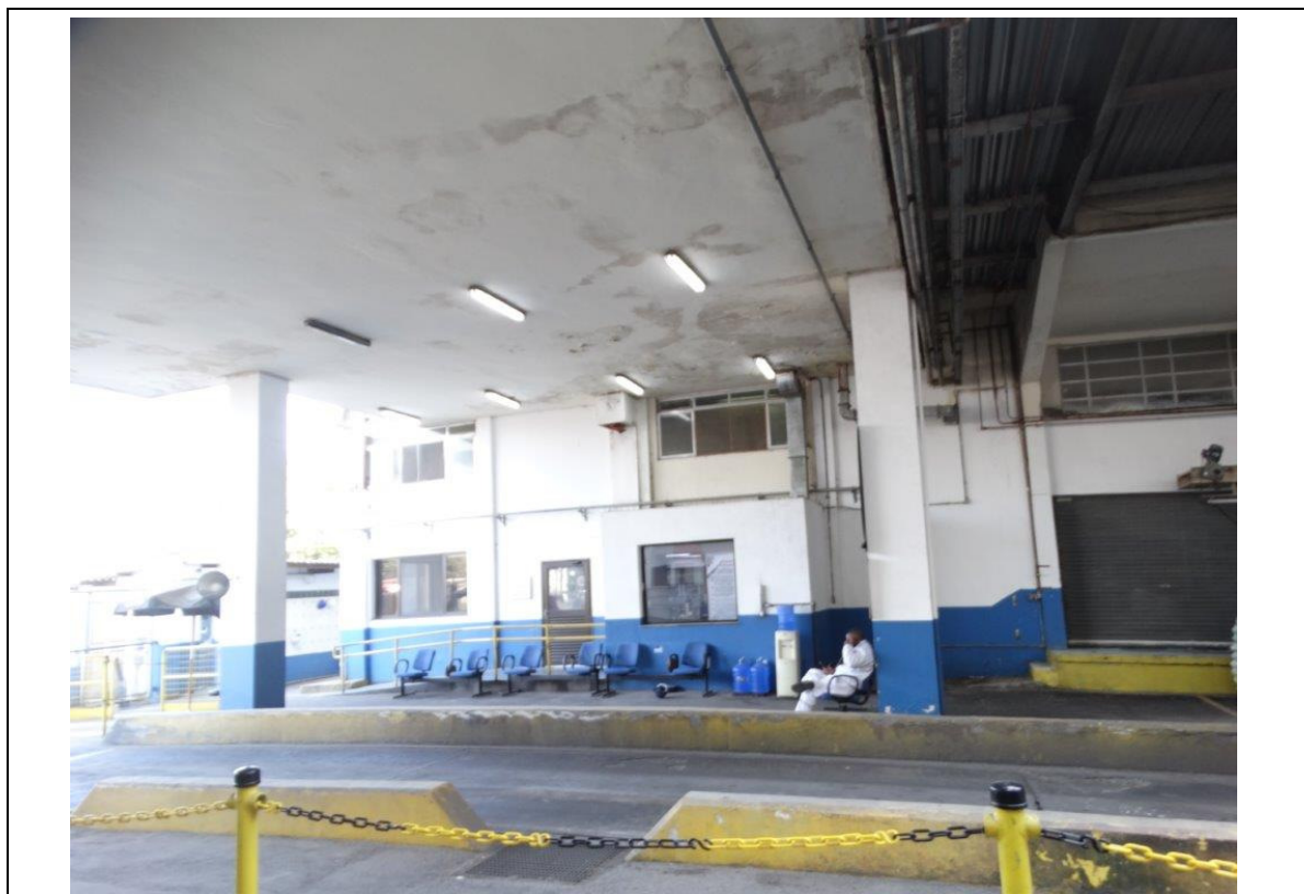
FOTO 30 – COBERTURA DA ENTRADA.
