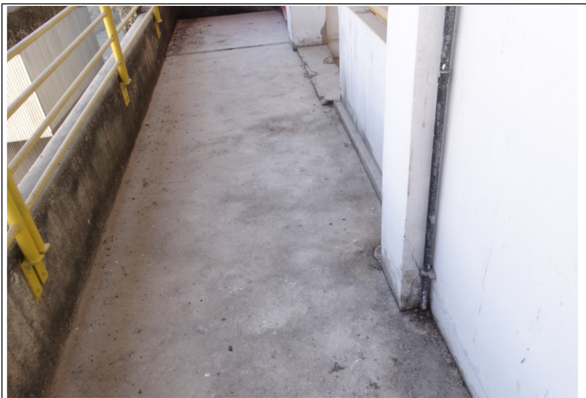
FOTO 141 – PRÉDIO H0 - SAÍDA DE EMERGÊNCIA 4º ANDAR.
