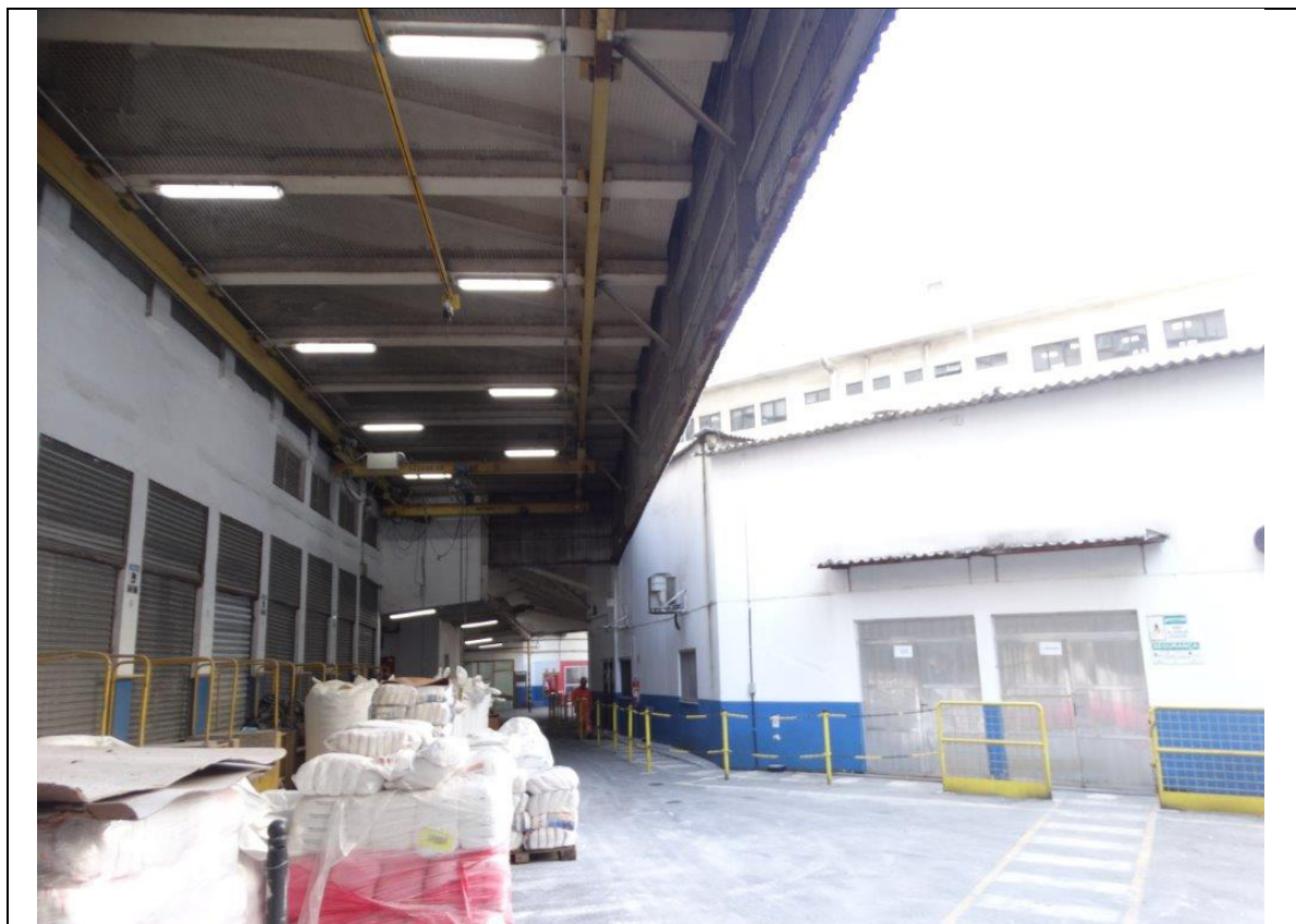
FOTO 76 – COBERTURA MOAGEM A.
