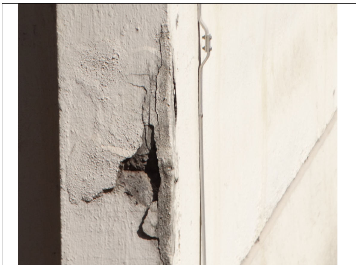
FOTO 151 – DETALHE DA FOTO ANTERIOR: INDÍCIO DE CORROSÃO DA ARMADURA.
