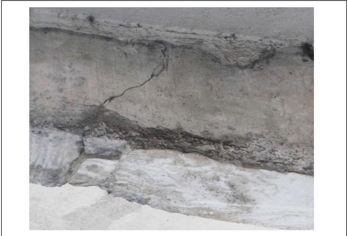
FOTO 84 – DETALHE DA FOTO ANTERIOR: TRINCA NA VIGA, NECESSÁRIA UMA INTERVENÇÃO IMEDIATA PARA RECUPERAR A INTEGRIDADE DO CONCRETO.
