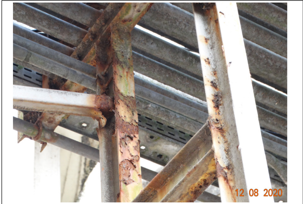
FOTO 243 – DETALHE DA FOTO ANTERIOR: CORROSÃO SUPERFICIAL EM DIVERSOS TRECHOS DA ESTRUTURA METÁLICA.
