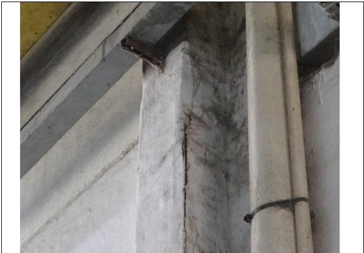
FOTO 180 – DETALHE DA FOTO ANTERIOR: INDÍCIO DE CORROSÃO DA ARMADURA DO PILAR. NECESSÁRIO UMA INSPEÇÃO INVASIVA, CASO EXISTA CORROSÃO TRATAR ADEQUADAMENTE.
