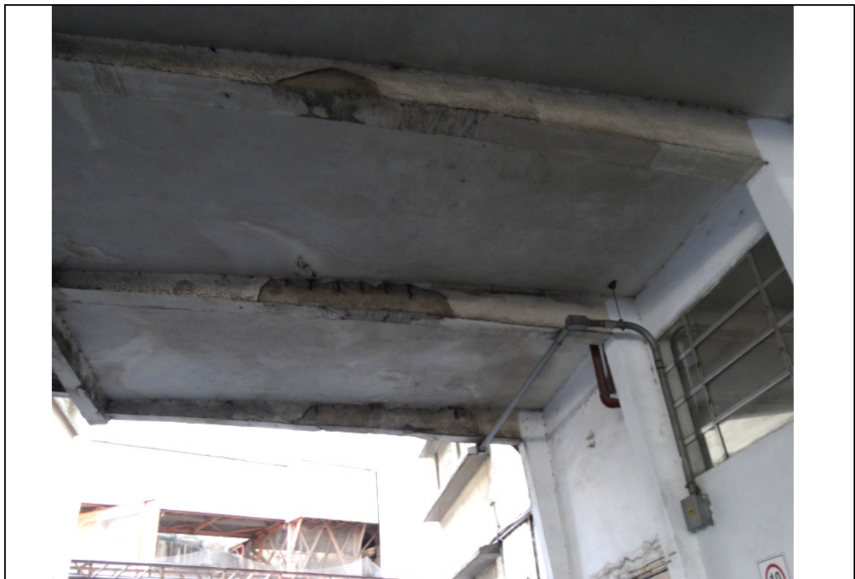
FOTO 81 – COBERTURA MOAGEM B.
