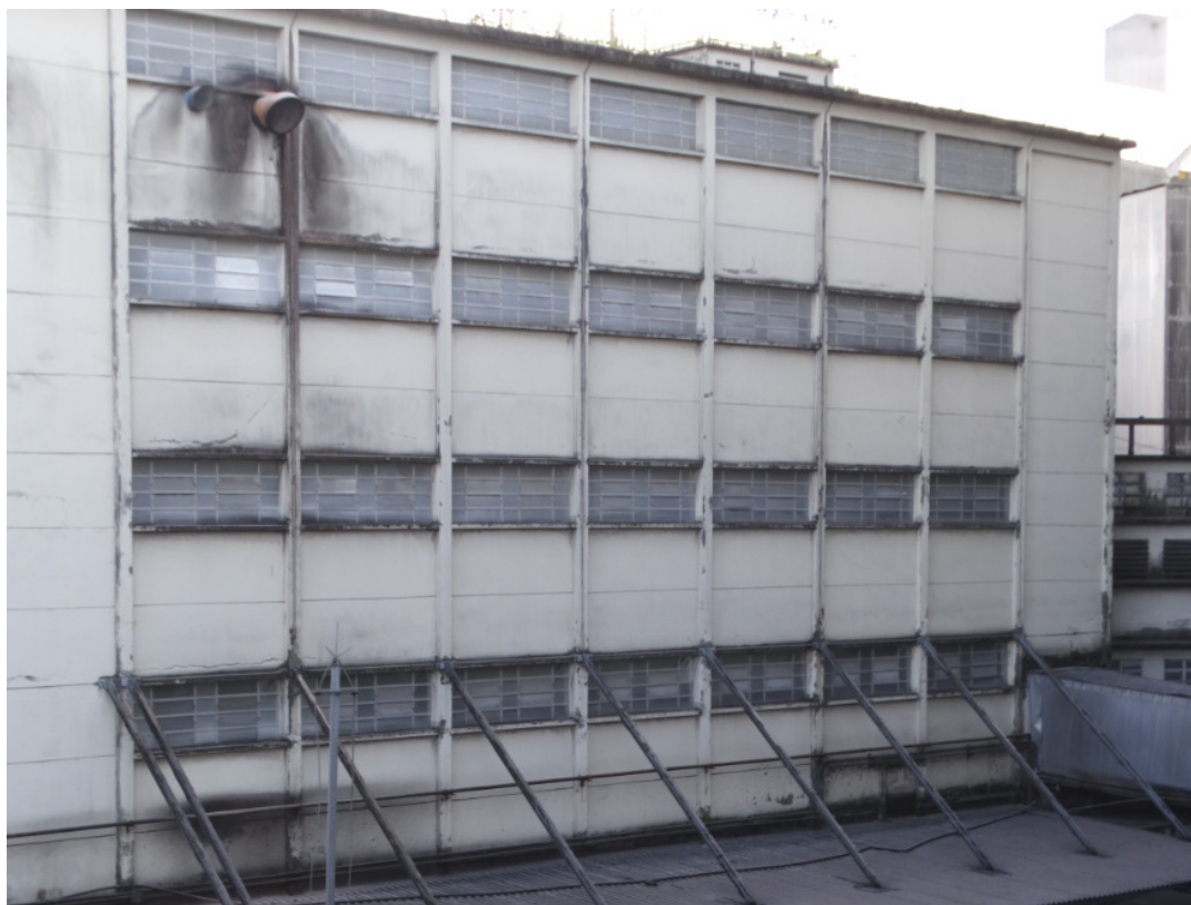
FOTO 162 – FACE LATERAL DO PRÉDIO H0.
