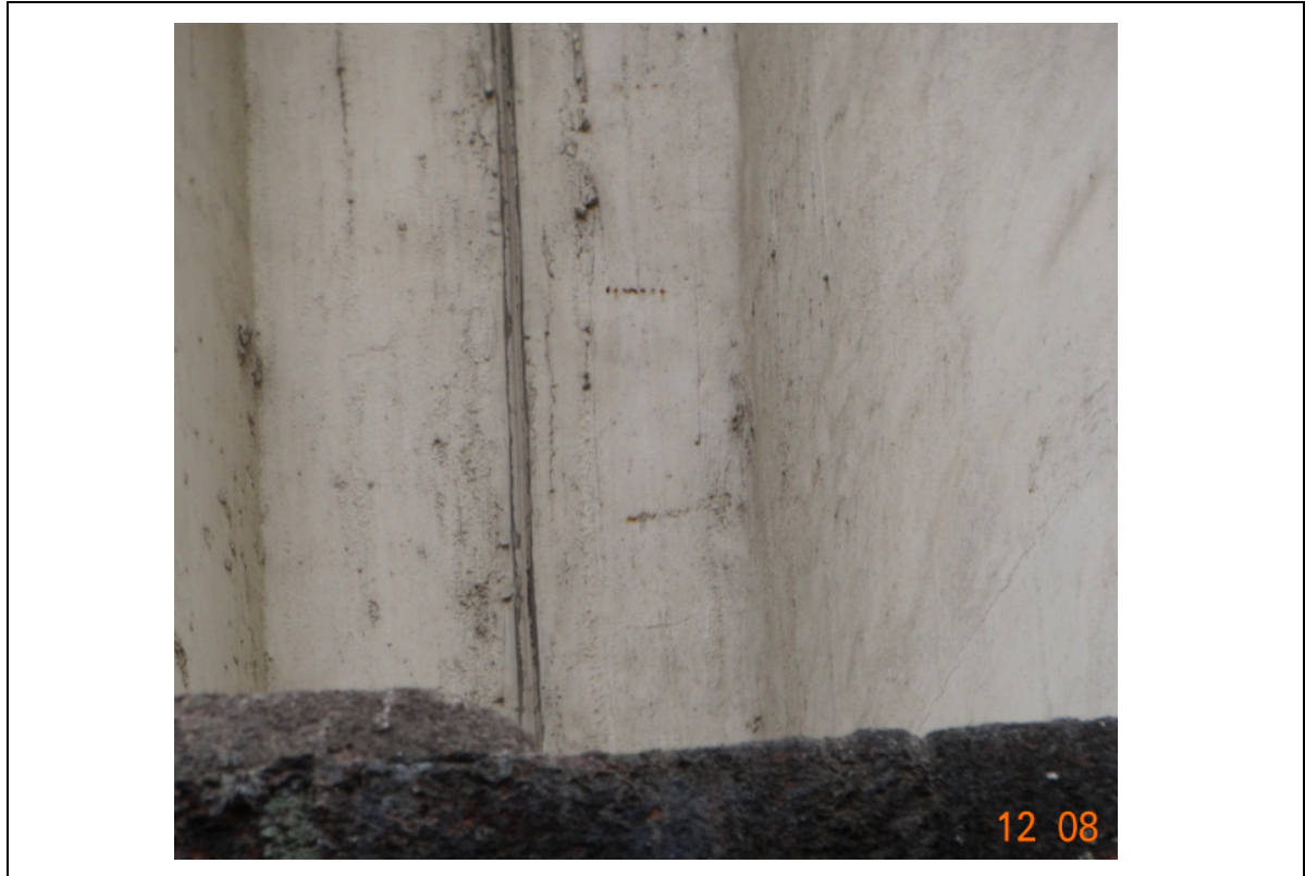
FOTO 222 – TRECHO DA JUNTA ESTRUTURAL NA PARTE INFERIOR DO MEGASILO (VIDE FOTO 218).
