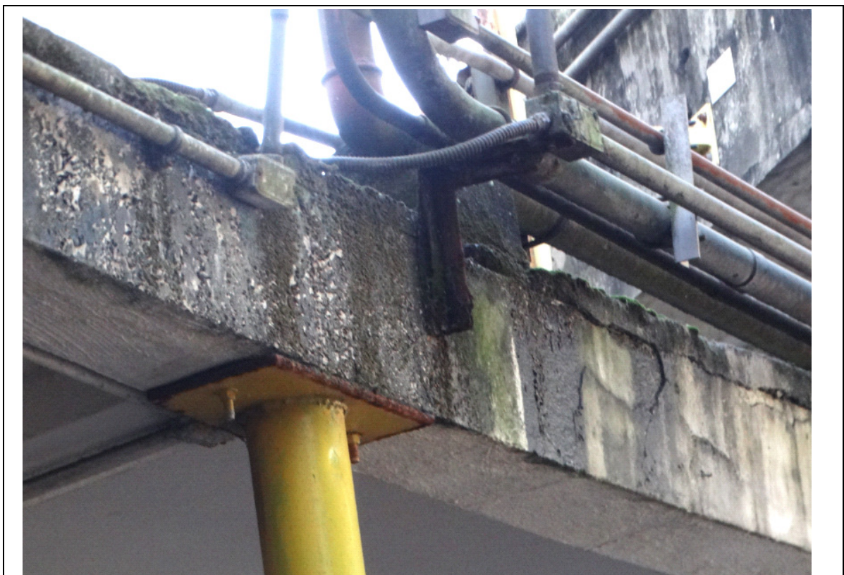
FOTO 44 - DETALHE DA FOTO ANTERIOR: NECESSÁRIO ELIMINAR INFILTRAÇÃO, SUJIDADE, FUNGOS E LIMO SOBRE O CONCRETO.
