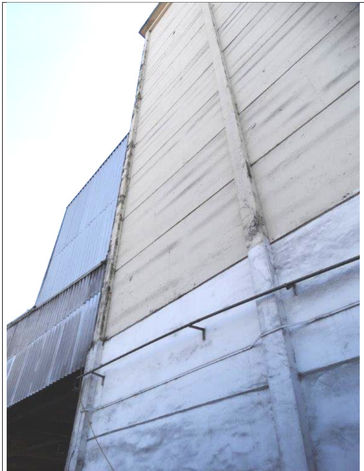
FOTO 187 – FACHADA PRÉDIO H1.
