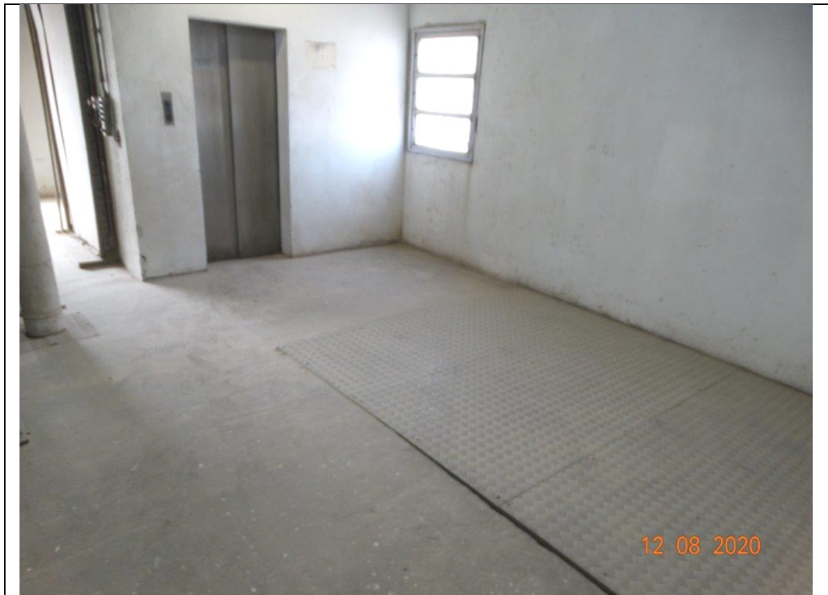
FOTO 252 – MEGASILO: 6º ANDAR.
