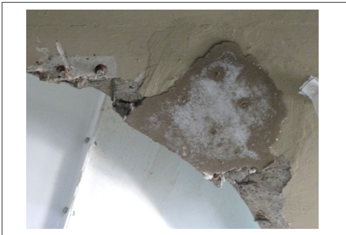
FOTO 172 – DETALHE DA FOTO ANTERIOR: TRECHO DE LAJE ABERTA SEM ARREMATE.
