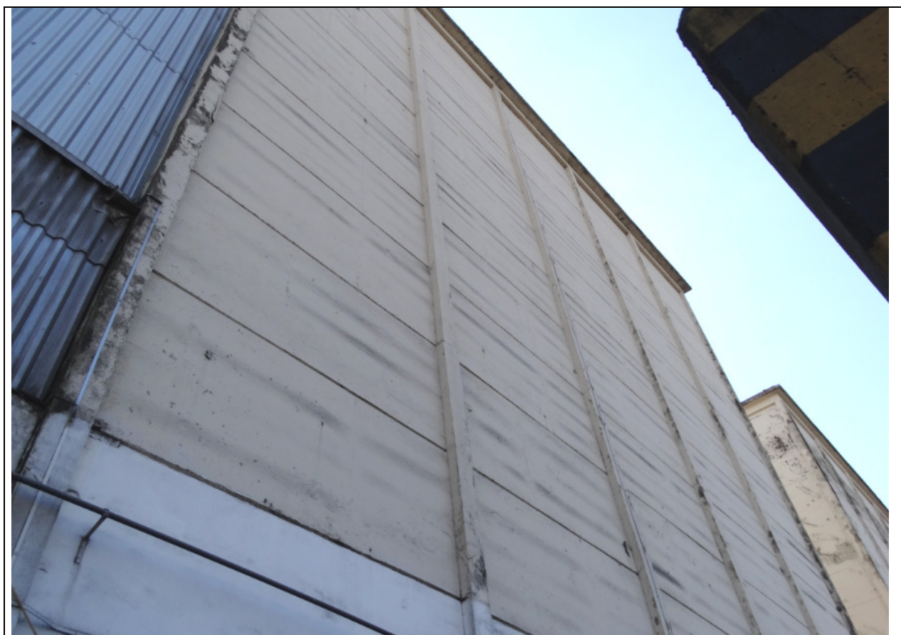
FOTO 186 – FACHADA PRÉDIO H1.
