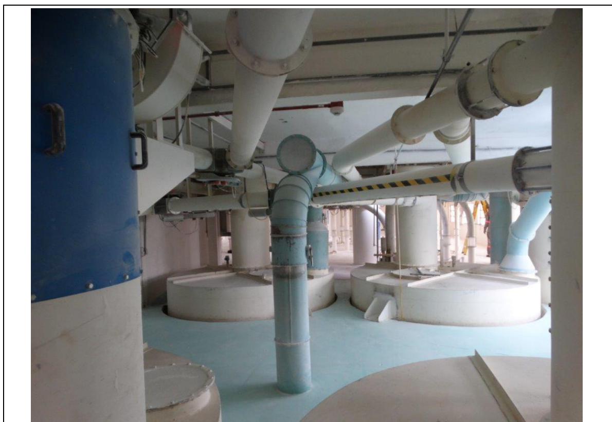
FOTO 167 – PRÉDIO H1: 4º ANDAR.
