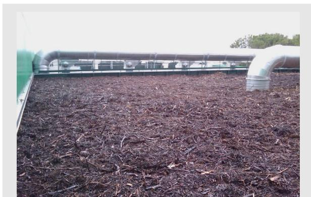
Foto 7: Camada de cavaco dos Biofiltros.
