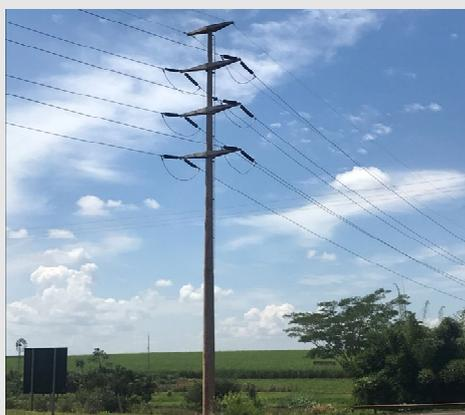
Foto 9: Exemplo de torre em concreto armado.
