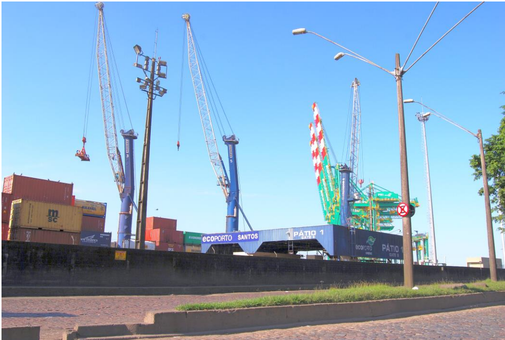
Foto 17 – Avenida Engenheiro Antonio Alves Freire, na altura Pátio1. O entorno todo é compatível com o uso da Ultragas, não havendo choques ou impactos decorrentes da atividade desenvolvida.
