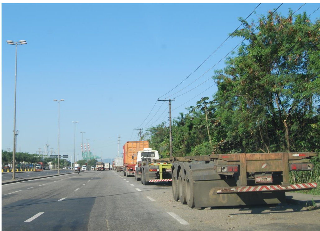
Foto 16 – Avenida Engenheiro Antonio Alves Freire, na altura do novo acesso.
