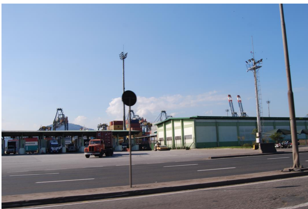
Foto 14 – Avenida Engenheiro Antonio Alves Freire, lado oposto de onde será construído o novo acesso.
