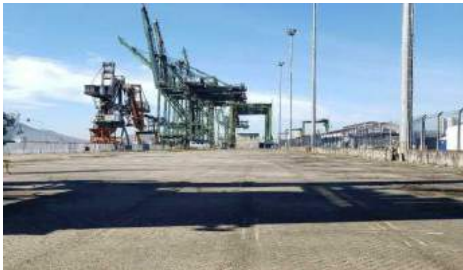
Figura 33 – Visão geral da área do STS-14 com piso em pavimento articulado de blocos concreto.
