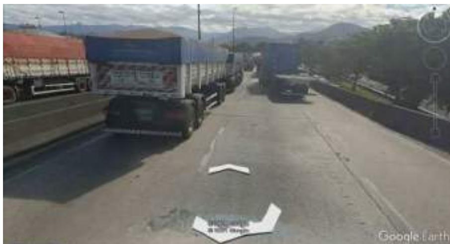
Figura 45 – Viaduto da Alemoa (sentido Porto).
