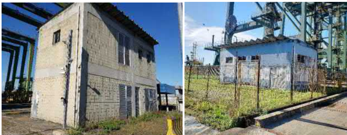
Figura 34 – Visão das duas subestações existentes na área do STS-14, sendo uma do arrendatário e outra do Porto (SPA).
