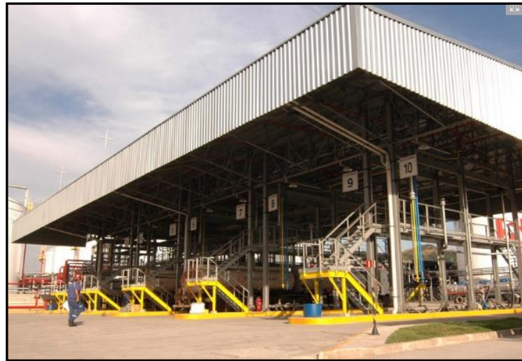
Figura 2-6: Plataforma de Carga e Descarga – Área II
