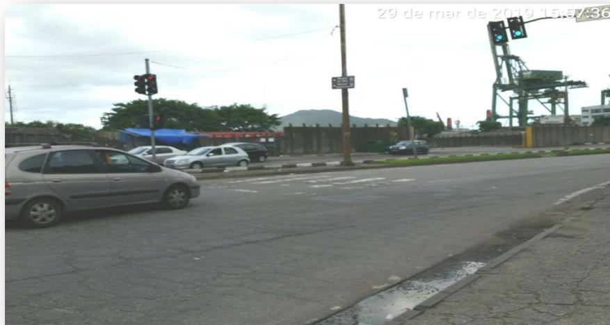
**Figura 47** – Av. Gov. Mário Covas Jr., na posição de entrada do Portão 18, travessia de pedestres com controle semafórico do trânsito. A pintura da faixa apresenta-se desgastada. Pavimento com trincas no revestimento.
