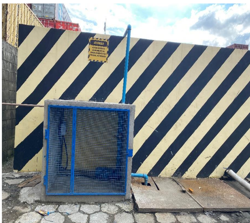
Foto 2.2.2-16: Sistema de bombeamento
