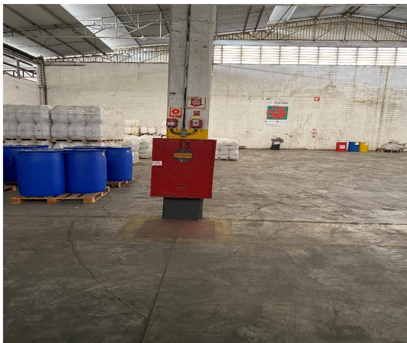
Foto 2.2.2-8: Alarme e mangueira para hidrante de combate a incêndio.
