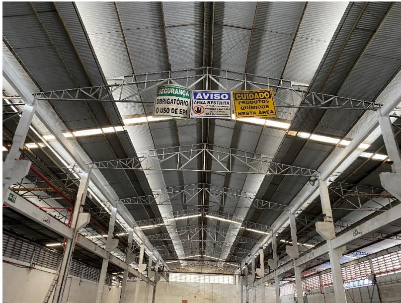
Foto 2.2.2-4: Armazém geral – área destinada a produtos químicos.
