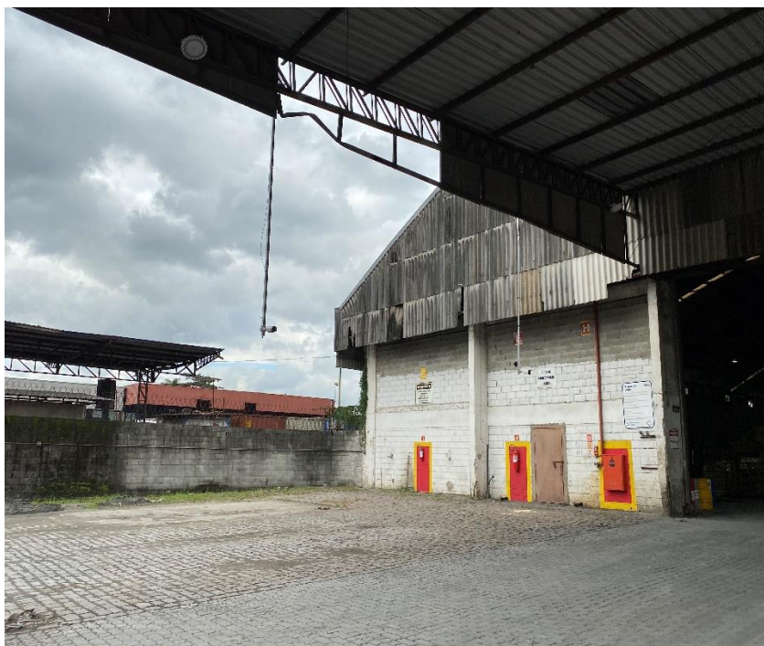
Foto 2.2.2-13: Extintores e hidrante para combate a incêndio - armazém REDEX.
