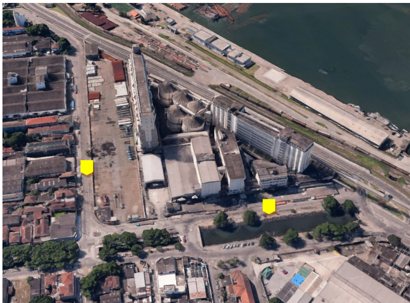
Figura 3 - Pontos de observação e contagem de veículos que circulam no local
