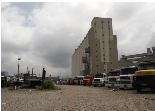
FOTO 08 – Área oeste Empresa vizinha ao empreendimento (INNT - Instituto Nacional dos Negócios de Transporte)
