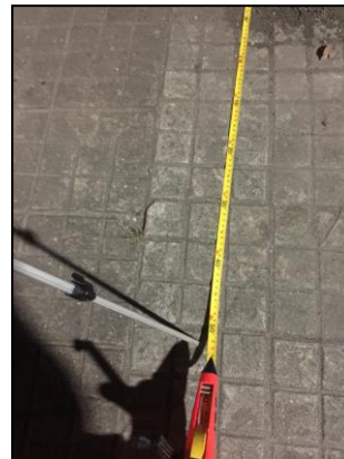
Distância da parede aprox. 2,50 metros
