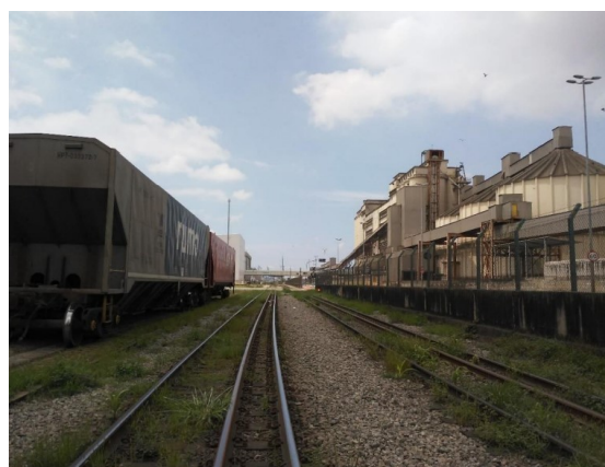
FOTO 05 – Área leste do empreendimento – Ferrovia
