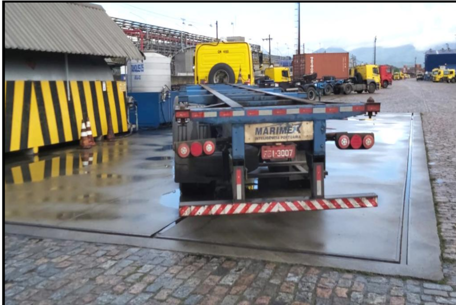
Figura 22 – Área de abastecimento de caminhões e máquinas, com canaletas no seu perímetro.
