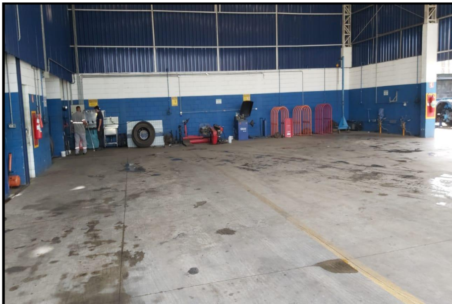
Figura 23 – Vista da borracharia e área de serviços gerais.
