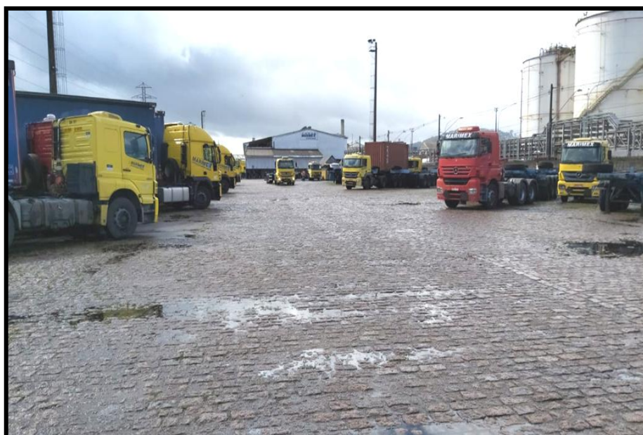
Figura 15 – Vista do pátio de veículos, sem formação de poças de água em dia chuvoso.
