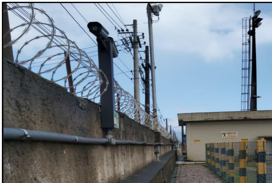
Figura 18 – Padrão do muro em alvenaria no perímetro do pátio de veículos.
