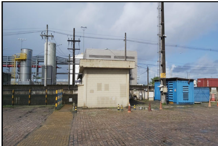
Figura 25 – Vista da subestação de energia elétrica, próxima ao muro da R. Dr. Albert Schweitzer.
