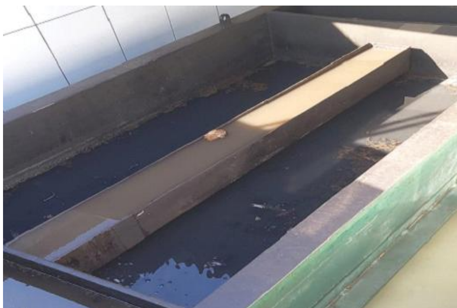
Figura 52 – Vista do separador óleo/água do lavador de veículos.
