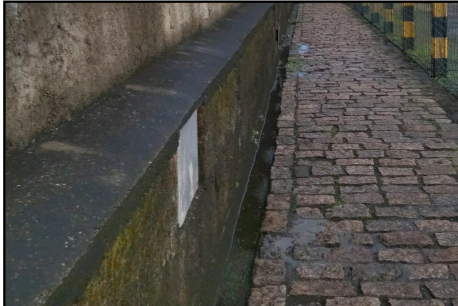
Figura 29 – Faixa de circulação de pedestres segregada, com calçamento em paralelepípedos de granito e sistema de coleta de águas pluviais.
