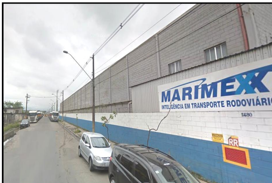
Figura 30 – Detalhe da iluminação pública na R. Dr. Albert Schweitzer defronte ao Empreendimento.
