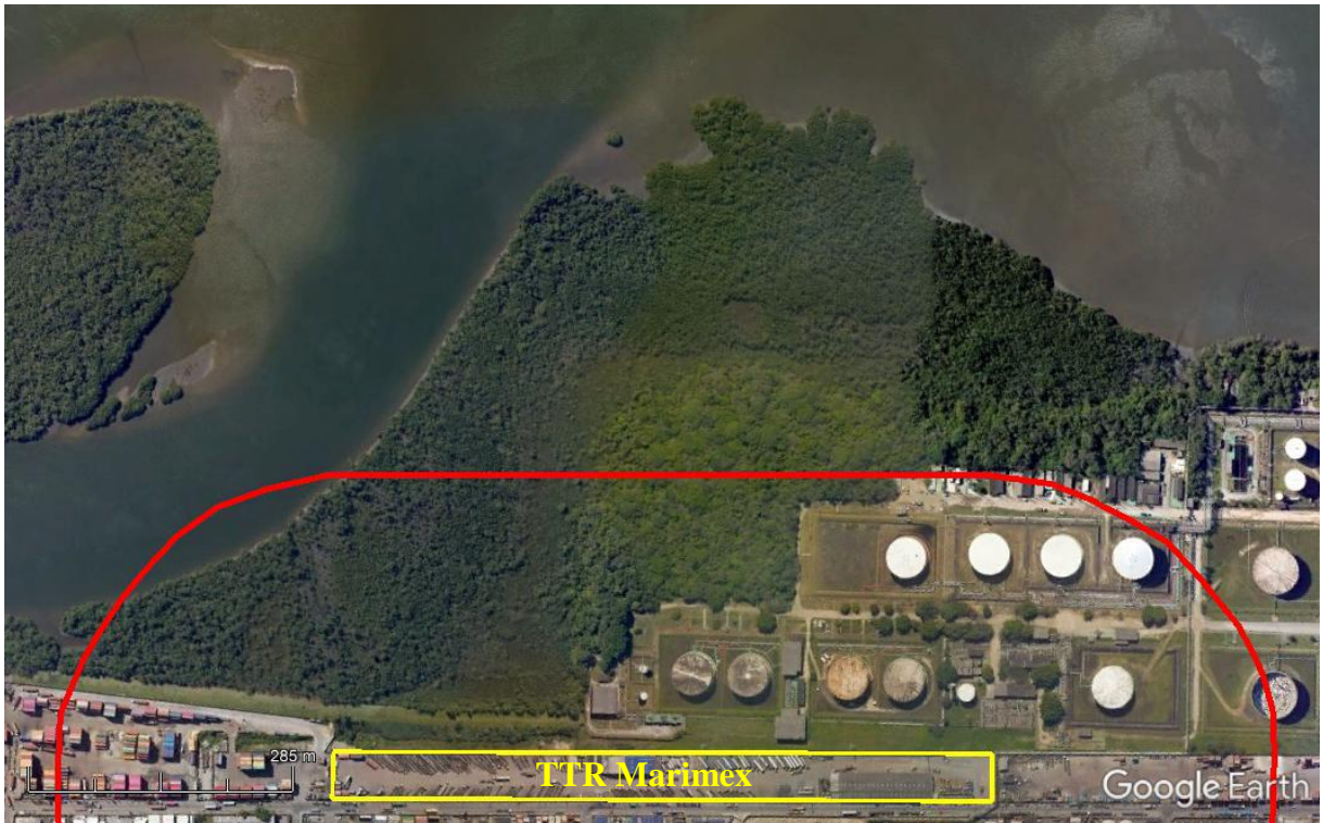
Figura 38 – Vista do Empreendimento na face Norte (AID parcial em vermelho), vizinho ao Terminal da Transpetro.
