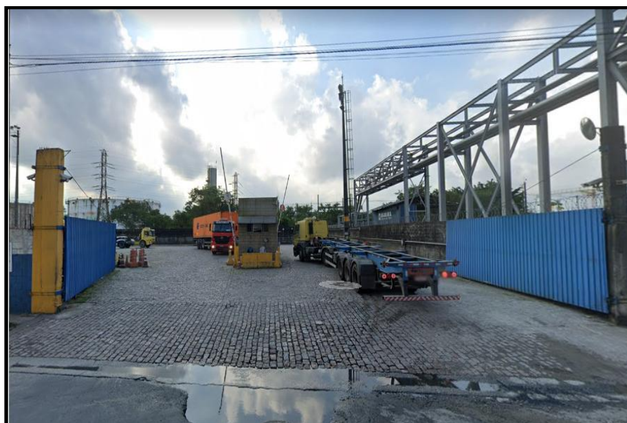
Figura 17 – Portaria operacional do Empreendimento para controle de acesso e saída.
