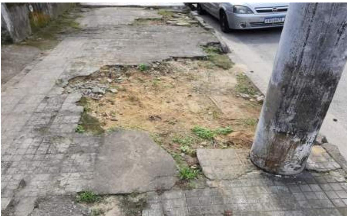
Figura 49 – Calçada danificada e inadequada ao trânsito de pedestres.
