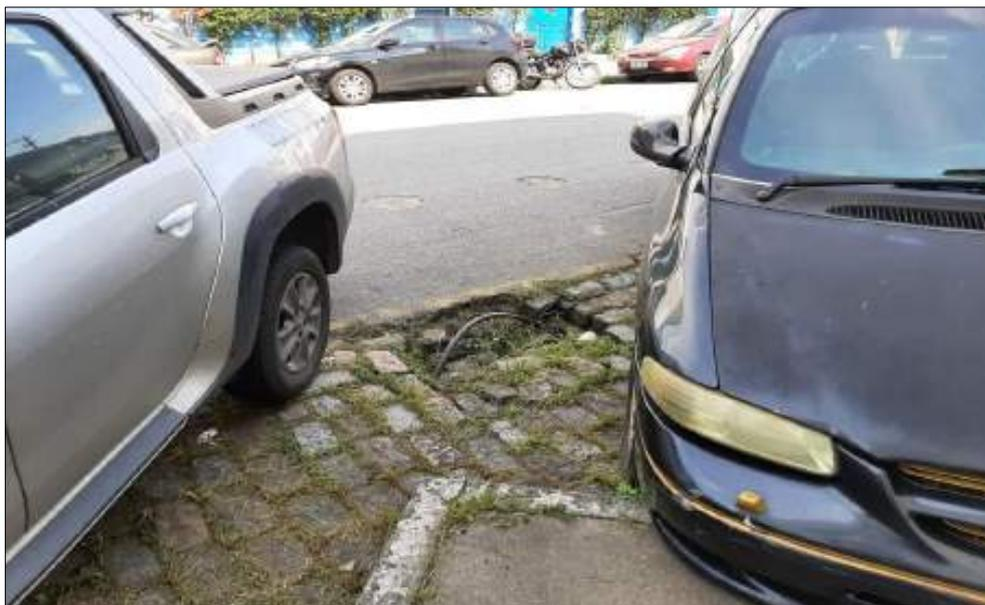
Figura 83 - Danos no piso asfáltico e no calçamento na faixa de estacionamento, com exposição de cabo.
