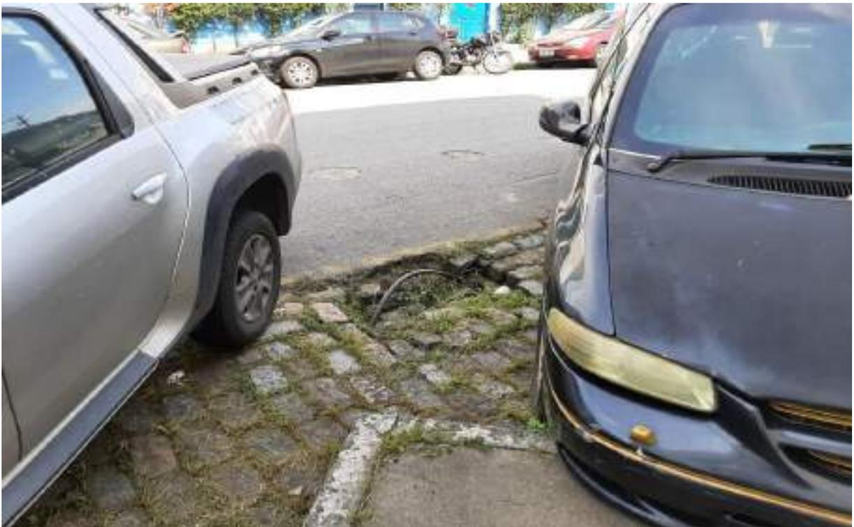
Figura 61 - Danos no piso asfáltico e no calçamento na faixa de estacionamento de veículos, com exposição de cabo.
