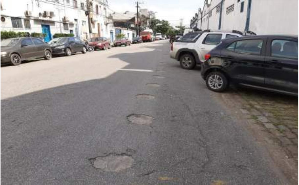
Figura 60 – Danos regulares e sucessivos de origem desconhecida no piso asfáltico.
