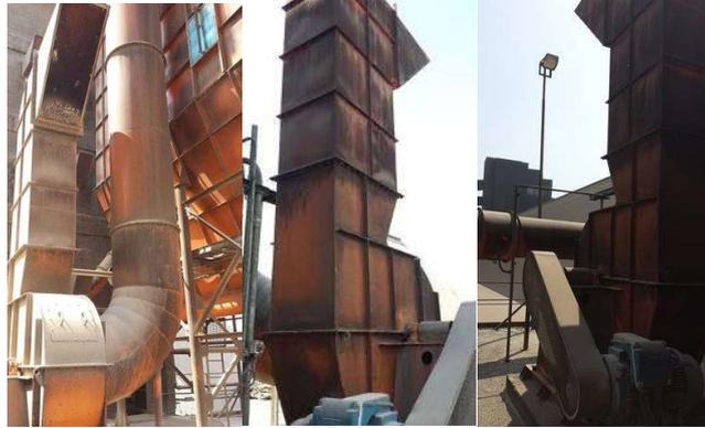
**Figura 7.9.1 - Moegas 1 e 2: dutos de saída dos SA1A, SA1B e SA2A.**
