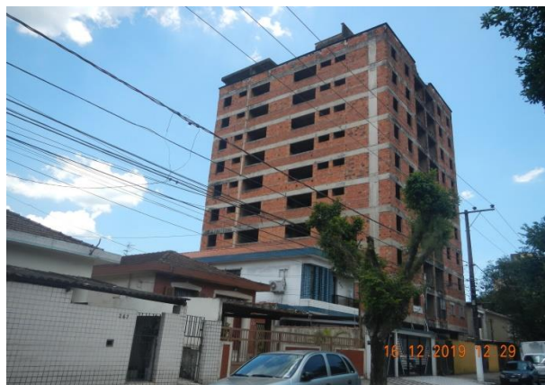
Foto VII.4-11 – Prédio em construção. Rua Liberdade
