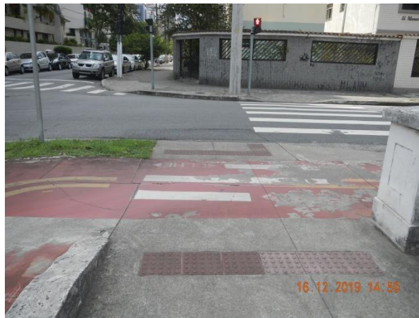
Foto VII.10-1 – Piso tátil e rampa na via pública (Rua Ministro João Mendes x Av. Almirante Cochrane)
