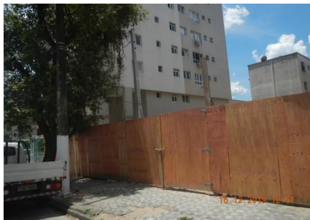
Foto VII.4-12 – Tapume de proteção para obra de prédio na Rua Liberdade
