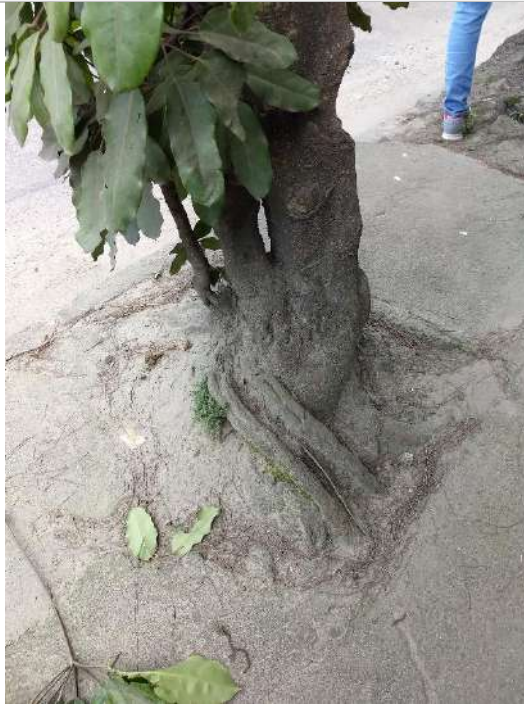
Raízes expostas danificando a calçada.
