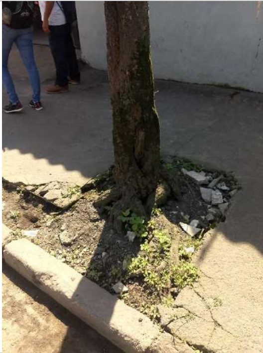
Cova: calçada danificada
