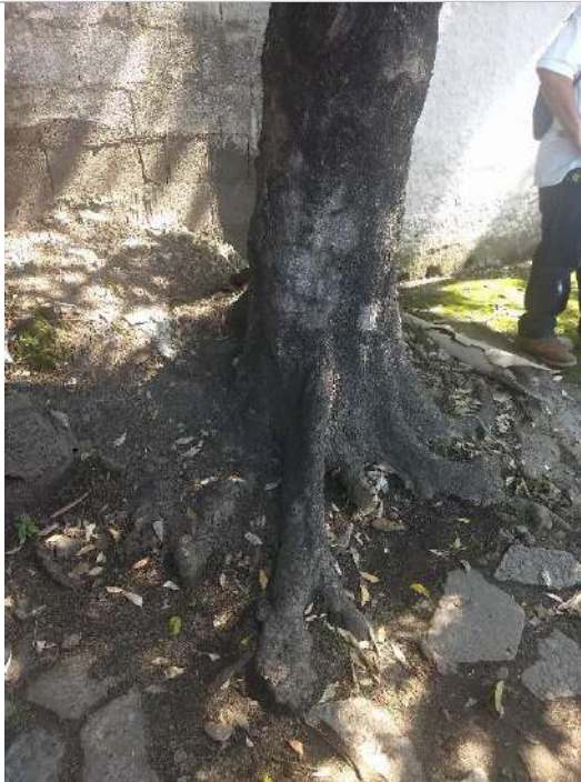
Raízes: expostas, danificando a calçada
