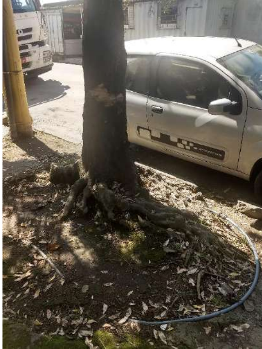
Raízes: danificando a calçada
