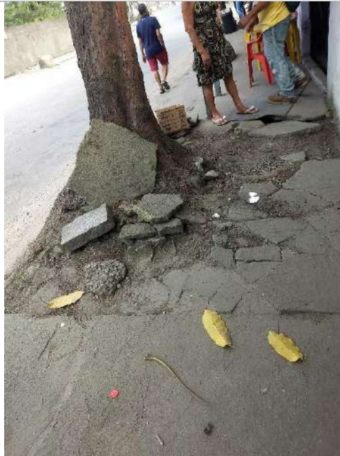
Raízes: danificando a calçada.
