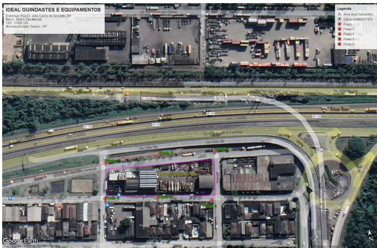
Figura 1: Instalação da IDEAL GUINDASTES E EQUIPAMENTOS – Fonte: Google Earth 2024.
