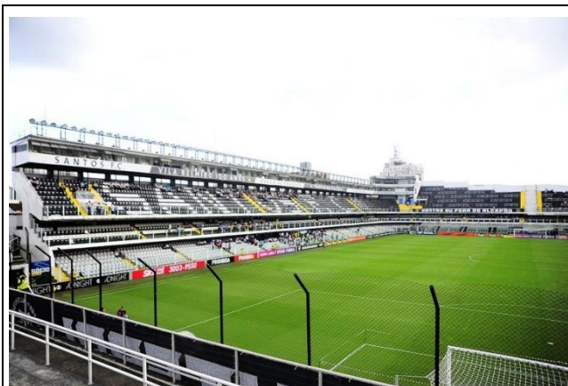
Foto 2.3-3: Vista interna do Estádio Urbano Caldeira
