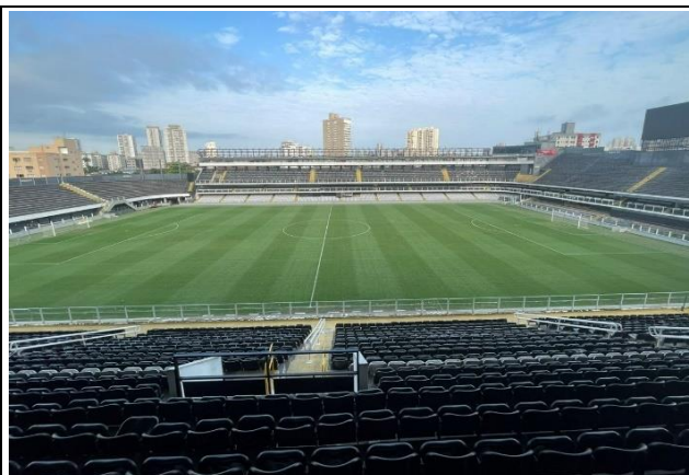
Foto 2.3-4: Vista interna do Estádio Urbano Caldeira
