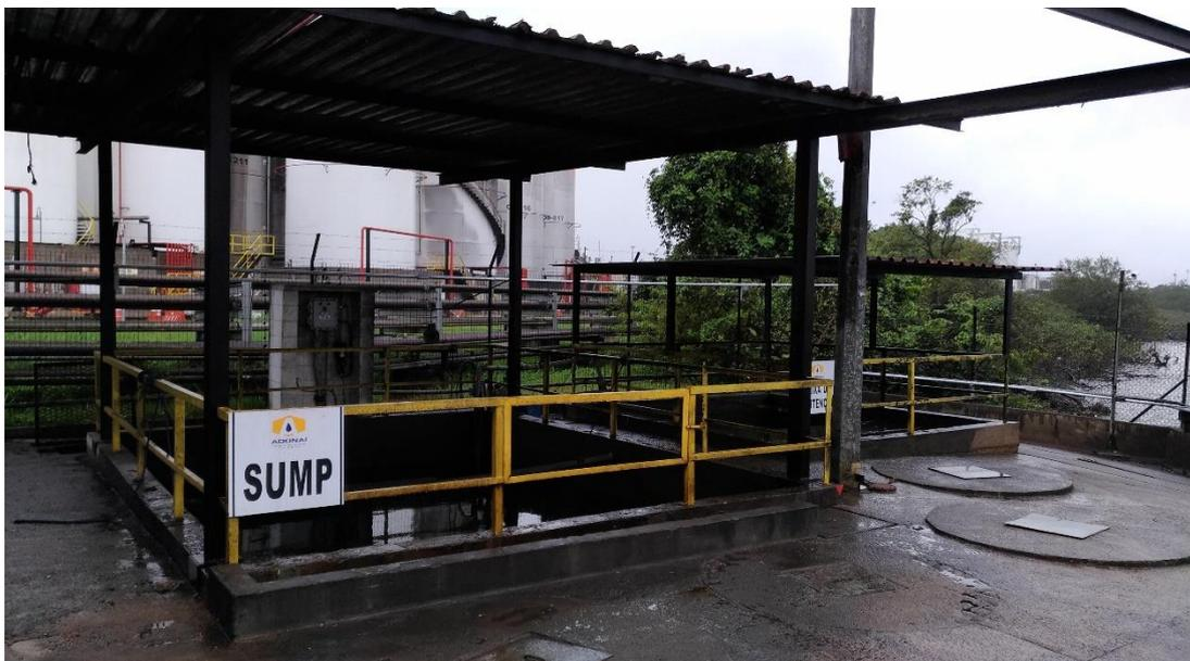
**Figura 2.2.2 - 1: Vista do SUMP existente no terminal, onde são tratadas as águas incidentes em todas as bacias do terminal**
