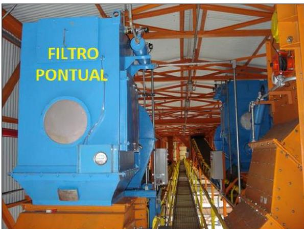
Figura 6.8.2 - 7: Exemplo de filtro pontual instalado.
