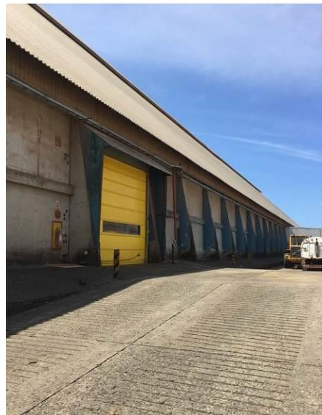
Figura 6.8.2 - 5: Silo horizontal XLI, Porta automática já implantada.
