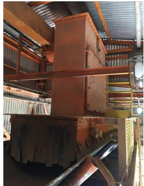
Figura 6.8.2 - 8: Filtro compacto já implantado nas linhas de transportadores do terminal.
