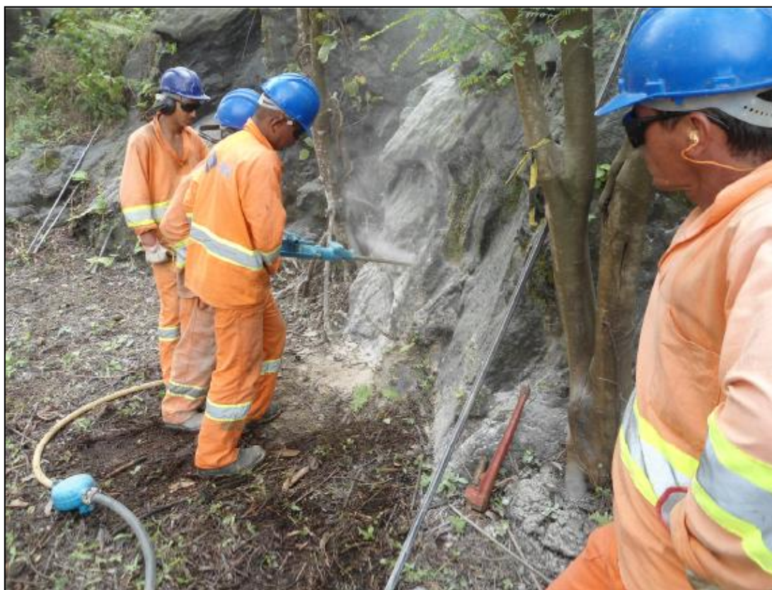
Imagem 16 - Perfuração no Setor F para posterior instalação de vergalhão
