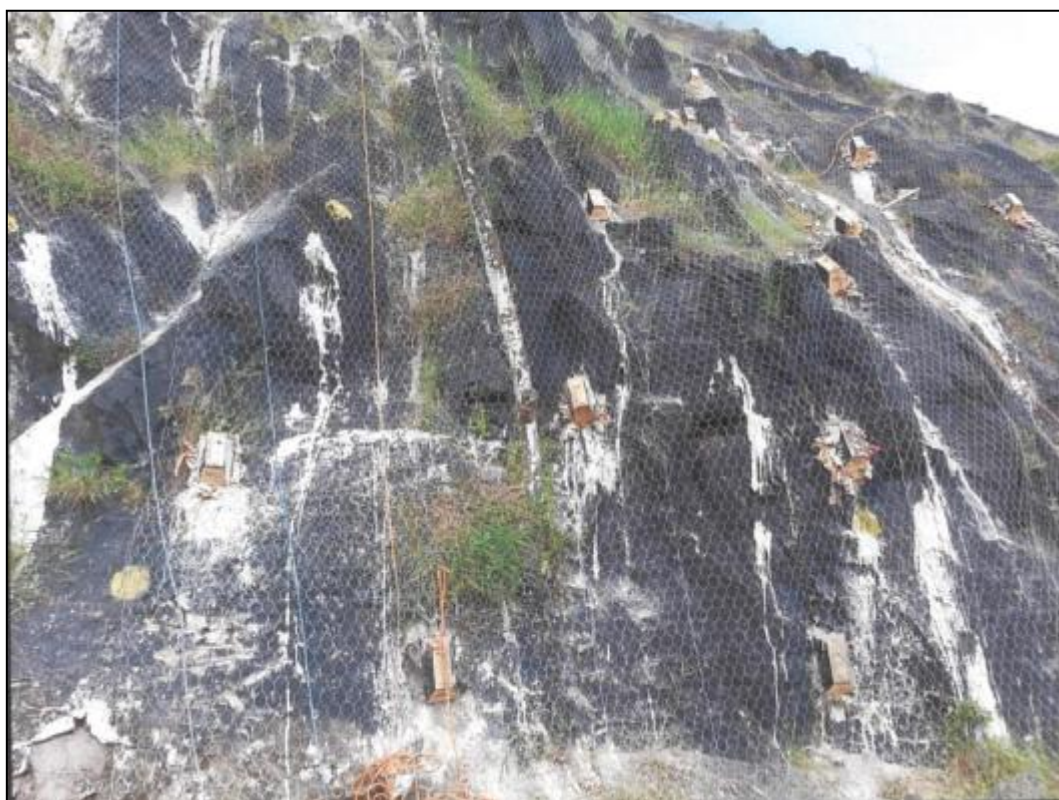
Imagem 28 - Acabamento dos chumbadores
