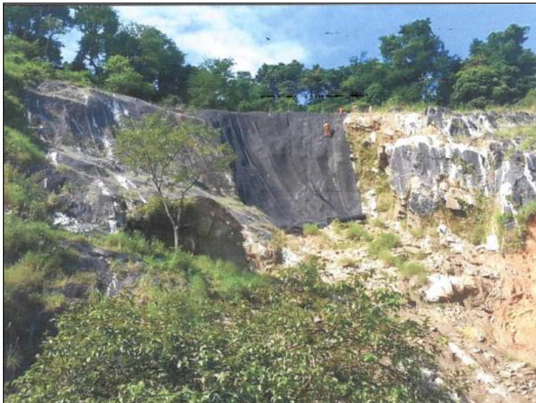
Imagem 27 - Geomanta aplicada na área da encosta onde houve desmoronamento
