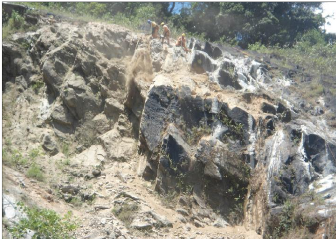
Imagem 13 - Remoção manual e perfuração a montante do bloco de rocha no setor A.
