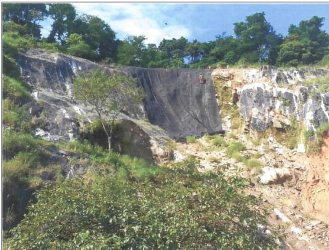
Imagem 35 - Instalação da malha hexagonal reforçada no Setor "A" 100% concluída
