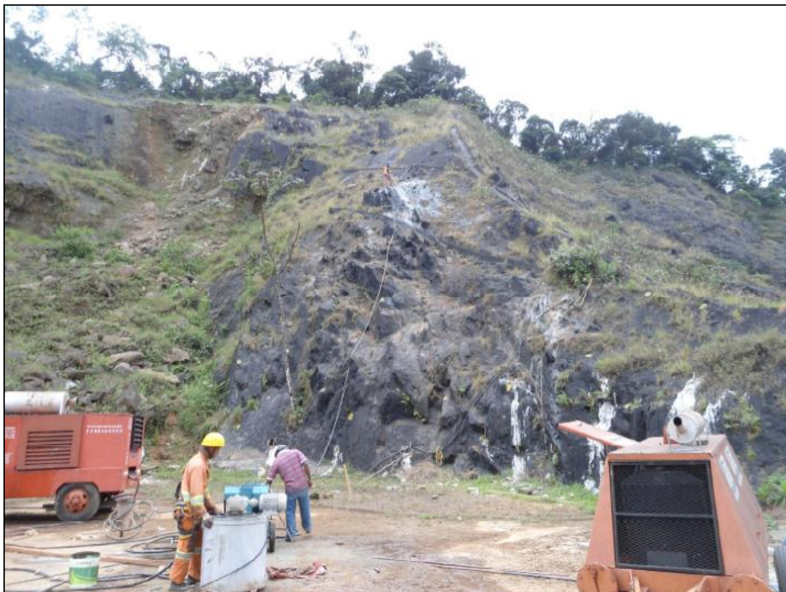
Imagem 19 - Bombeamento da calda de cimento para o Setor E
