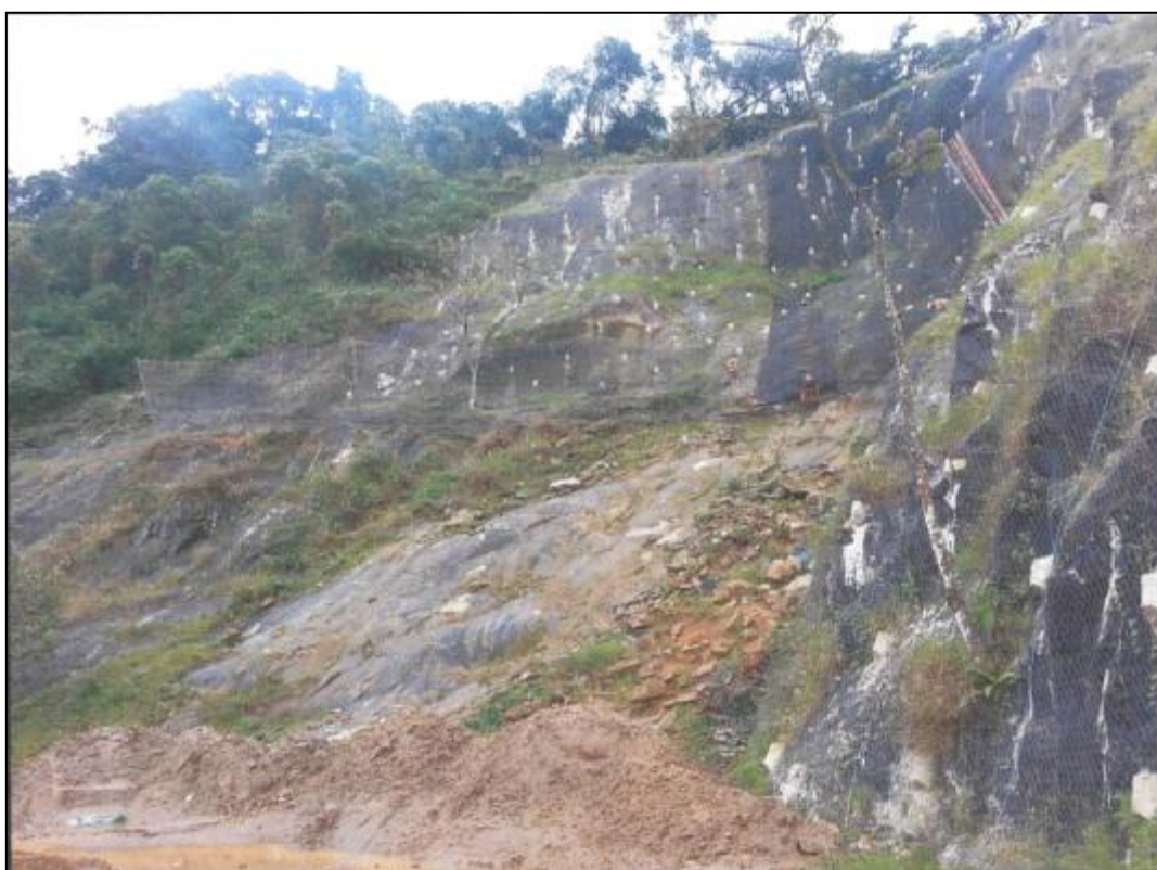
Imagem 30 - Painel da Barreira Dinâmica Flexível sendo instalada
