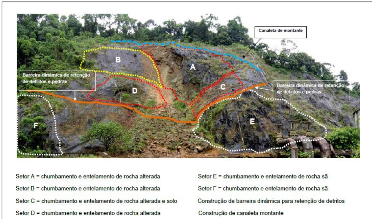
Imagem 2 - Projeto executivo e identificação dos setores – visão frontal da Área de Erosão
