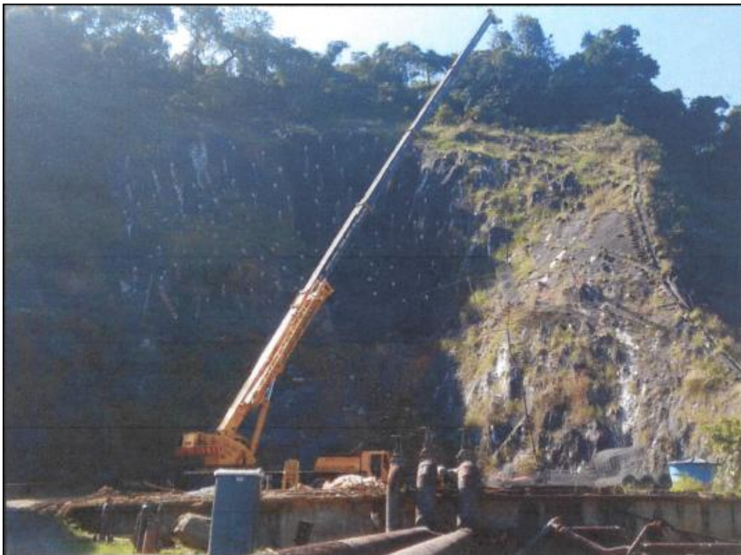
Imagem 31 - Painéis da Barreira Dinâmica Flexível sendo içado por guindaste
