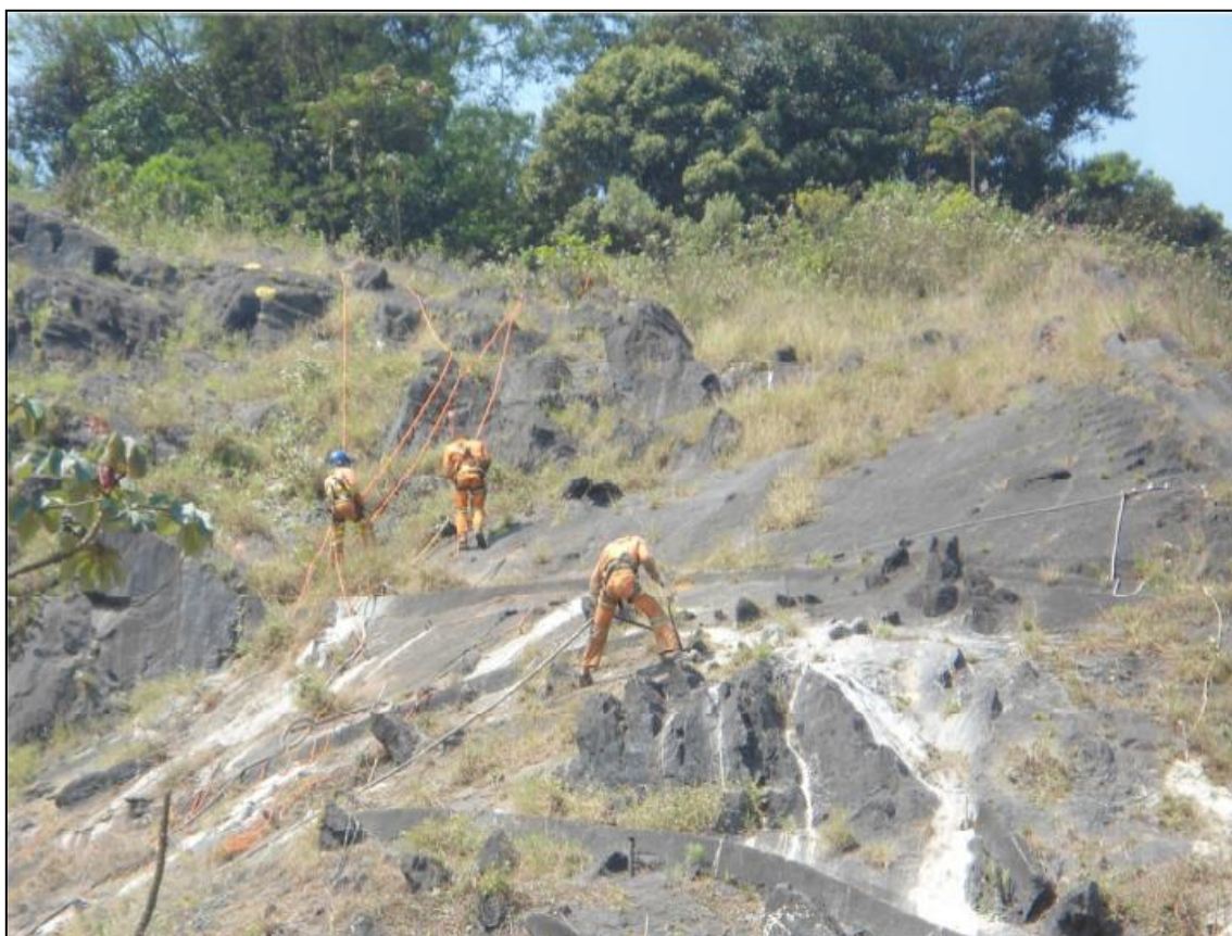
Imagem 24 - Perfuração no Setor A e instalação de chumbadores
