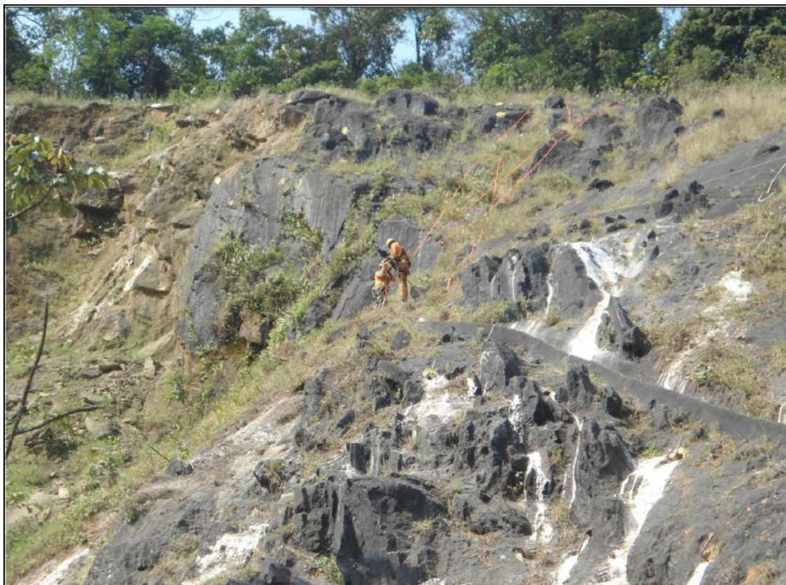
Imagem 23 - Perfuração no Setor C
