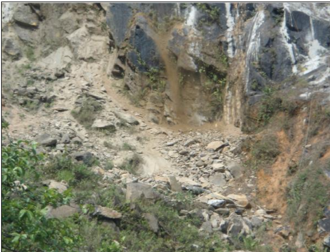
Imagem 15 - Pedras soltas que foram removidas da encosta rochosa
