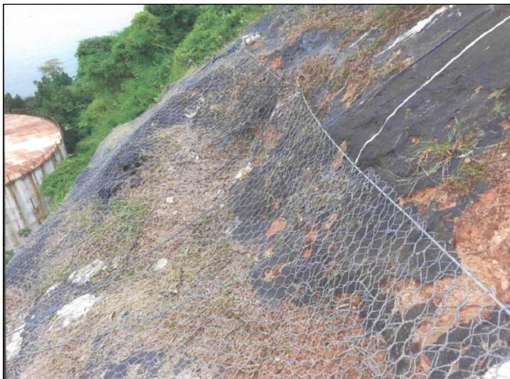
Imagem 26 – Malha de dupla torção aplicado no topo da encosta
