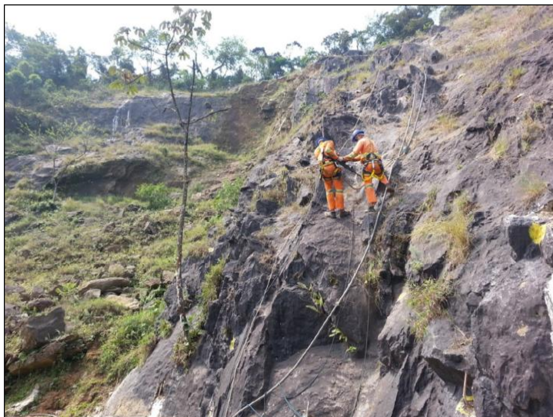
Imagem 18 - Perfuração de chumbadores no Setor E
