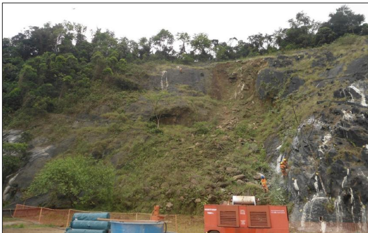
Imagem 22 - Perfuração no Setor E e início da descida pelo setor B e D
