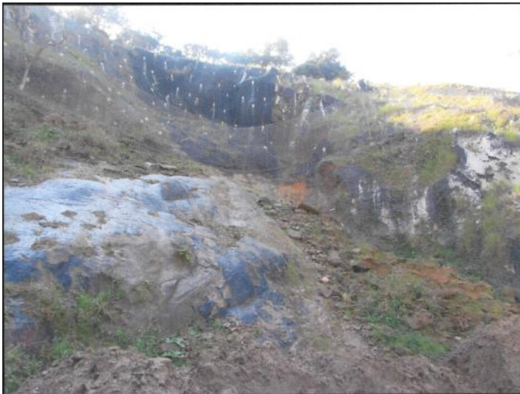
Imagem 33 - Vista geral da obra com destaque para a Barreira Dinâmica Flexível instalada
