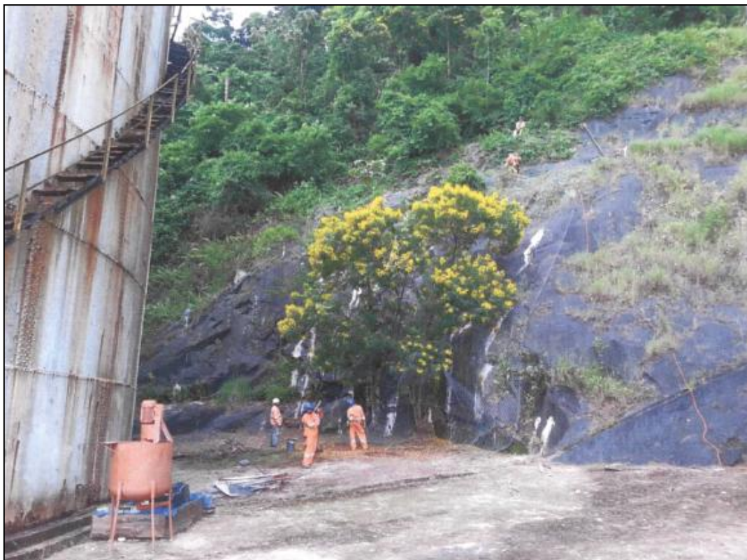
Imagem 37 - Instalação da malha hexagonal reforçada do setor "F" 100% concluída
