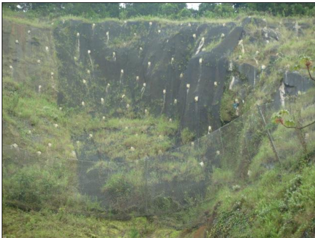
Imagem 38 - Visão geral da obra 100% concluída. Detalhe na vegetação crescendo na geomanta.
