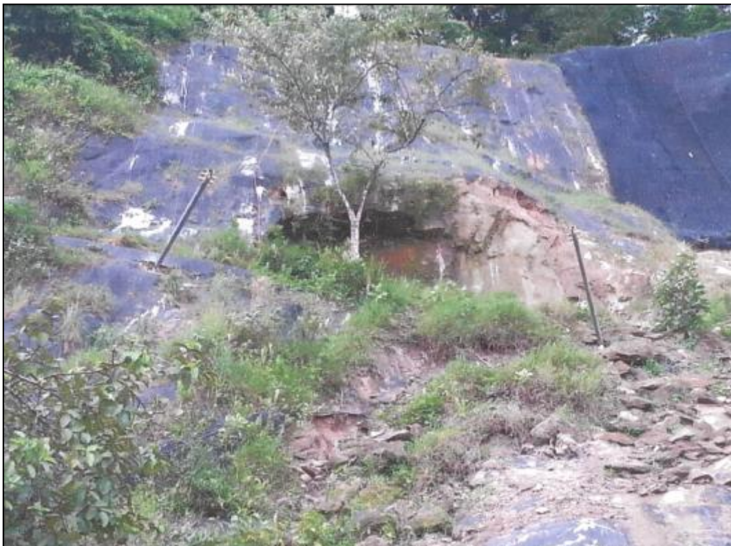
Imagem 29 - Postes da Barreira Flexível Dinâmica instalados
