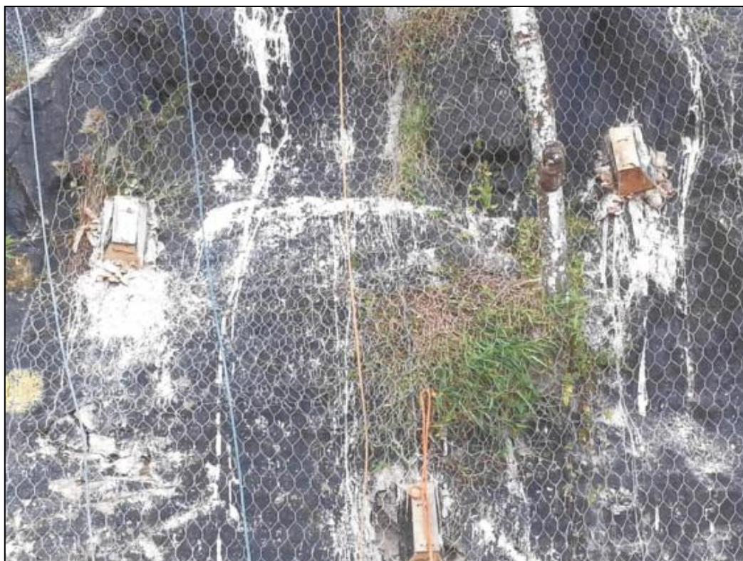
Imagem 36 - Detalhe dos capacetes dos chumbadores do setor "E" 100% concluído
