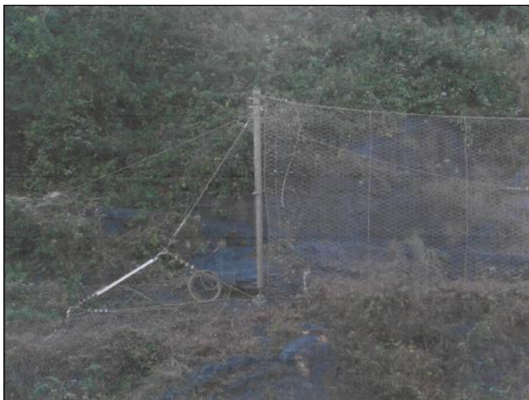
Imagem 32 - Detalhe dos cabos da Barreira Dinâmica Flexível tensionados
