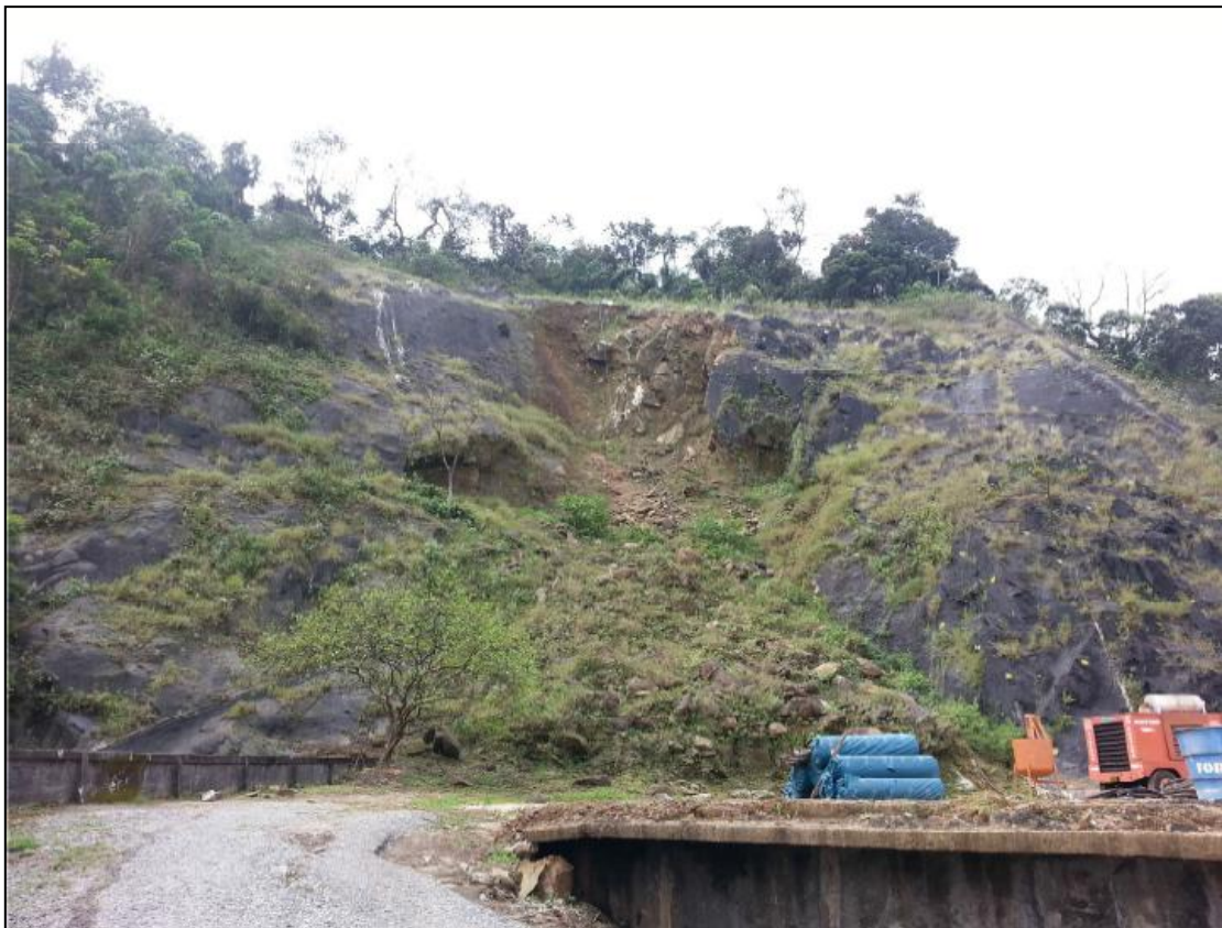
Imagem 12 - Vista frontal da encosta antes das atividades
