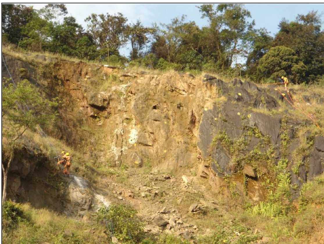
Imagem 14 - Encosta após remoção de pedras soltas
