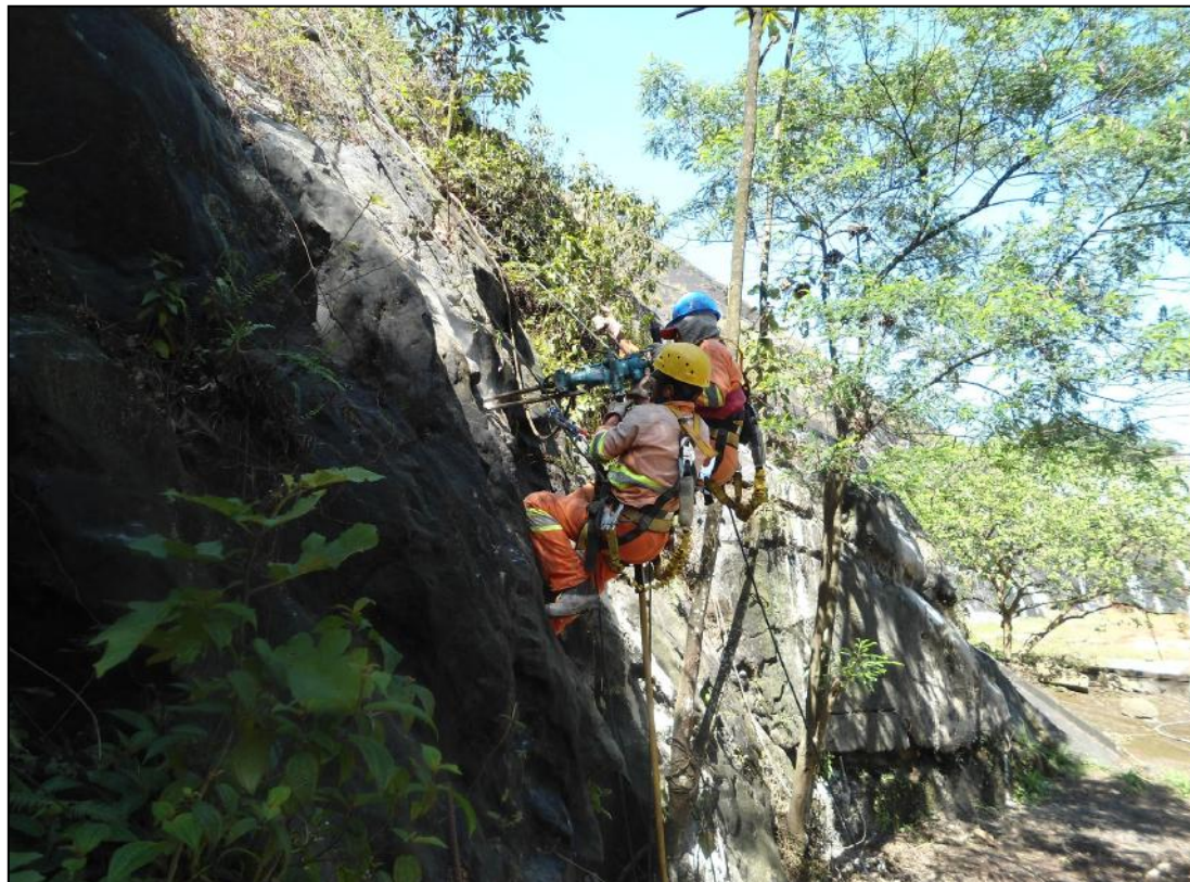
Imagem 20 - Perfuração de chumbadores no Setor F
