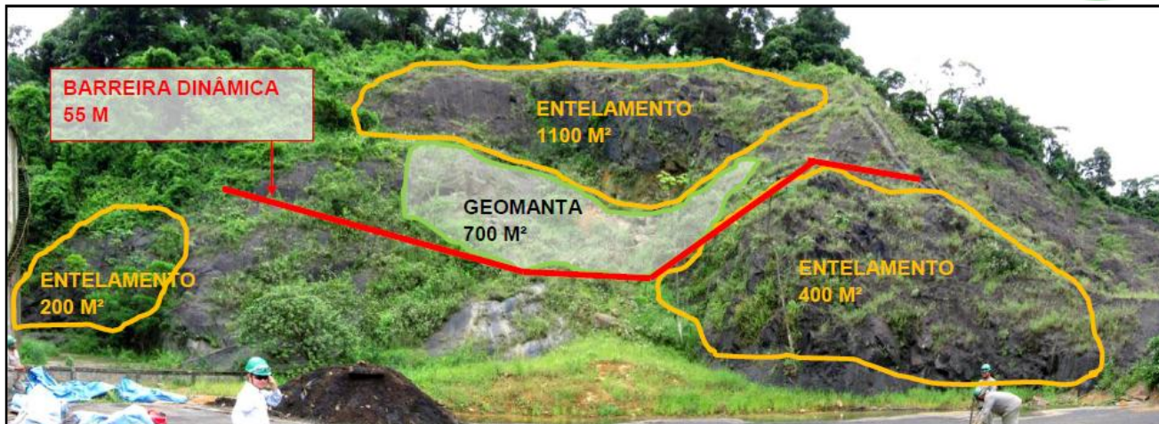
Imagem 5 - Medidas de controle da Área de Erosão
