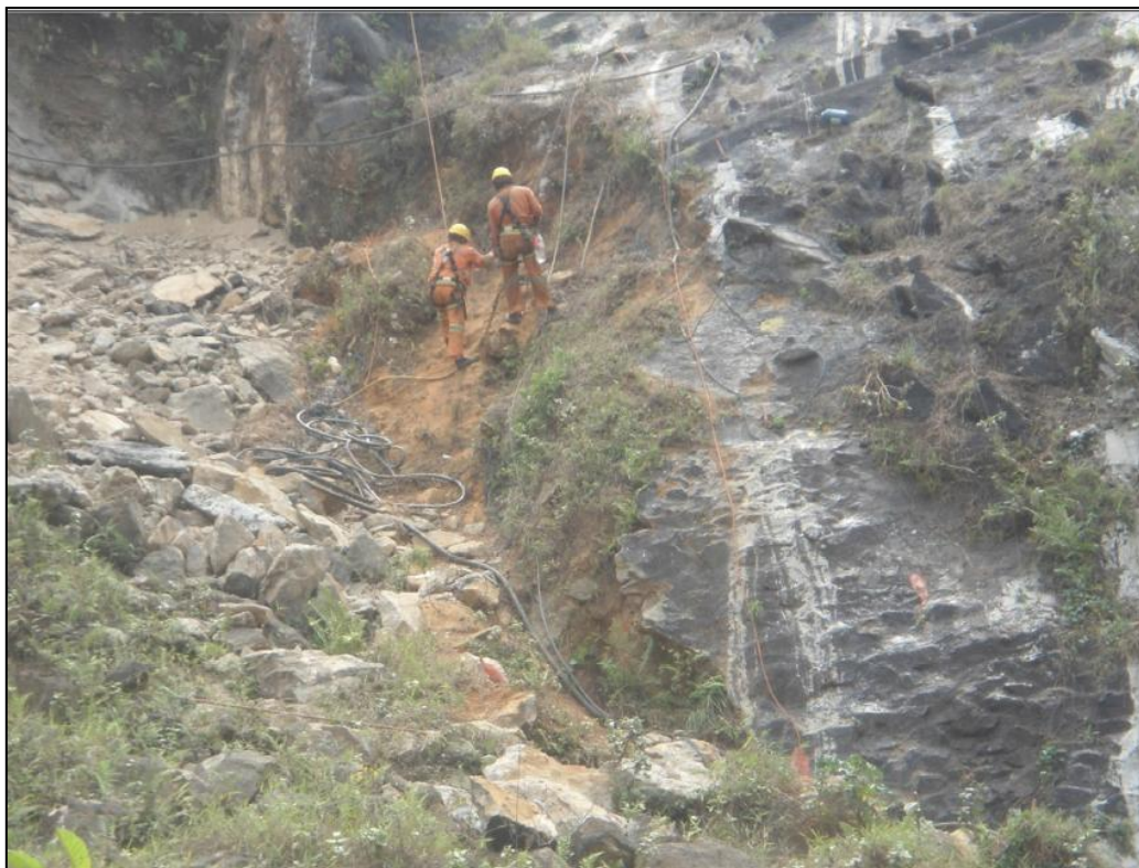
Imagem 25 - Perfuração no Setor C
