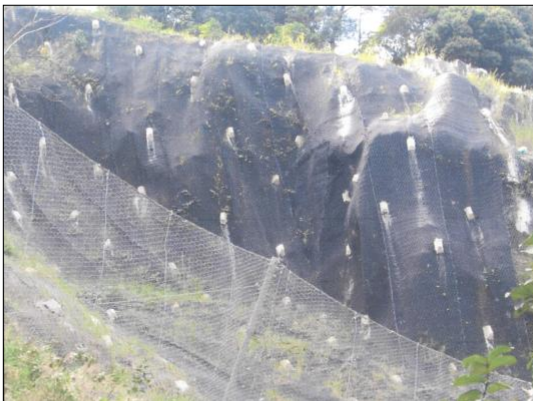
Imagem 34 - Vista geral da obra com a geomanta ao fundo e a Barreira Dinâmica Flexível no primeiro plano
