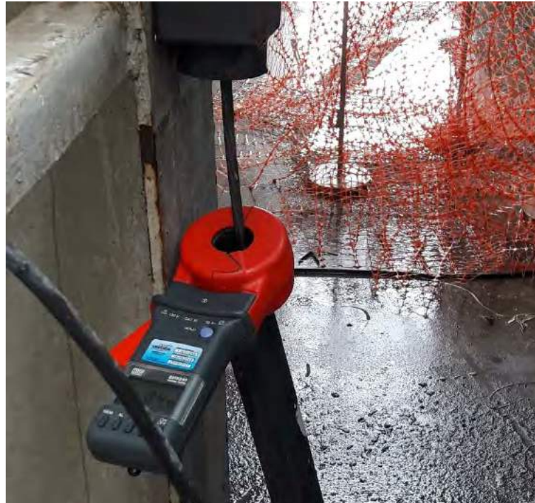
Figura 5: Medição de continuidade das descidas.
