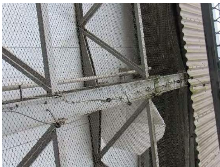
Figura 11: Isoladores tortos ou quebrados.
