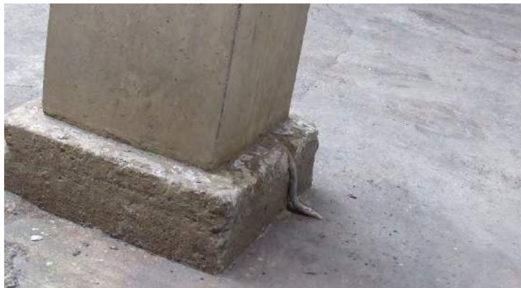
Figura 4: Ponto de aterramento de pilar ( próximo a Sala de máquinas 01 - 2018)
