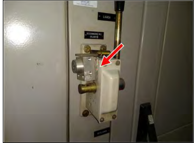
Figura 33 - Bloqueio mecânico danificado Secc. nº02
