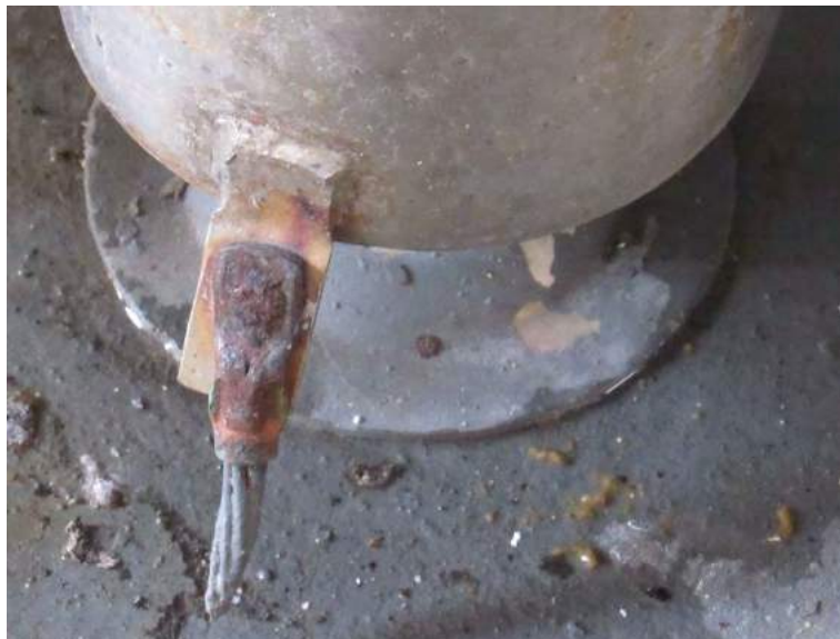
Figura 42: Parafuso oxidado.
