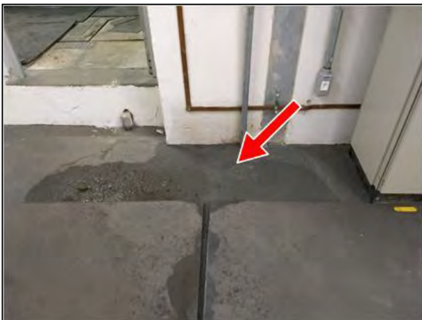
Figura 50 – gotejamento de água no teto da subestação
