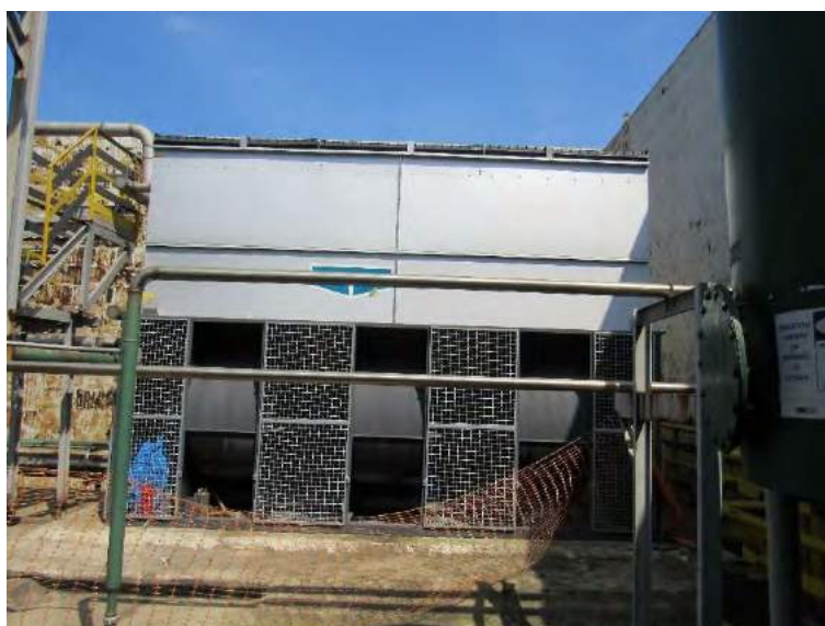
Figura 28: Novos equipamentos instalados.
