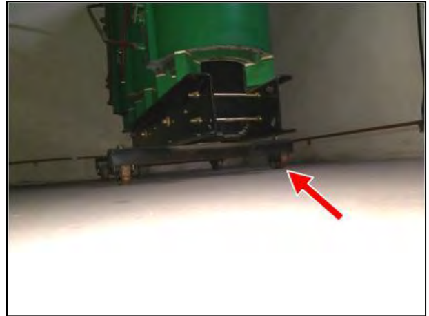
Figura 48 – Rodas do Transformador não está travada
