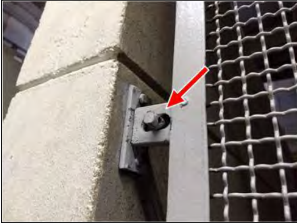
Figura 31 – Grade não travada de acordo
