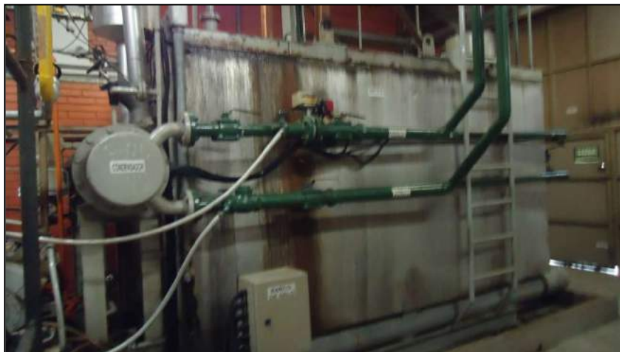
Figura 16 – Reservatório e compressor do Banco de Gelo
