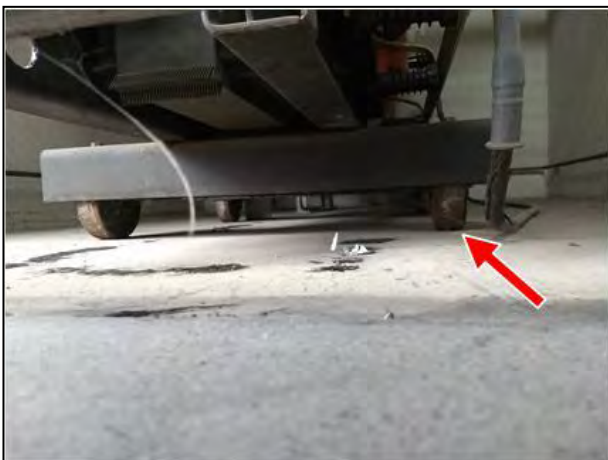
Figura 47 – Rodas do Transformador não está travada
