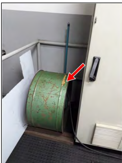
Figura 17 – Materiais armazenados dentro sala elétrica
