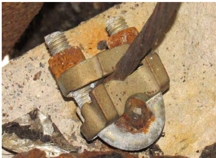
Figura 14: Vergalhão e conector em estado de corrosão.
