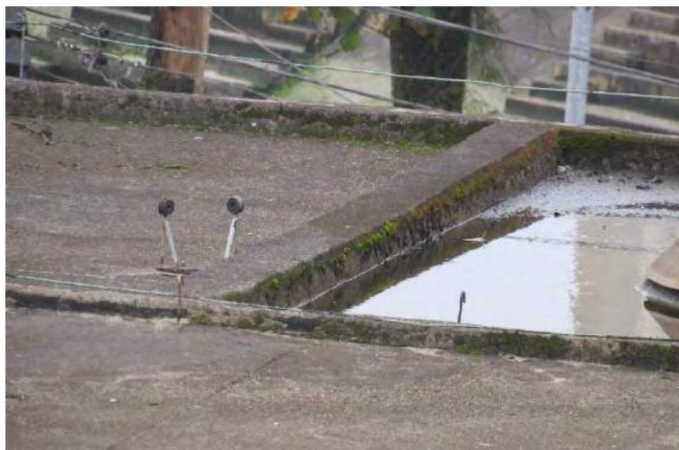
Figura 37: Trecho descontinuado do SPDA e Suporte de cabos defeituoso (foto 2018).
