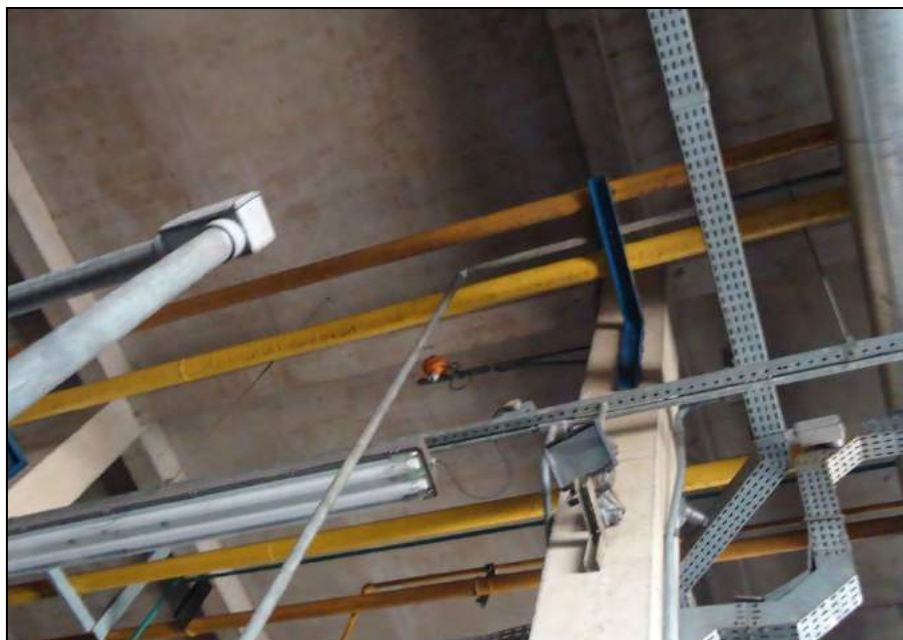
Figura 3 – Detector de hidrocarbonetos na sala de caldeiras
