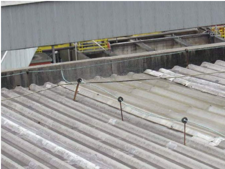
Figura 17: Cabo da linha de vida em contato com o SPDA (foto 2018).
