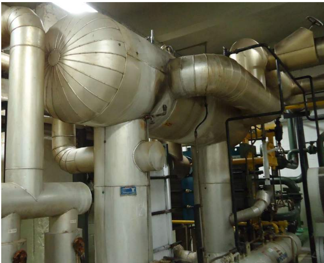
Figura 11 – Separador de líquido da sala de máquinas 2
