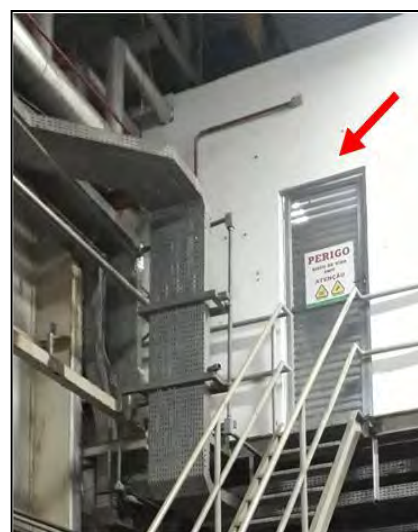
Figura 16 – Sala elétrica sem identificação
