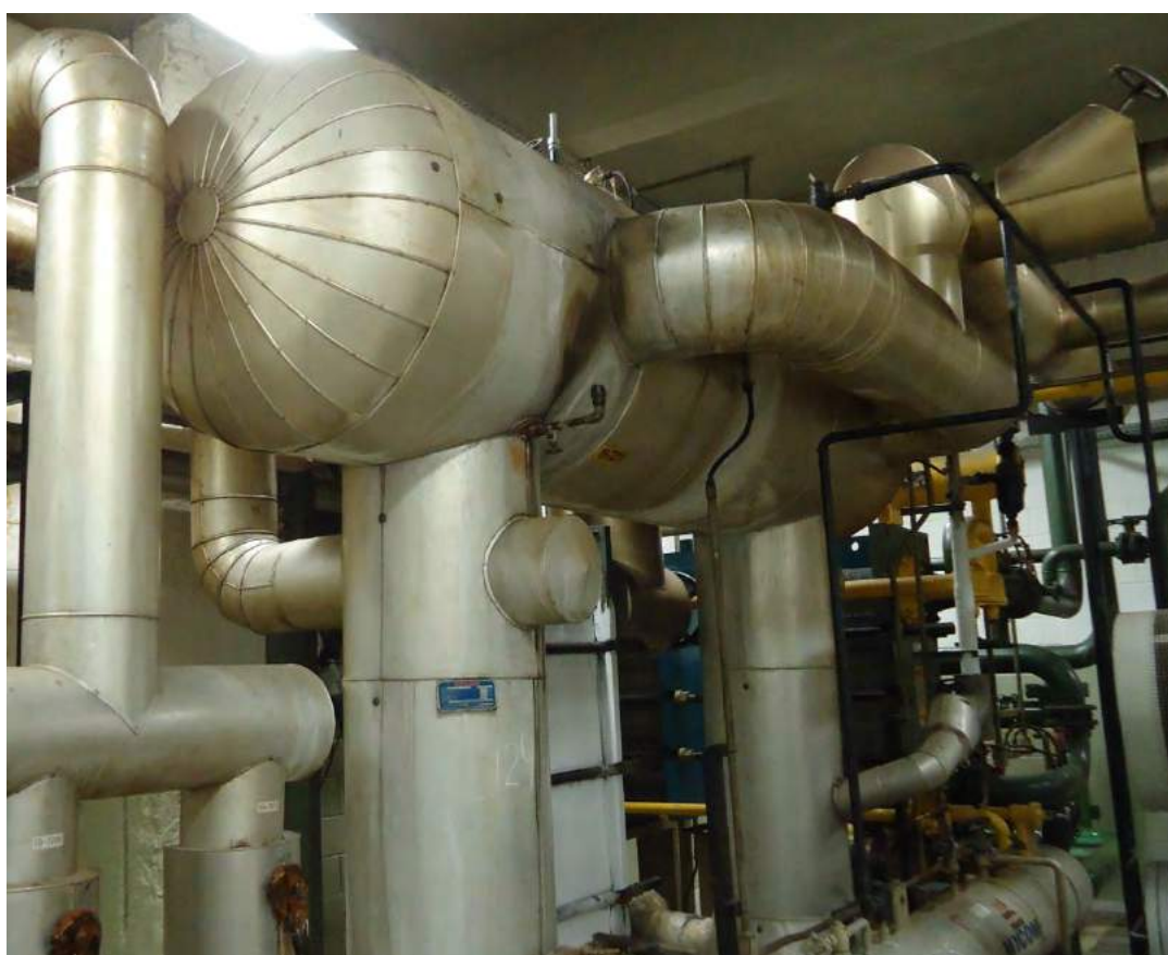
Figura 9 – Separador de líquido da sala de máquinas 2
