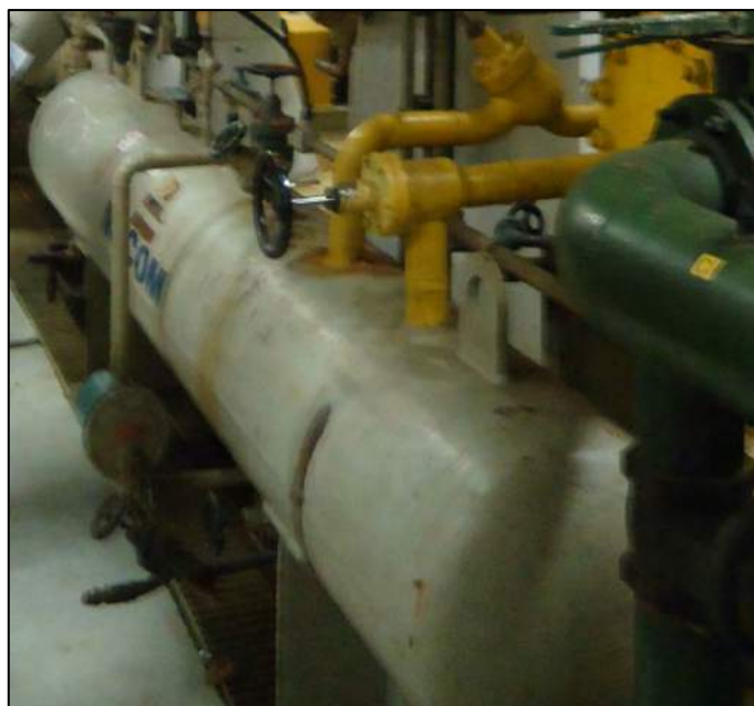
Figura 7 – Reservatório de amônia da sala de máquinas 2
