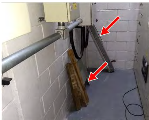
Figura 28 – Materiais em desuso armazenada no interior da subestação
