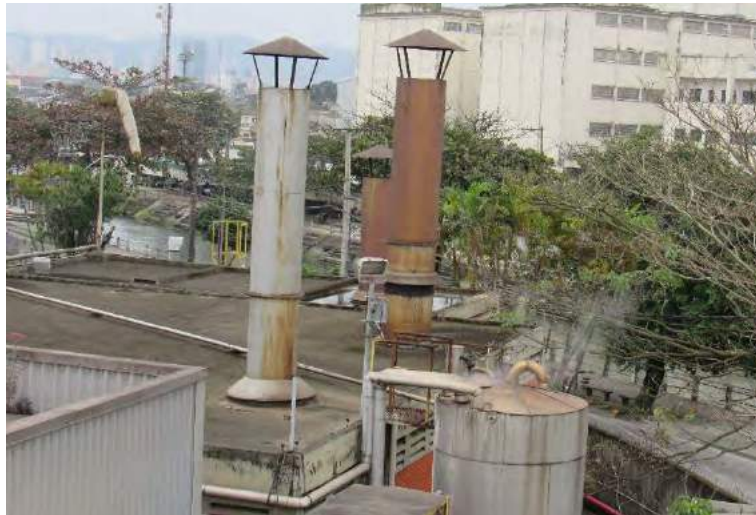
Figura 36: Estruturas fora do volume de proteção e desvinculadas (foto 2018).
