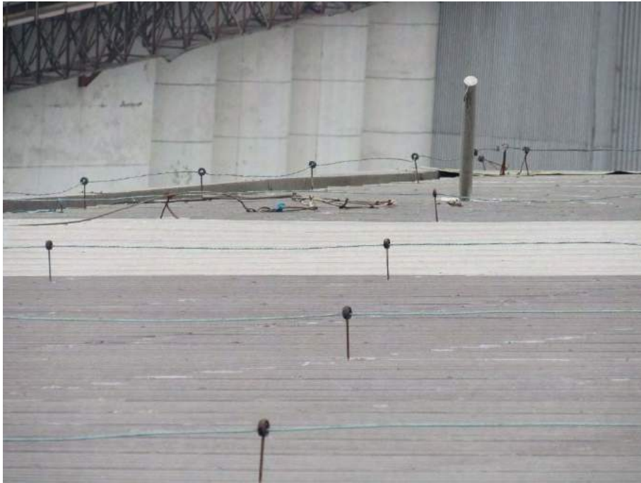
Figura 16: Elemento de linha de vida acima do SPDA (foto 2018).
