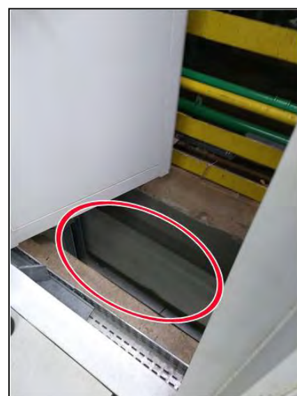
Figura 42 – Porta de emergência
