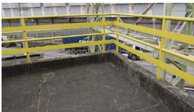
Figura 23: SPDA abaixo de várias estruturas metálicas. (foto 2018)
