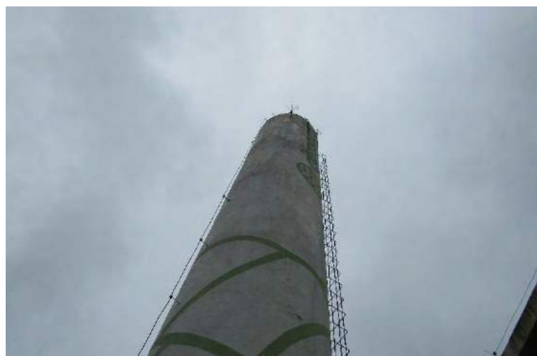
Figura 30: Caixa d'água elevada com uma descida (foto 2018).
