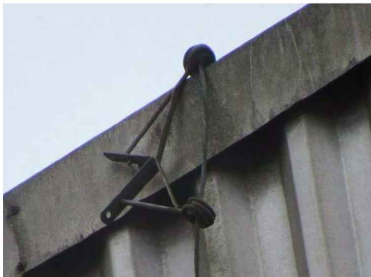
Figura 9: Isolador solto na descida 12
