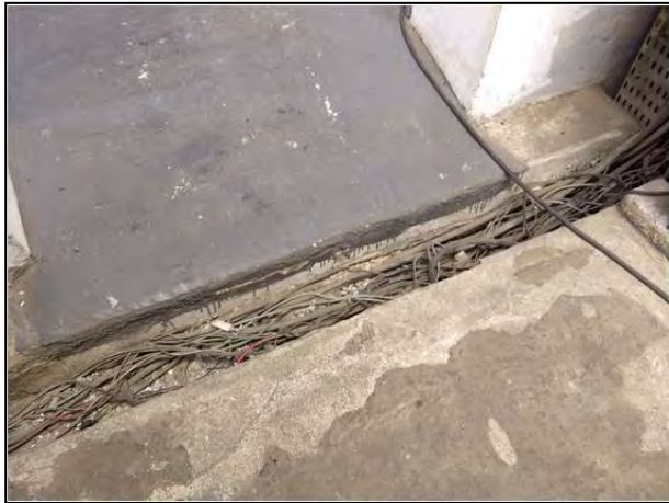
Figura 20– canaleta sem tampa para proteção
