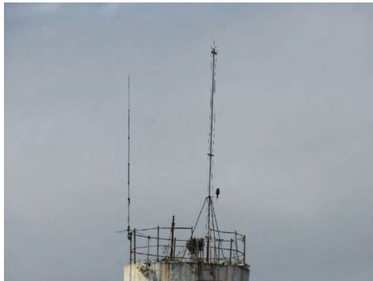
Figura 29: Captação da caixa d'água elevada.
