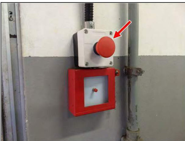
Figura 11 – Botoeira de “emergência”
