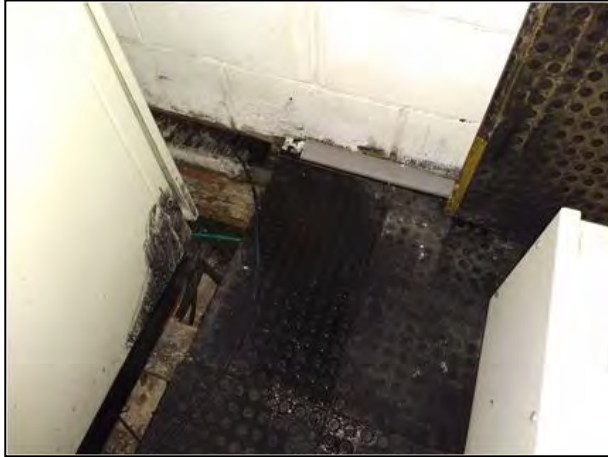
Figura 37– Infiltração de água no teto da subestação
