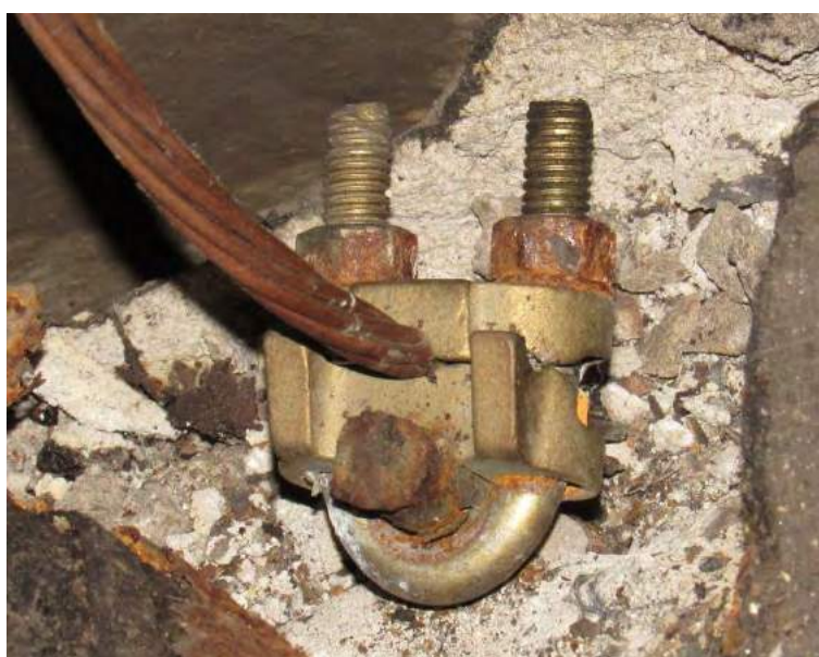
Figura 13: Vergalhão e conector em estado de corrosão.
