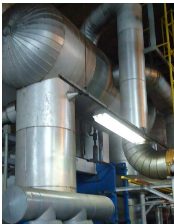
Figura 11 – Separador de líquido da sala de máquinas 3
