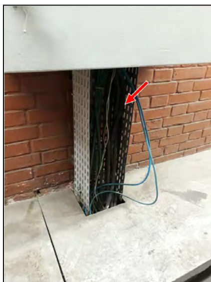
Figura 14 –Eletrocalha sem tampa
