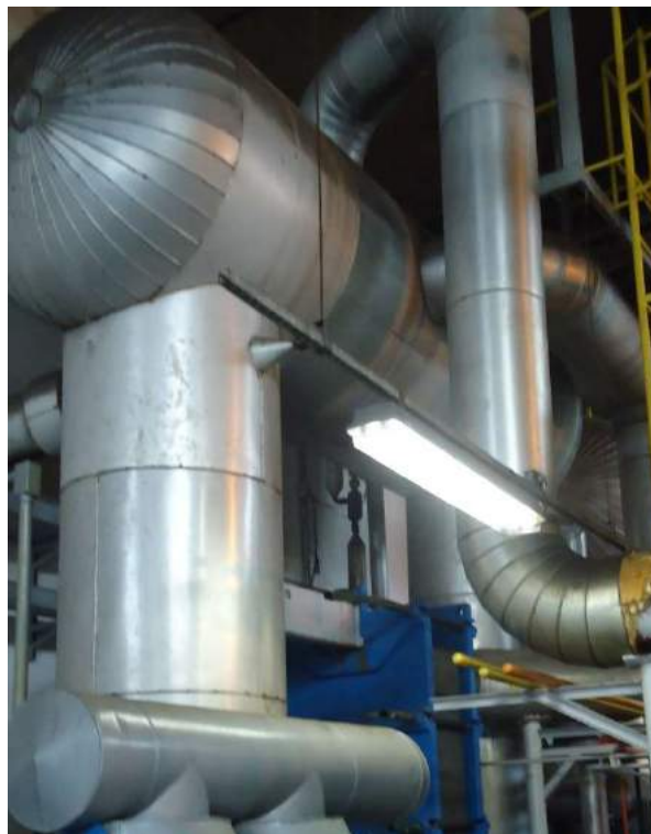
Figura 13 – Separador de líquido da sala de máquinas 3
