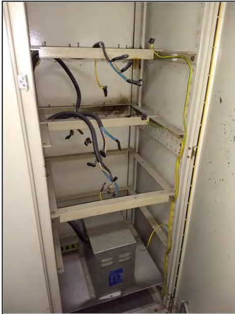
Figura 46 – Equipamento desativado sem identificação de sua condição
