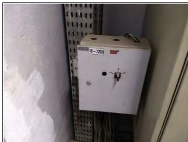
Figura 19 – Painel instalado de forma inadequada.
