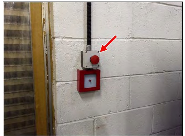
Figura 39 – Botão de “emergência”
