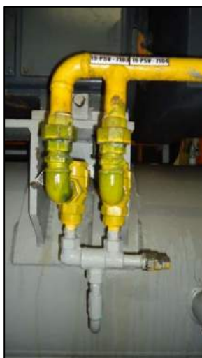
Figura 14 – Exemplo de PSV instalada em compressor da sala de máquinas 1
