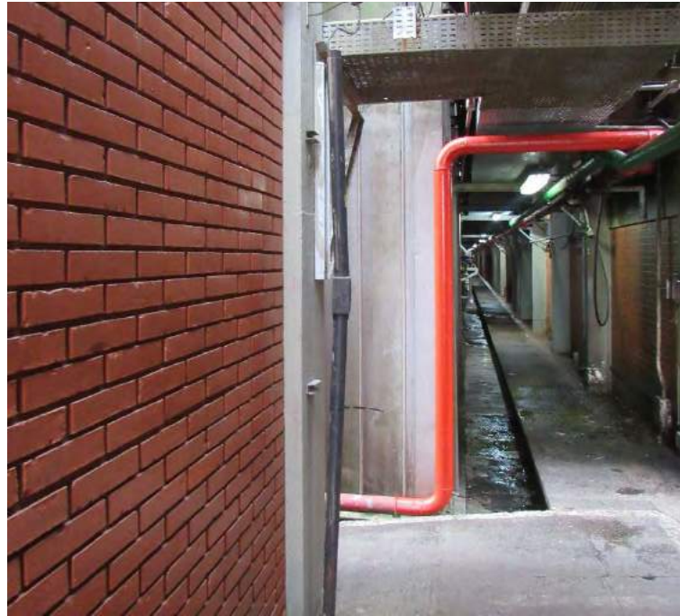
Figura 20: Proteção de PVC solta.
