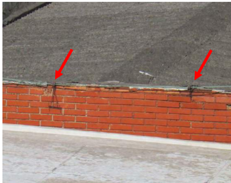
Figura 19: Isolador solto na captação da SE-03.
