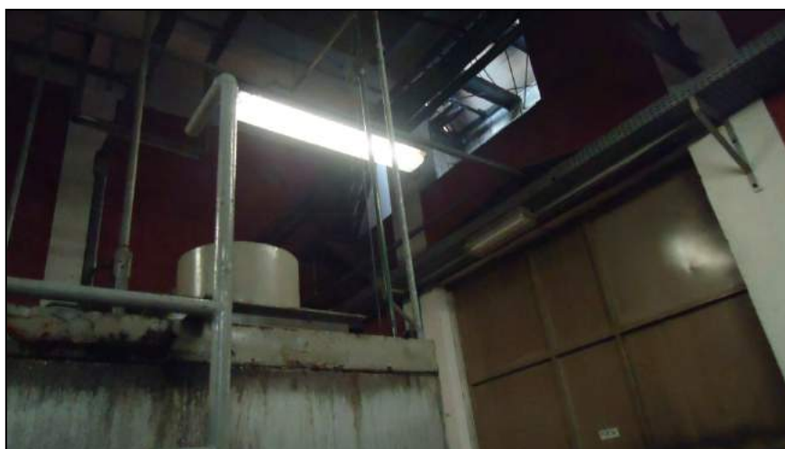
Figura 13 – Exaustor para o Banco de Gelo
