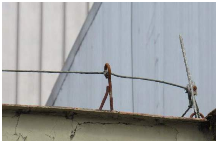
Figura 32: Isolador solto sobre o prédio da Adm.
