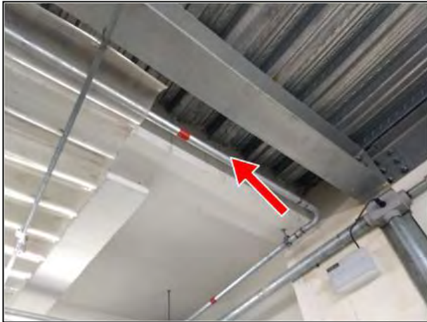
Figura 49 – Gotejamento de água no teto da subestação
