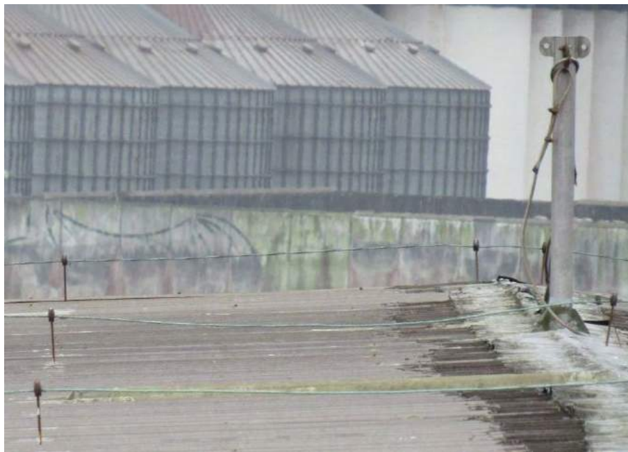
Figura 15: Elemento de linha de vida acima do SPDA (foto 2018).
