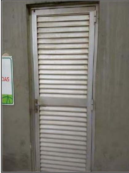
Figura 34 – Porta de entrada da subestação sem identificação / sinalização dos riscos
