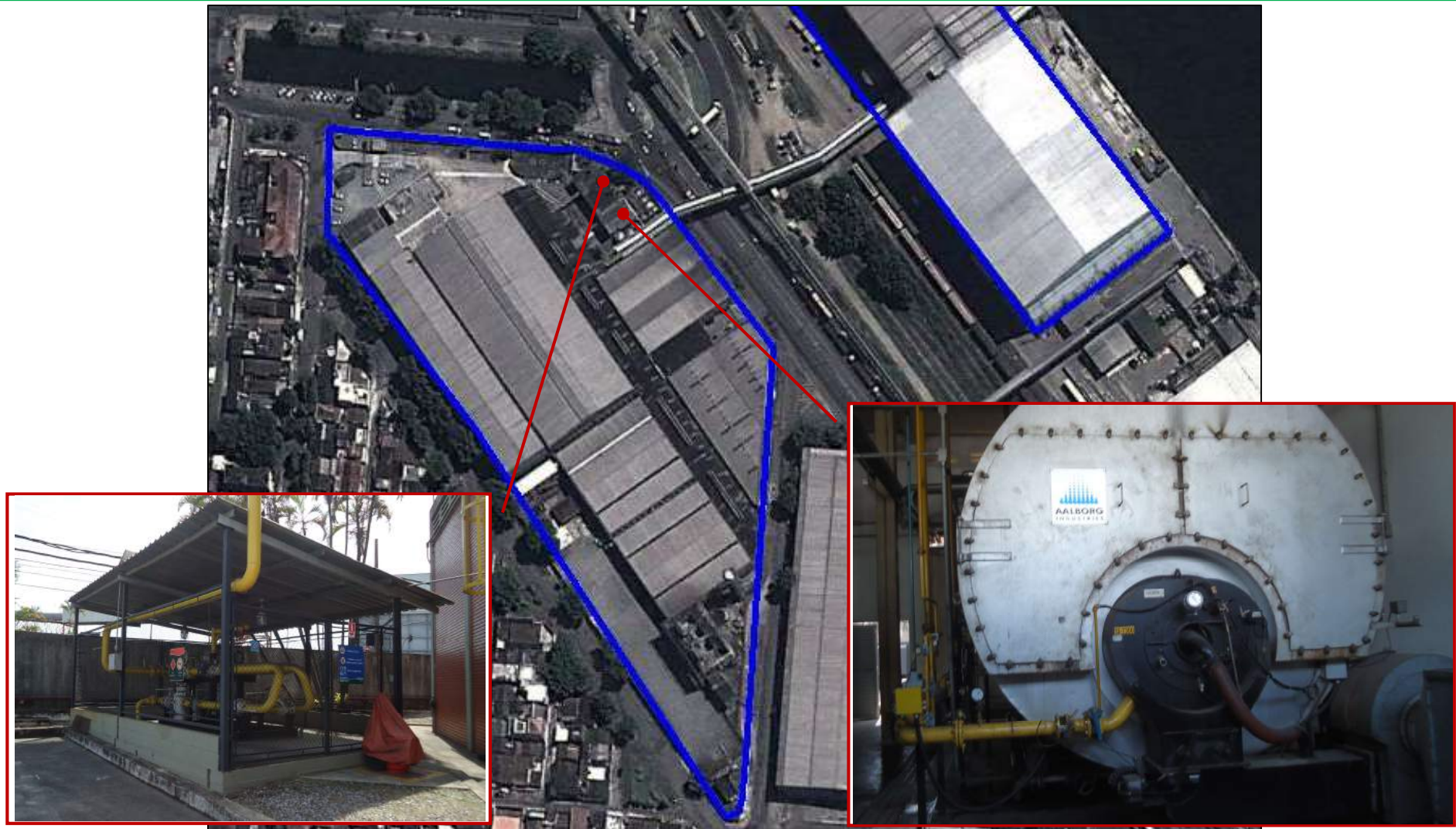
Figura 4 – Sistema de alimentação de gás natural para caldeiras à vapor
