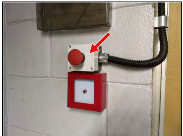
Figura 23 – Botoeira de “emergência”
