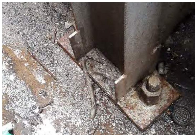
Figura 7: Conexão rompida.
