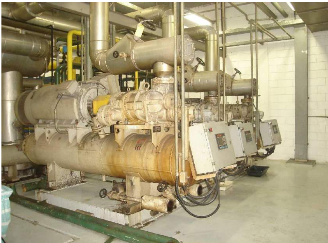
Foto 6 – Grupo de compressores de amônia.
