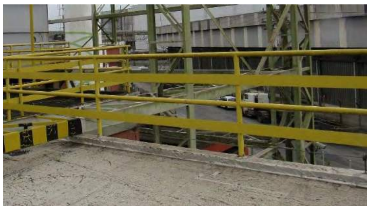
Figura 22: SPDA abaixo da estrutura metálicas. (foto 2018)
