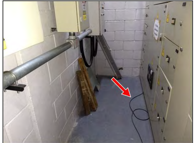
Figura 25 – Cabos instalados de maneira provisória
