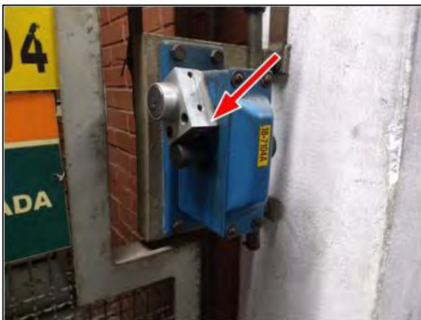
Figura 2 - Bloqueio mecânico danificado
