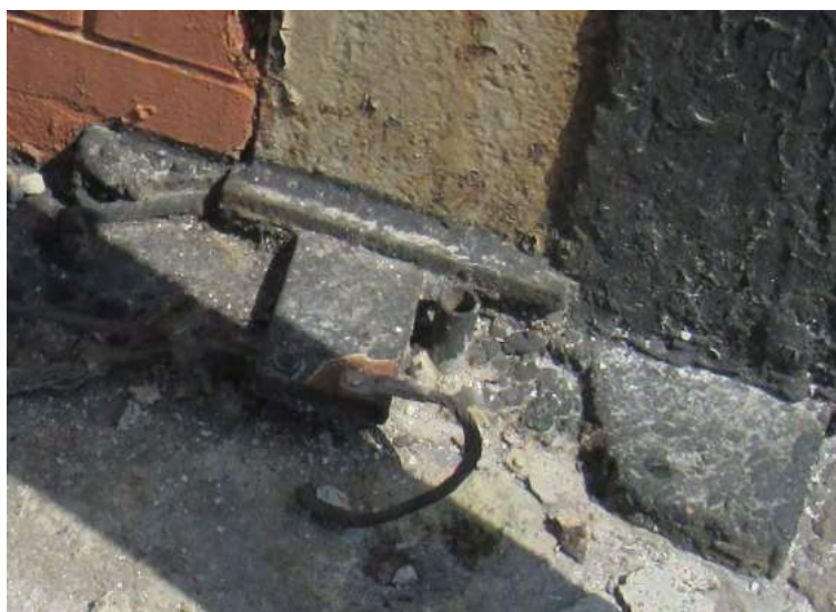
Figura 49: Ponto de aterramento EQ-03
