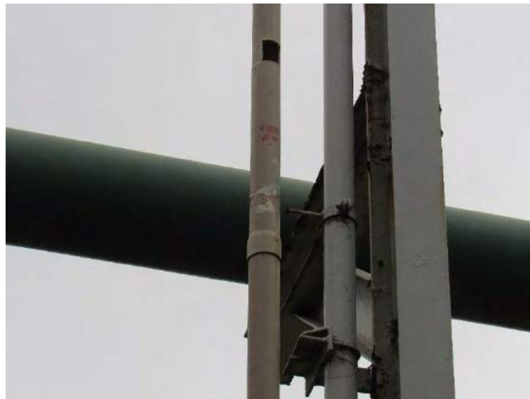
Figura 25: Suportação deficiente do condutor de descida do captor Franklin.
