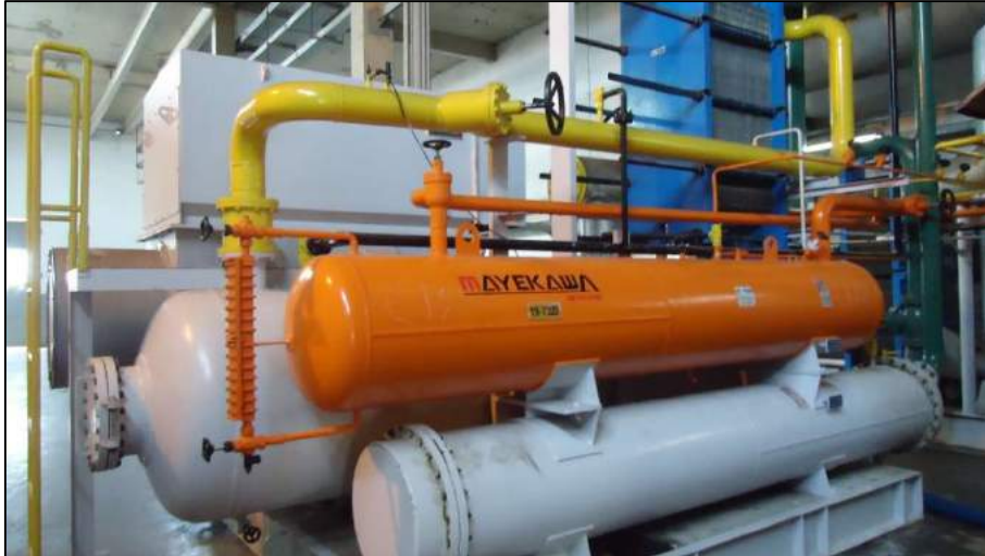
Figura 12 – Reservatório de amônia da sala de máquinas 3
