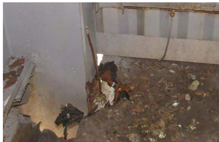
Figura 10: Visão geral da instalação.
