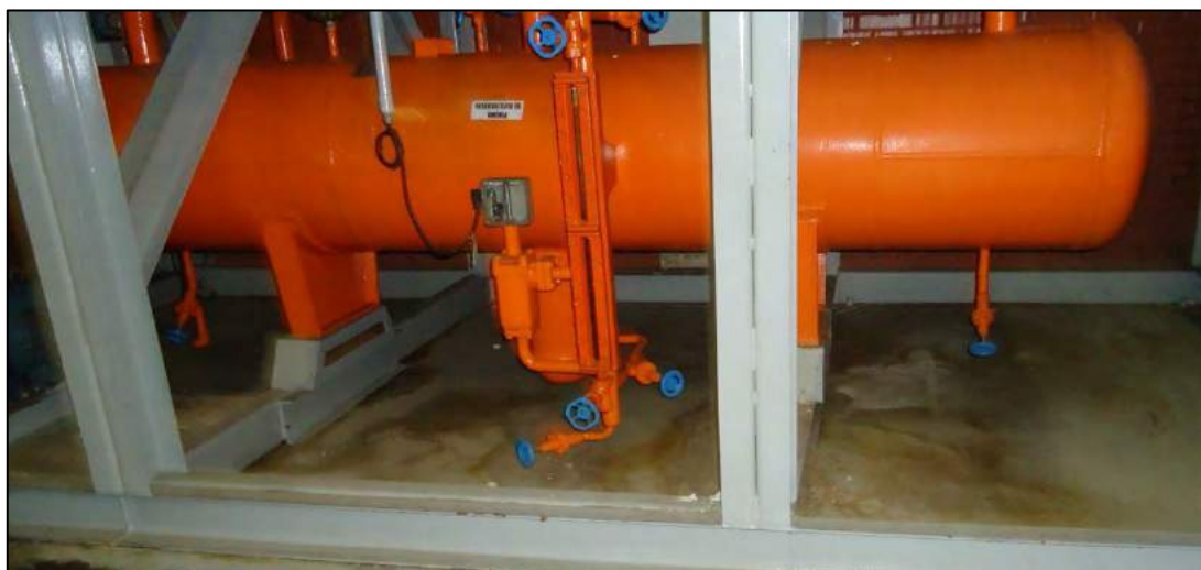
Figura 6 – Reservatório de amônia da sala de máquinas 1
