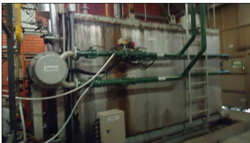
Figura 14 – Reservatório e compressor do Banco de Gelo
