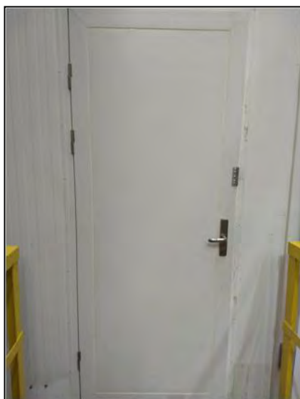
Figura 41 – Porta de entrada da subestação sem identificação / sinalização dos riscos
