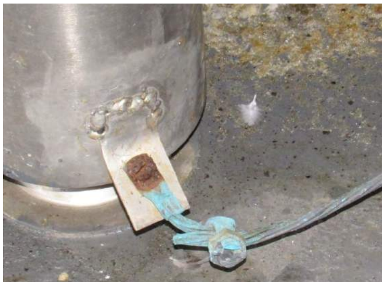
Figura 44: Parafuso oxidado.
