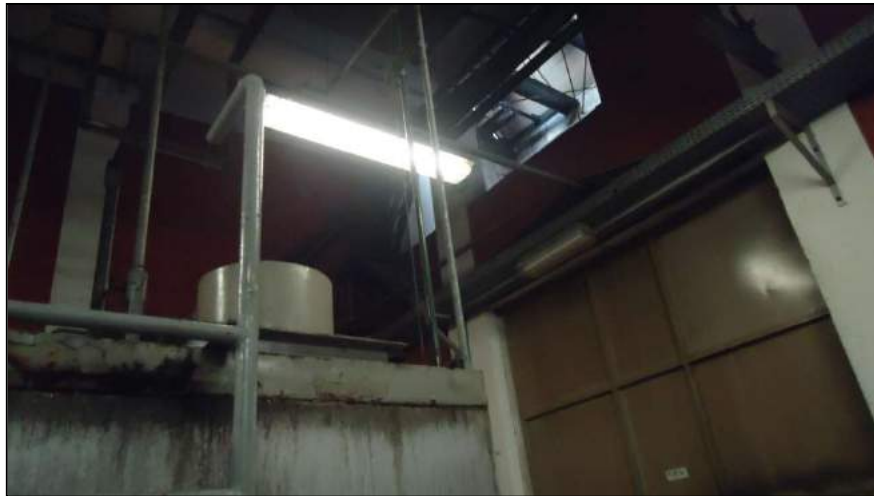
Figura 15 – Exaustor para o Banco de Gelo
