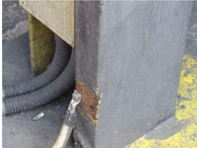
Figura 46: conexão no pilar ponto EQ-01.
