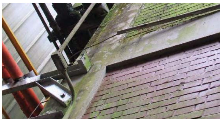
Figura 8: Ligação equipotencial lateral na descida 34 (foto 2018)
