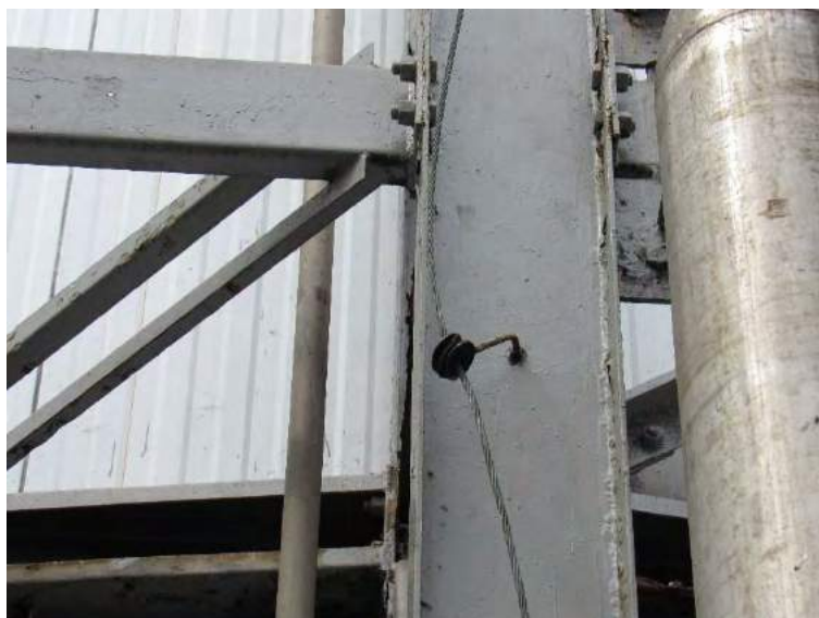
Figura 10: Isolador torto.
