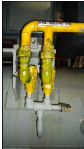
Figura 12 – Exemplo de PSV instalada em compressor da sala de máquinas 1
