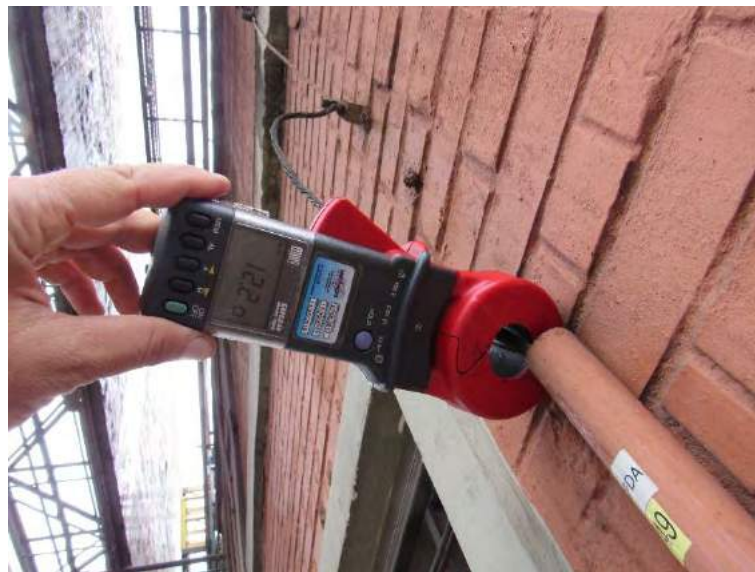
Figura 26: Medição de aterramento, descida 49 (foto 2018).
