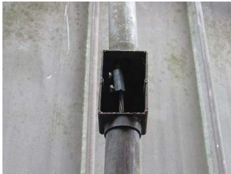
Figura 45: conexão de emenda na descida 10.
