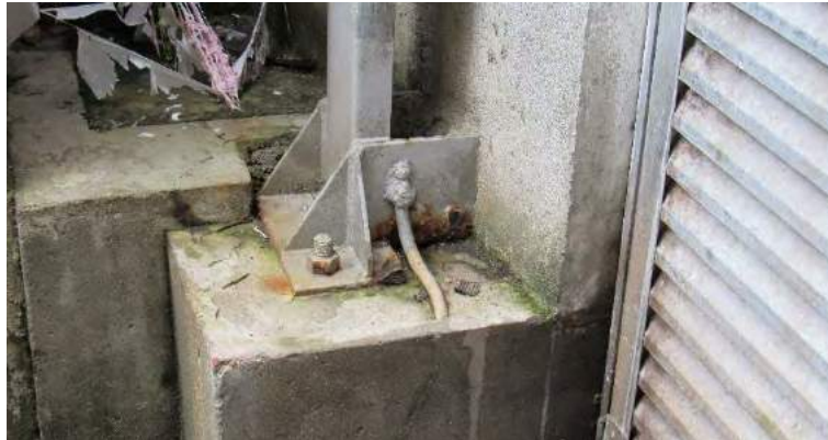
Figura 3: Ponto de aterramento nos tanques NFC ao lado da ADM (foto 2018).
