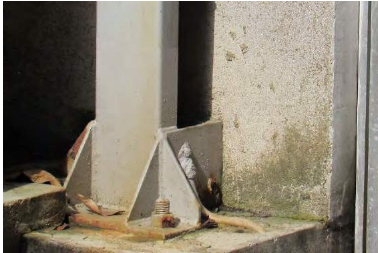
Figura 41: Ponto de aterramento na Base.
