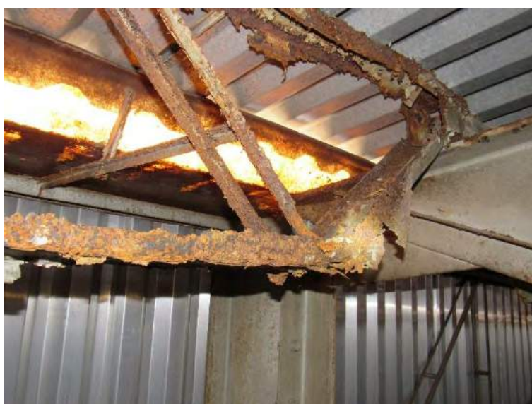
Figura 16: Exemplo do potencial corrosivo da atmosfera.
