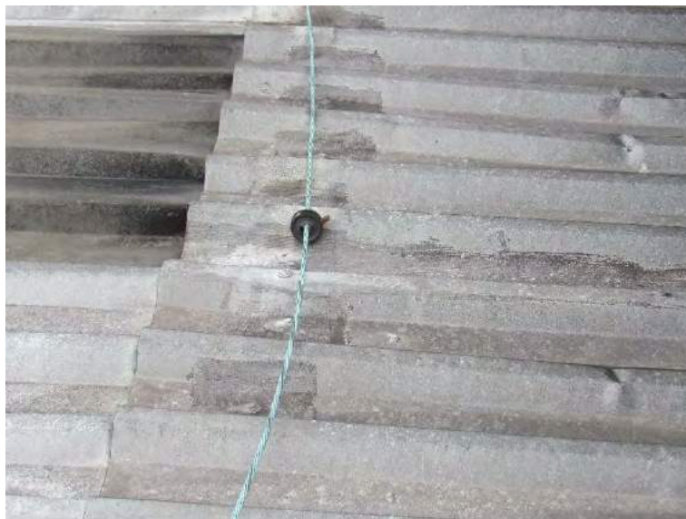
Figura 14: Suporte quebrado, lado mais antigo (foto 2018).
