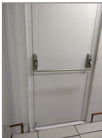
Figura 42 – Porta de emergência
