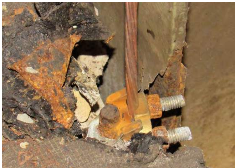
Figura 11: Vergalho e conector aplicado em estado de corrosão
