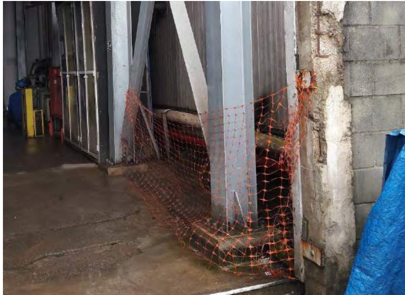
Figura 3: Isolamento de acesso à lateral das câmaras lado da ferrovia.
