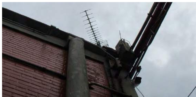
Figura 34: Condutos não interligados ao SPDA, e antena fora do Volume de Proteção (foto 2018).
