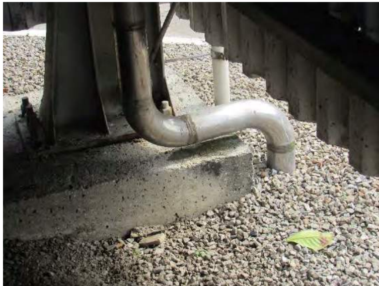
Figura 2: Elemento metálico enterrado.
