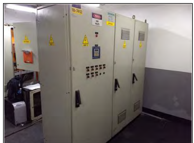
Figura 45 – Equipamento desativado sem identificação de sua condição
