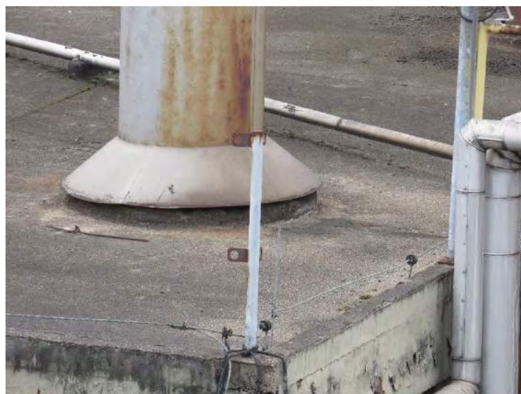
Figura 35: Estruturas fora do volume de proteção e desvinculadas (foto 2018).
