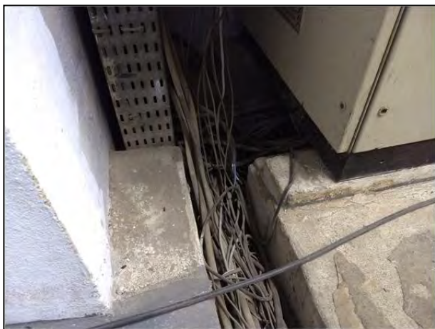
Figura 21– canaleta sem tampa para proteção
