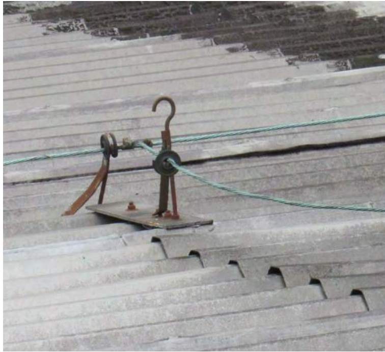
Figura 13: Suporte quebrado, lado mais antigo (foto 2018).
