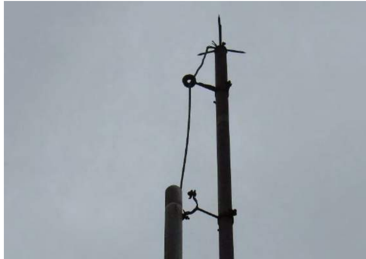
Figura 24: Suportação deficiente do condutor de descida do captor Franklin. (foto 2018)
