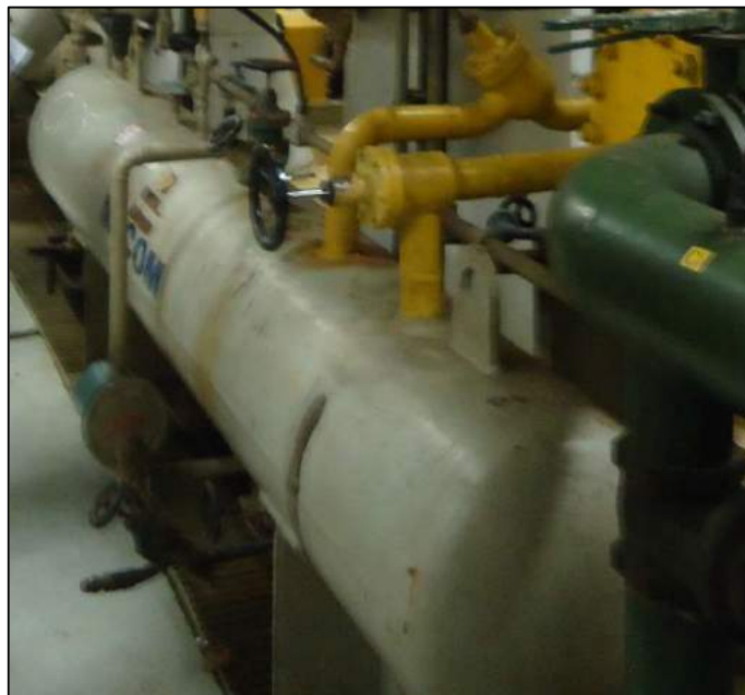
Figura 9 – Reservatório de amônia da sala de máquinas 2
