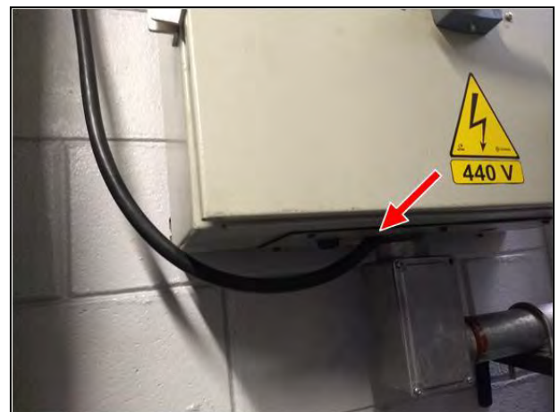
Figura 26 – Cabos instalados de maneira provisória
