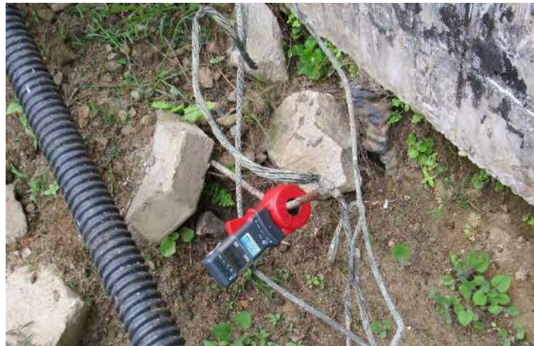
Figura 12: Haste de aterramento afetada pela escavação.
