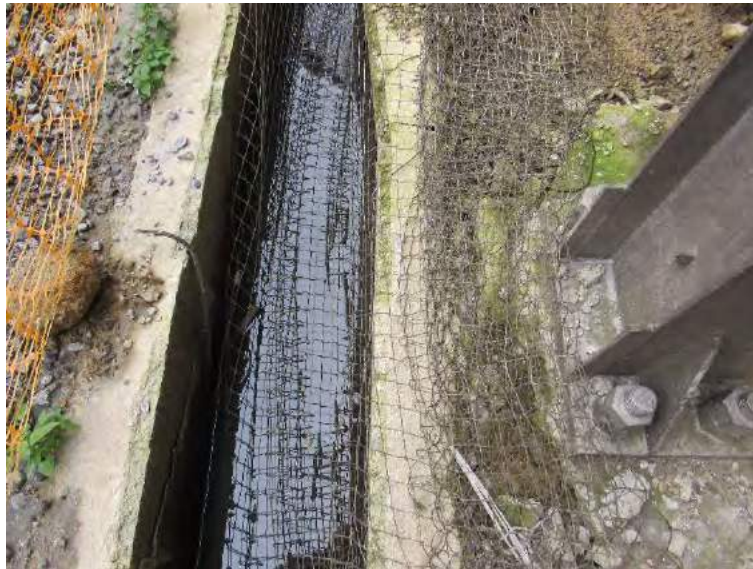
Figura 6: Ponto de aterramento desconectado (foto de 2018).
