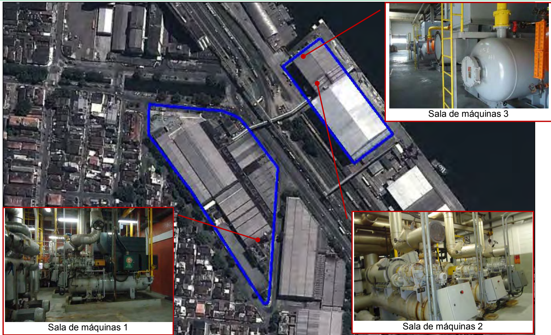
Figura 5 – Salas de máquinas do sistema de refrigeração
