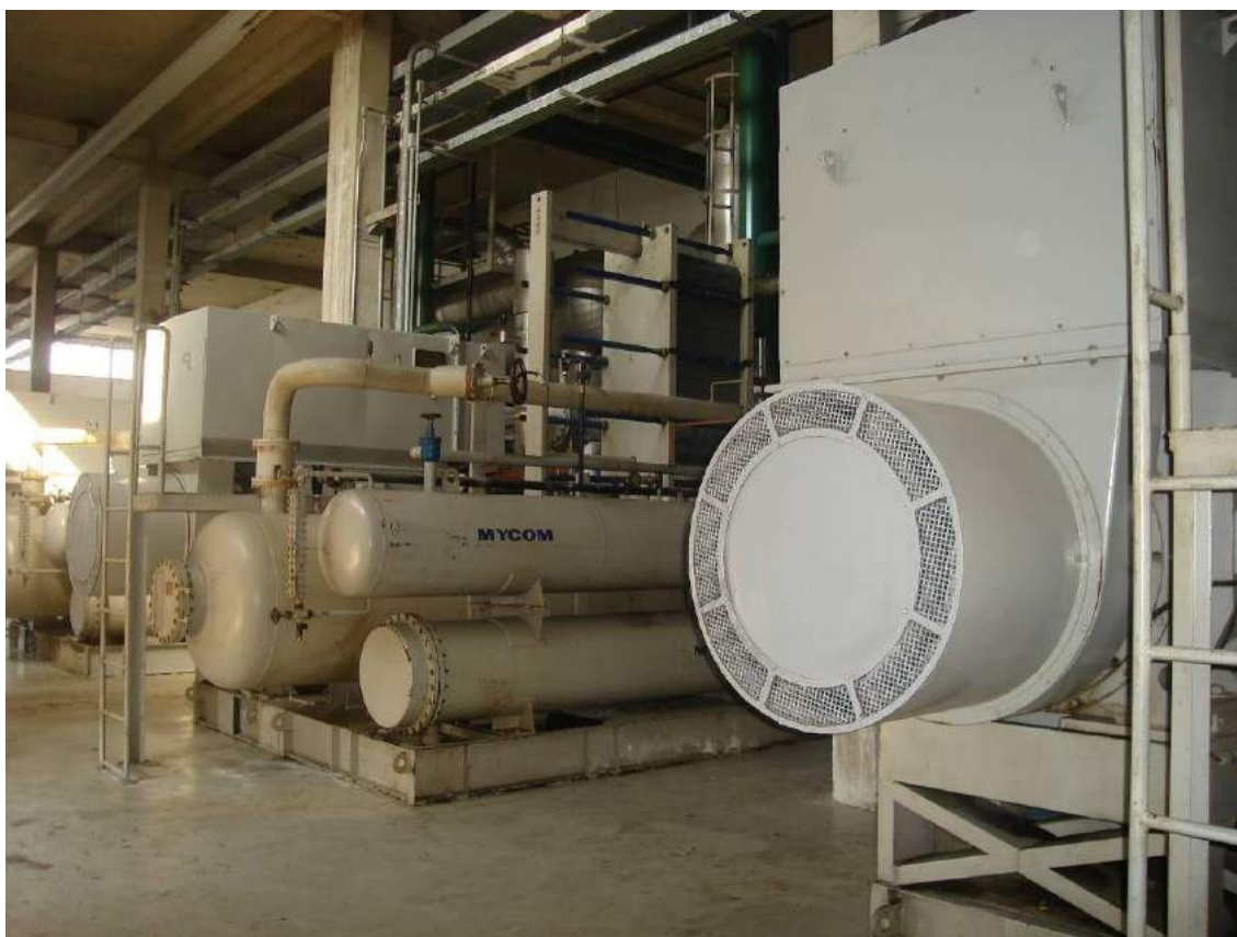
Foto 7 – Grupo de compressores de amônia.
