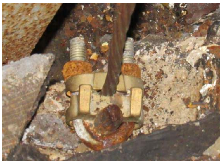
Figura 15: Vergalhão e conector em estado de corrosão.
