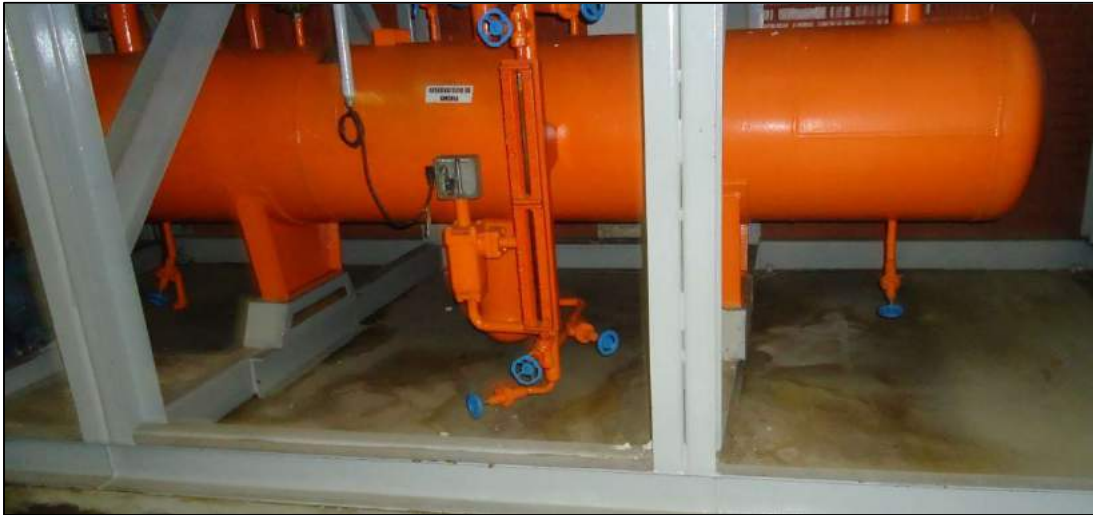
Figura 8 – Reservatório de amônia da sala de máquinas 1
