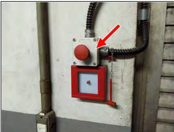
Figura 43 – Botoeira de “emergência”
