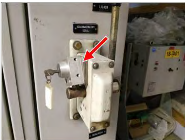
Figura 32 - Bloqueio mecânico danificado Secc. nº01
