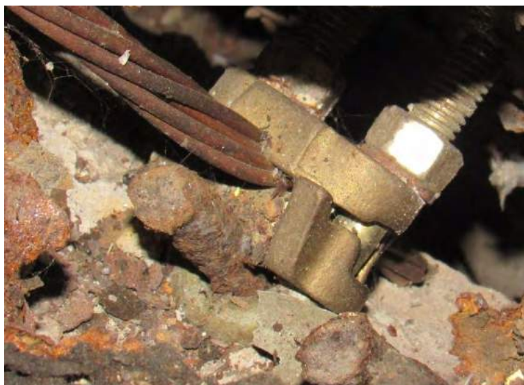
Figura 12: Vergalhão em estado de corrosão.
