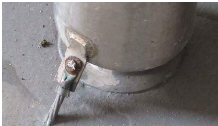
Figura 43: Parafuso oxidado.
