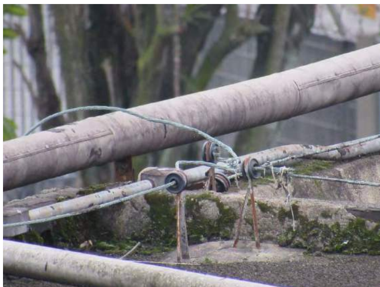
Figura 38: Condutos desvinculados do SPDA (foto 2018).
