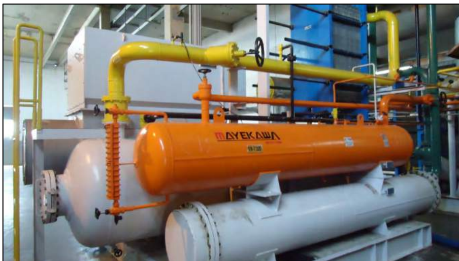
Figura 10 – Reservatório de amônia da sala de máquinas 3
