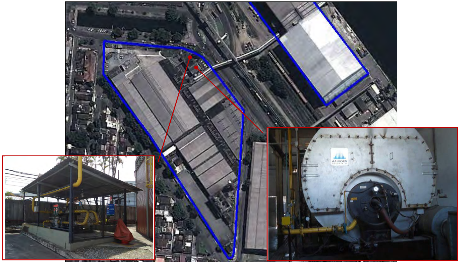
Figura 2 – Sistema de alimentação de gás natural para caldeiras à vapor
