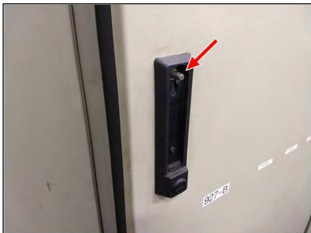
Figura 40 – Fechadura danificada
