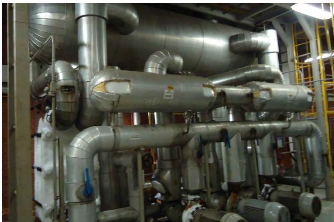
Figura 8 – Separador de líquido da sala de máquinas 1
