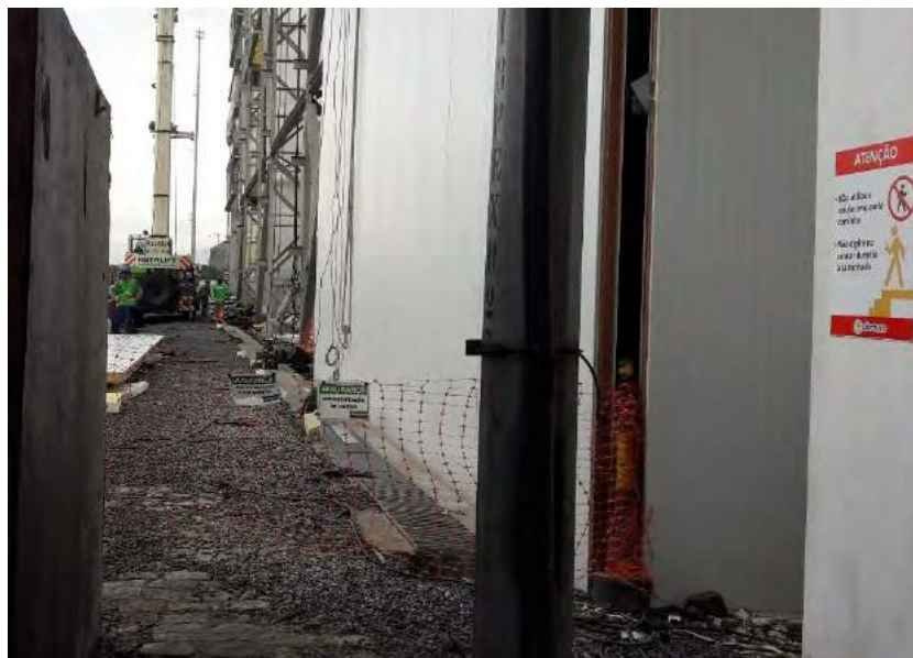
Figura 4: Acesso interditado devido a obras em execução.
