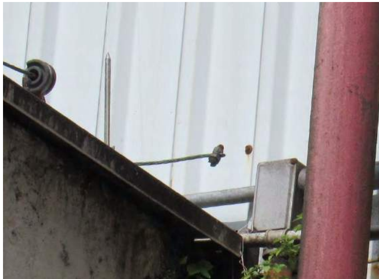
Figura 40; Captação desconectada ao topo.
