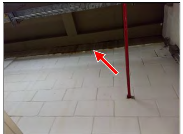
Figura 36 – Infiltração de água no teto da subestação
