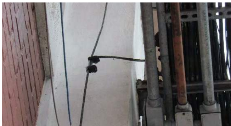
Figura 6: Ligação equipotencial lateral na Câmara C (foto 2018).
