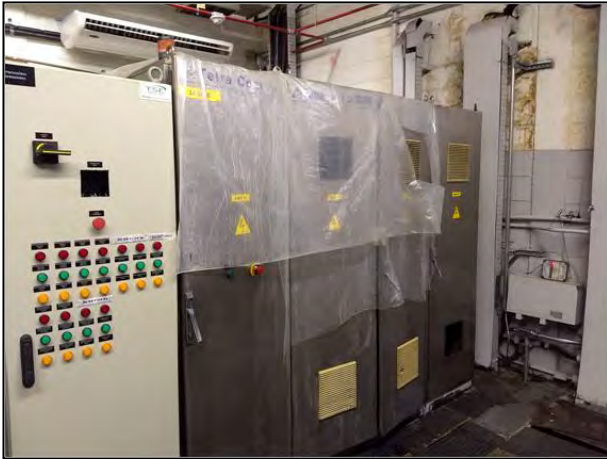
Figura 27 – Gotejamentos sobre o painel elétrico
