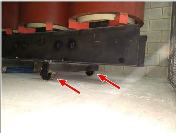
Figura 24 – Transformador não possui travas nas rodas
