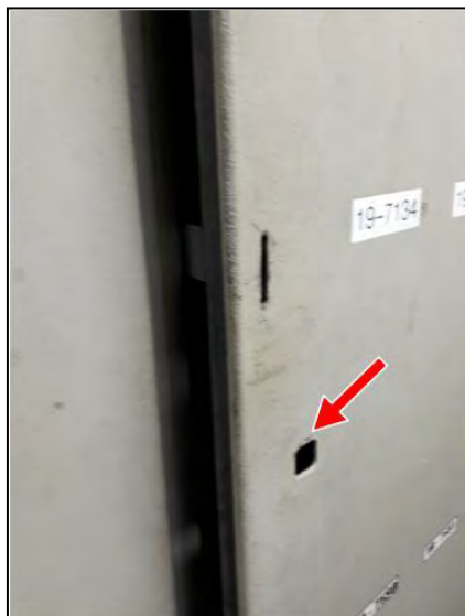
Figura 13 – Painel baixa tensão sem fecho na porta
