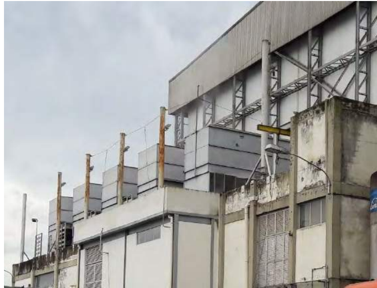
Figura 8: Mastros no Armazém 29
