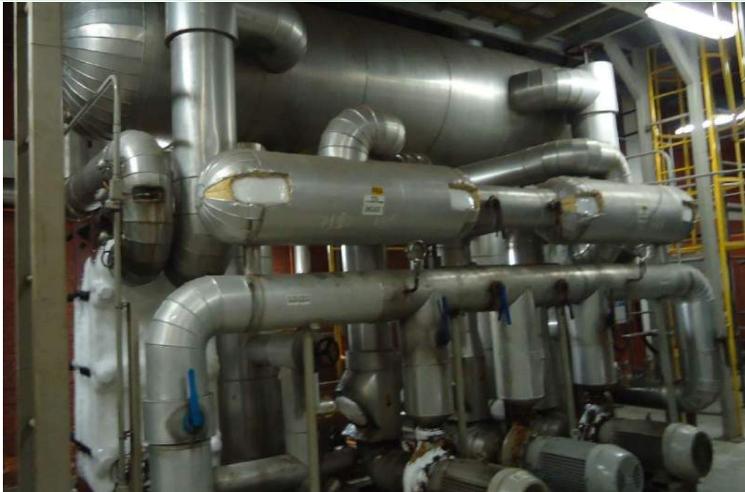
Figura 10 – Separador de líquido da sala de máquinas 1
