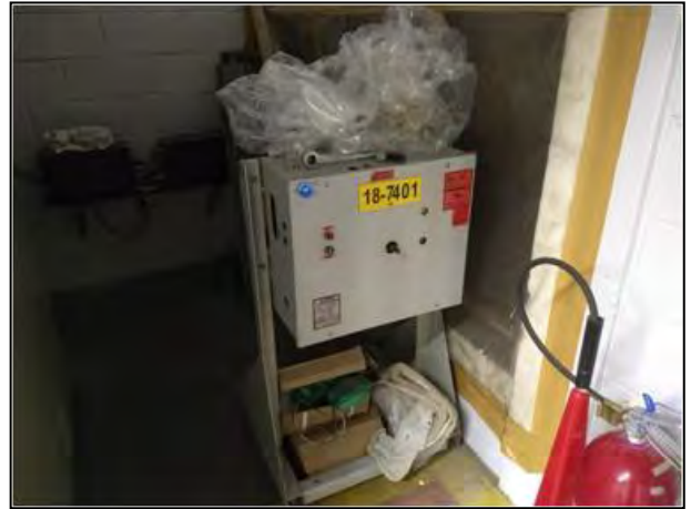
Figura 29 – Materiais em desuso armazenada no interior da subestação
