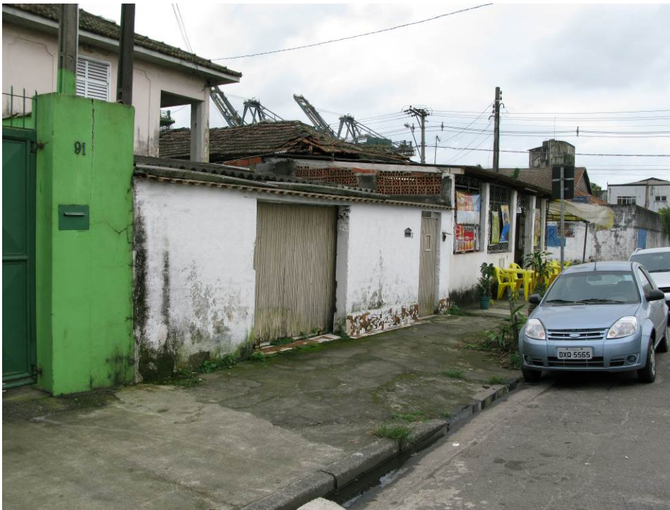
Figura 3.5 - 3: Vista Panorâmica da Rua Octávio Corrêa (casas que fazem fundos para o terreno do viaduto).
