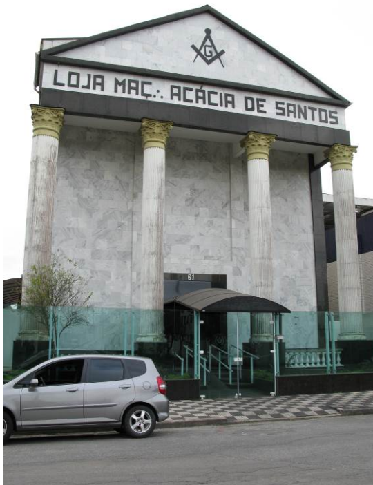
Figura 3.5 - 5: Vista da Rua Octávio Corrêa (edifício institucional que faz fundos para o terreno do viaduto).
