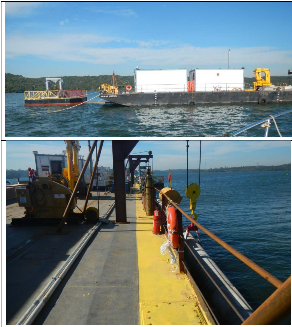
Figura 7.4.1.1-1: Balsa utilizada para construção do gasoduto marítimo
