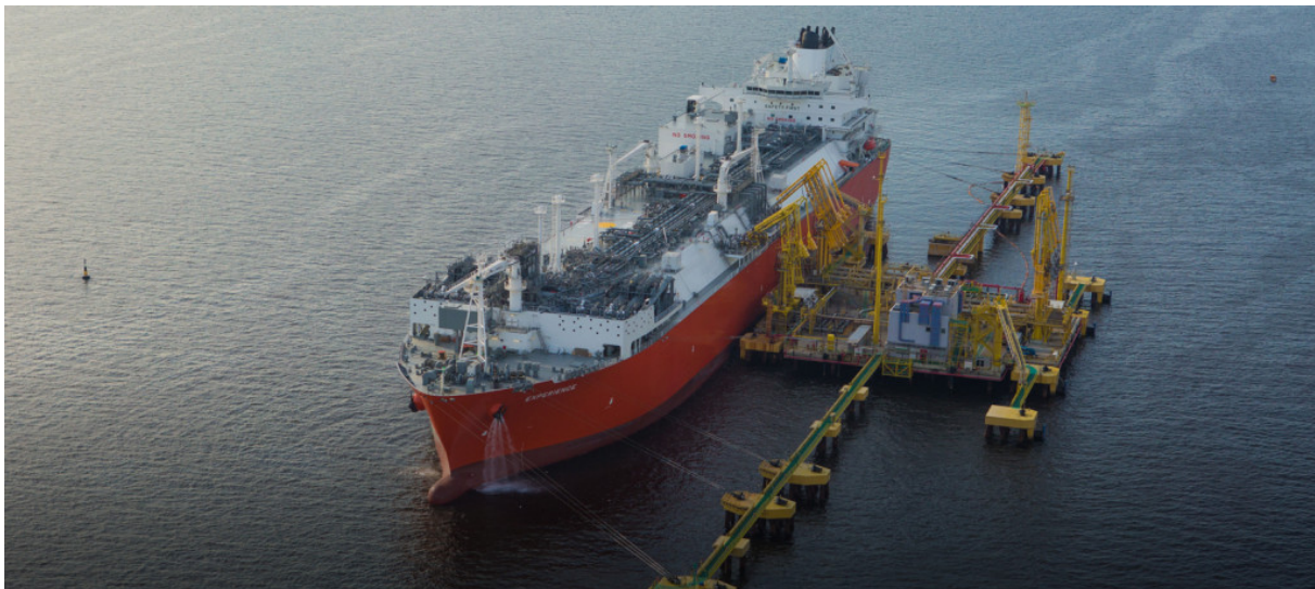
Figura 7.2.3.1-2: Exemplo de FSRU em operação, atracado em terminal de GNL com píer tipo ilha.
