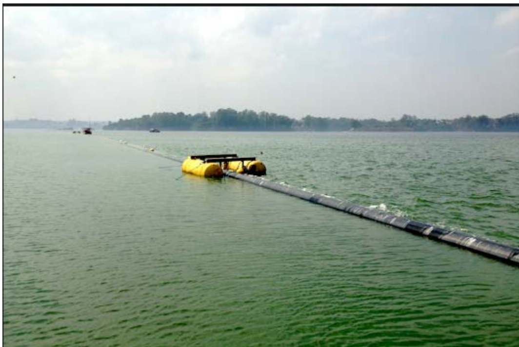
Figura 7.4.8.2-2: Montagem de tubulação Marítima, coluna de tubo para furo
