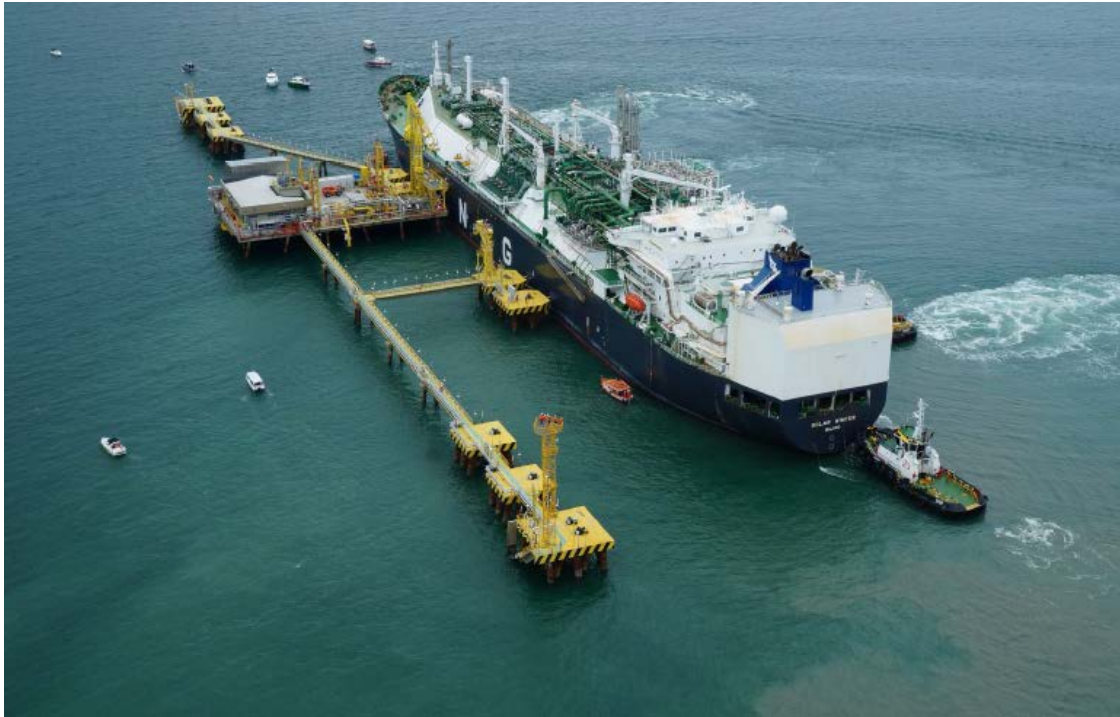
Figura 7.5.6-2: Manobra de atracação de navio FSRU em Terminal de Regaseificação de GNL
