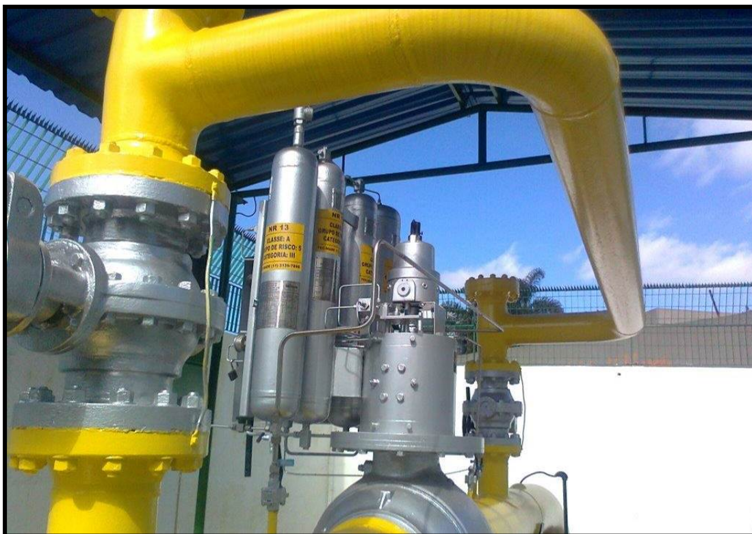
Figura 7.5.8.5-1: Válvula de Bloqueio Automática
