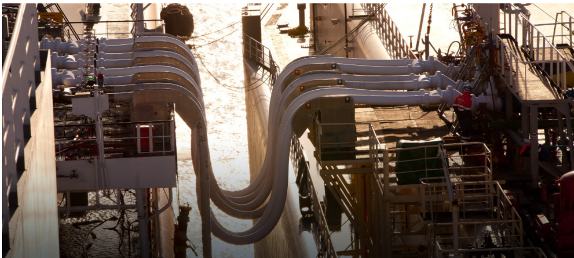
Figura 7.2.3.1-3: conexão ship-to-ship para transbordo de GNL entre o LNGC e o FSRU
