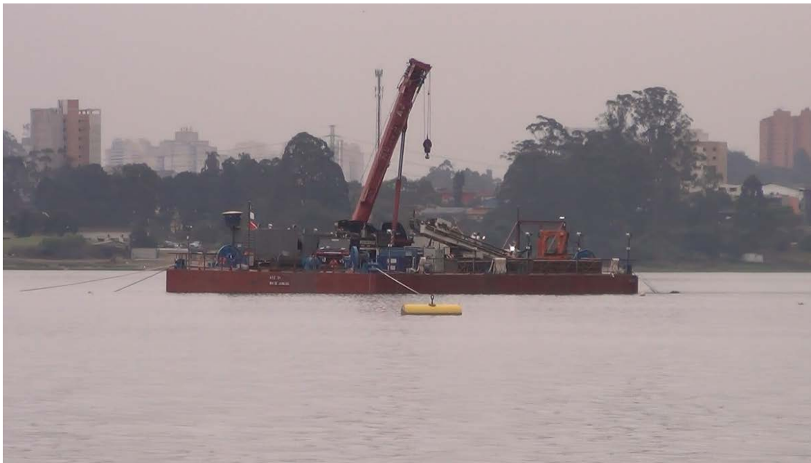
Figura 7.4.8-1: Balsa de apoio para construção marítima já usada pela COMGAS.
