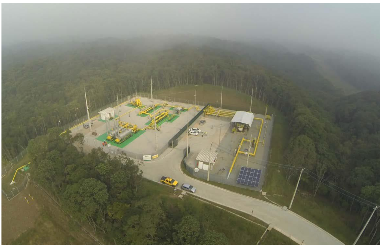
Figura 8. Ilustração típica do City Gate COMGAS existente no alto da serra. Fonte: COMGAS.
