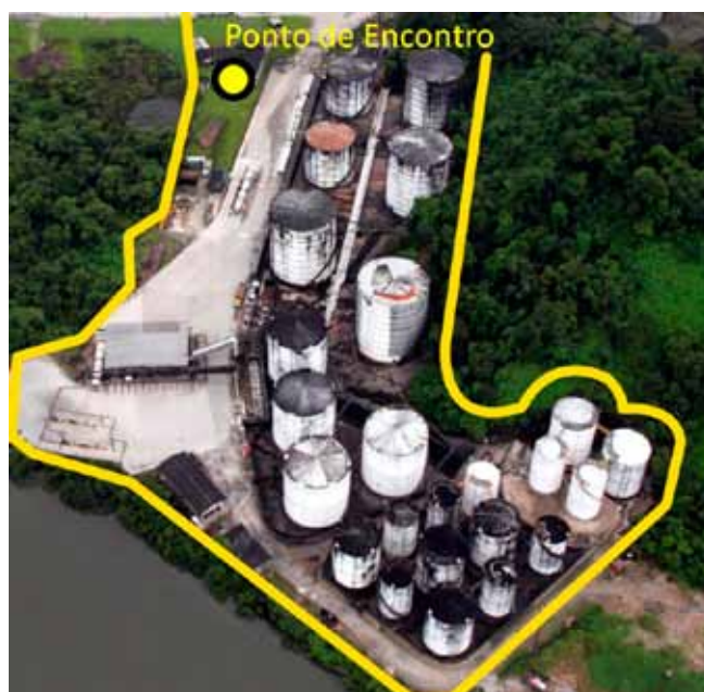
COPAPE Terminais e Armazéns S.A. - Ilha Barnabé
