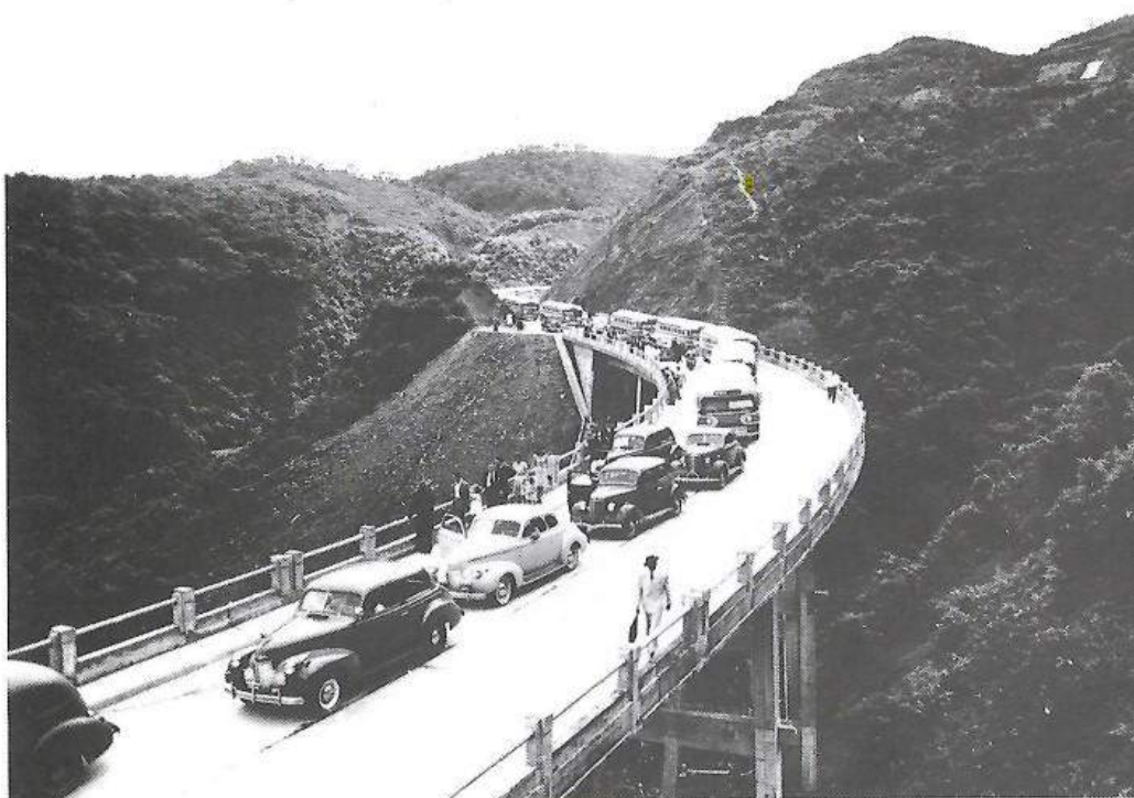
Inauguração da pista ascendente da Rodovia Anchieta. 1947 Acervo Fundação Arquivo e Memória de Santos
