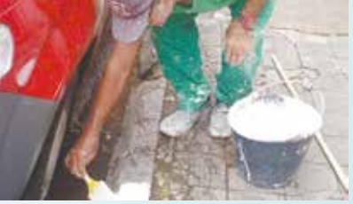
Pintura de guias na Rua Dr. Côchrane - Vila Nova
