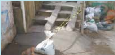
Rampa finalizada - Rua 7 - Morro José Menino
