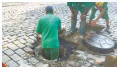
Renivelamento de poço de visita na Rua Martim Afonso com Praça da República - Centro
