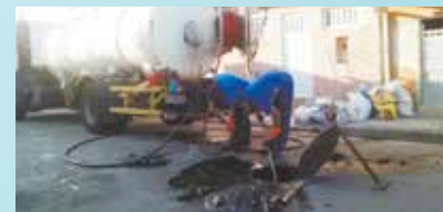
Limpeza de galerias Rua Aguinaldo Caiado, Castelo
